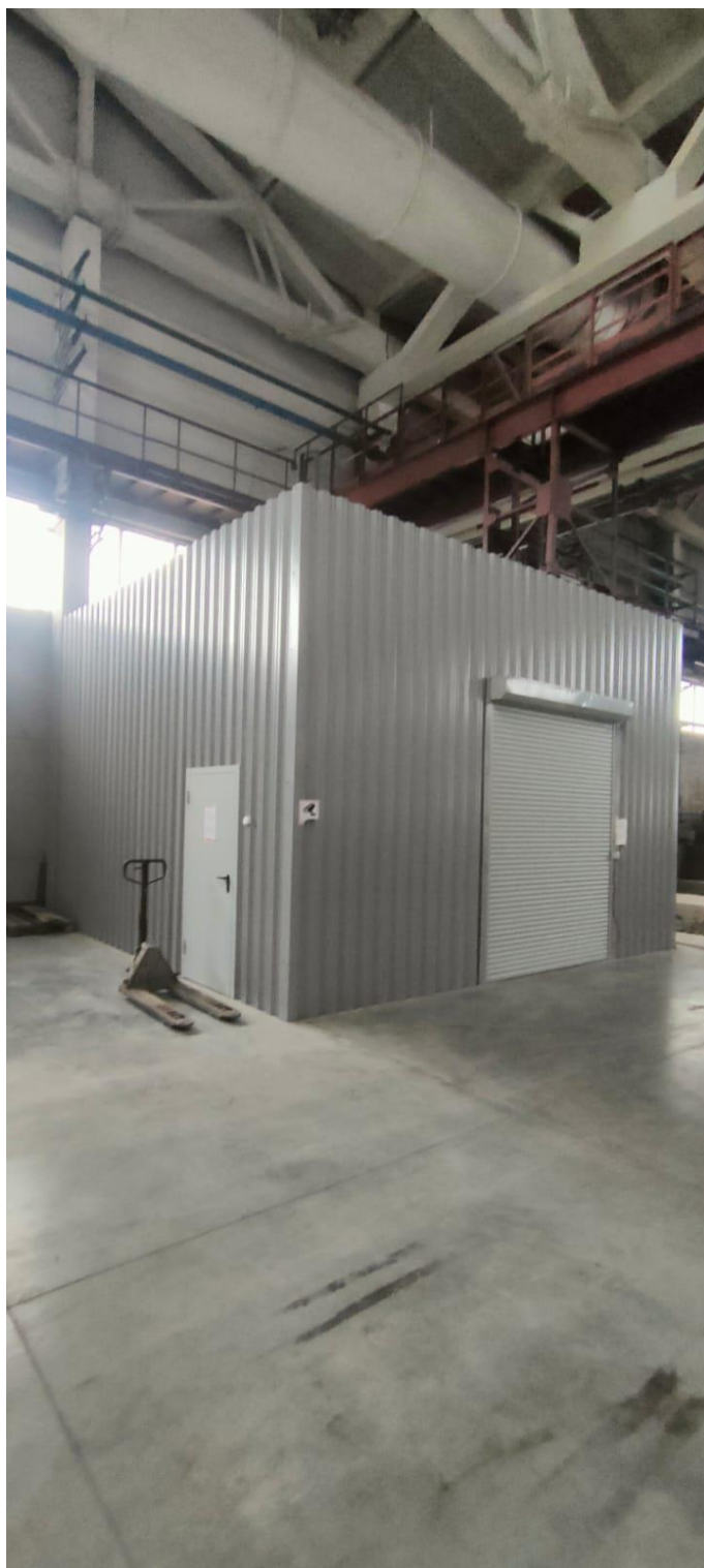
Складское помещение в осях Б/3-Б/2 – 32-33.
