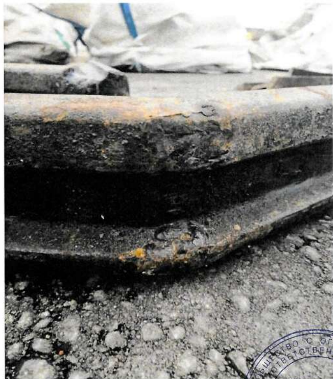
Фото №15. В конструкции «Глухое пересечение» использованы стыковые накладки распиленные пополам и затем приваренные под углом с использованием сварки.
