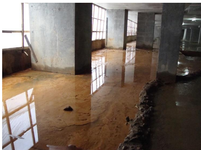
До производства гидроизоляционных работ
