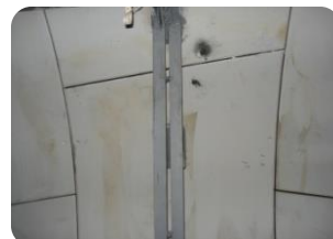
После пр-ва работ
