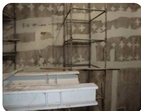
После пр-ва работ
