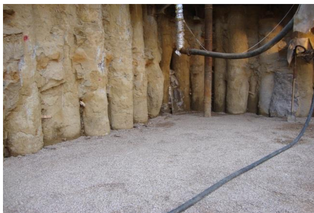
После производства работ
