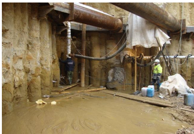
Во время производства работ
