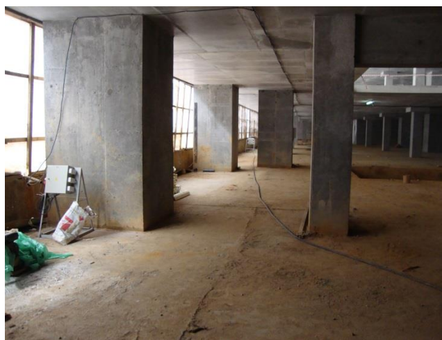
После производства гидроизоляционных работ
