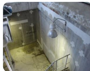
После пр-ва работ
