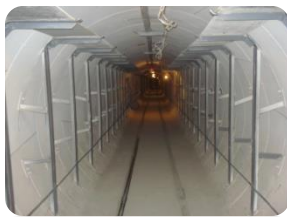
После пр-ва работ
