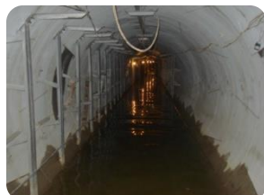
До пр-ва работ
