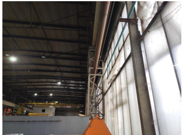
Фото 22. Общий вид на колонну К-1.
