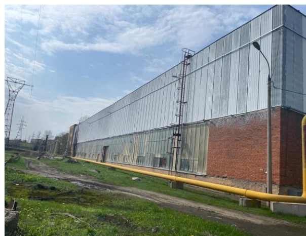
Фото 4. Общий вид на фасад здания.
