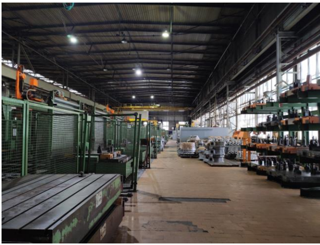
Фото 19. Общий вид на пролет здания в осях XXXXXX.
