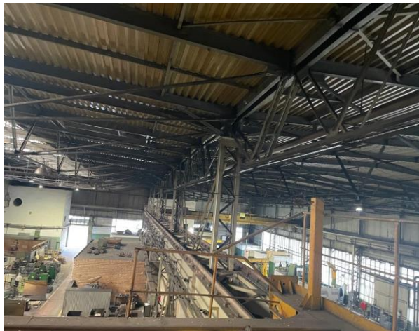
Фото 68. Общий вид на конструкции покрытия.
