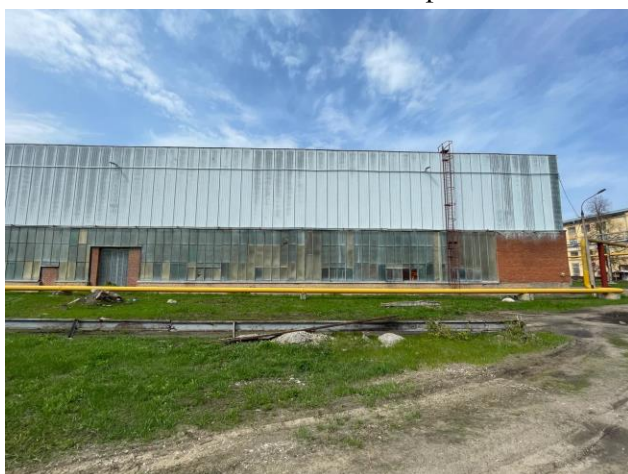
Фото 5. Общий вид на часть фасада здания.
