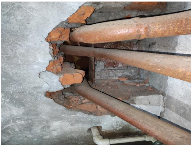
Фото 47. Необращенное техническое отверстие.
