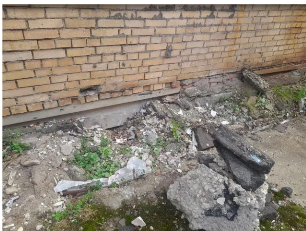
Фото 7. Разрушение отмостки, произрастание растительности. Скопления мусора.
