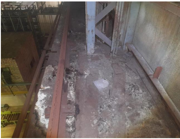
Фото 43. Замачивание подкрановых балок.
