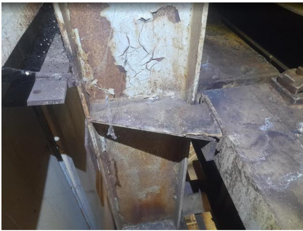
Фото 37. Вид на крепление верхнего пояса подкрановых балок к колоннам.
