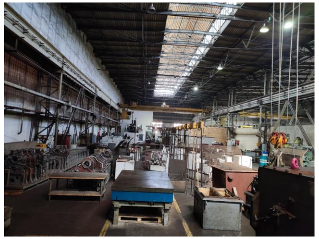
Фото 20. Общий вид на пролет здания в осях XXXXXX.
