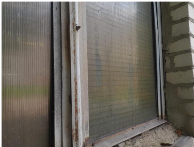
Фото 99. Армированное стекло. Поликарбонат. Не соответствует ЛСК.
