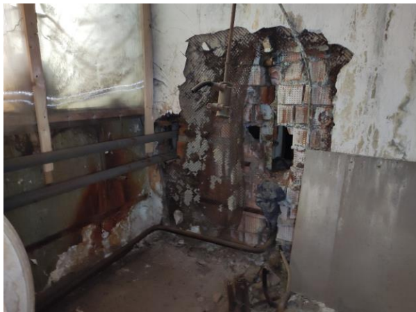
Фото 50. Необращенное техническое отверстие.
