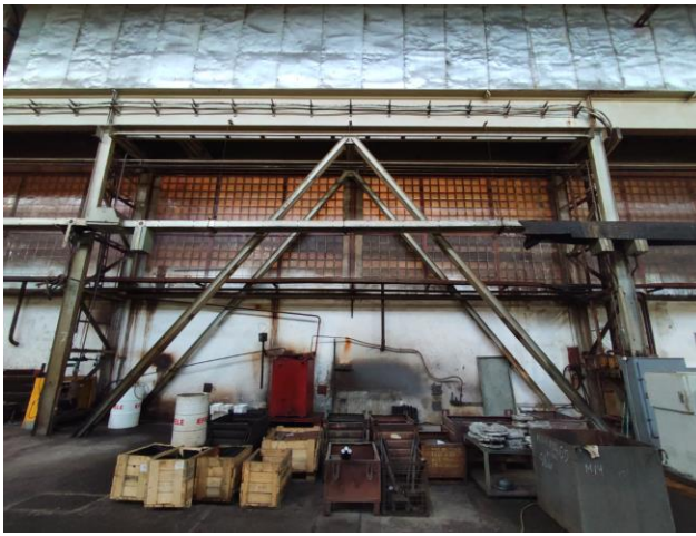
Фото 25. Общий вид на вертикальную связь ВС-2.
