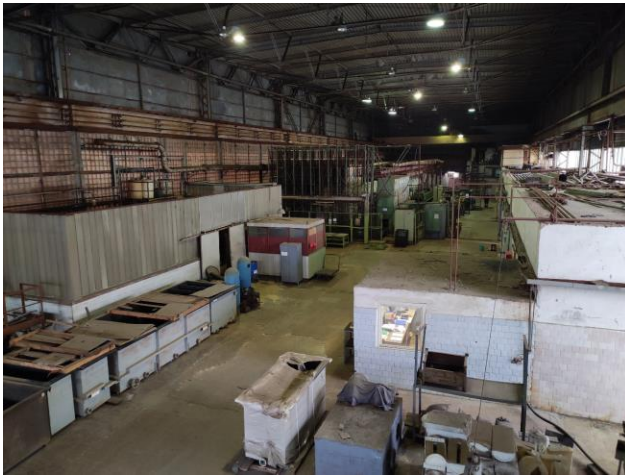
Фото 21. Общий вид на пролет здания в осях XXXXXX.
