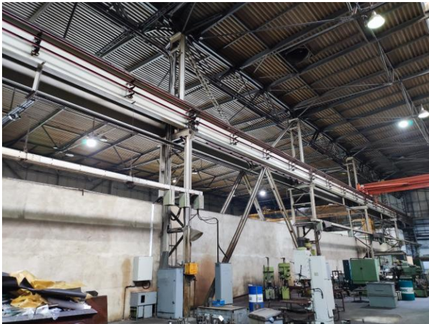
Фото 33. Общий вид подкрановую балку в осях XXXXX.
