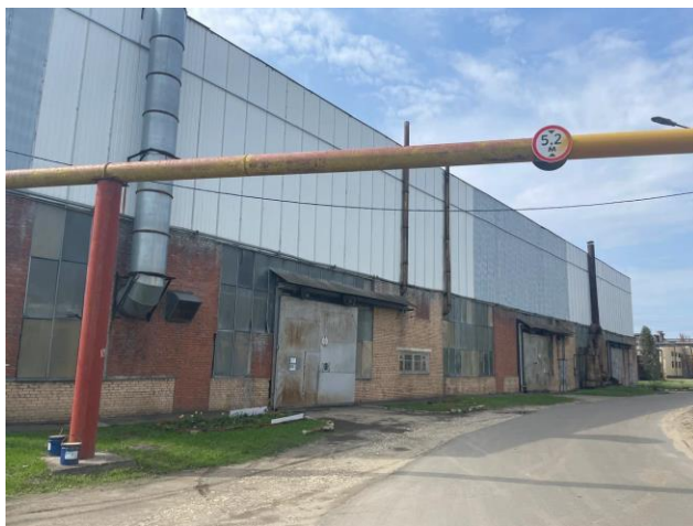
Фото 3. Общий вид на фасад здания.
