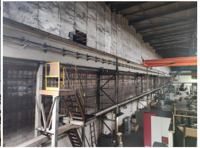
Фото 32. Общий вид подкрановую балку в осях XXXXX.
