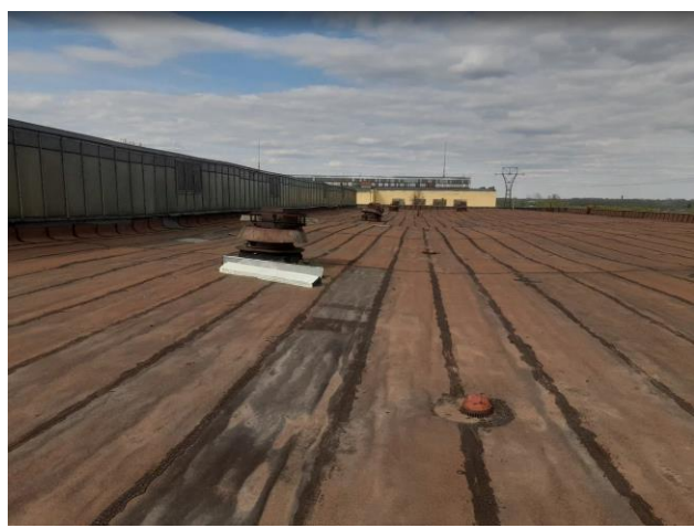
Фото 88. Общий вид на кровлю здания.
