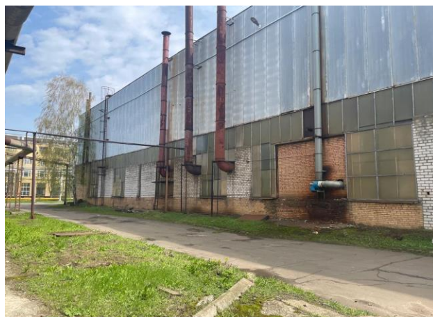
Фото 2. Общий вид на часть фасада здания.
