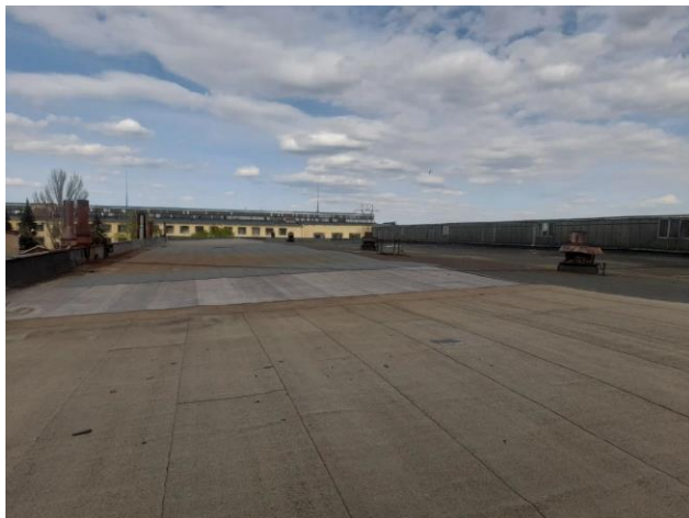
Фото 101. Рулонный ковер не разрезан на карты необходимой площади, и фактическая нагрузка на 1 \text{ м}^2 составляет 1,07 \text{ кПа}
