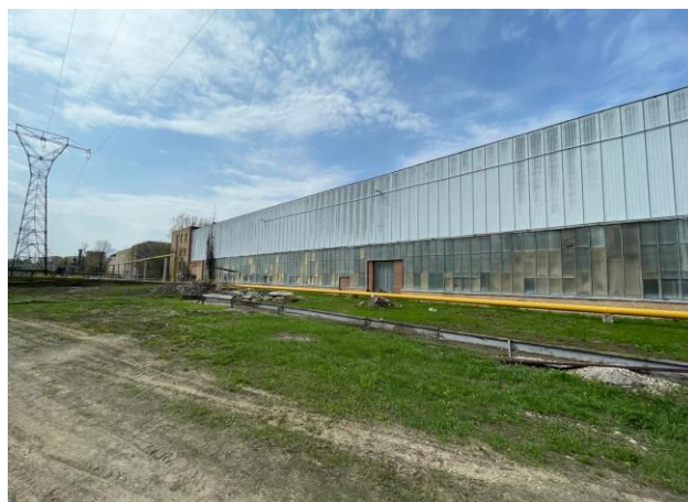
Фото 6. Общий вид на часть фасада здания.
