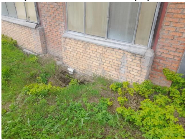
Фото 7. Разрушение отмостки, произрастание растительности. Скопления мусора.
