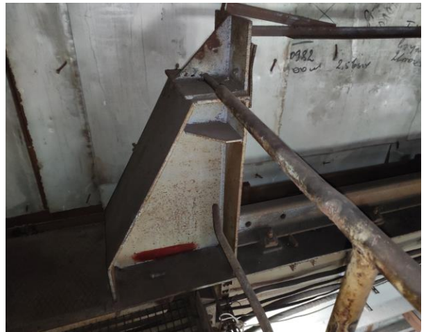
Фото 36. Вид на тупиковый упор.
