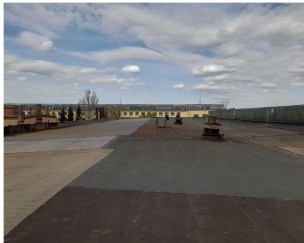
Фото 102. Рулонный ковер не разрезан на карты необходимой площади, и фактическая нагрузка на 1 \text{ м}^2 составляет 1,07 \text{ кПа}
