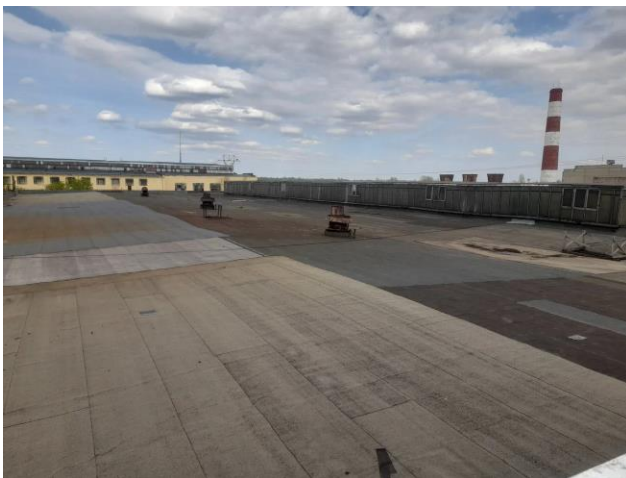
Фото 87. Общий вид на кровлю здания.
