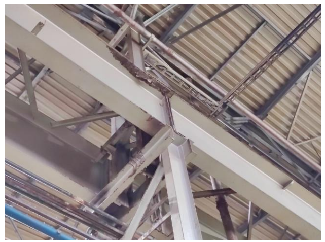
Фото 38. Узел опирания подкрановых балок на консоль колонн К-2.
