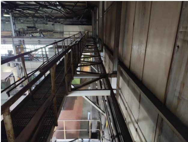
Фото 65. Вид на ходовой мостик.
