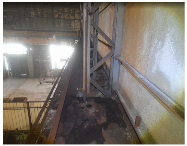
Фото 44. Замачивание подкрановых балок.
