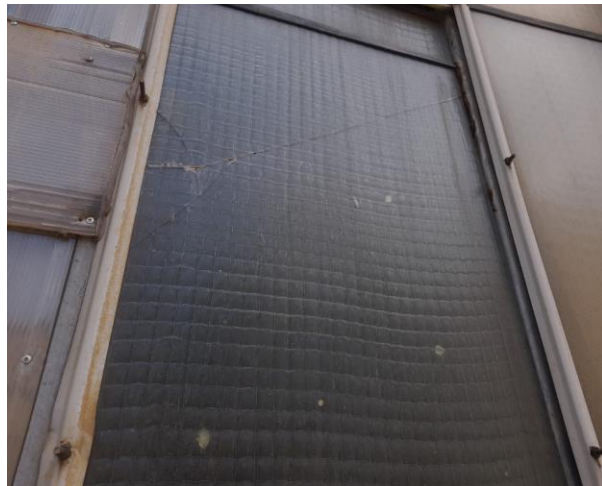
Фото 100. Армированное стекло. Поликарбонат. Не соответствует ЛСК.
