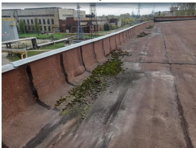
Фото 93. Произрастание растительности. Скопление промышленной пыли. Следы застоев воды.
