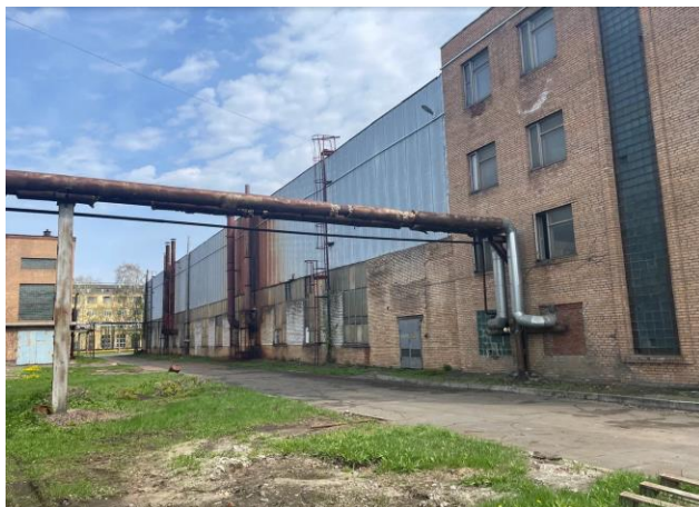
Фото 1. Общий вид на фасад здания.
