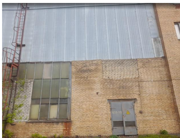
Фото 10. Отсутствие защитного фартука верха кирпичной части стены. Следы замачивания. Коррозия дверного блока включая перемычку. Коррозия лестницы.
