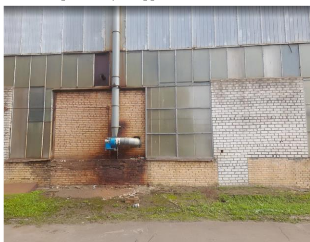
Фото 10. Отсутствие защитного фартука верха кирпичной части стены. Следы замачивания. Коррозия дверного блока включая перемычку. Коррозия лестницы.
