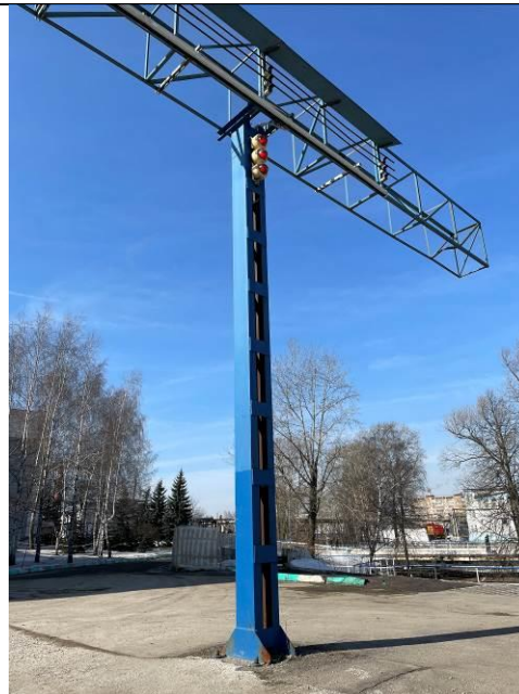
Фото 20. Общий вид опоры троллея
