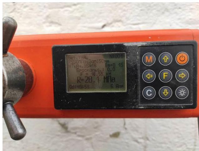
Фото 18. Определение прочности бетона подпорной стены методом отрыва со скалыванием
