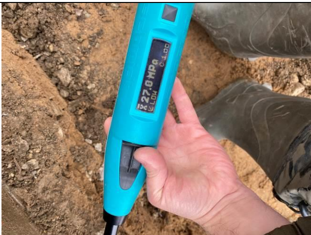
Фото 16. Определение прочности бетона фундамента ударно-импульсным методом
