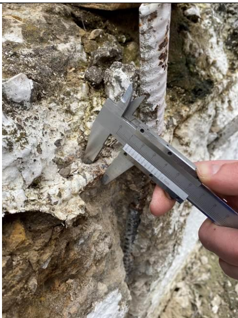
Фото 17. Определение армирования ж/б монолитной подпорной стены
