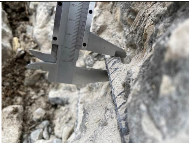
Фото 15. Определение армирования ж/б монолитного фундамента
