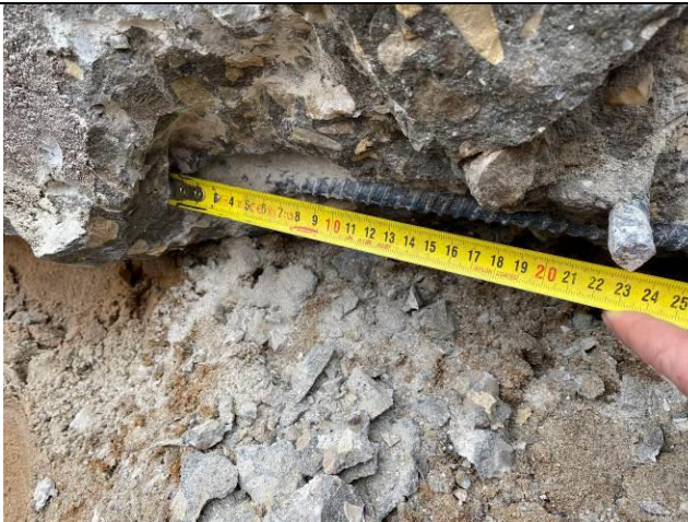
Фото 14. Определение армирования ж/б монолитного фундамента
