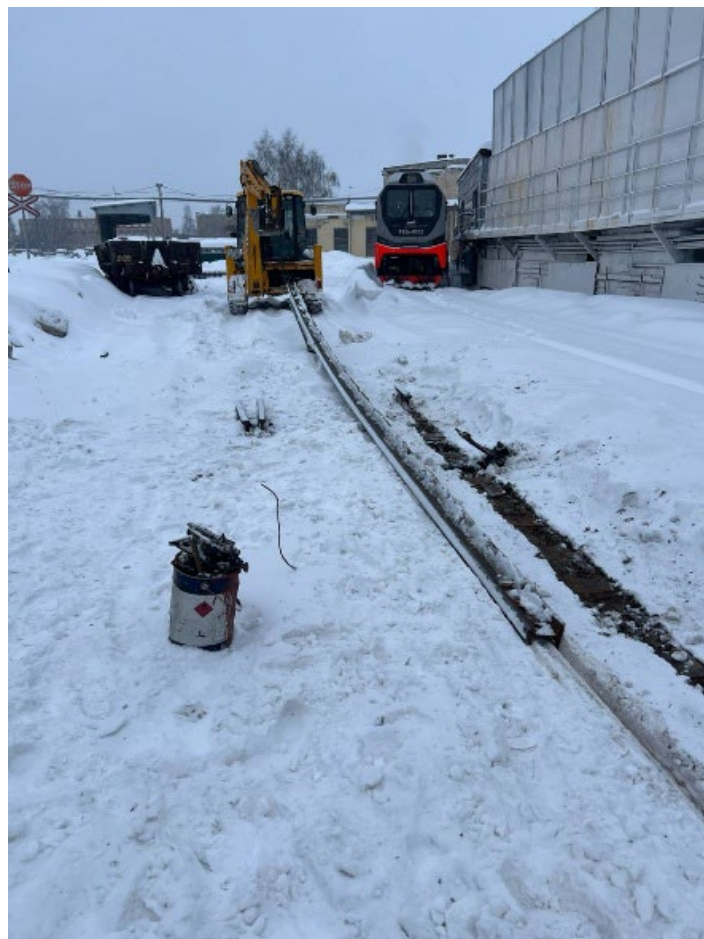
Демонтаж стрелочного перевода №14 после
