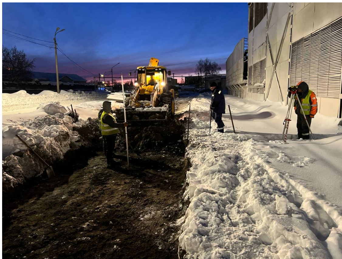
Устройство щебеночного балласта под стрелочный перевод №14 до
