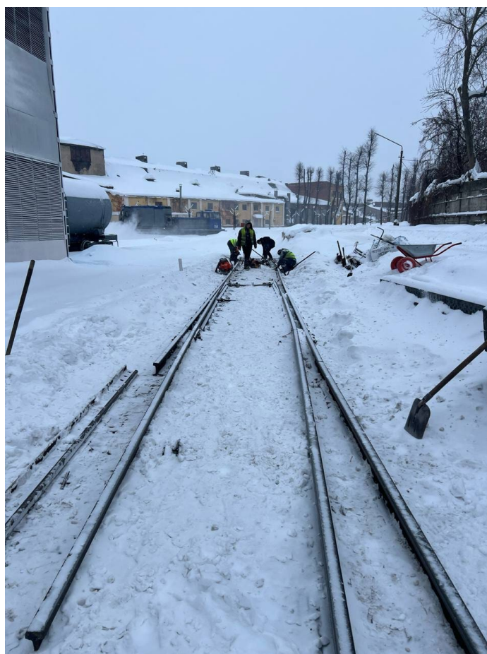
Демонтаж стрелочного перевода №14 до
