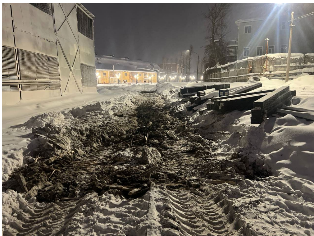
Выемка загрязненного балласта под стрелочный перевод №14 до
