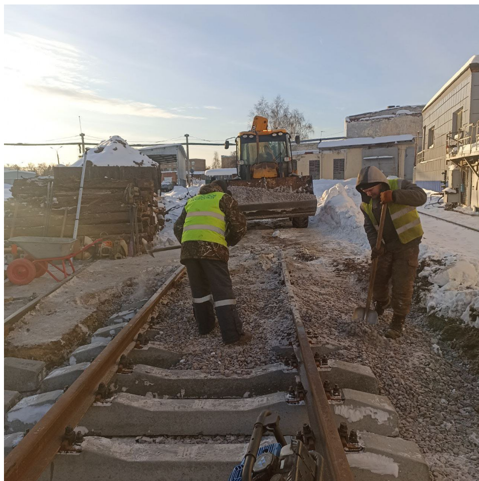
Балластировка, выправка и рихтовка стрелочного перевода №14 до
