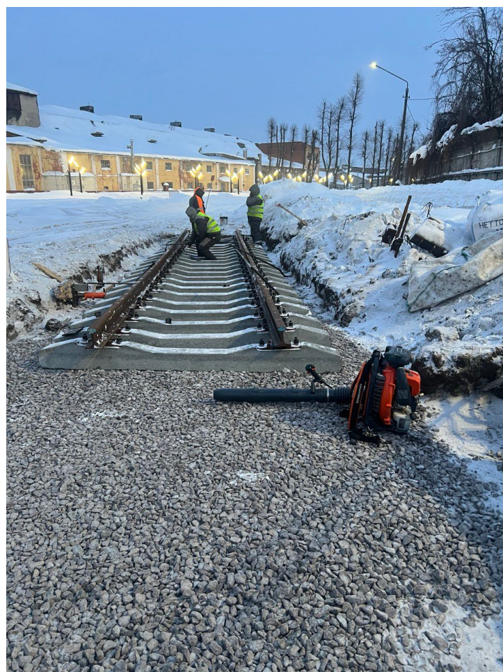
Устройство щебеночного балласта под стрелочный перевод №14 после
