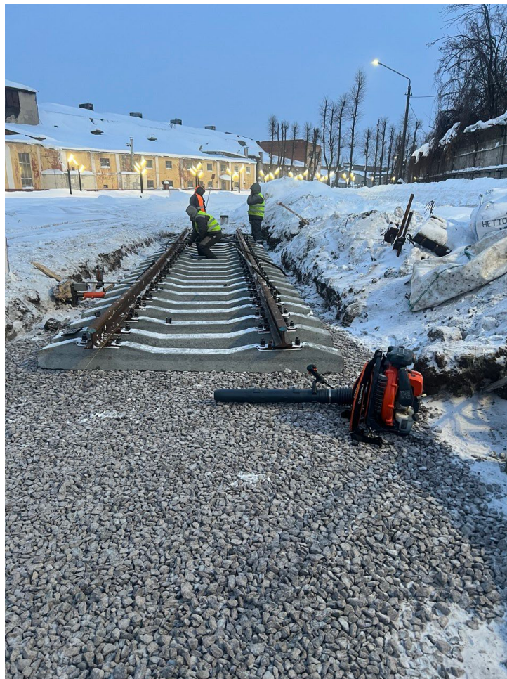
Укладка стрелочного перевода №14 до
