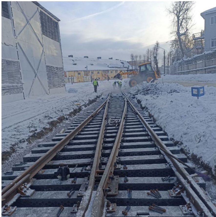
Укладка стрелочного перевода №14 после
