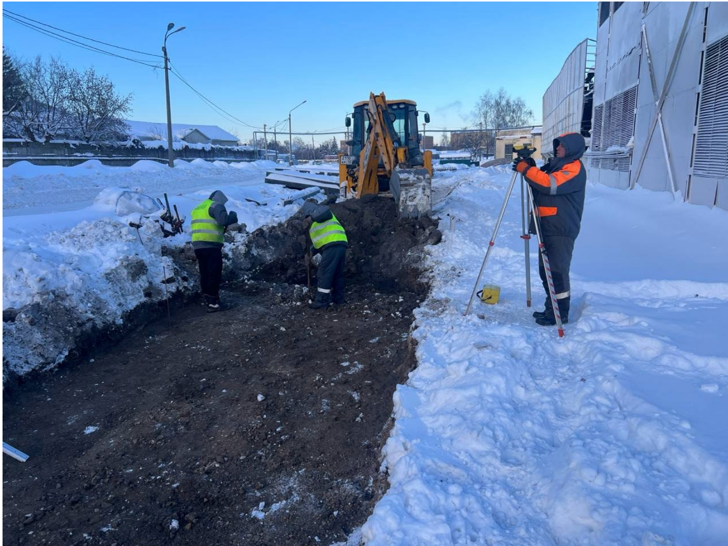
Устройство щебеночного балласта под стрелочный перевод №14 до
