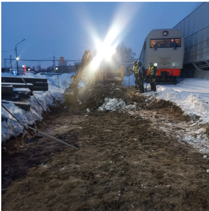
Выемка загрязненного балласта под стрелочный перевод №14 после
