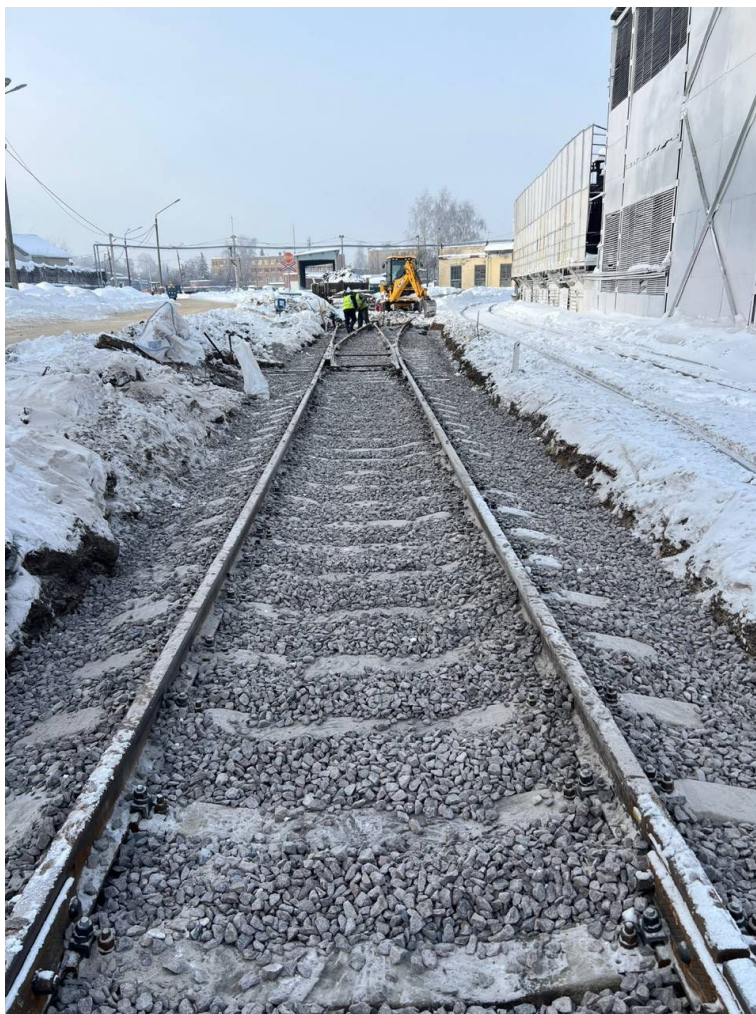
Балластировка, выправка и рихтовка стрелочного перевода №14 после
