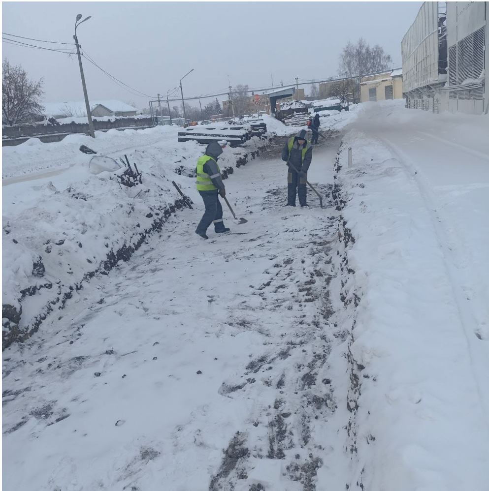
Выемка загрязненного балласта под стрелочный перевод №14 после
