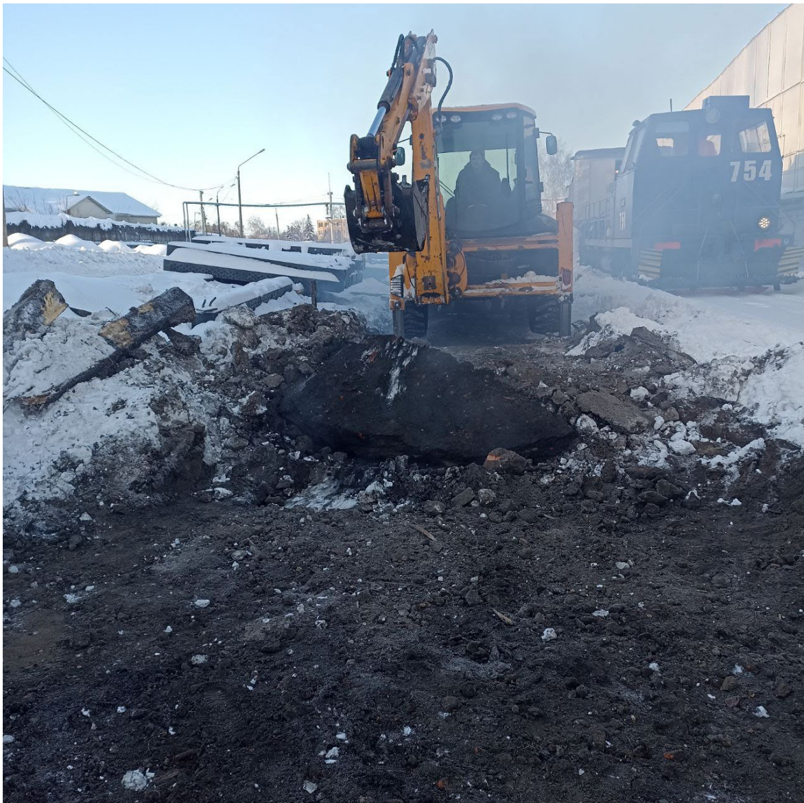
Выемка загрязненного балласта под стрелочный перевод №14 до
