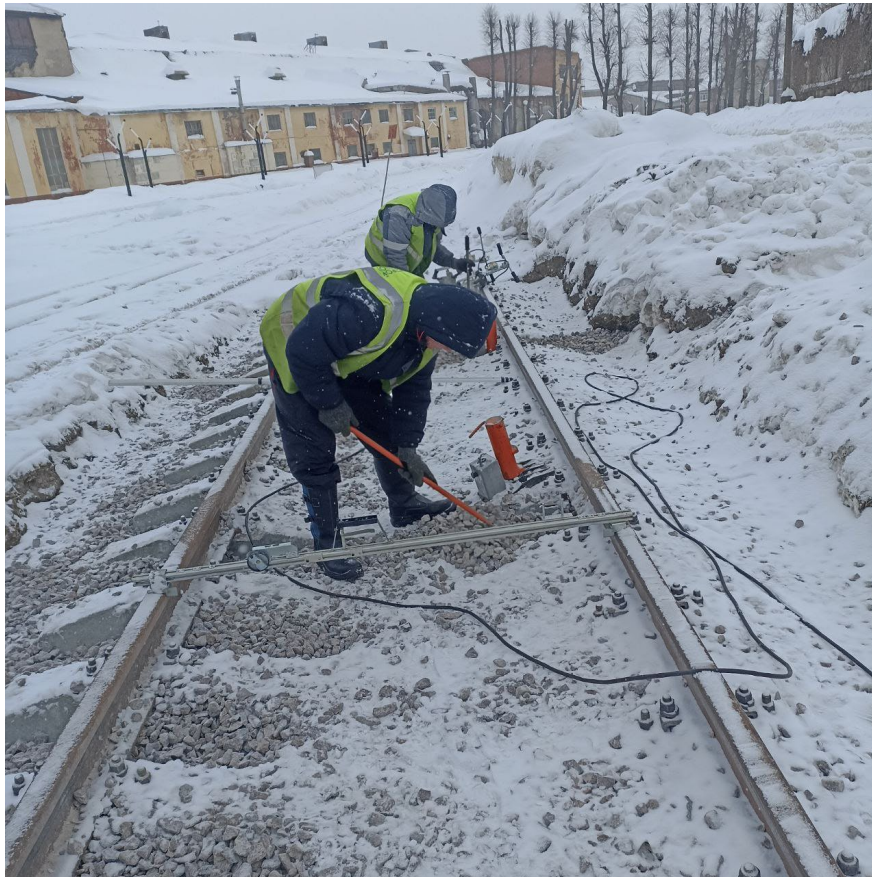
Балластировка, выправка и рихтовка стрелочного перевода №14 после
