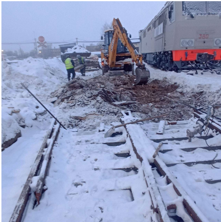
Демонтаж рельсошпальной решетки путей №14 и №15 после
