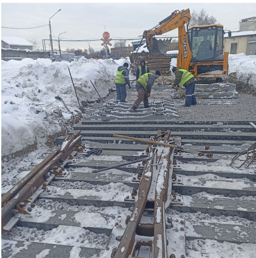
Устройство щебеночного балласта путей №14 и №15 после
