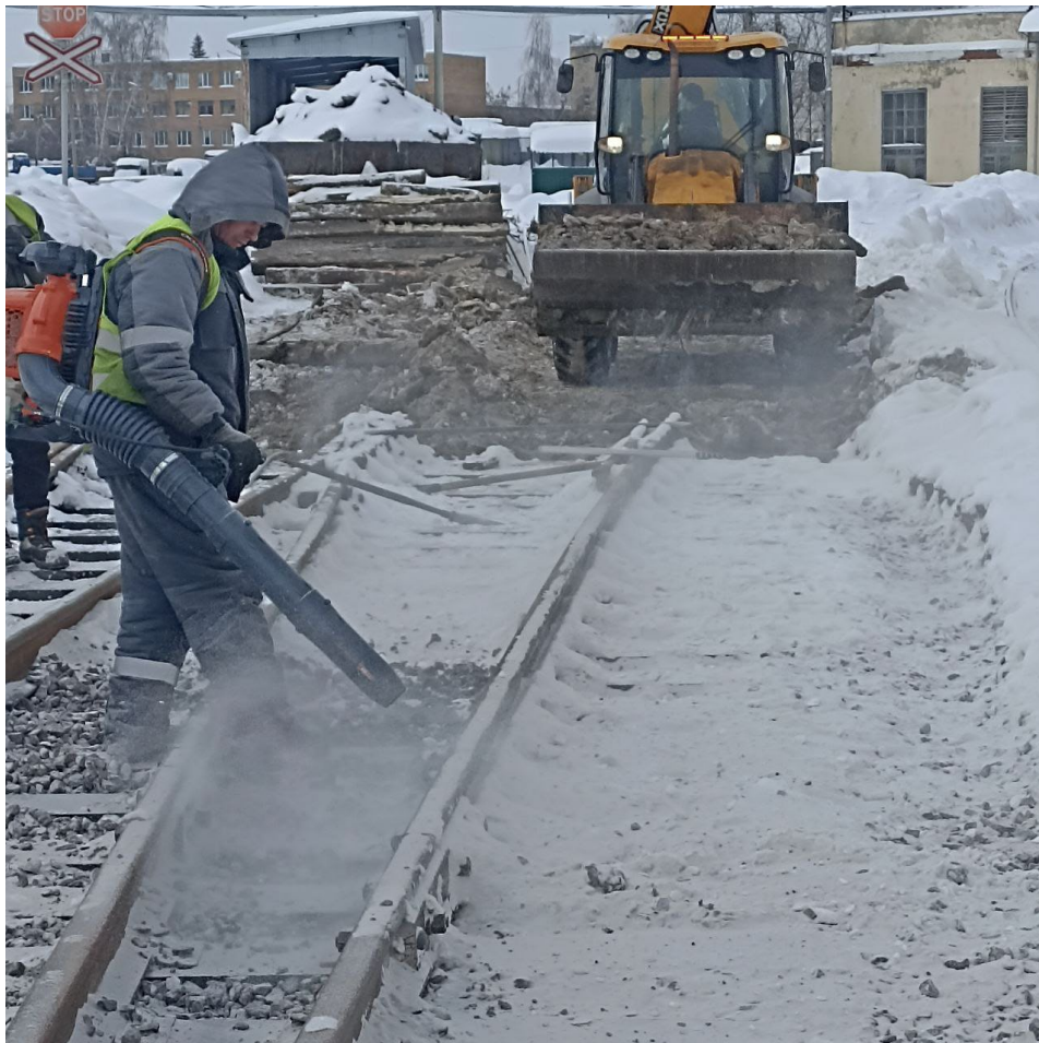
Выемка загрязненного балласта путей №14 и №15 до
