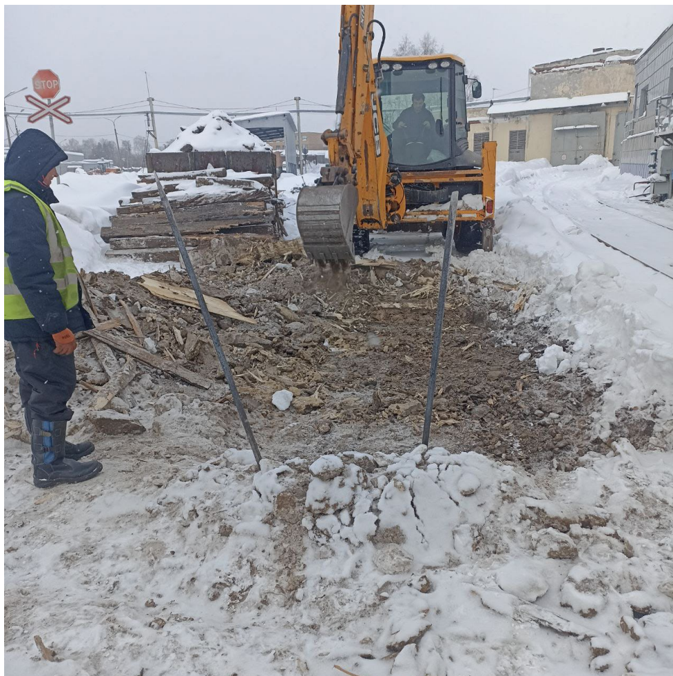
Выемка загрязненного балласта путей №14 и №15 до
