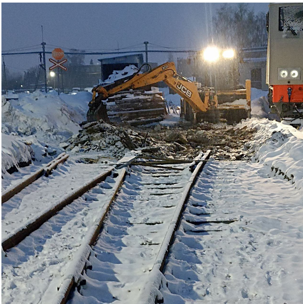
Демонтаж рельсошпальной решетки путей №14 и №15 после
