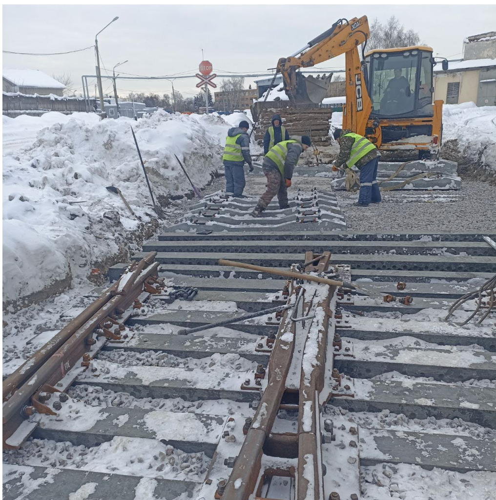
Укладка рельсошпальной решетки путей №14 и №15 до
