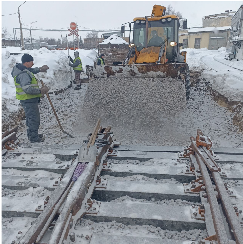
Устройство щебеночного балласта путей №14 и №15 после
