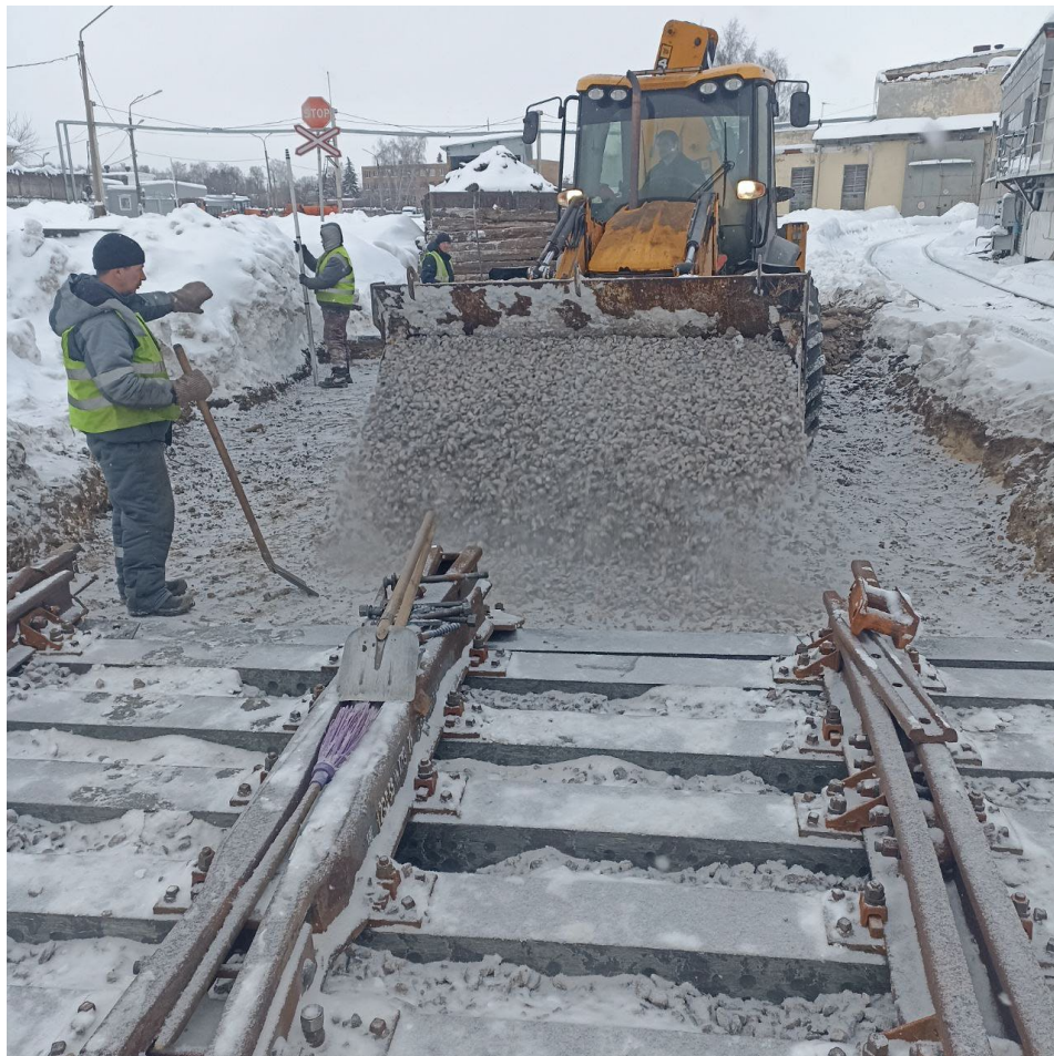
Укладка рельсошпальной решетки путей №14 и №15 до
