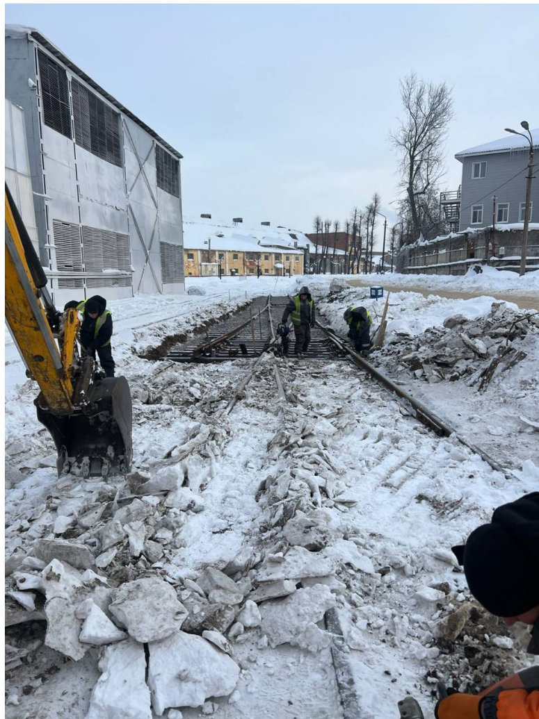
Демонтаж рельсошпальной решетки путей №14 и №15 до
