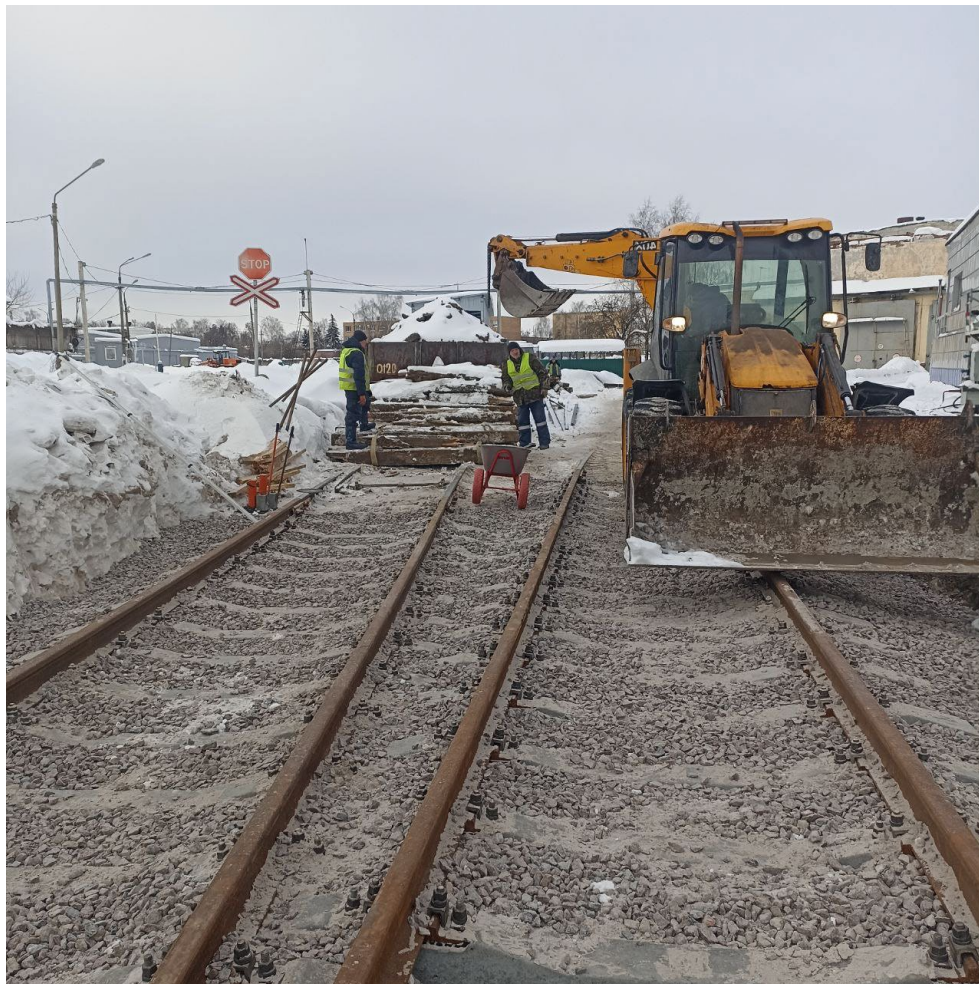
Балластировка, выправка и рихтовка путей №14 и №15 после
