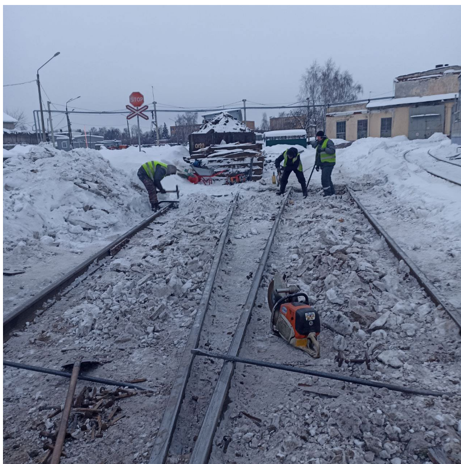
Демонтаж рельсошпальной решетки путей №14 и №15 до
