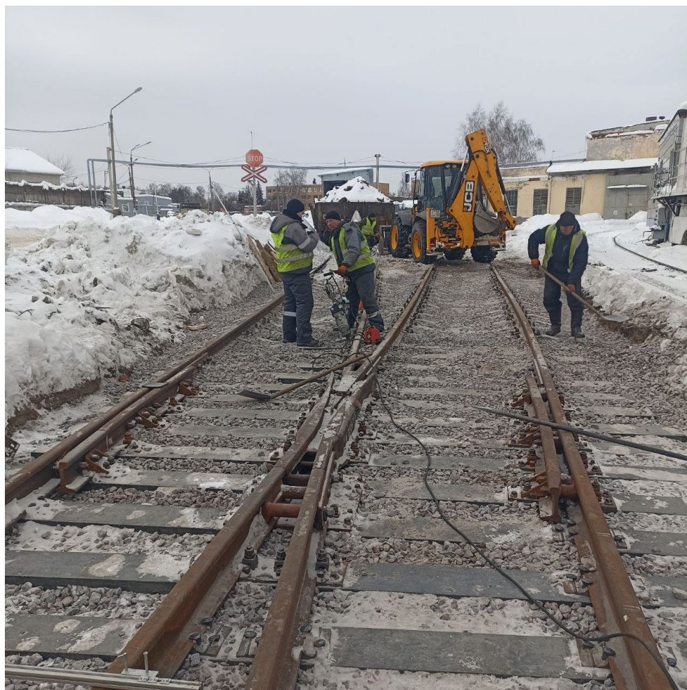
Балластировка, выправка и рихтовка путей №14 и №15 после
