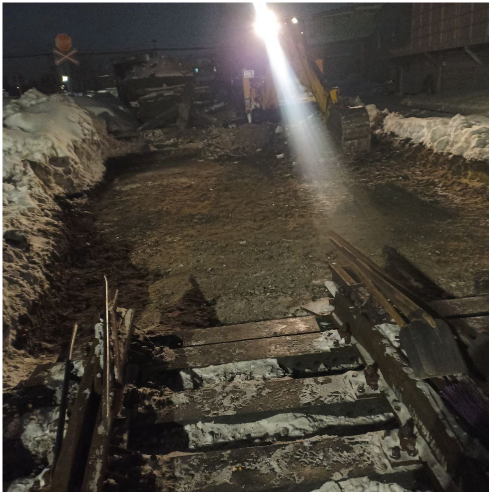
Выемка загрязненного балласта путей №14 и №15 после
