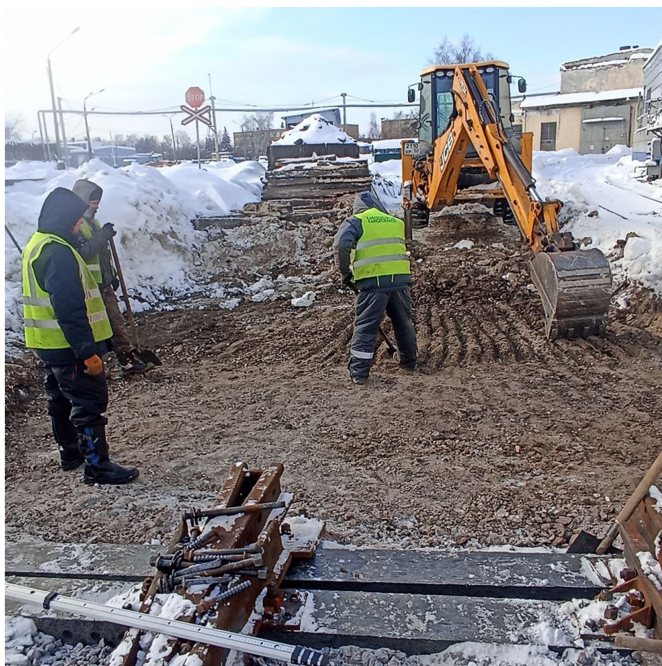
Выемка загрязненного балласта путей №14 и №15 после
