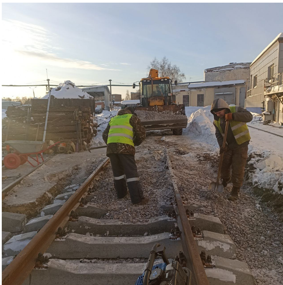
Балластировка, выправка и рихтовка путей №14 и №15 до
