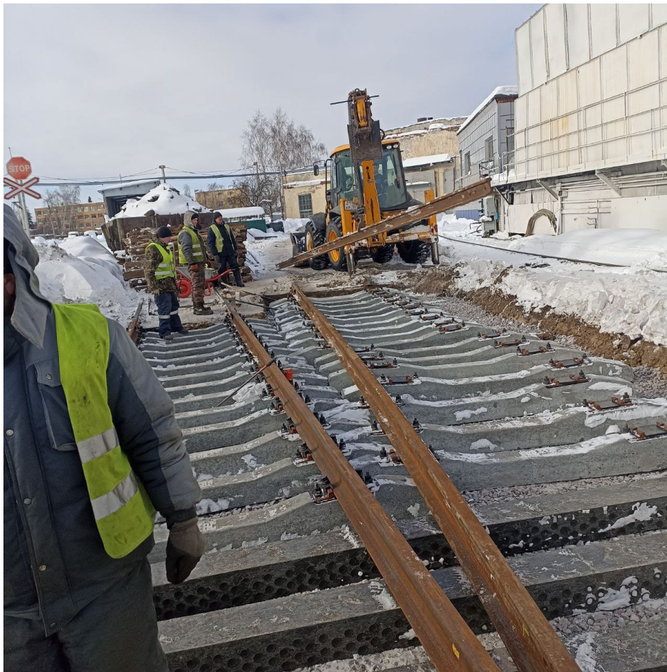
Балластировка, выправка и рихтовка путей №14 и №15 до
