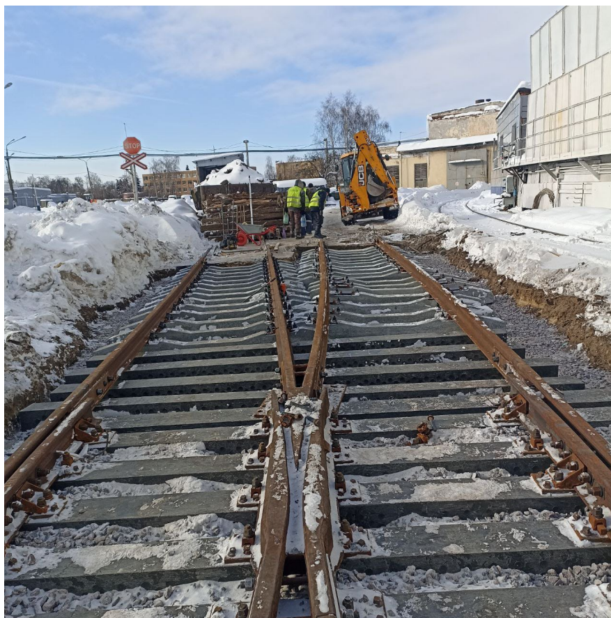
Укладка рельсошпальной решетки путей №14 и №15 после
