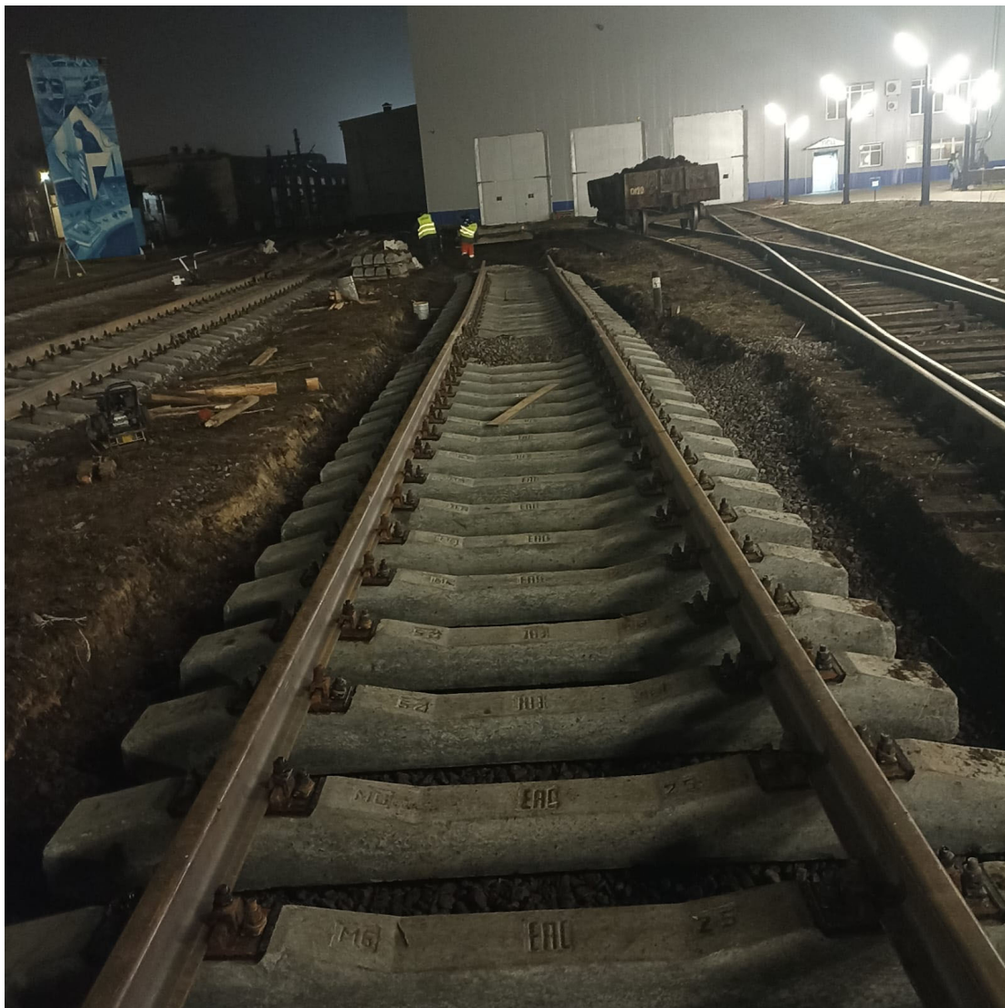
Укладка рельсошпальной решетки пути №7 после
