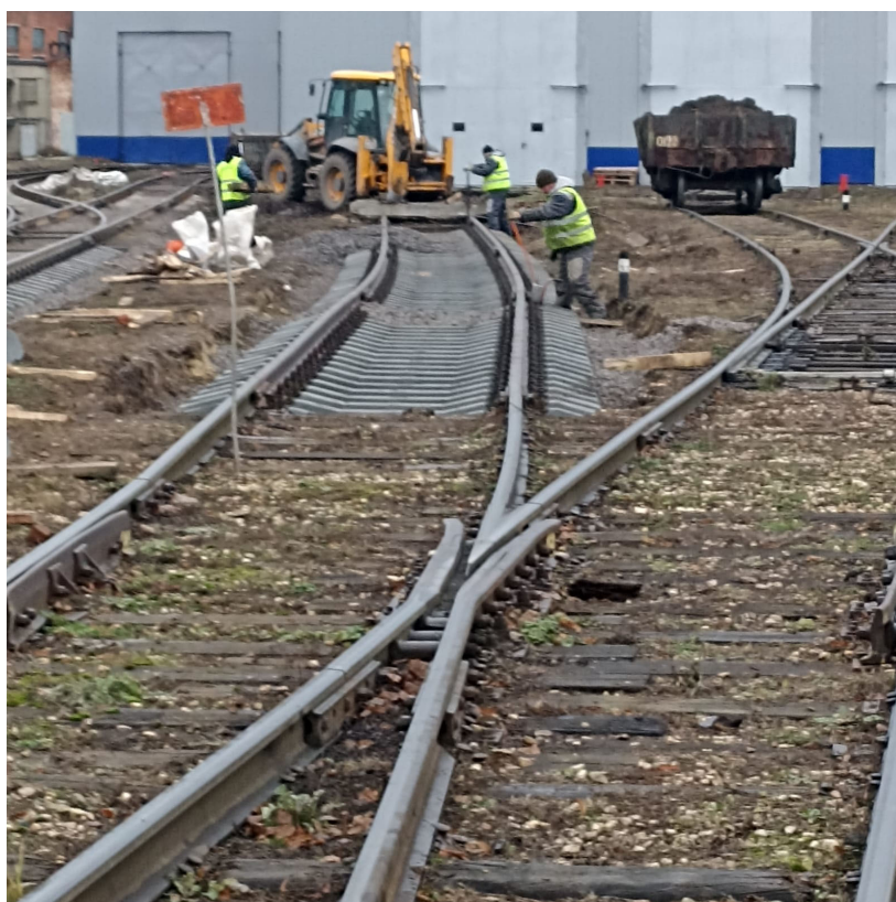
Укладка рельсошпальной решетки пути №7 после
