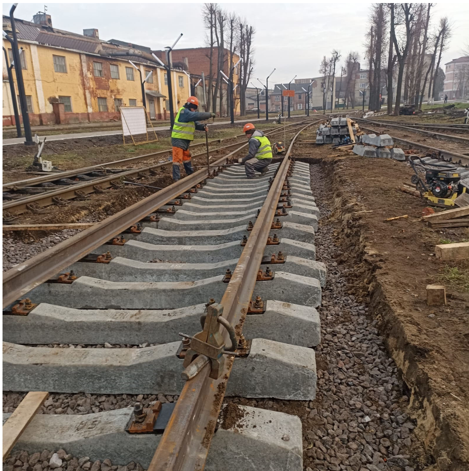
Балластировка, выправка и рихтовка пути №7 до
