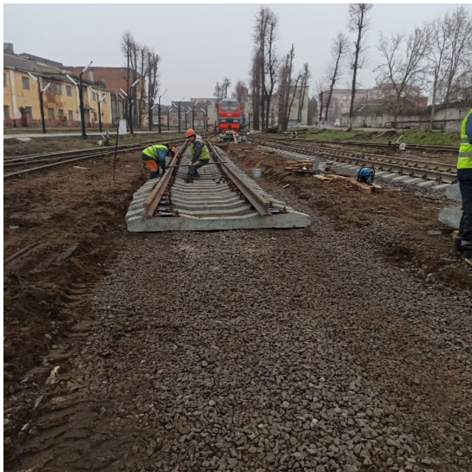
Укладка рельсошпальной решетки пути №7 до
