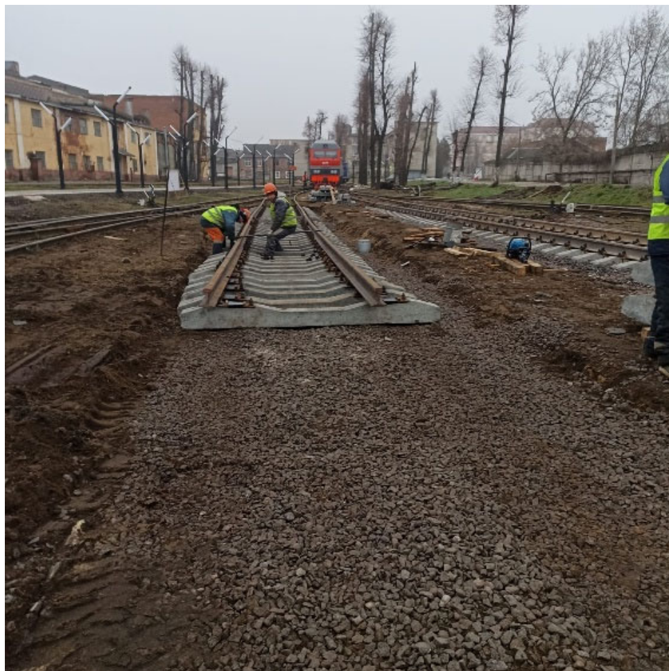
Устройство щебеночного балласта под путь №7 после
