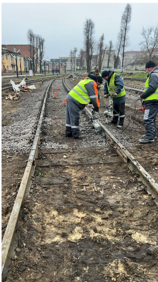
Балластировка, выправка и рихтовка пути №7 до
