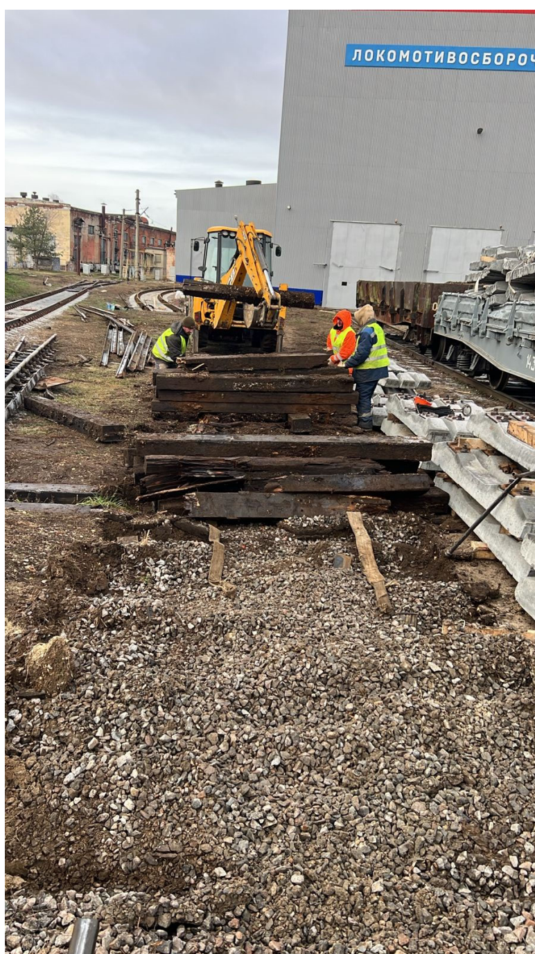
Демонтаж рельсошпальной решетки пути №7 после
