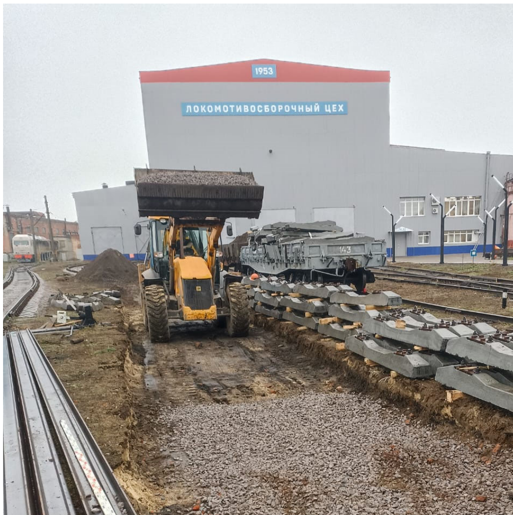
Устройство щебеночного балласта под путь №7 до
