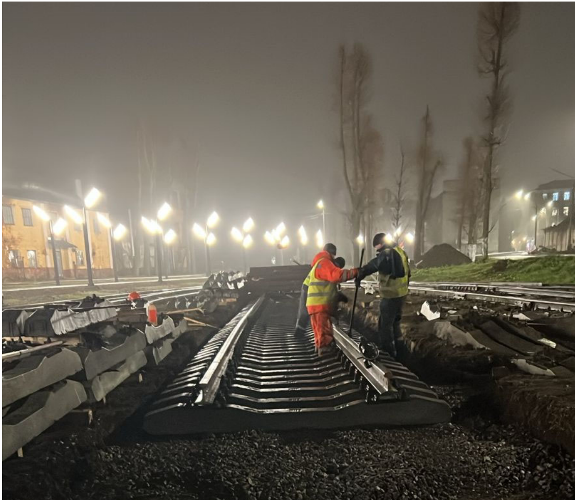
Устройство щебеночного балласта под путь №7 после
