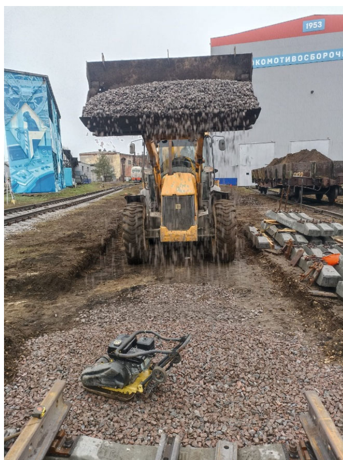
Устройство щебеночного балласта под путь №7 до
