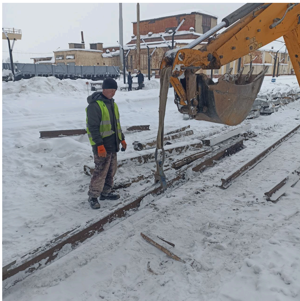
Демонтаж рельсошпальной решетки пути №8 после
