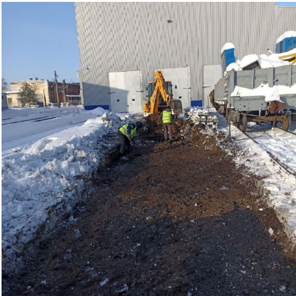
Устройство щебеночного балласта под путь №8 до
