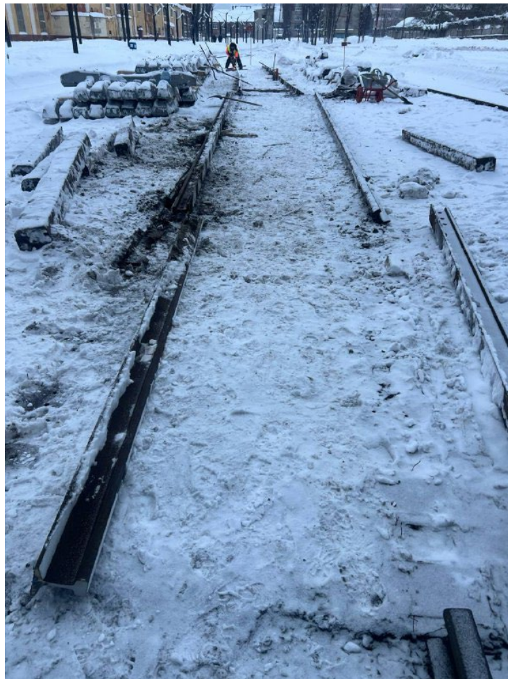
Демонтаж рельсошпальной решетки пути №8 после
