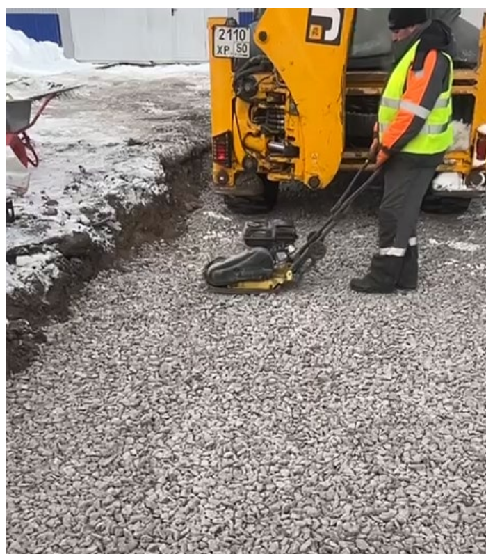
Устройство щебеночного балласта под путь №8 после
