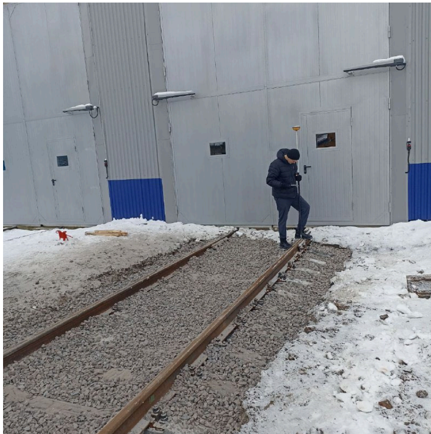
Балластировка, выправка и рихтовка пути №8 после
