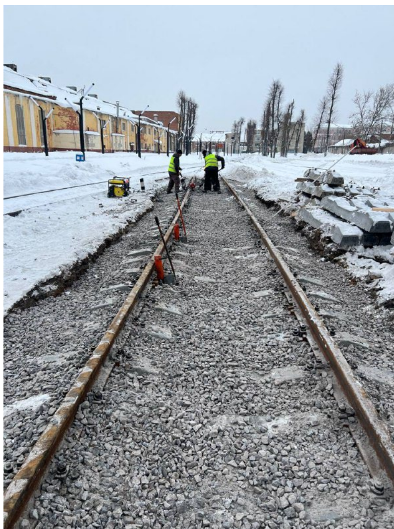
Балластировка, выправка и рихтовка пути №8 после
