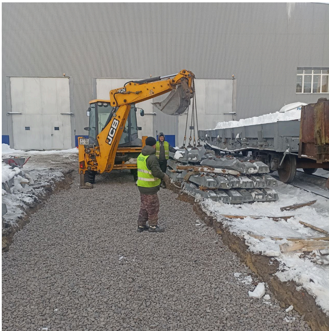
Укладка рельсошпальной решетки пути №8 до
