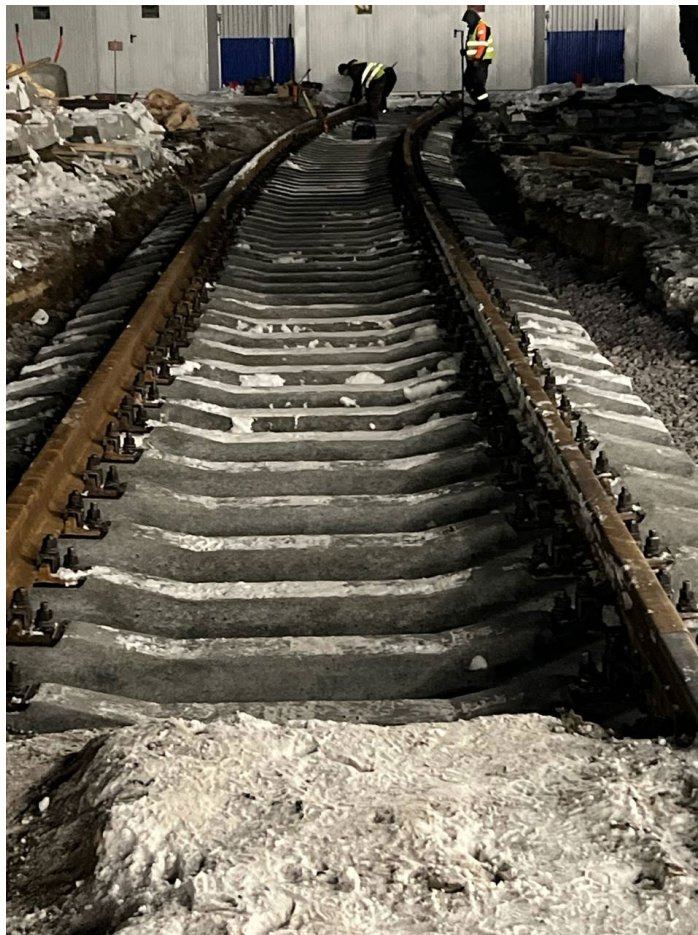
Балластировка, выправка и рихтовка пути №8 до
