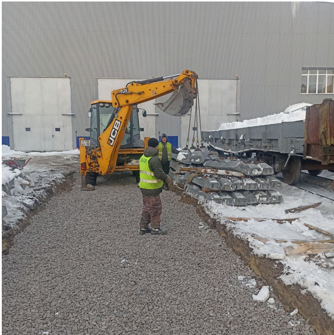
Устройство щебеночного балласта под путь №8 после
