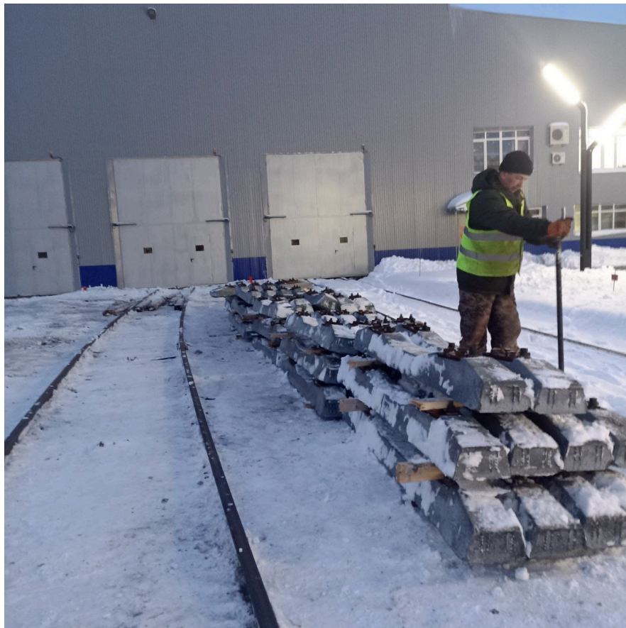
Демонтаж рельсошпальной решетки пути №8 до
