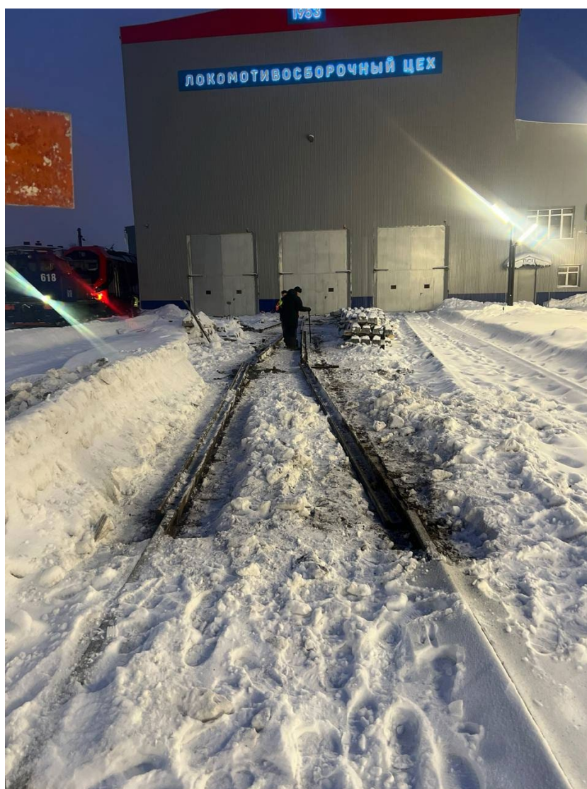
Демонтаж рельсошпальной решетки пути №8 до
