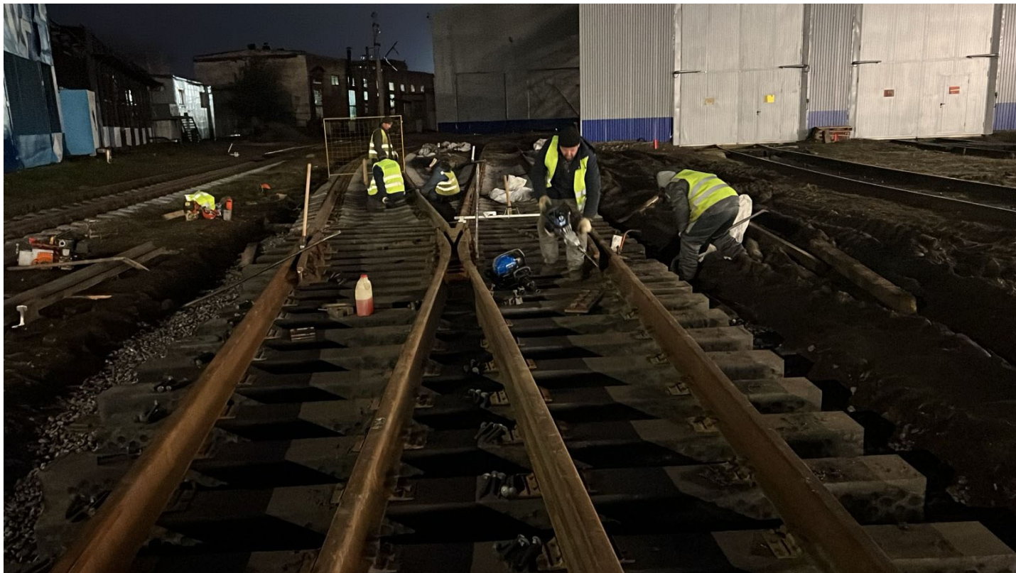
Балластировка, выправка и рихтовка стрелочного перевода №10 до
