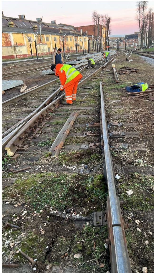
Демонтаж стрелочного перевода №10 до
