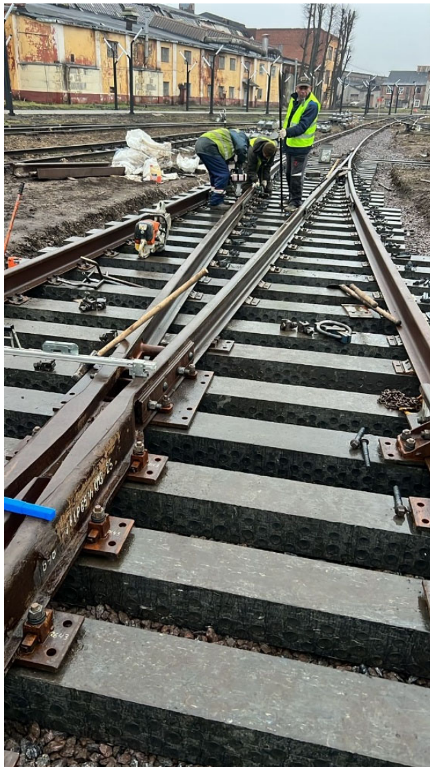
Укладка стрелочного перевода №10 после
