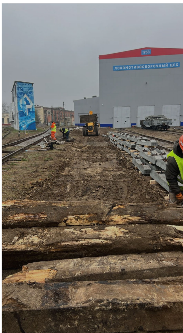
Выемка загрязненного балласта под стрелочный перевод №10 до
