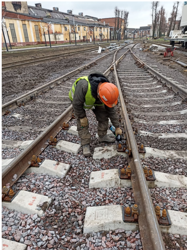
Балластировка, выправка и рихтовка стрелочного перевода №10 после
