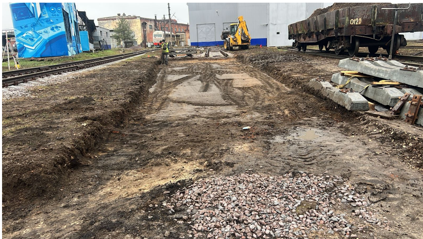
Выемка загрязненного балласта под стрелочный перевод №10 после
