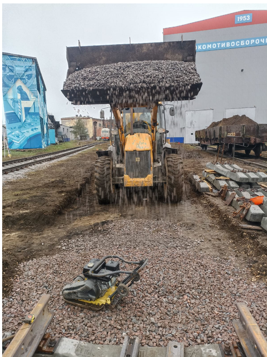
Устройство щебеночного балласта под стрелочный перевод №10 до
