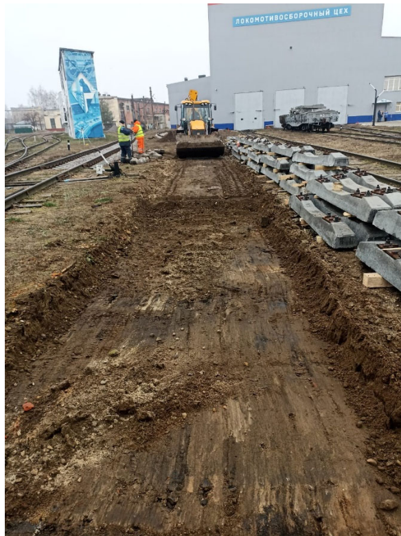
Устройство щебеночного балласта под стрелочный перевод №10 до
