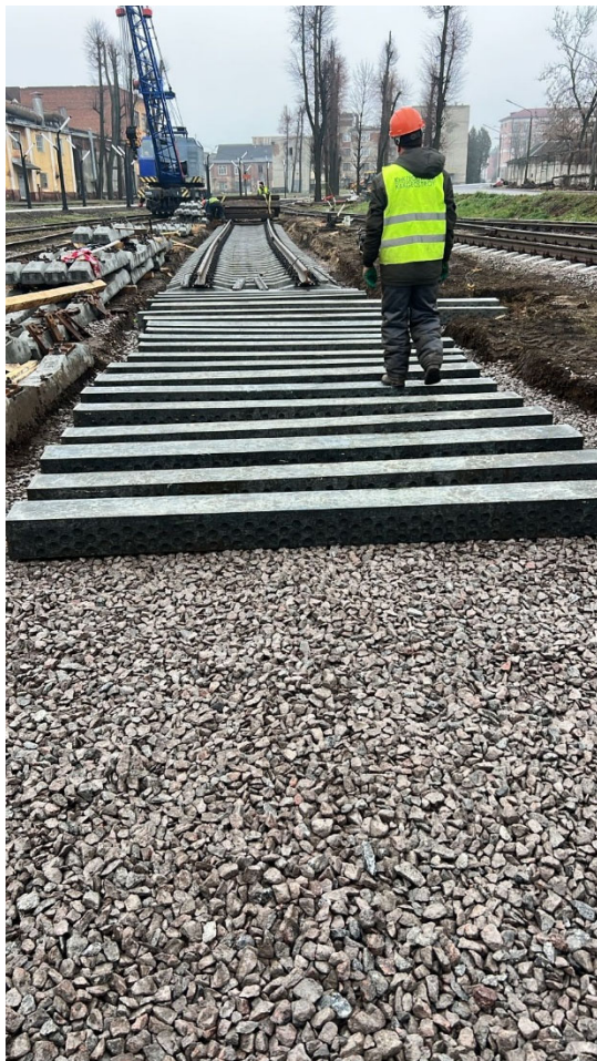
Устройство щебеночного балласта под стрелочный перевод №10 после
