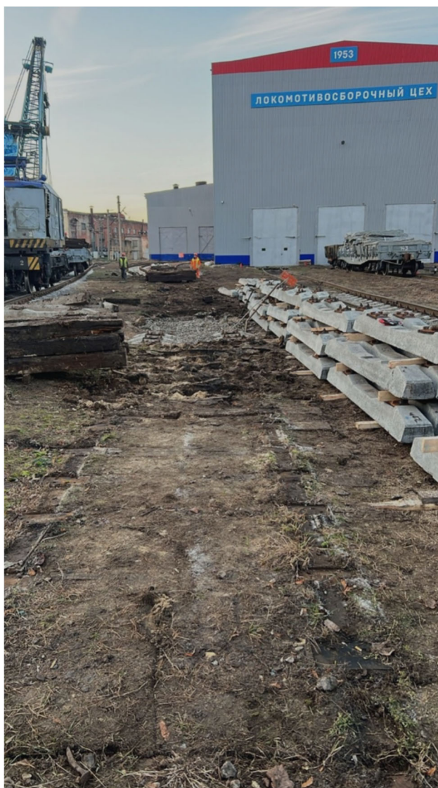
Демонтаж стрелочного перевода №10 после
