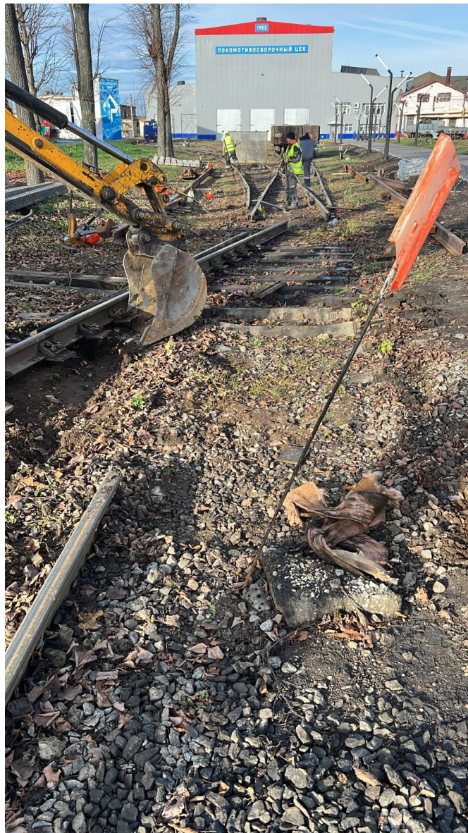
Демонтаж стрелочного перевода №6 после
