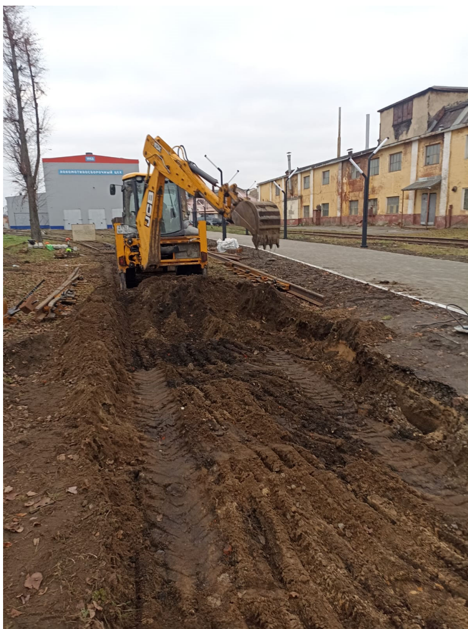
Выемка загрязненного балласта под стрелочный перевод №6 после
