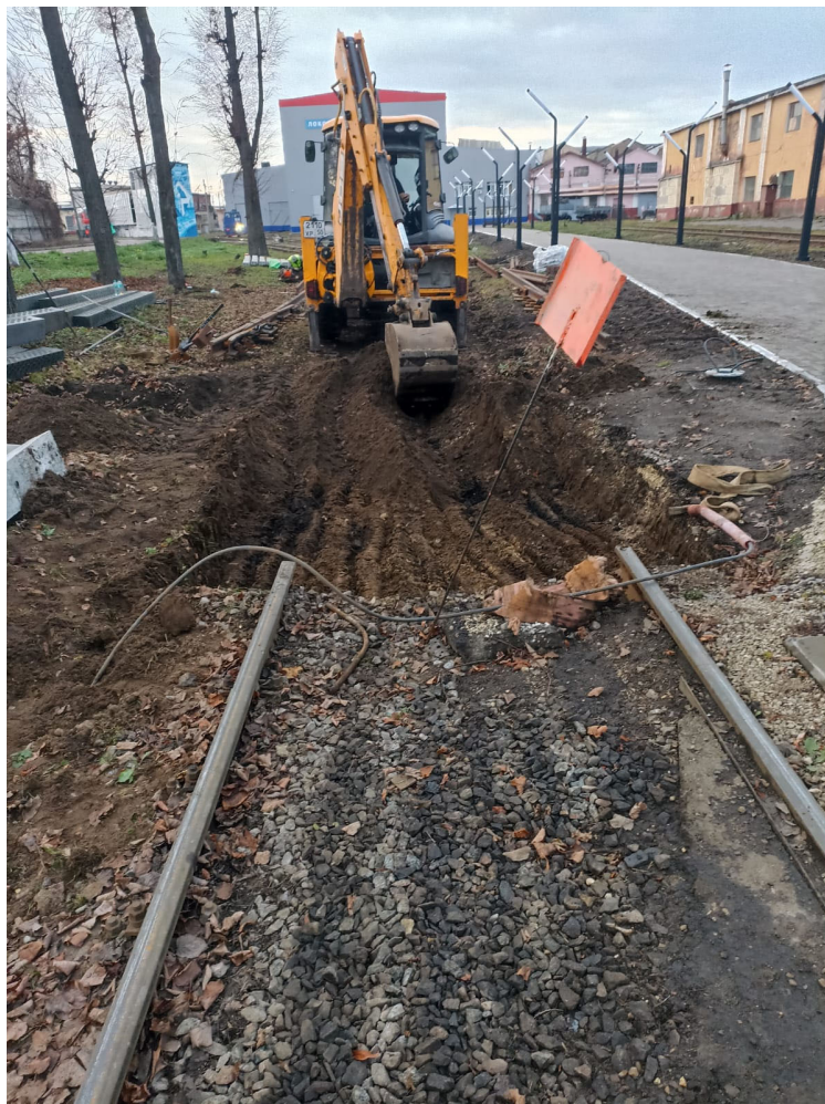
Выемка загрязненного балласта под стрелочный перевод №6 до
