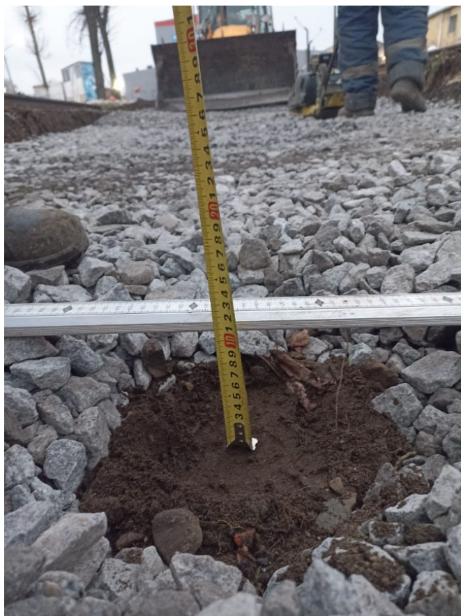
Устройство щебеночного балласта под стрелочный перевод №6 после
