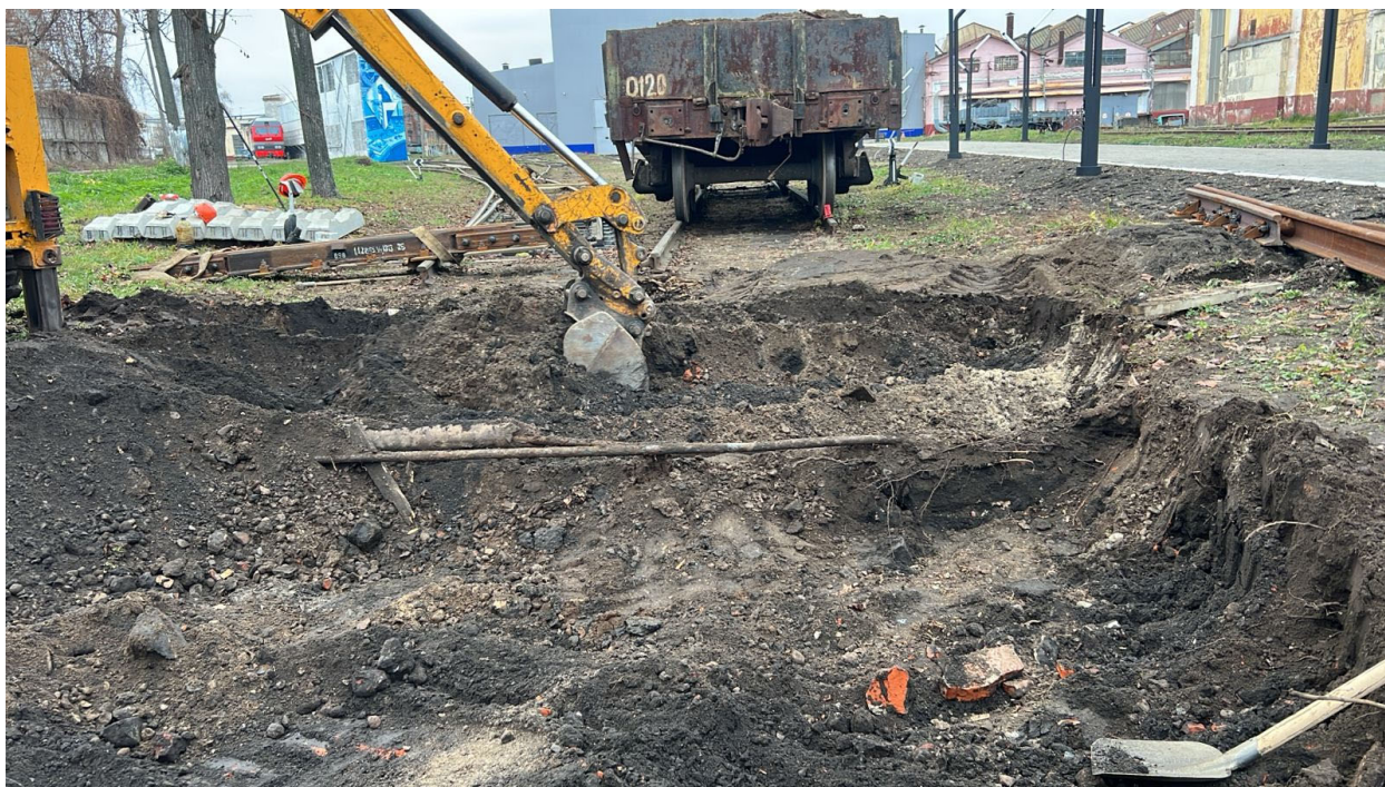
Выемка загрязненного балласта под стрелочный перевод №6 после
