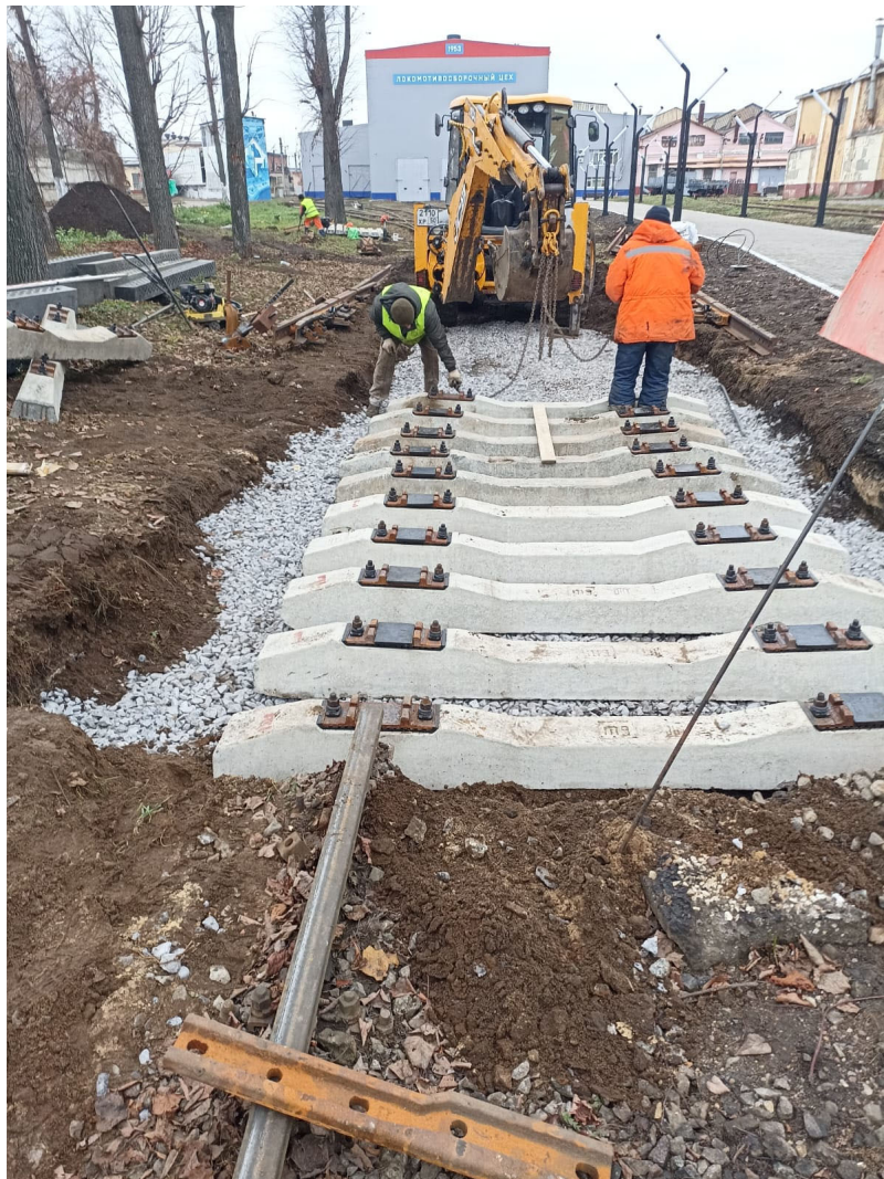
Устройство щебеночного балласта под стрелочный перевод №6 после
