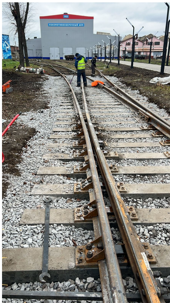
Балластировка, выправка и рихтовка стрелочного перевода №6 после
