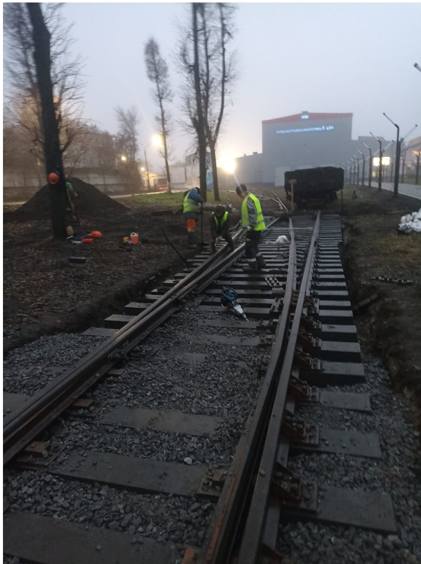
Укладка стрелочного перевода №6 после
