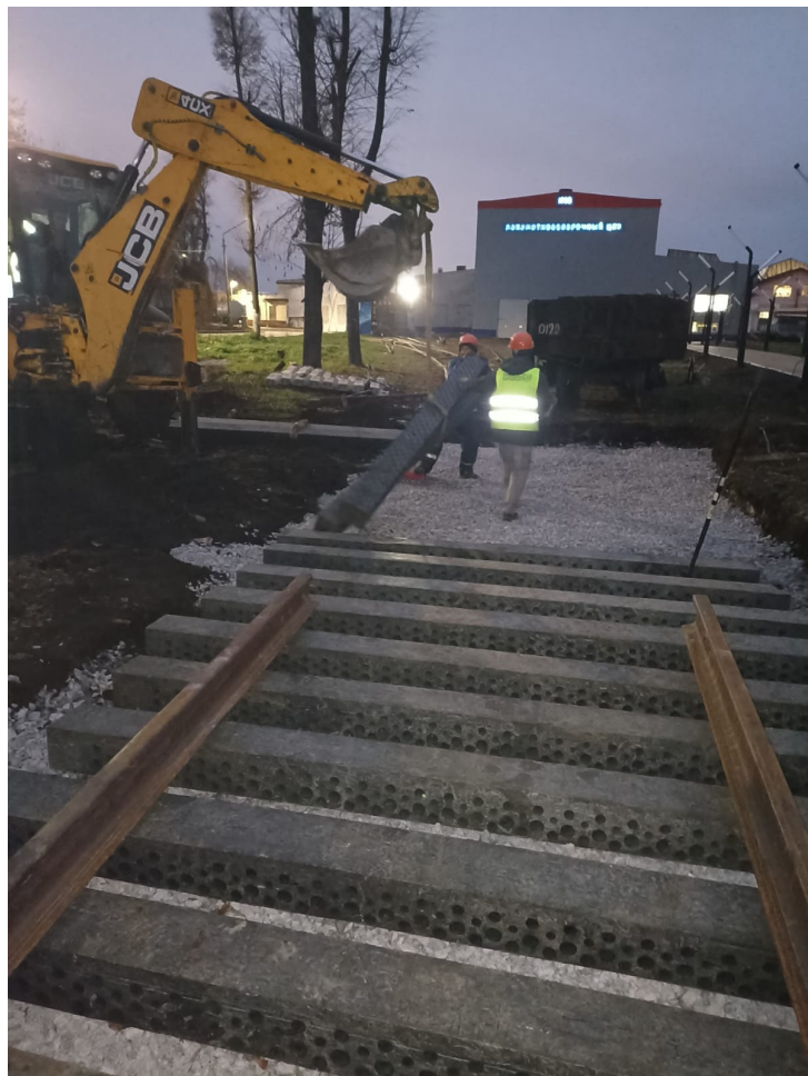
Укладка стрелочного перевода №6 до
