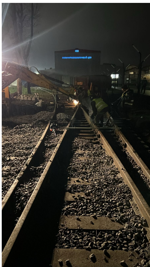
Балластировка, выправка и рихтовка стрелочного перевода №6 до
