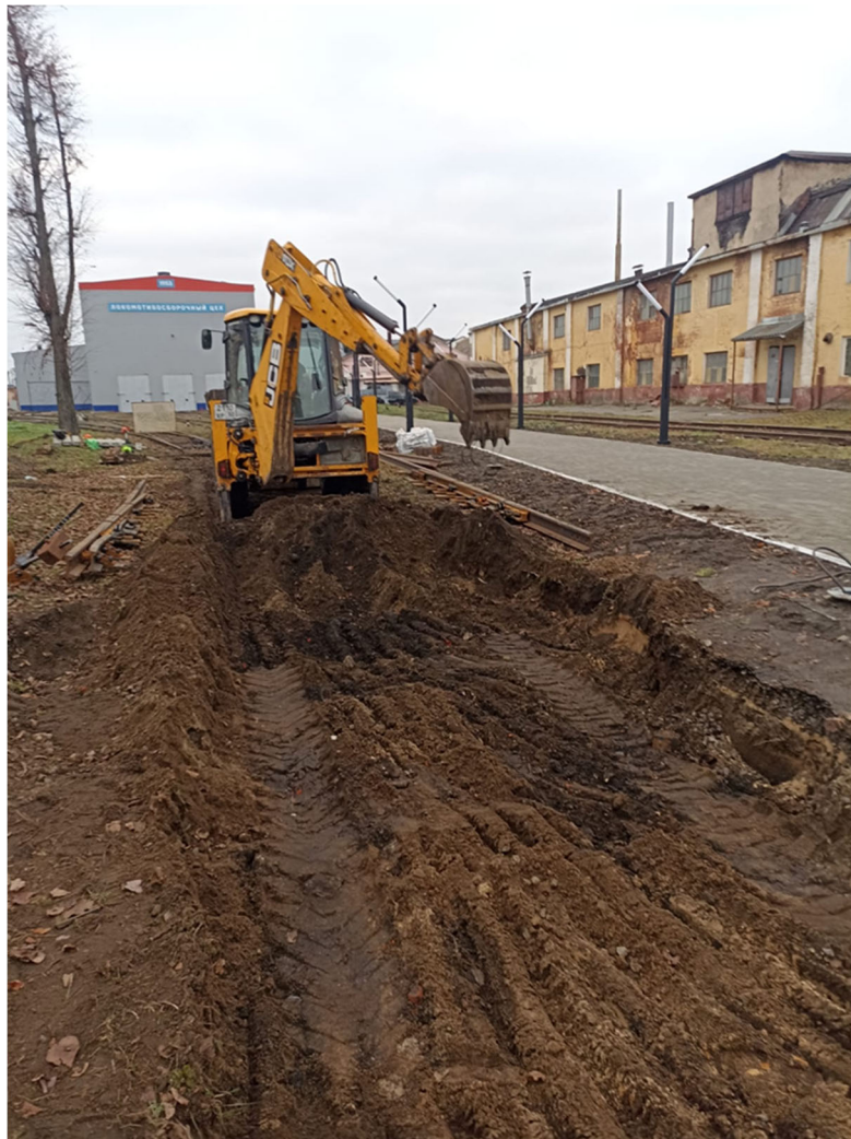
Устройство щебеночного балласта под стрелочный перевод №6 до
