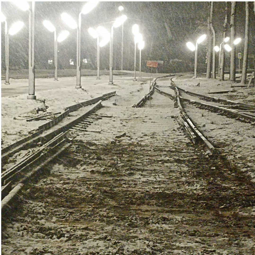
Демонтаж стрелочного перевода №7 после
