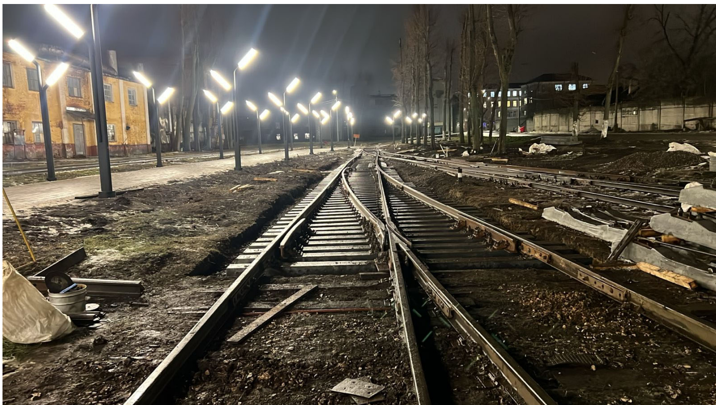
Балластировка, выправка и рихтовка стрелочного перевода №7 до
