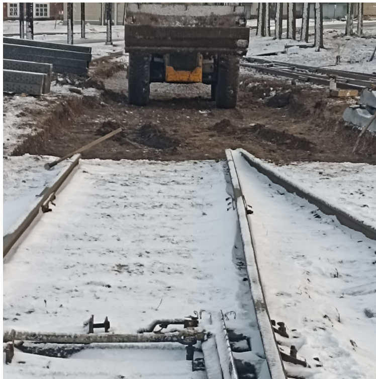
Устройство щебеночного балласта под стрелочный перевод №7 до
