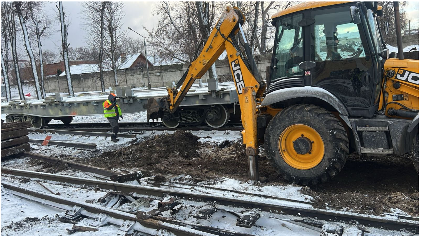
Выемка загрязненного балласта под стрелочный перевод №7 до
