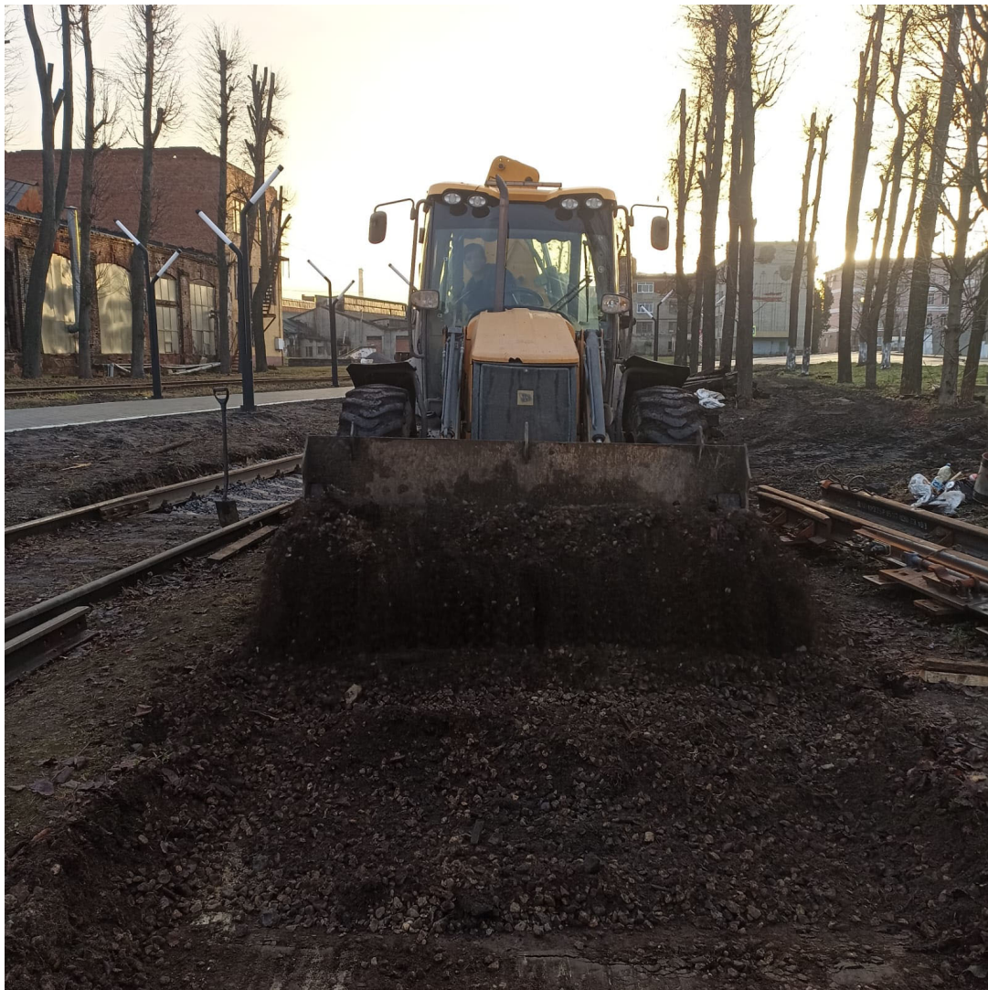
Выемка загрязненного балласта под стрелочный перевод №7 после
