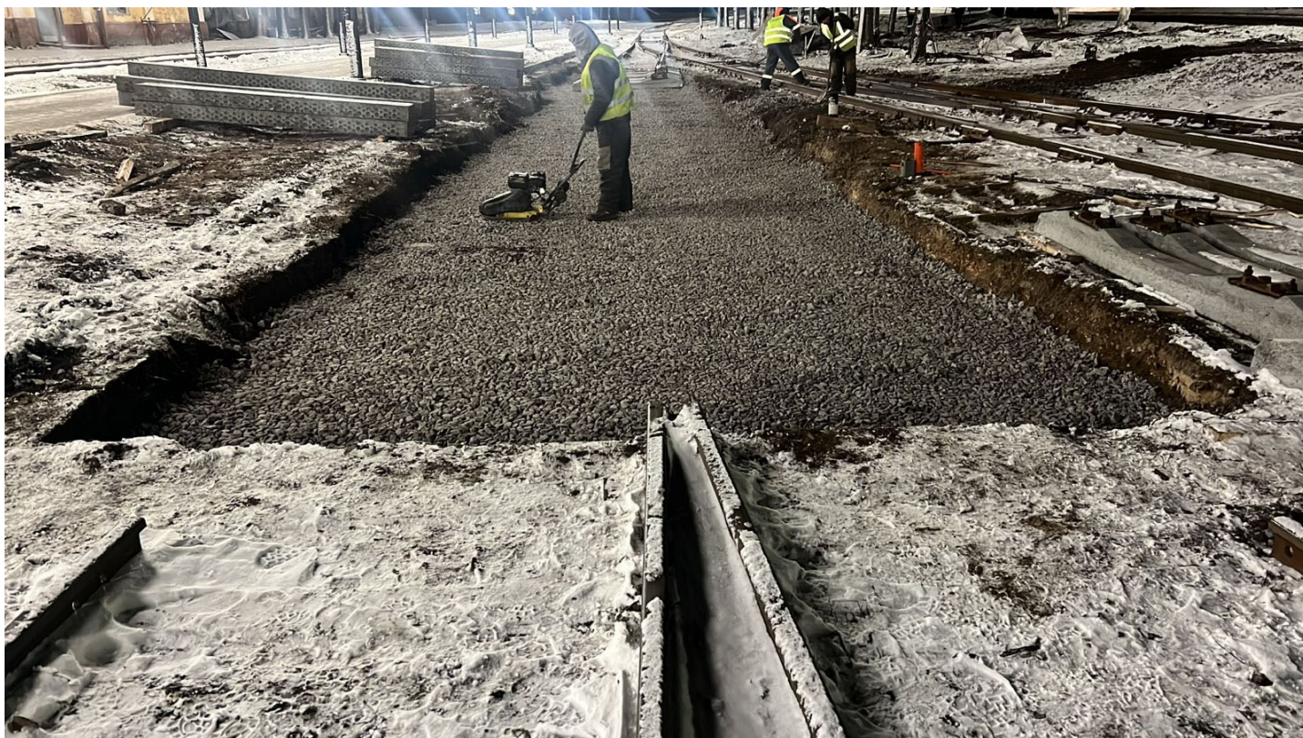
Укладка стрелочного перевода №7 до
