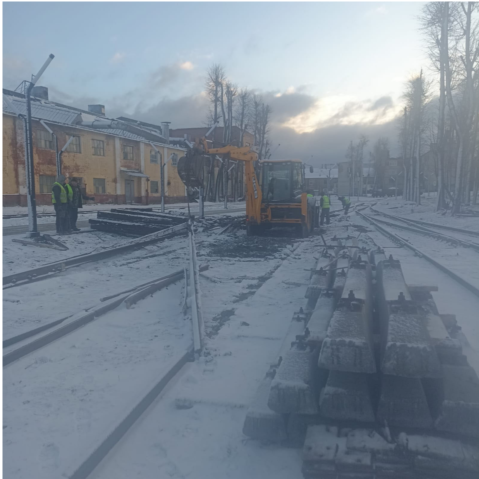
Выемка загрязненного балласта под стрелочный перевод №7 до
