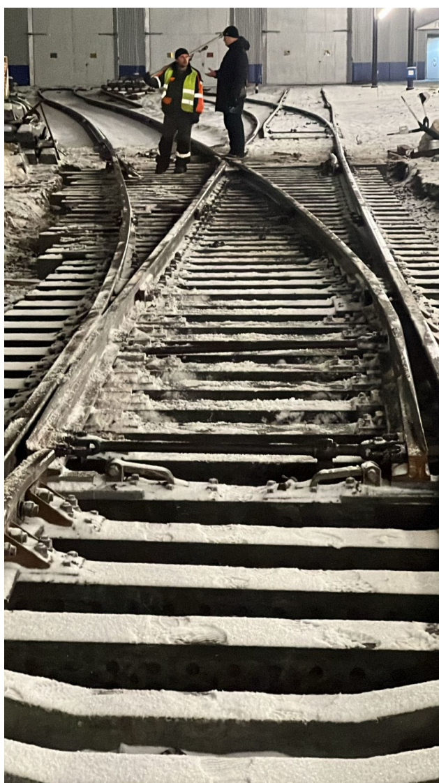
Укладка стрелочного перевода №7 после
