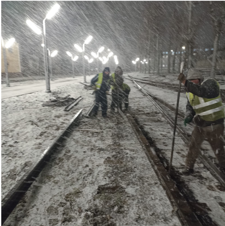
Демонтаж стрелочного перевода №7 после
