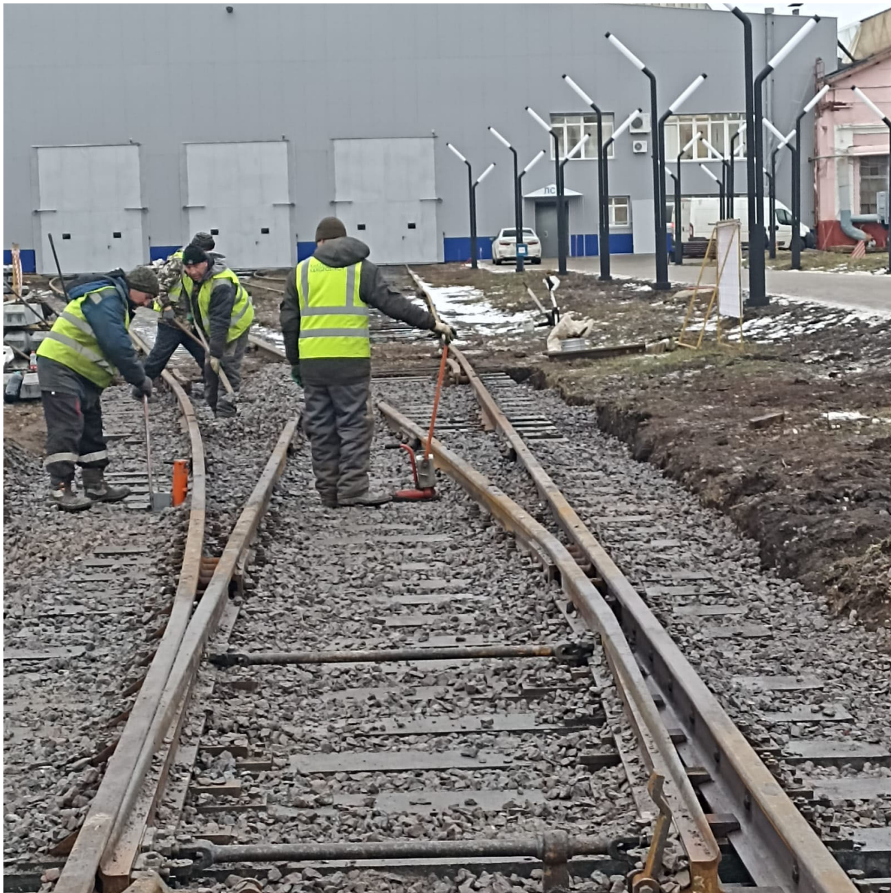
Балластировка, выправка и рихтовка стрелочного перевода №7 после
