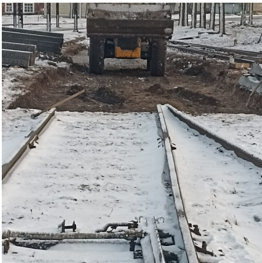
Выемка загрязненного балласта под стрелочный перевод №7 после
