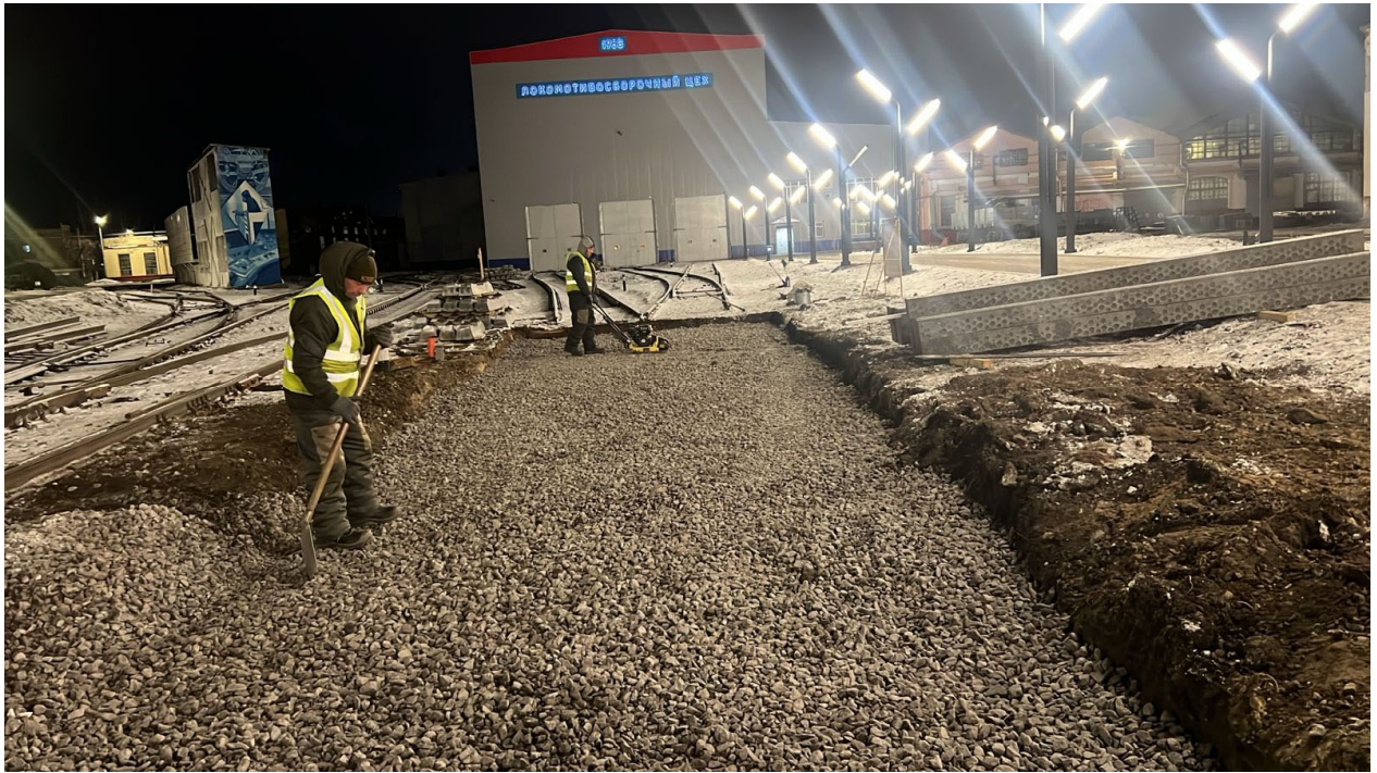
Устройство щебеночного балласта под стрелочный перевод №7 после
