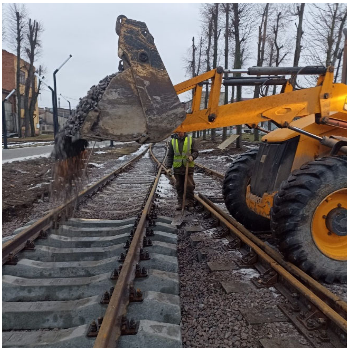
Устройство щебеночного балласта под стрелочный перевод №7 до
