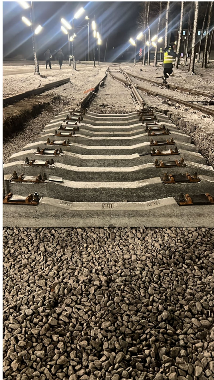
Устройство щебеночного балласта под стрелочный перевод №7 после
