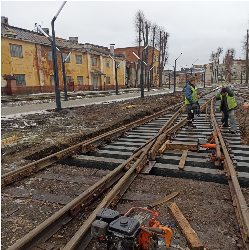
Укладка стрелочного перевода №7 после
