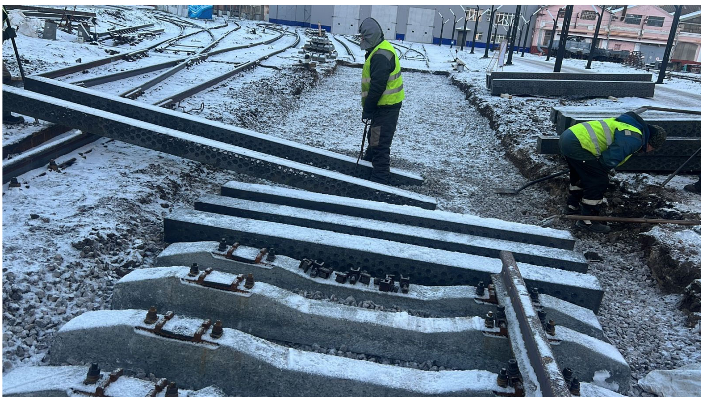
Укладка стрелочного перевода №7 до
