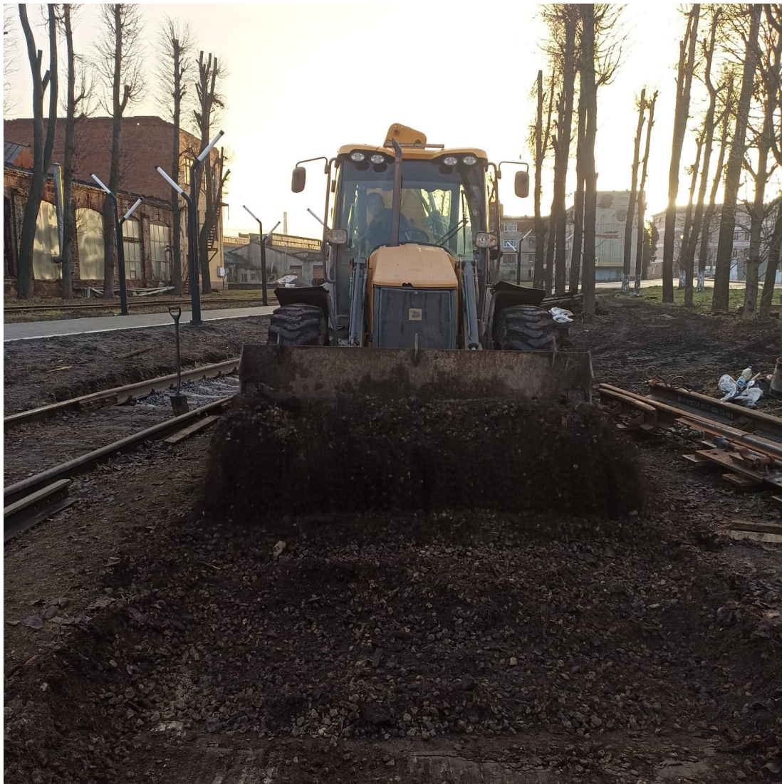
Устройство щебеночного балласта под стрелочный перевод №9 до
