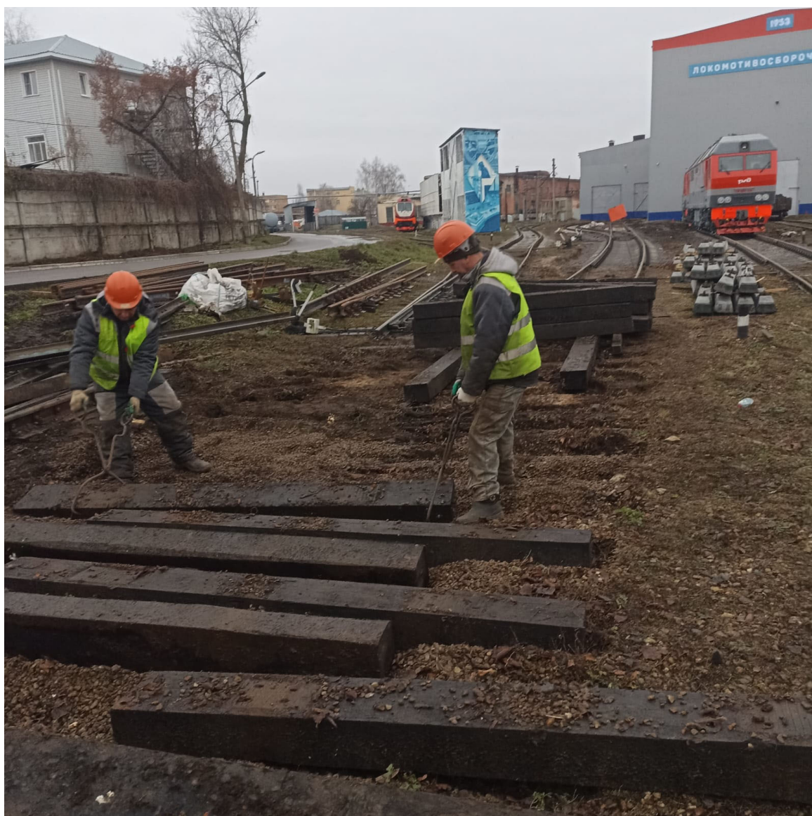
Выемка загрязненного балласта под стрелочный перевод №9 до
