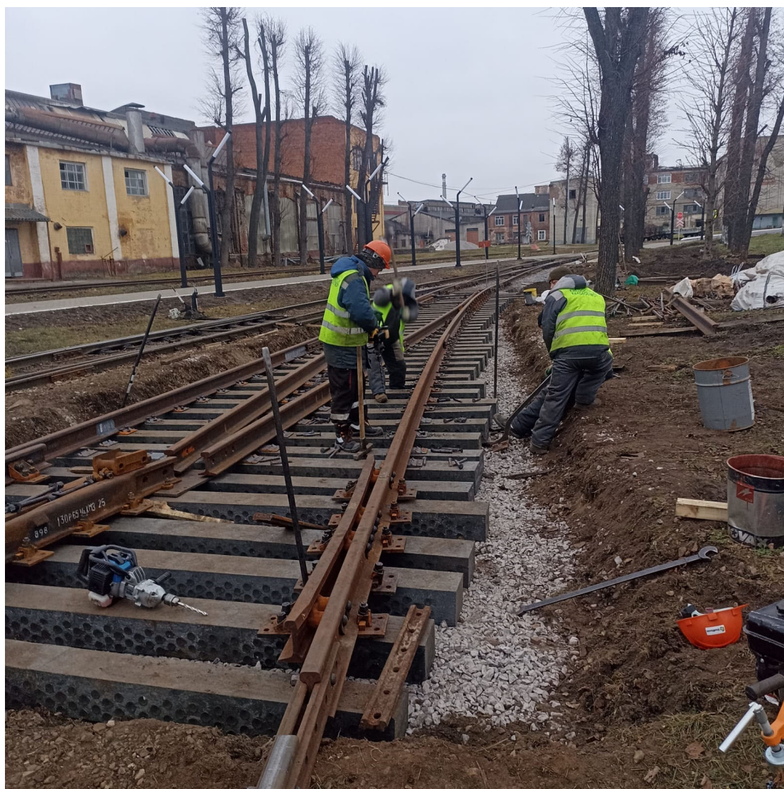
Укладка стрелочного перевода №9 после
