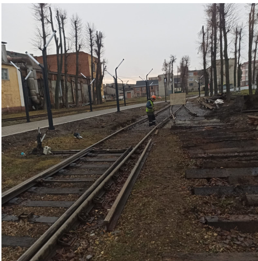
Демонтаж стрелочного перевода №9 после
