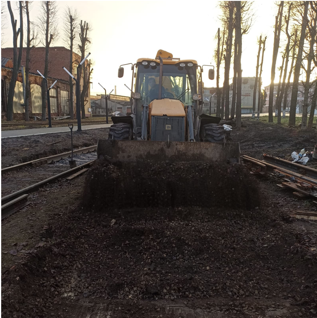
Выемка загрязненного балласта под стрелочный перевод №9 после
