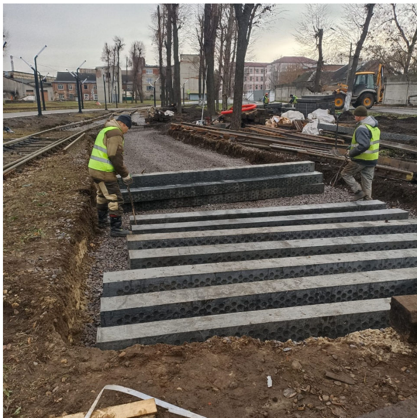
Устройство щебеночного балласта под стрелочный перевод №9 после
