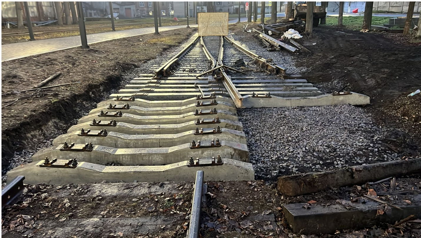
Укладка стрелочного перевода №9 до
