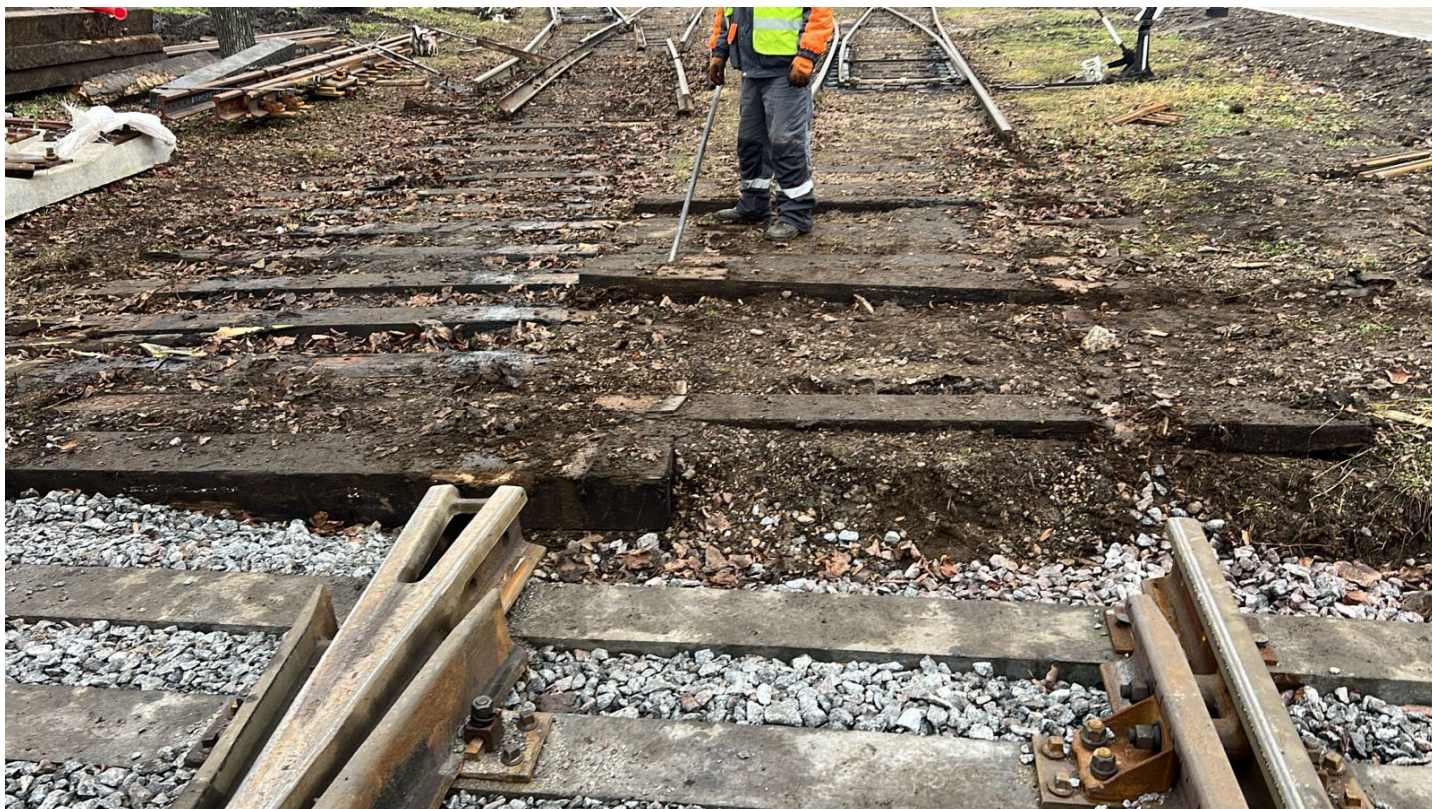
Демонтаж стрелочного перевода №9 после
