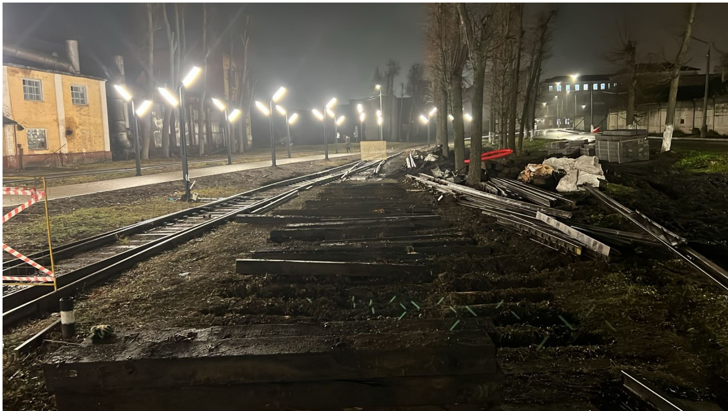
Выемка загрязненного балласта под стрелочный перевод №9 до
