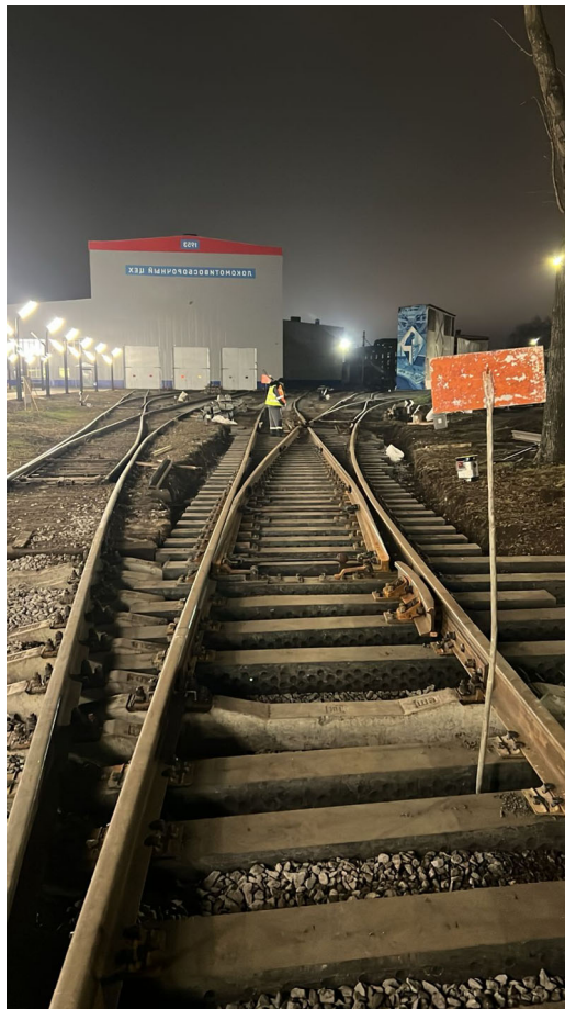
Балластировка, выправка и рихтовка стрелочного перевода №9 до
