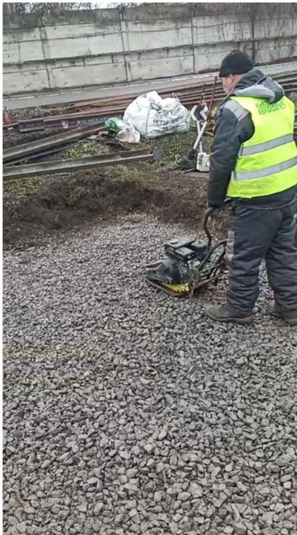
Устройство щебеночного балласта под стрелочный перевод №9 после
