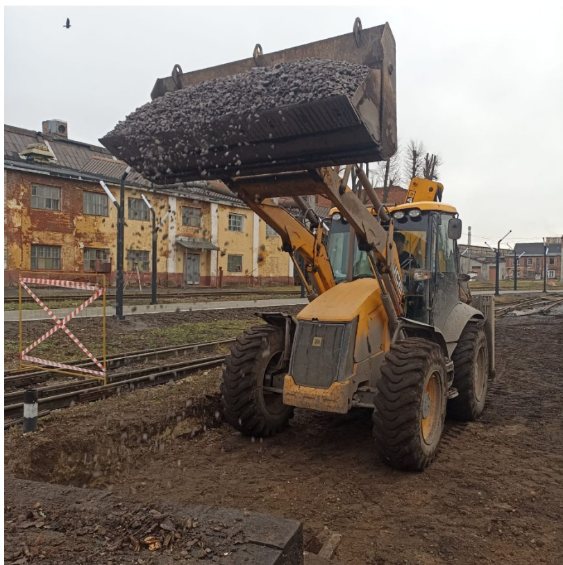
Выемка загрязненного балласта под стрелочный перевод №9 после
