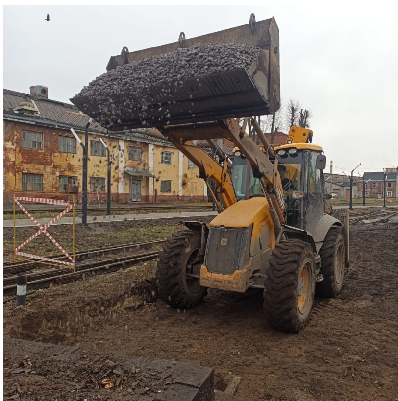
Устройство щебеночного балласта под стрелочный перевод №9 до
