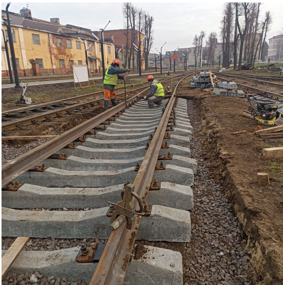
Балластировка, выправка и рихтовка пути №7 до
