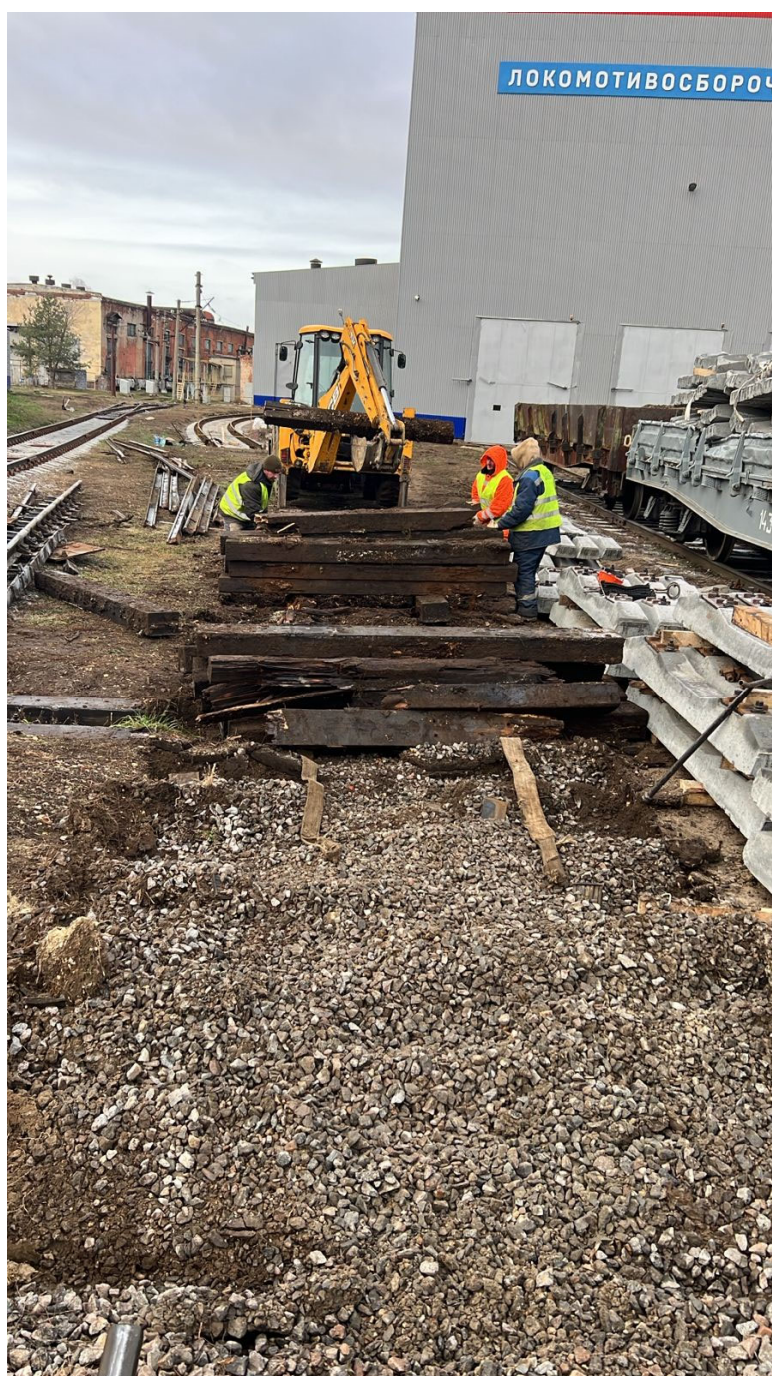
Демонтаж рельсошпальной решетки пути №7 после
