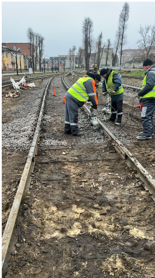
Балластировка, выправка и рихтовка пути №7 после
