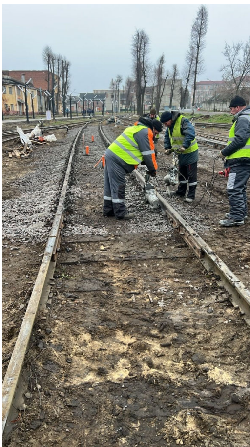
Балластировка, выправка и рихтовка пути №7 до
