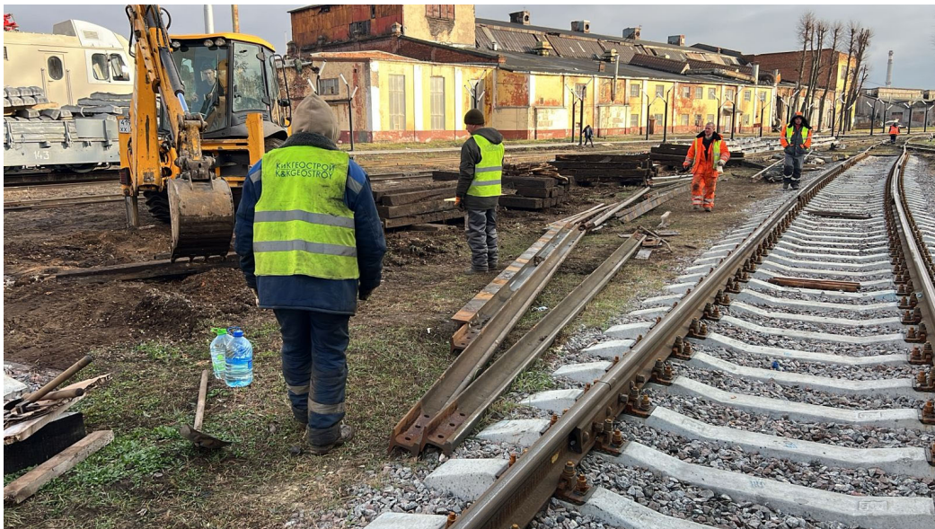
Демонтаж рельсошпальной решетки пути №7 после
