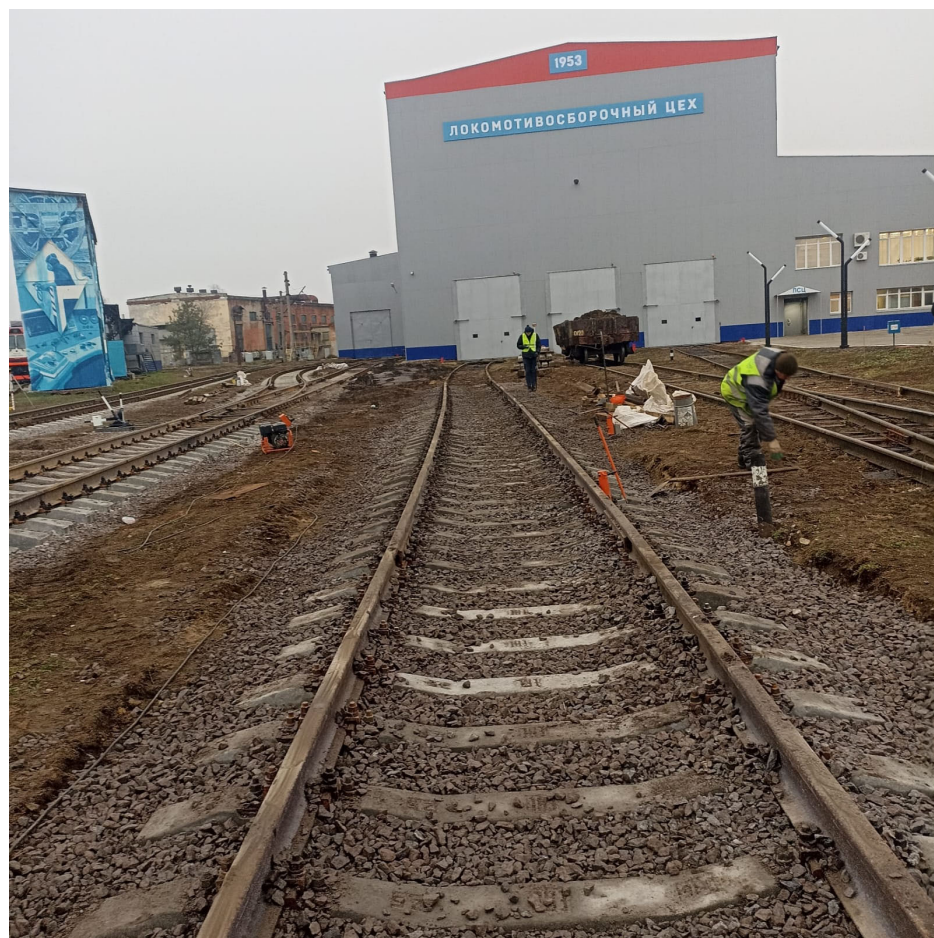
Балластировка, выправка и рихтовка пути №7 после
