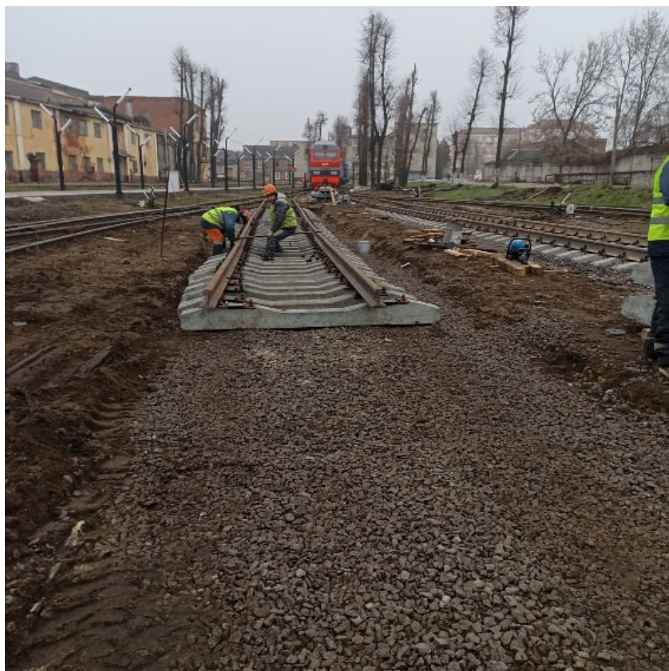
Укладка рельсошпальной решетки пути №7 до
