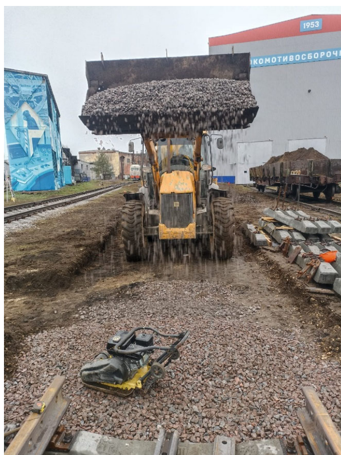
Устройство щебеночного балласта под путь №7 до
