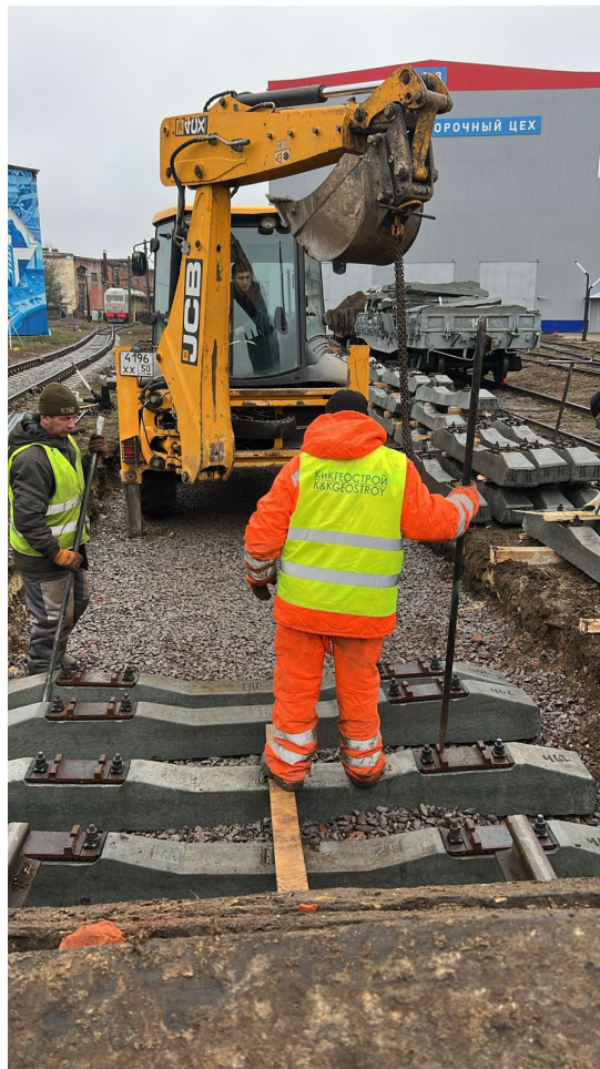
Укладка рельсошпальной решетки пути №7 до
