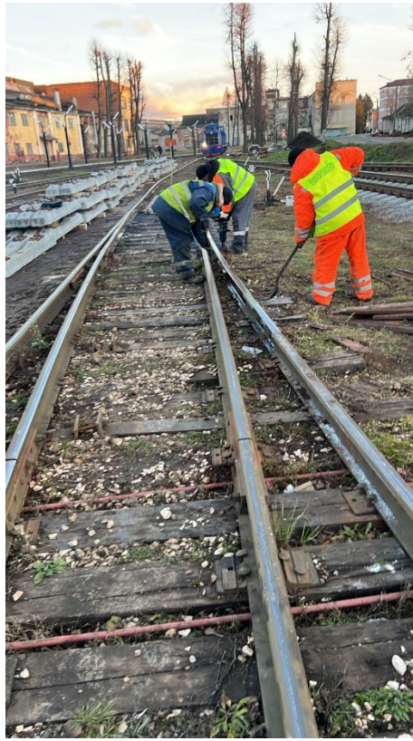
Демонтаж стрелочного перевода №10 до
