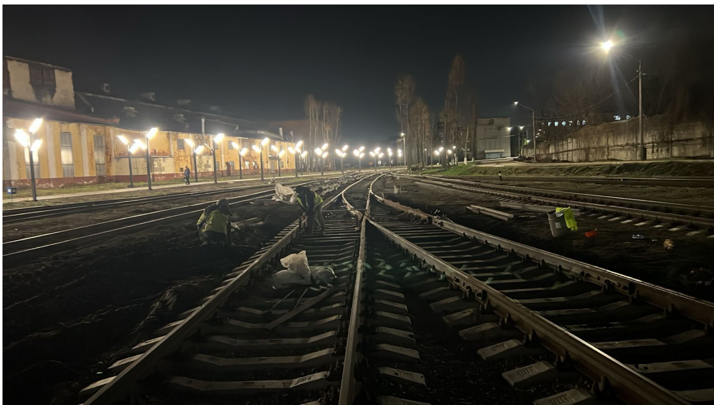
Укладка стрелочного перевода №10 после
