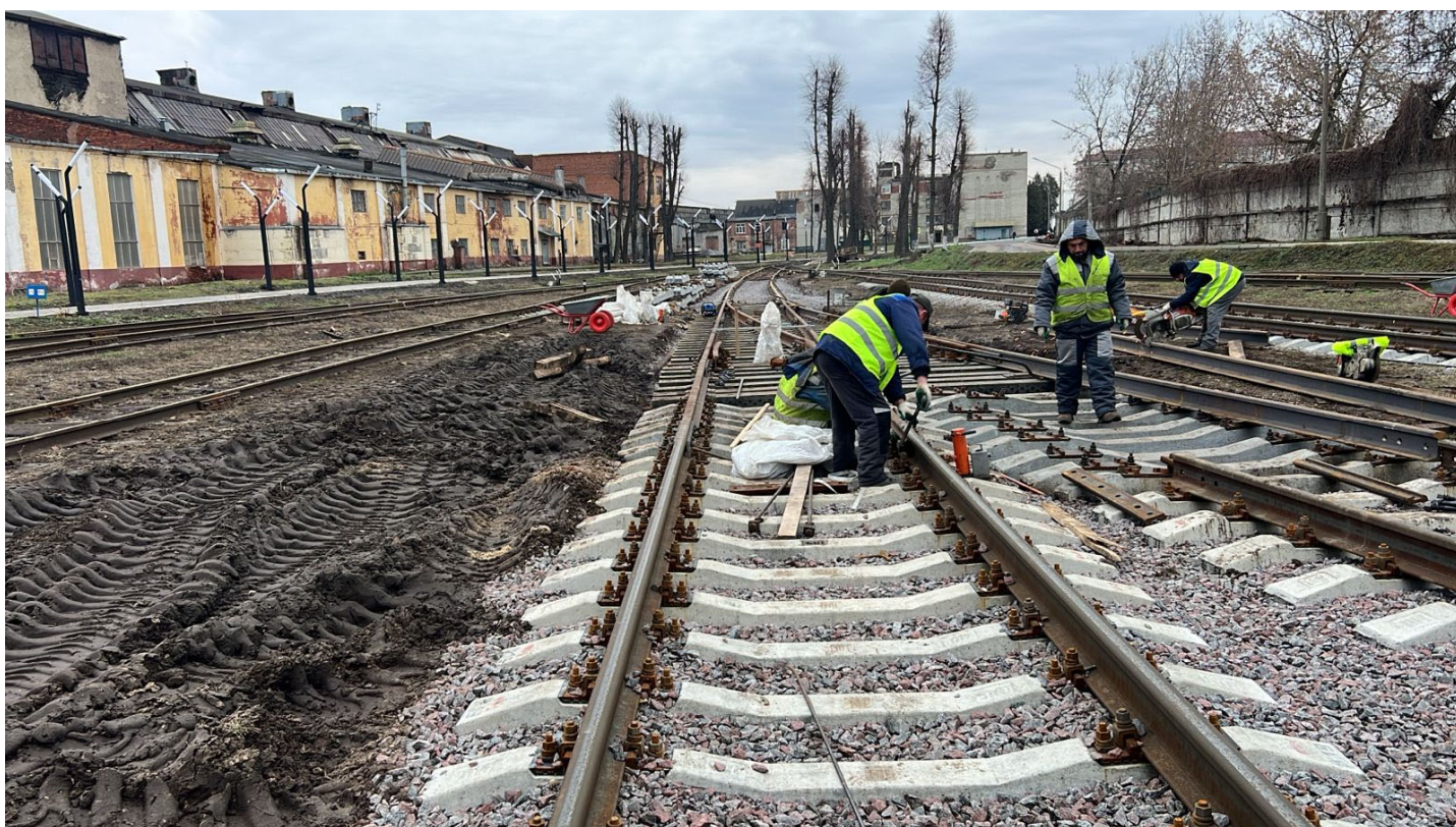
Балластировка, выправка и рихтовка стрелочного перевода №10 до
