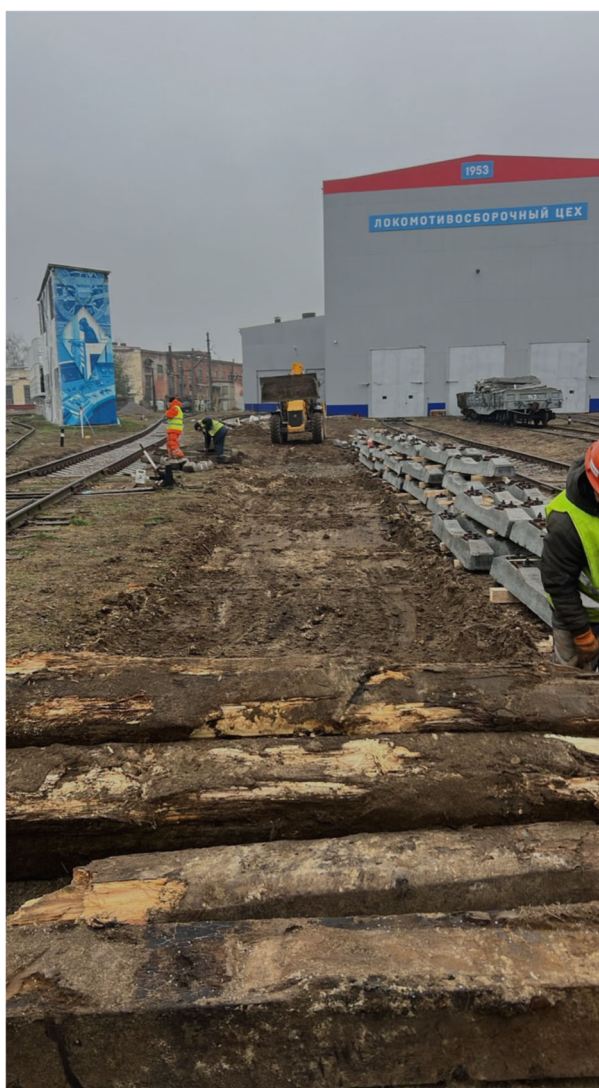
Выемка загрязненного балласта под стрелочный перевод №10 до
