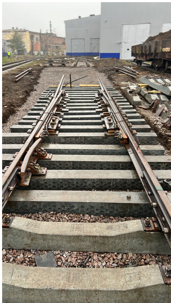
Устройство щебеночного балласта под стрелочный перевод №10 после
