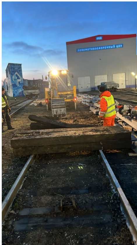
Выемка загрязненного балласта под стрелочный перевод №10 до
