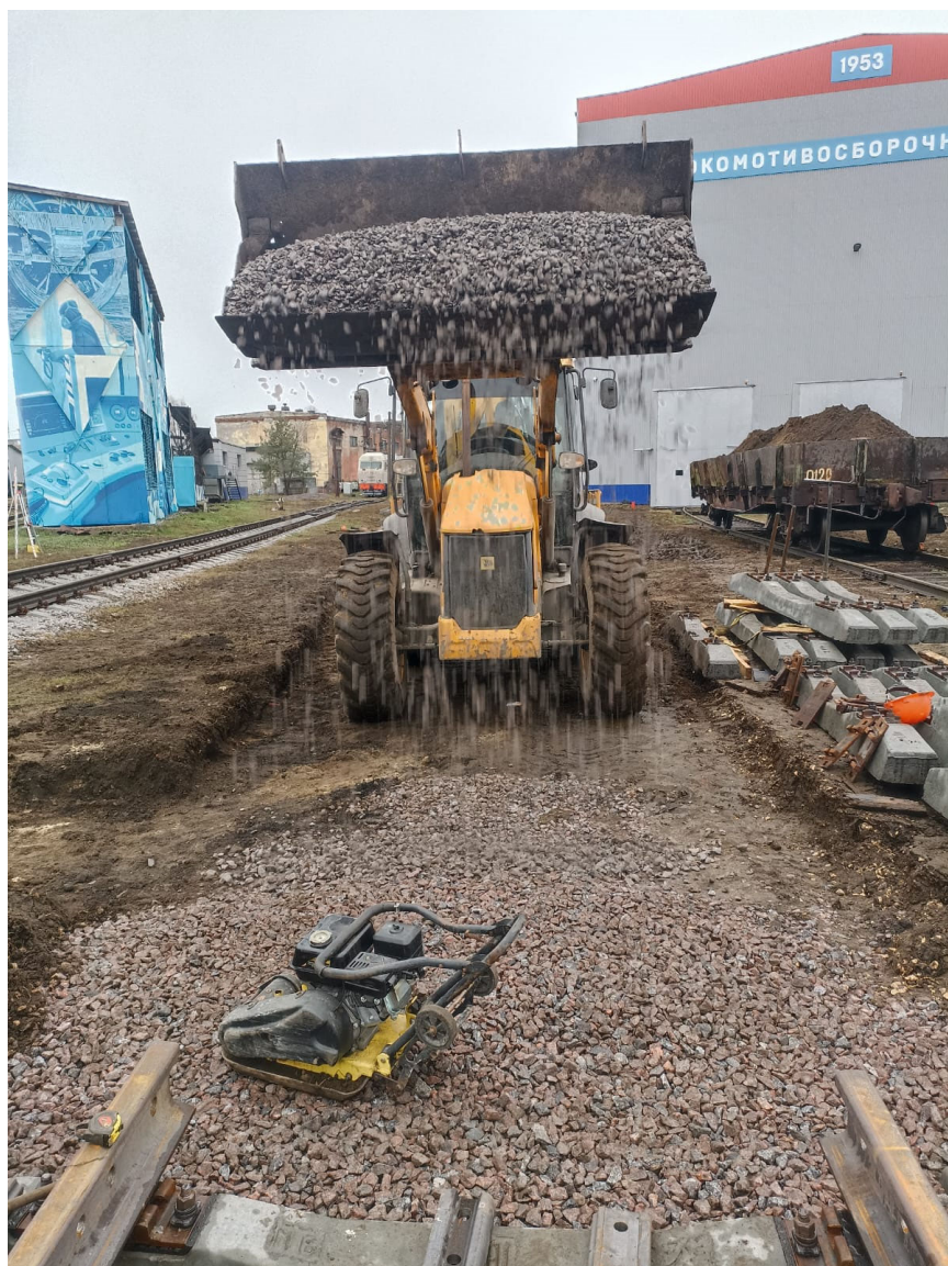
Устройство щебеночного балласта под стрелочный перевод №10 до
