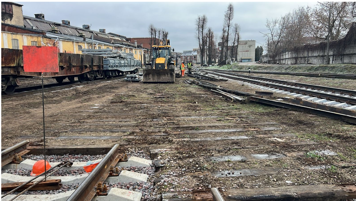
Демонтаж стрелочного перевода №10 после
