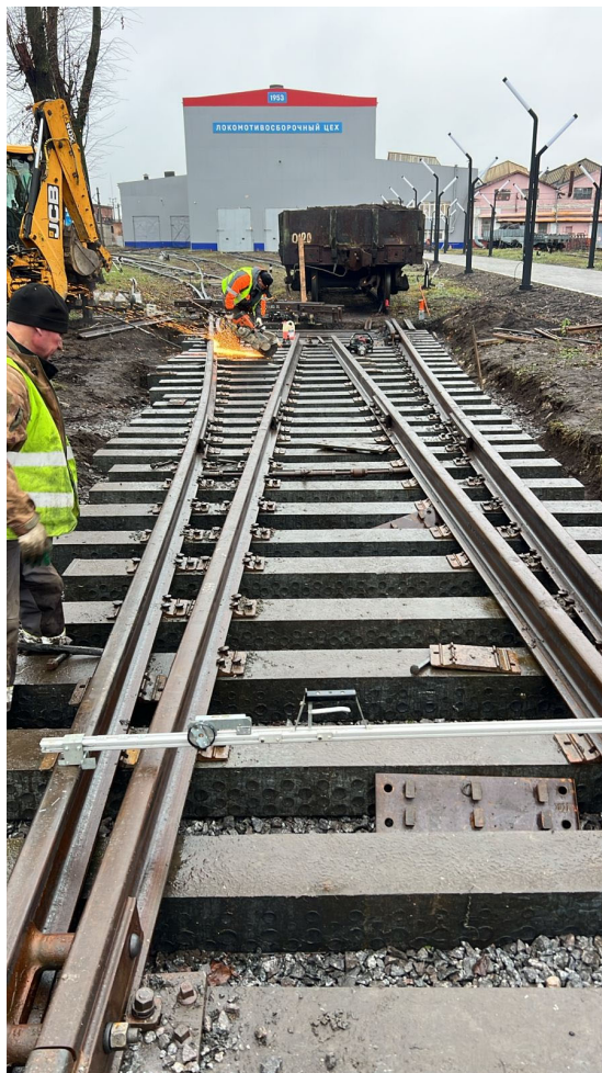
Балластировка, выправка и рихтовка стрелочного перевода №6 до
