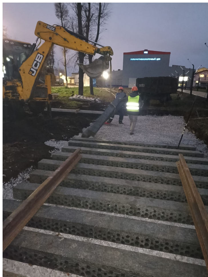
Укладка стрелочного перевода №6 до
