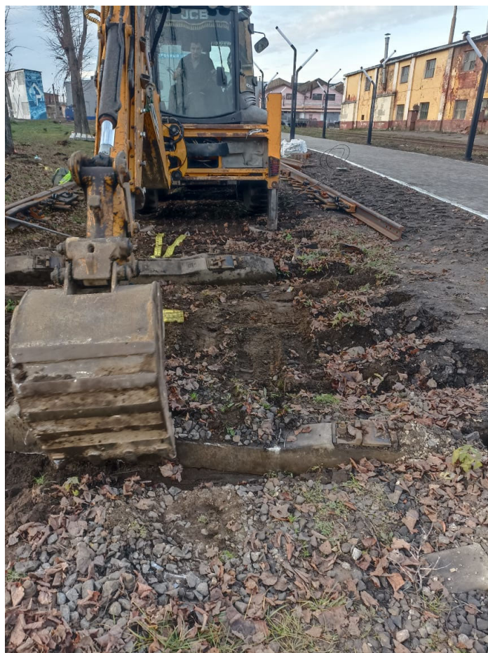
Выемка загрязненного балласта под стрелочный перевод №6 до
