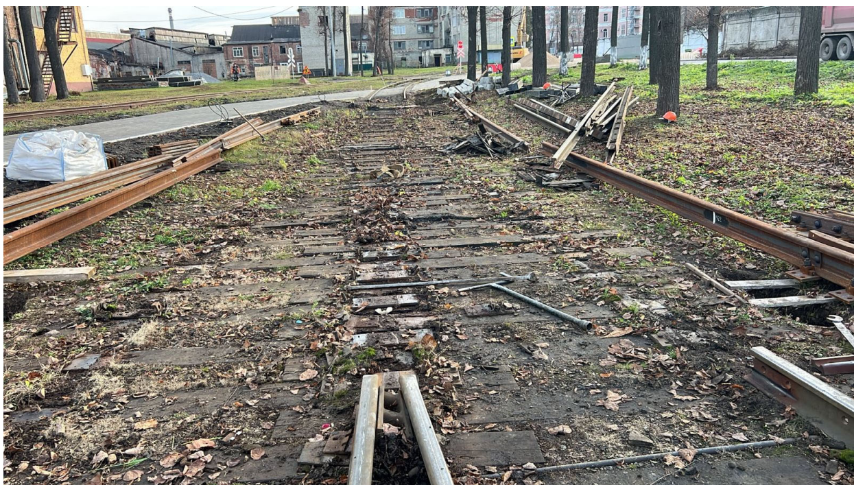
Демонтаж стрелочного перевода №6 после
