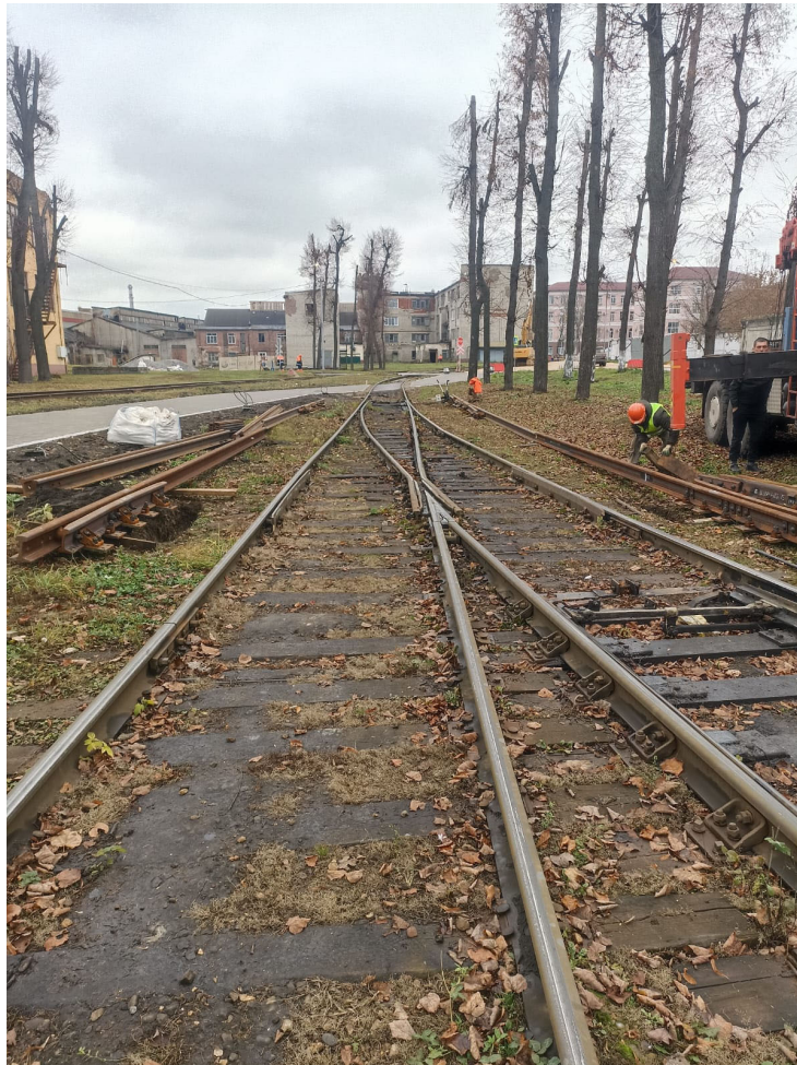
Демонтаж стрелочного перевода №6 до
