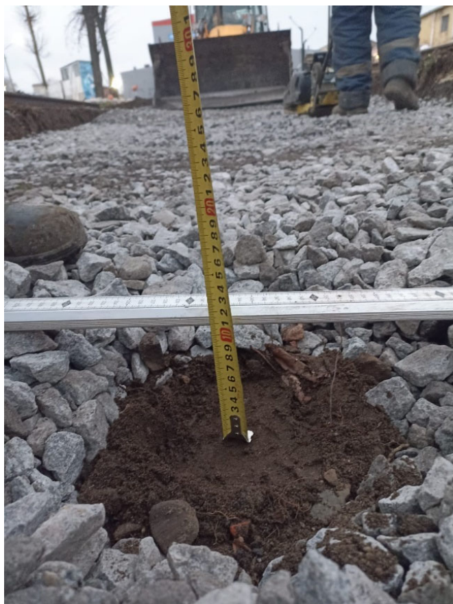
Устройство щебеночного балласта под стрелочный перевод №6 после
