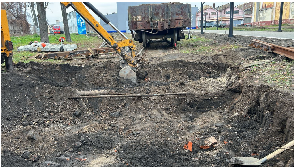
Выемка загрязненного балласта под стрелочный перевод №6 после
