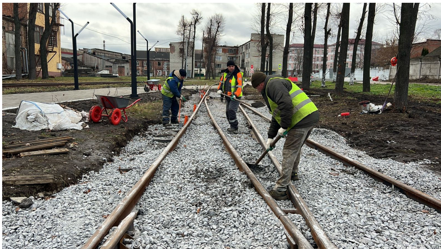
Балластировка, выправка и рихтовка стрелочного перевода №6 после
