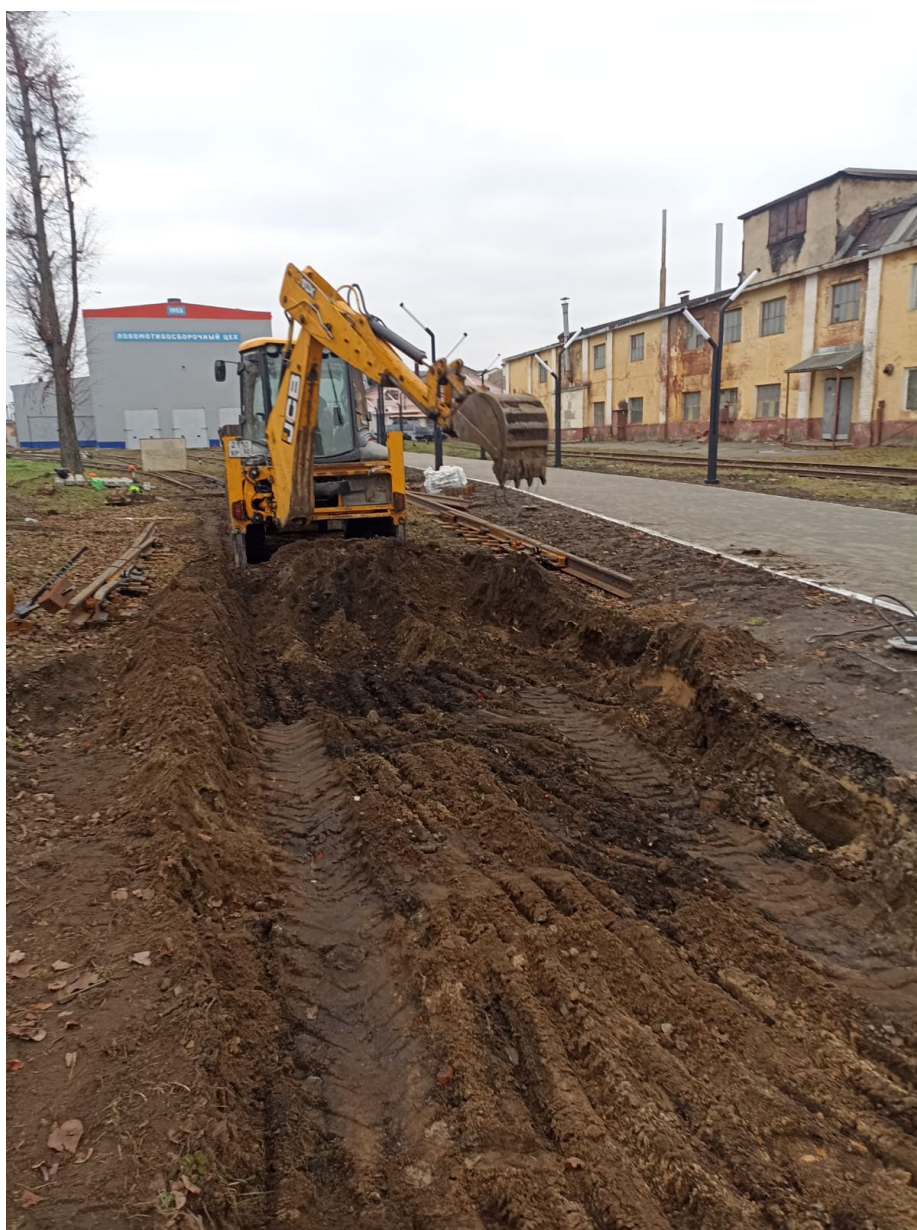
Выемка загрязненного балласта под стрелочный перевод №6 после
