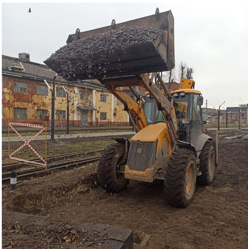
Выемка загрязненного балласта под стрелочный перевод №9 после
