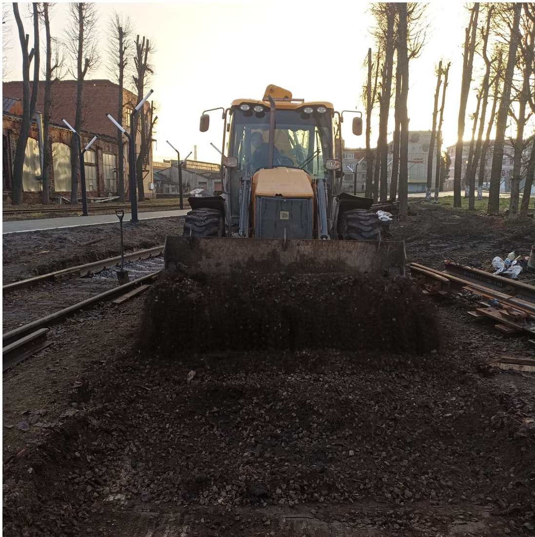
Устройство щебеночного балласта под стрелочный перевод №9 до
