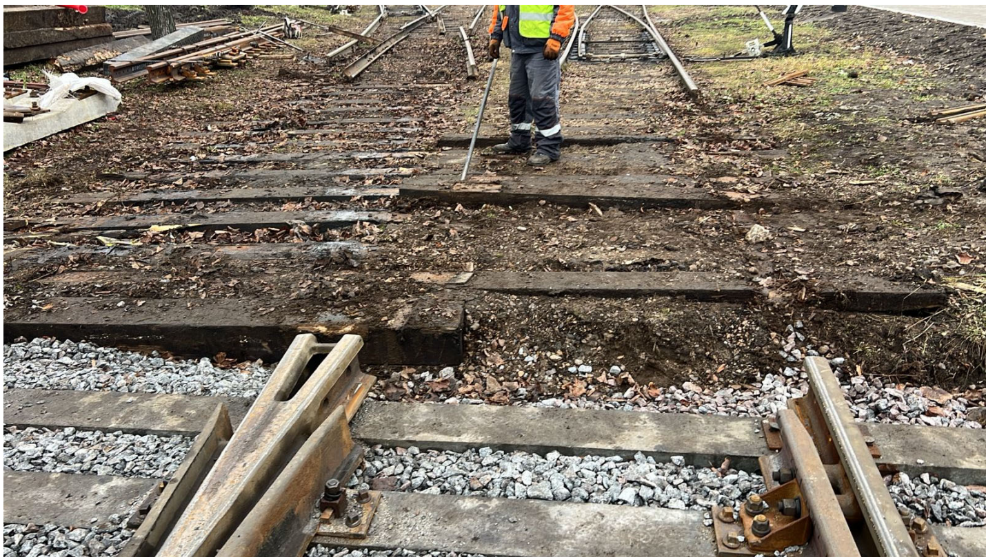
Демонтаж стрелочного перевода №9 после
