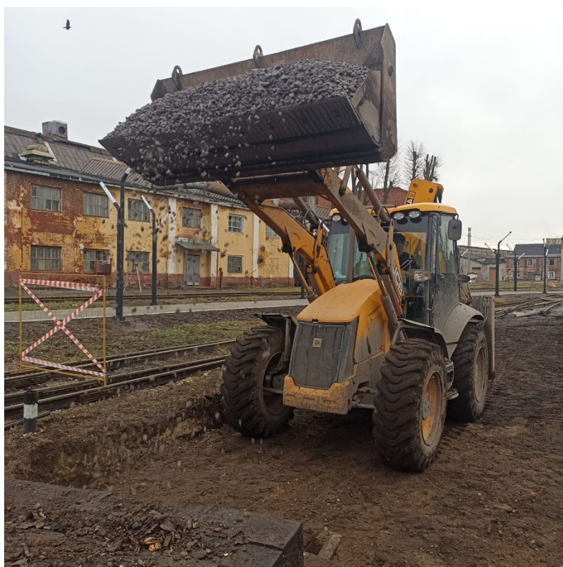
Устройство щебеночного балласта под стрелочный перевод №9 до
