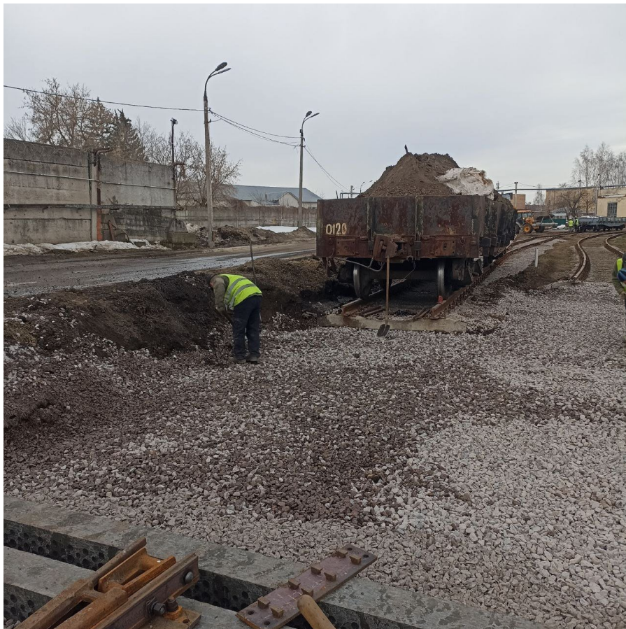
Устройство щебеночного балласта под стрелочный перевод №13 после
