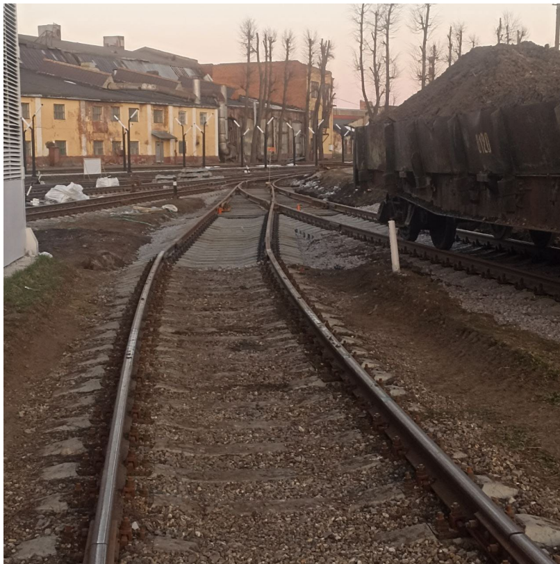
Балластировка, выправка и рихтовка стрелочного перевода №13 после
