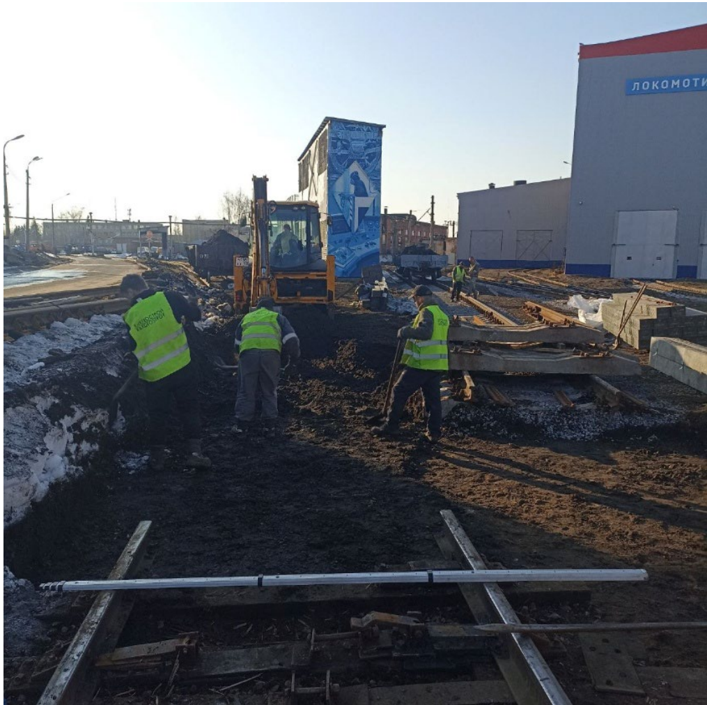
Устройство щебеночного балласта под стрелочный перевод №13 до
