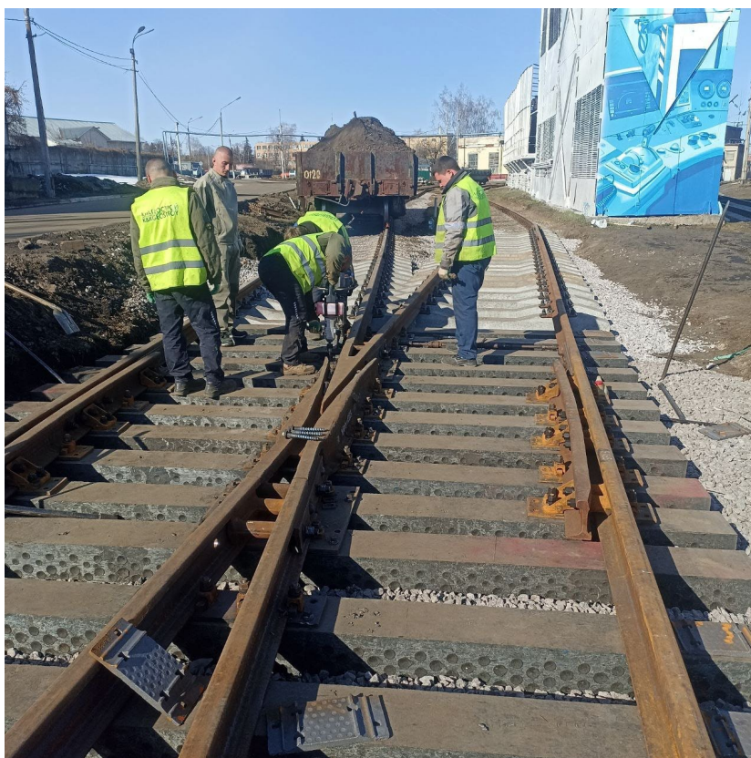
Укладка стрелочного перевода №13 после
