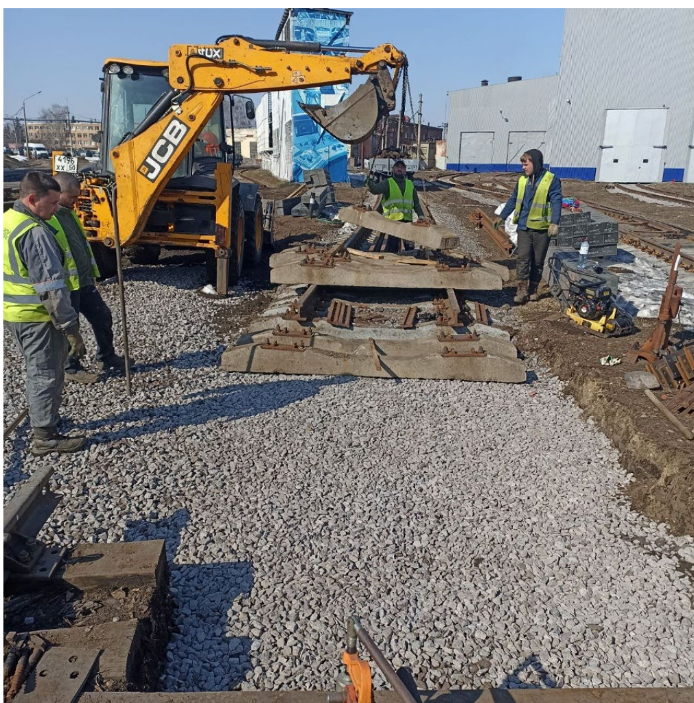
Укладка стрелочного перевода №13 до
