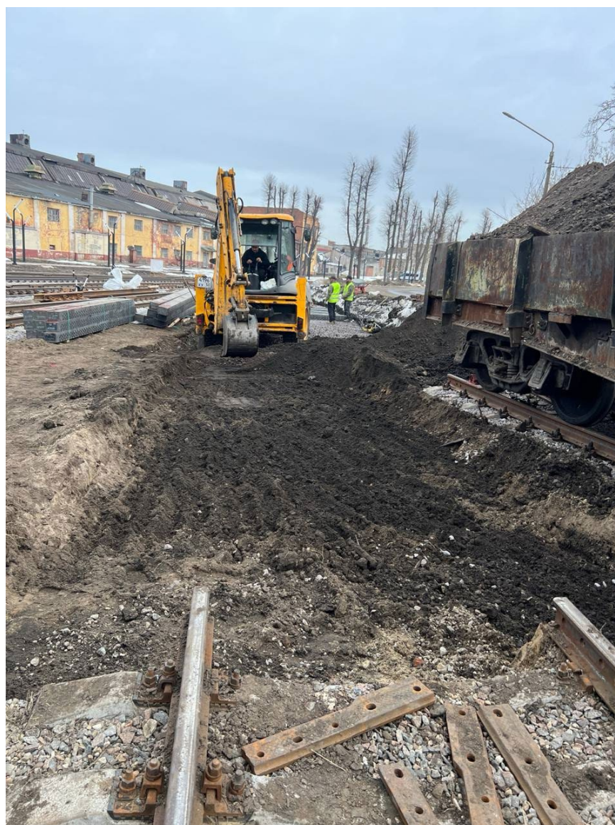
Демонтаж стрелочного перевода №13 после
