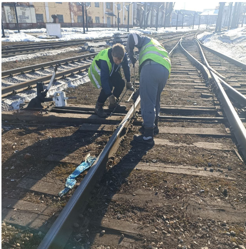
Демонтаж стрелочного перевода №13 до
