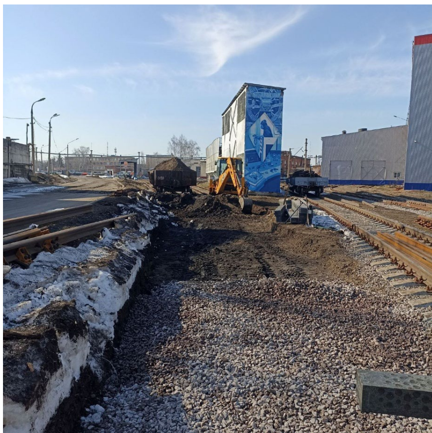
Устройство щебеночного балласта под стрелочный перевод №13 до
