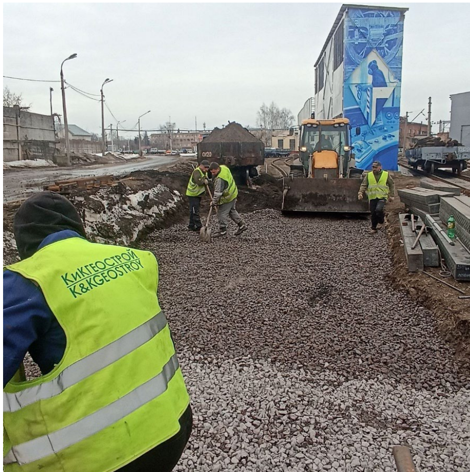
Укладка стрелочного перевода №13 до
