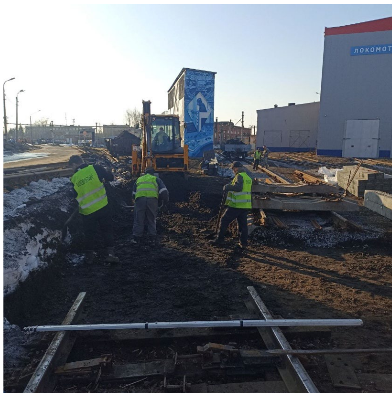
Выемка загрязненного балласта под стрелочный перевод №13 после
