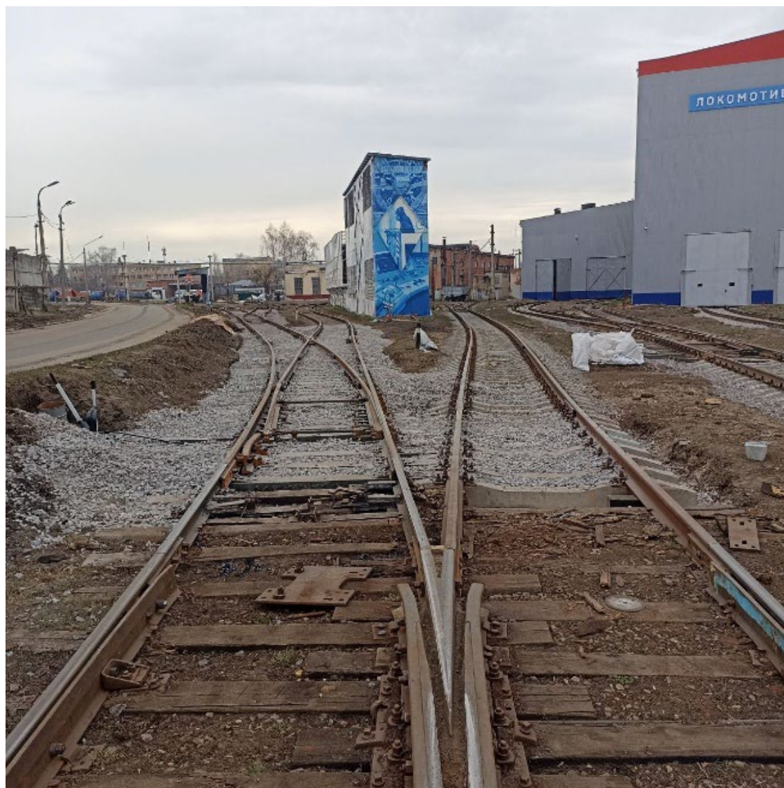
Балластировка, выправка и рихтовка стрелочного перевода №13 после
