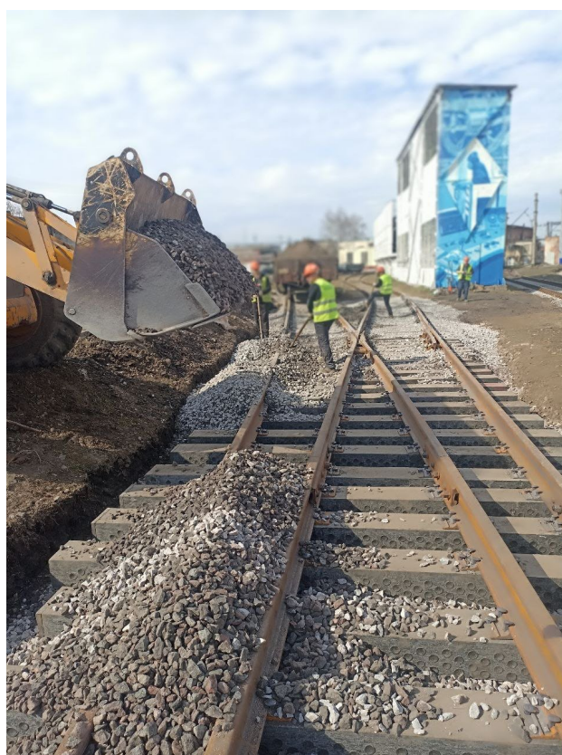
Балластировка, выправка и рихтовка стрелочного перевода №13 до
