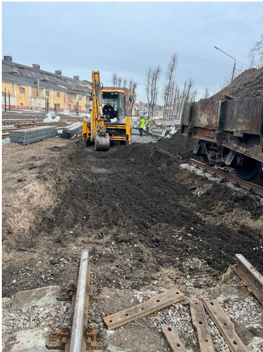
Выемка загрязненного балласта под стрелочный перевод №13 до
