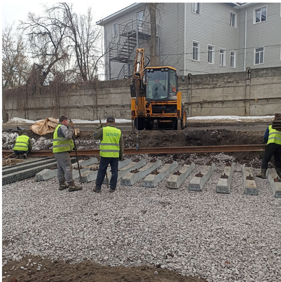
Устройство щебеночного балласта под стрелочный перевод №13 после
