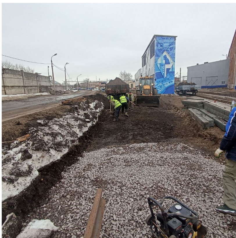
Выемка загрязненного балласта под стрелочный перевод №13 до
