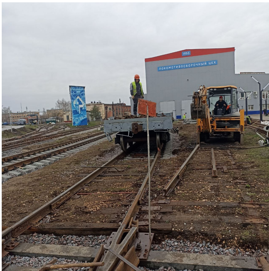
Демонтаж стрелочного перевода №8 до
