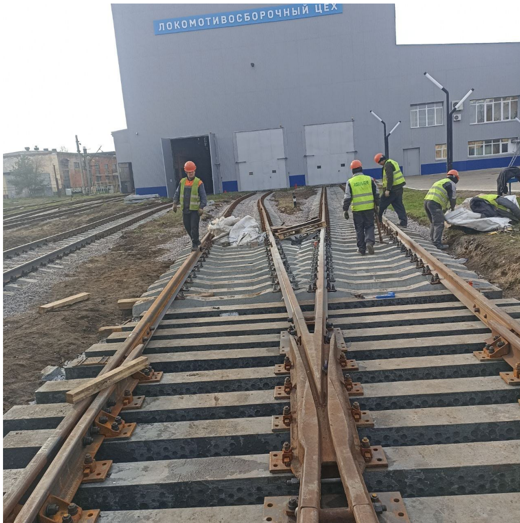
Балластировка, выправка и рихтовка стрелочного перевода №8 до
