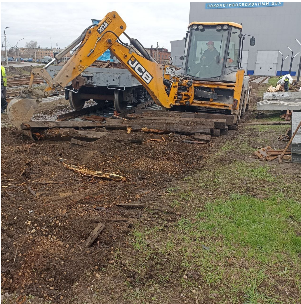
Демонтаж стрелочного перевода №8 после
