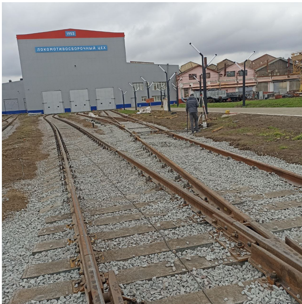
Балластировка, выправка и рихтовка стрелочного перевода №8 после
