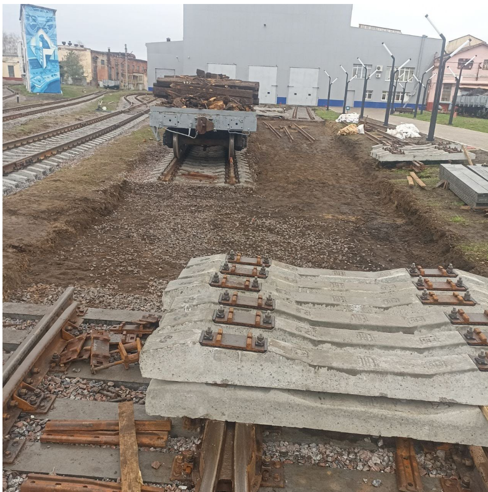
Устройство щебеночного балласта под стрелочный перевод №8 до
