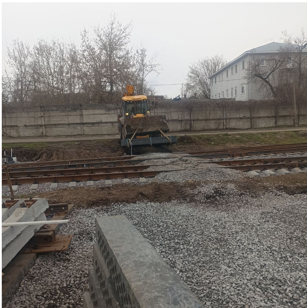
Устройство щебеночного балласта под стрелочный перевод №8 после
