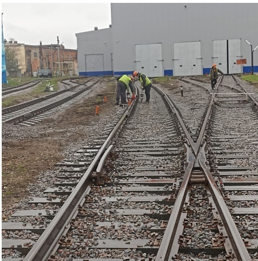
Балластировка, выправка и рихтовка стрелочного перевода №8 после
