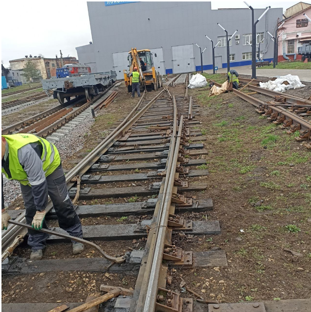
Демонтаж стрелочного перевода №8 до
