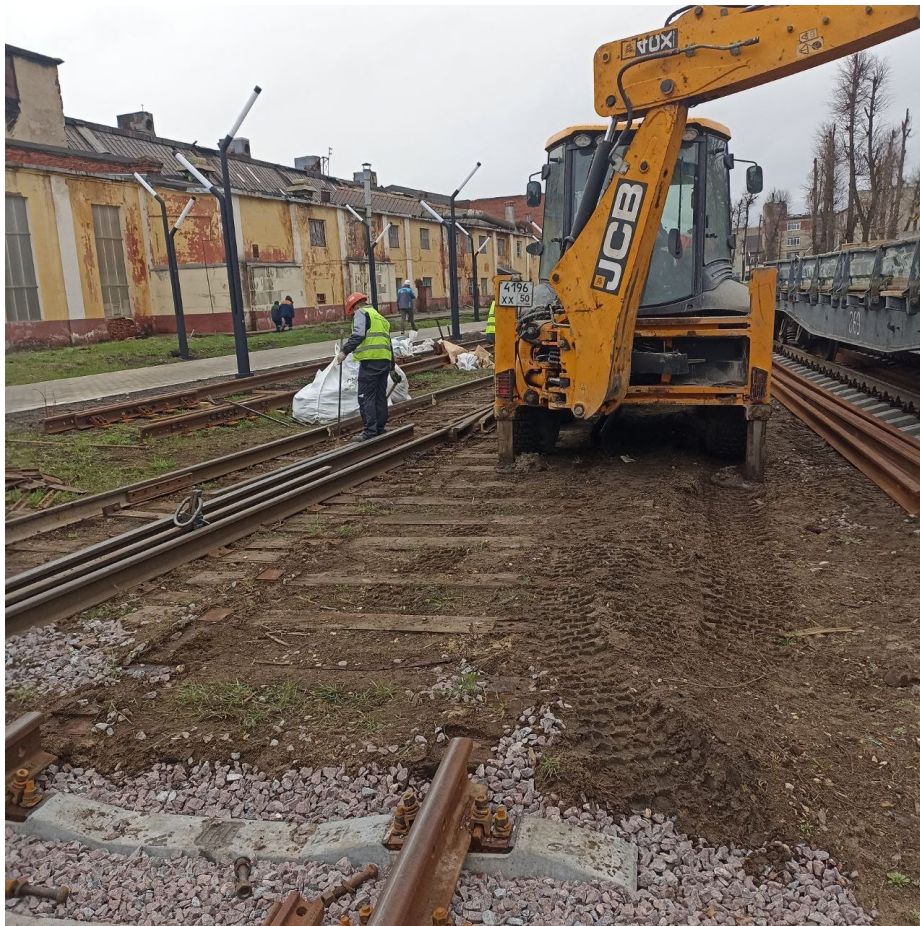
Выемка загрязненного балласта под стрелочный перевод №8 до
