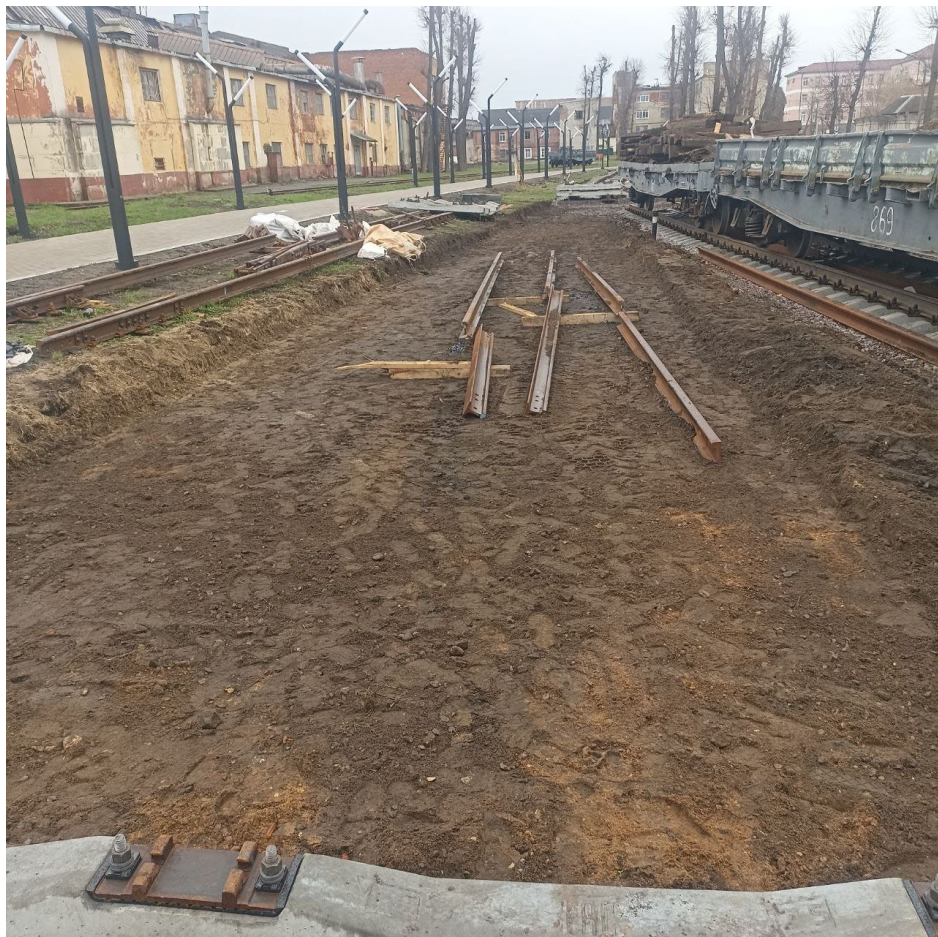
Выемка загрязненного балласта под стрелочный перевод №8 после
