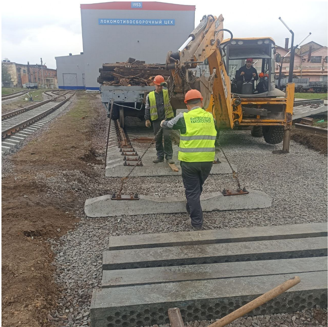
Укладка стрелочного перевода №8 до
