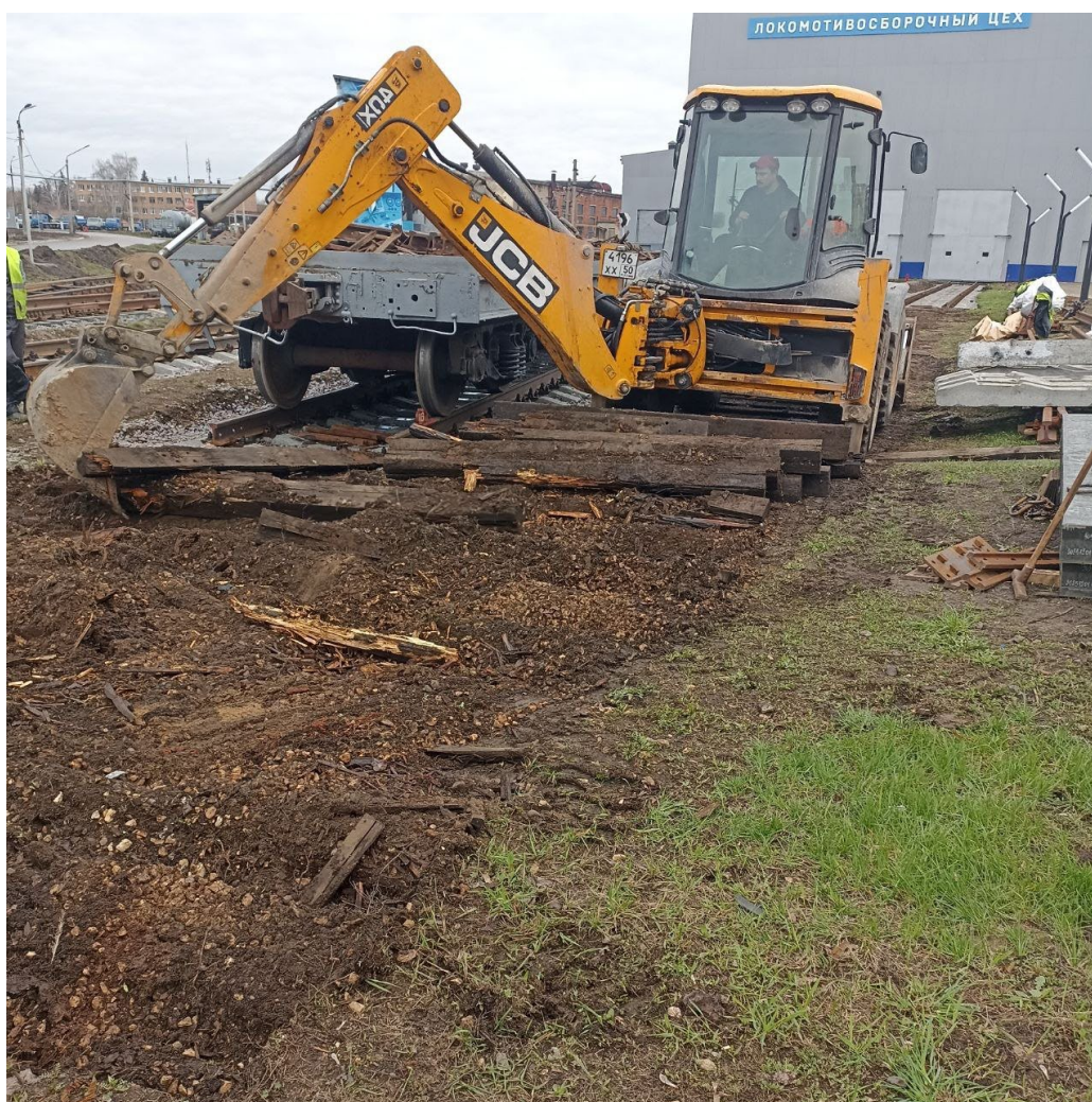
Выемка загрязненного балласта под стрелочный перевод №8 до
