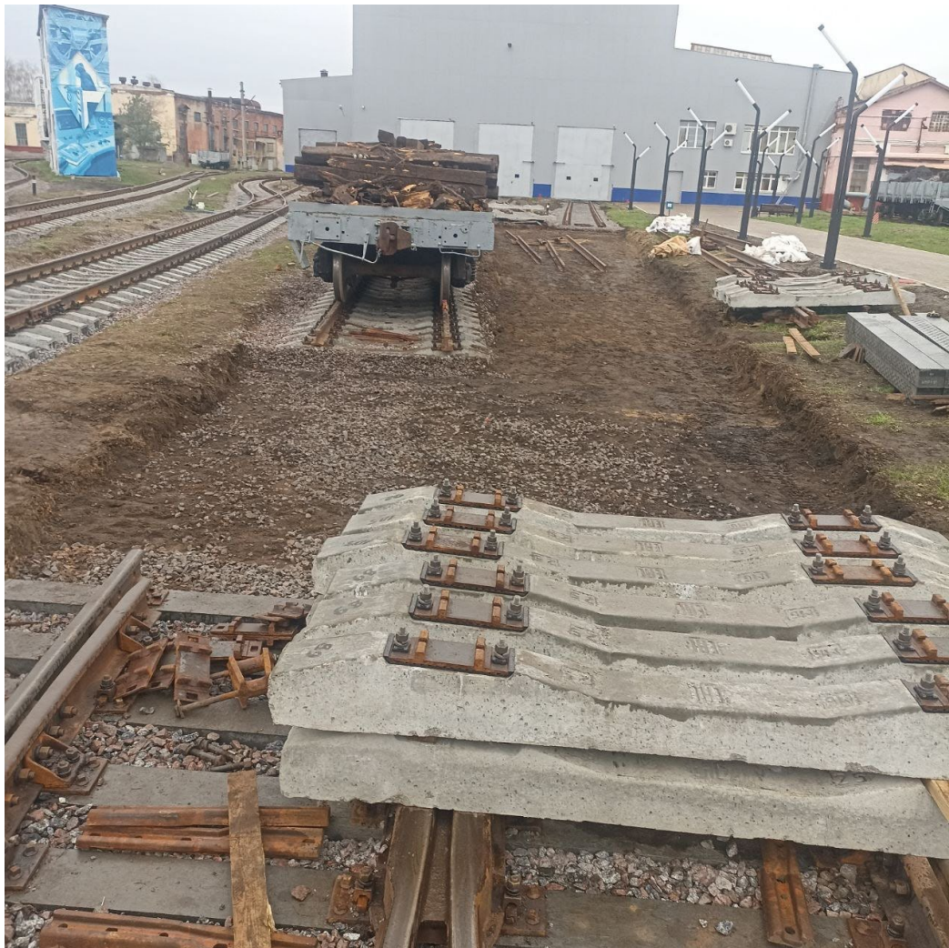
Выемка загрязненного балласта под стрелочный перевод №8 после
