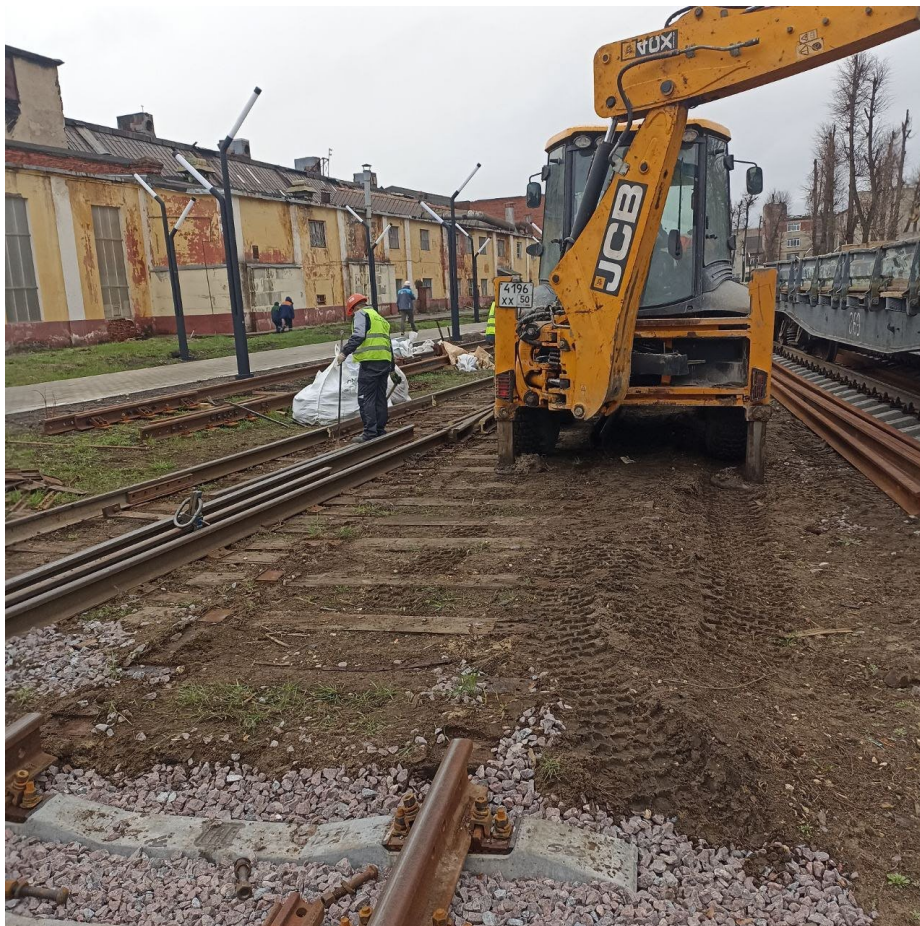
Демонтаж стрелочного перевода №8 после
