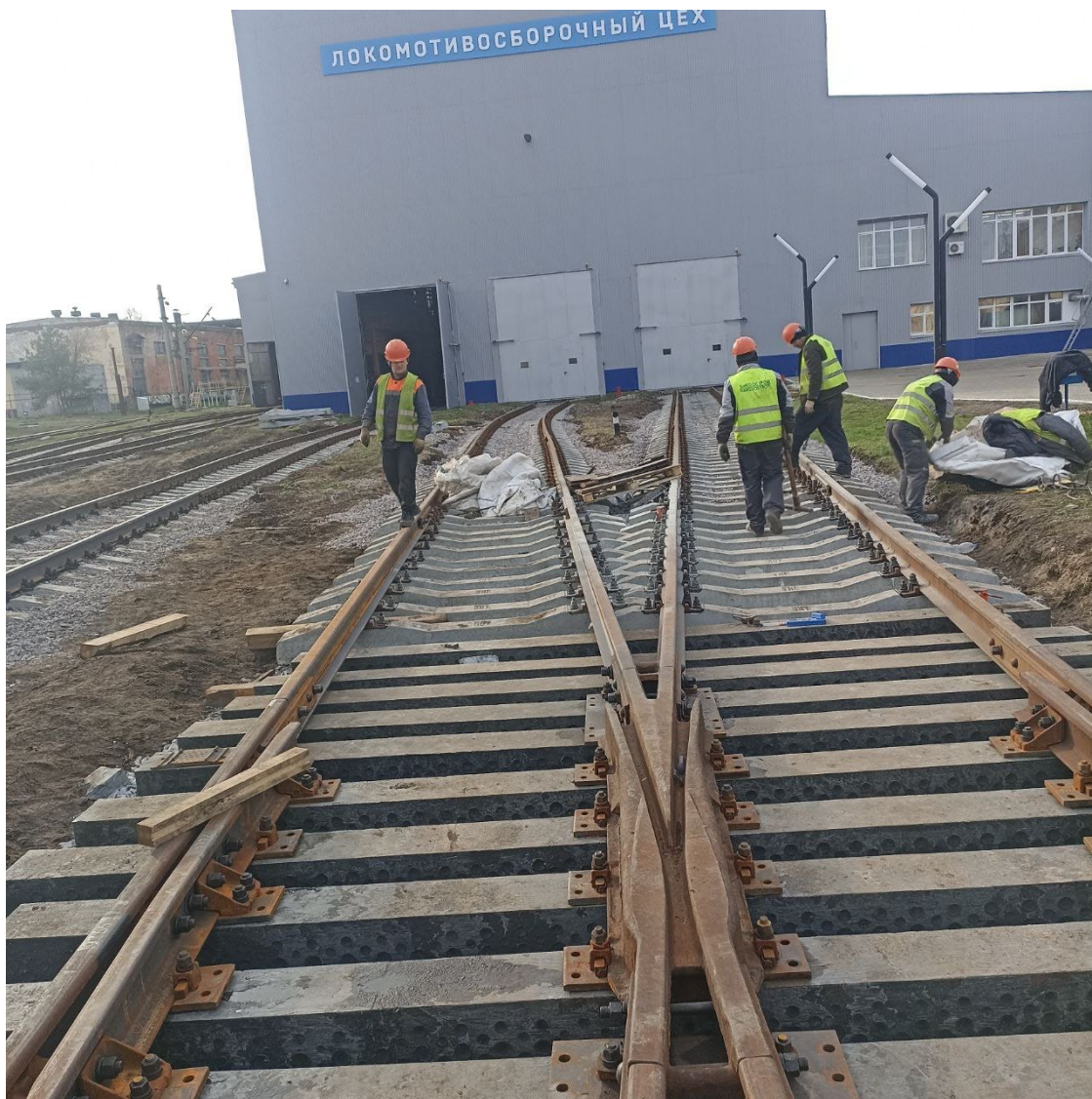
Укладка стрелочного перевода №8 после
