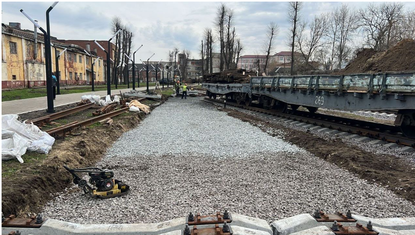
Устройство щебеночного балласта под стрелочный перевод №8 после
