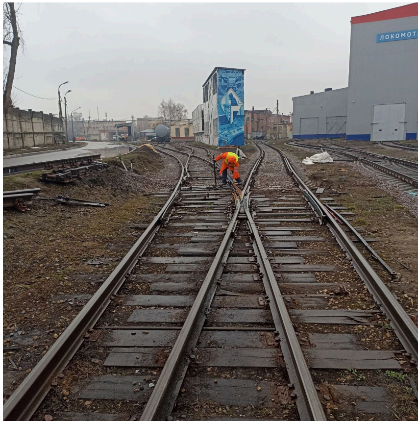
Демонтаж стрелочного перевода №11 до
