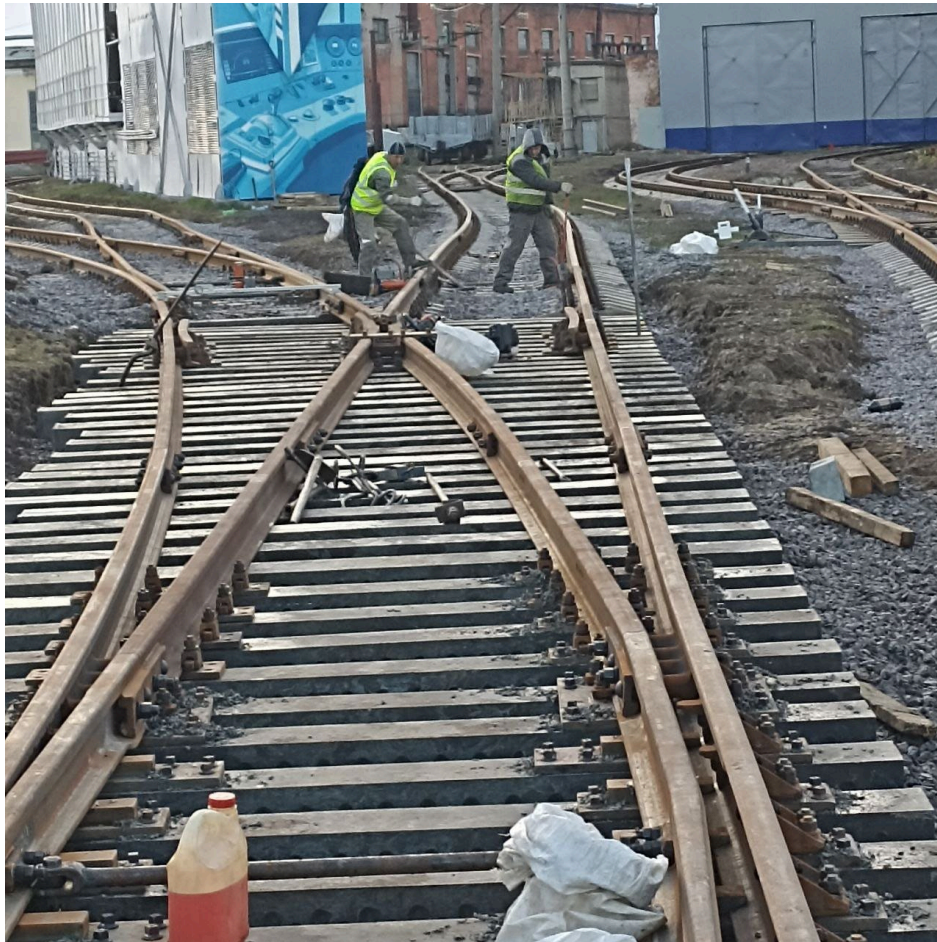
Балластировка, выправка и рихтовка стрелочного перевода №11 до
