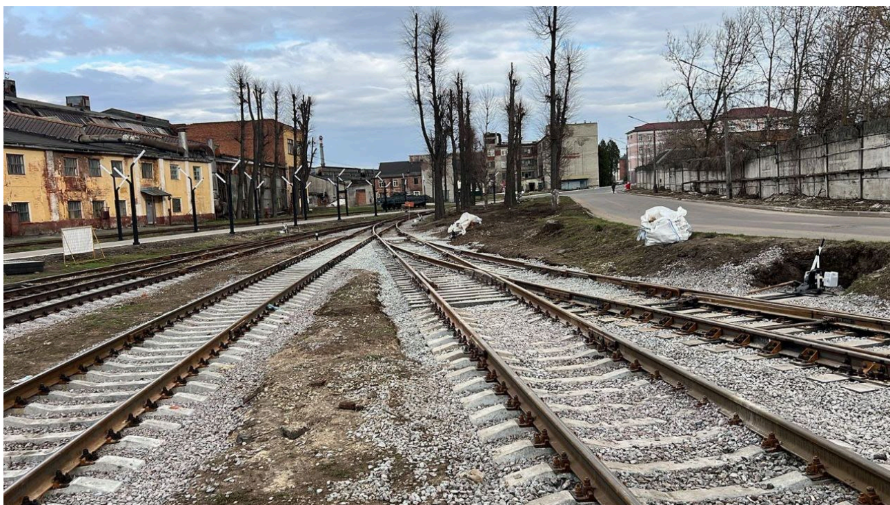
Балластировка, выправка и рихтовка стрелочного перевода №11 после
