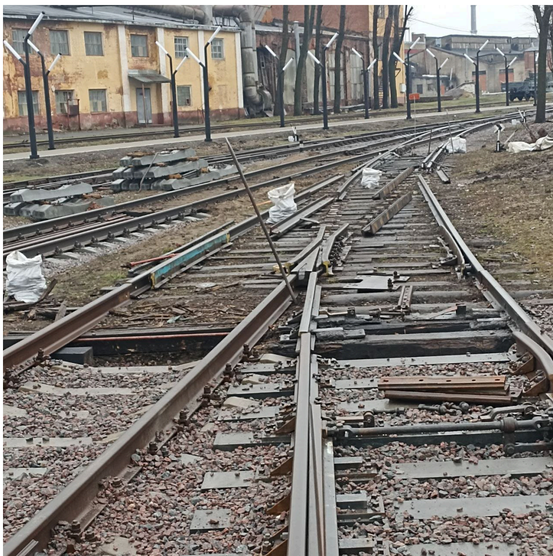
Демонтаж стрелочного перевода №11 до
