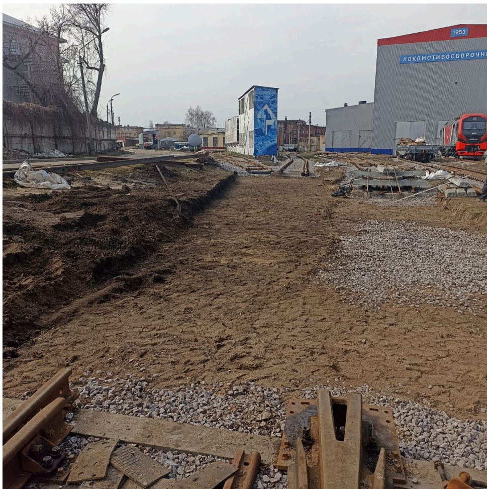
Устройство щебеночного балласта под стрелочный перевод №11 до
