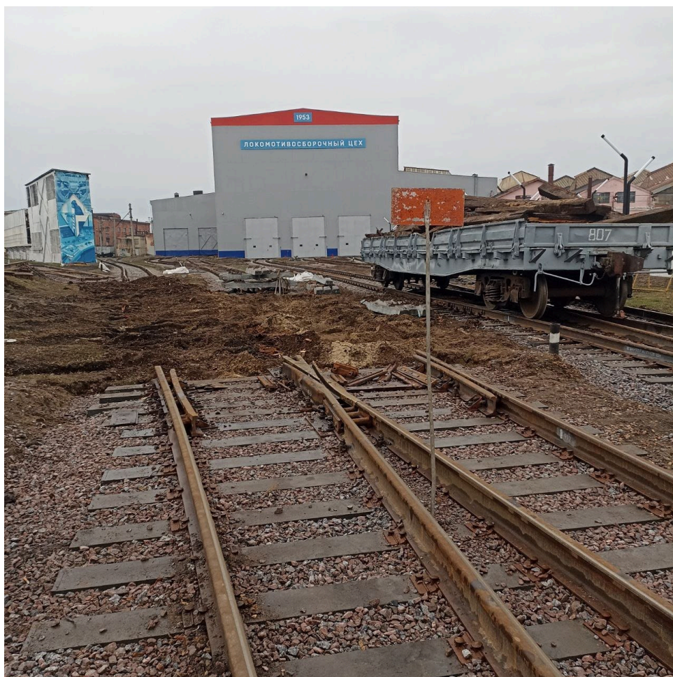
Выемка загрязненного балласта под стрелочный перевод №11 до
