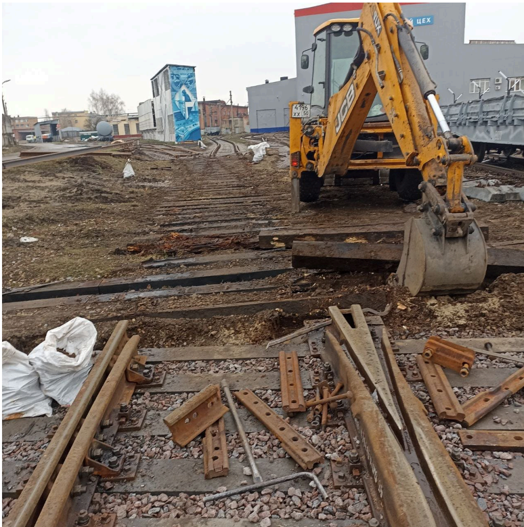
Демонтаж стрелочного перевода №11 после
