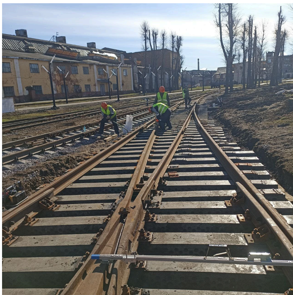
Укладка стрелочного перевода №11 после
