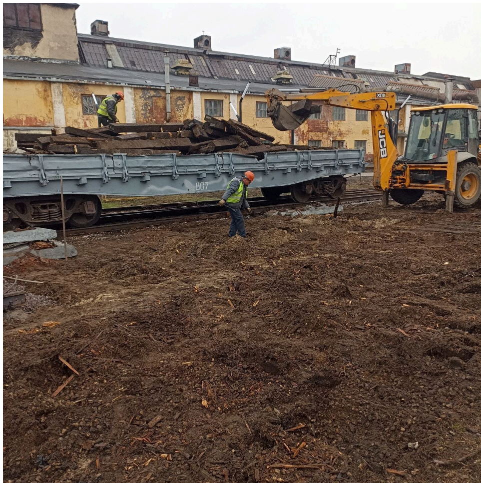
Выемка загрязненного балласта под стрелочный перевод №11 до
