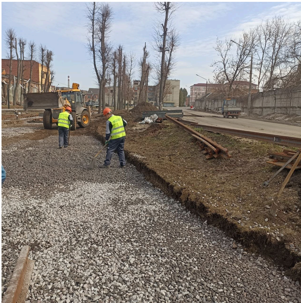
Выемка загрязненного балласта под стрелочный перевод №11 после
