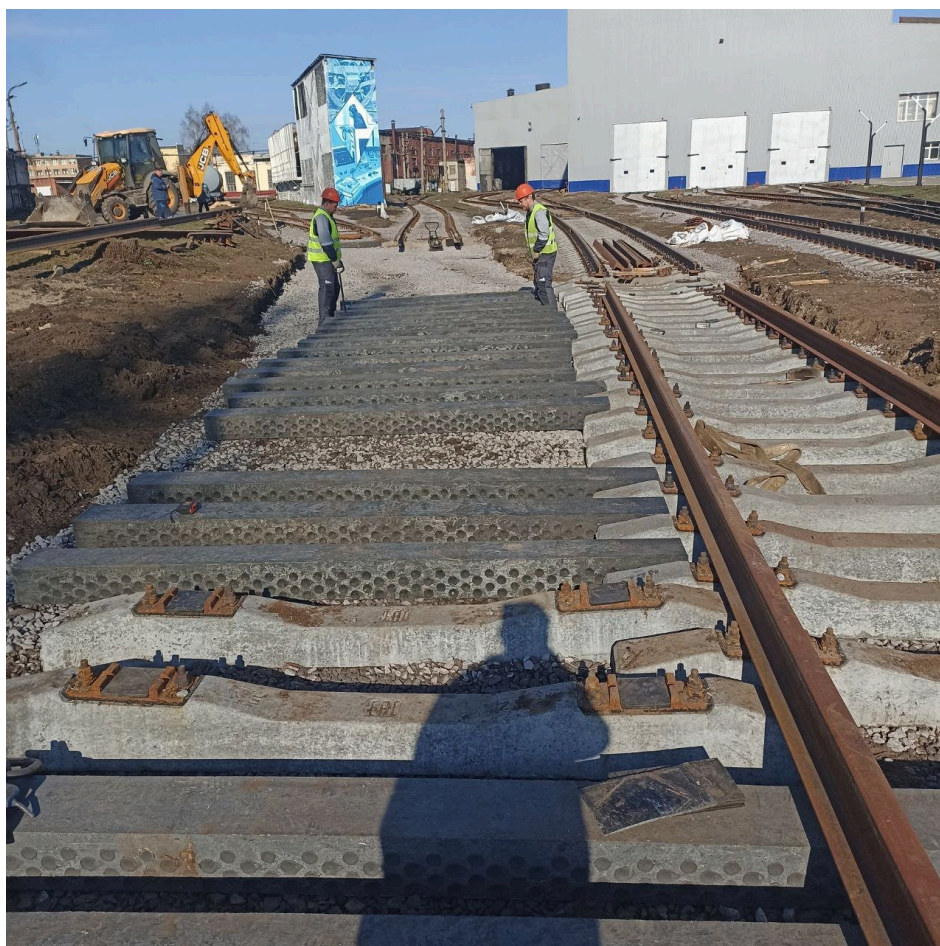
Укладка стрелочного перевода №11 до
