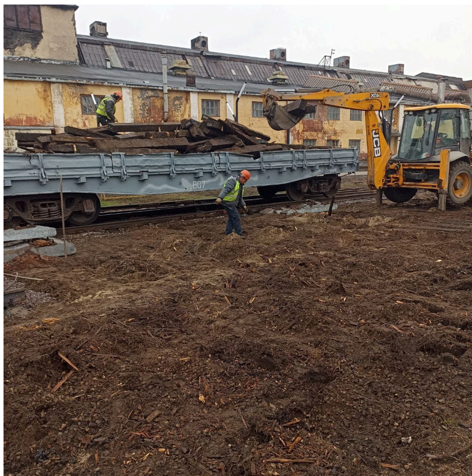
Демонтаж стрелочного перевода №11 после
