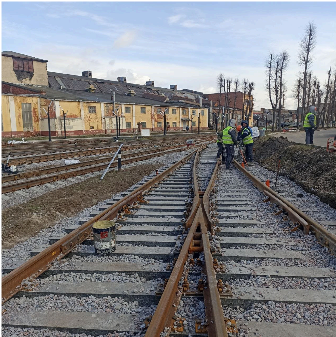
Балластировка, выправка и рихтовка стрелочного перевода №11 после
