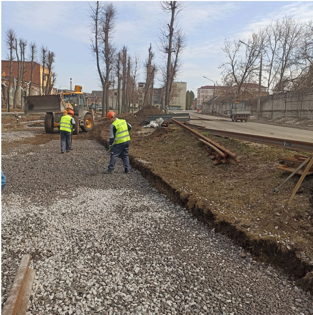
Устройство щебеночного балласта под стрелочный перевод №11 до
