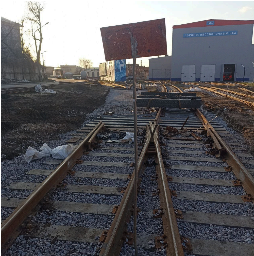
Укладка стрелочного перевода №11 до
