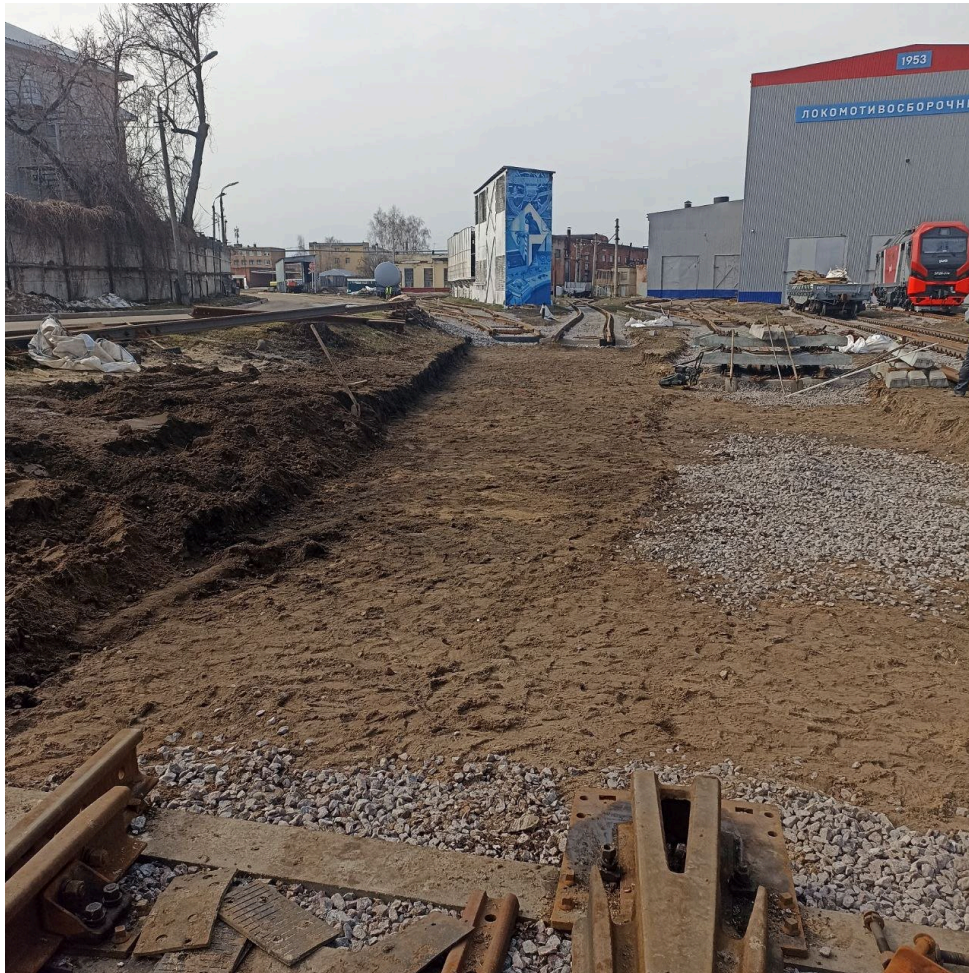
Выемка загрязненного балласта под стрелочный перевод №11 после
