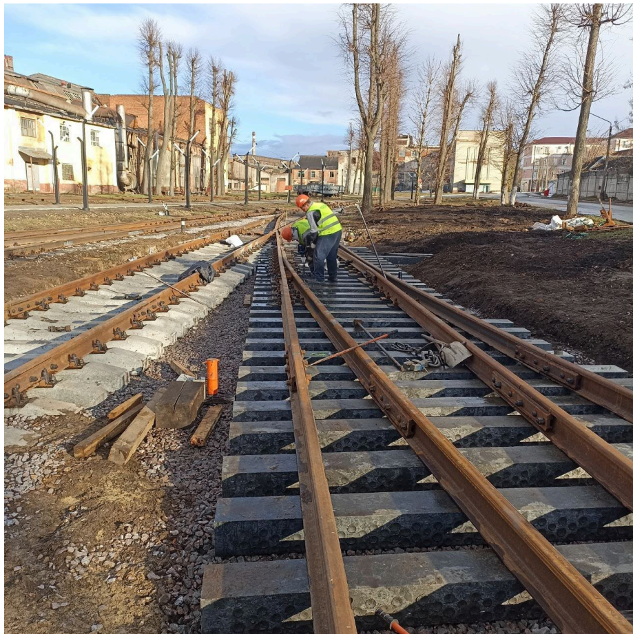
Укладка стрелочного перевода №11 после
