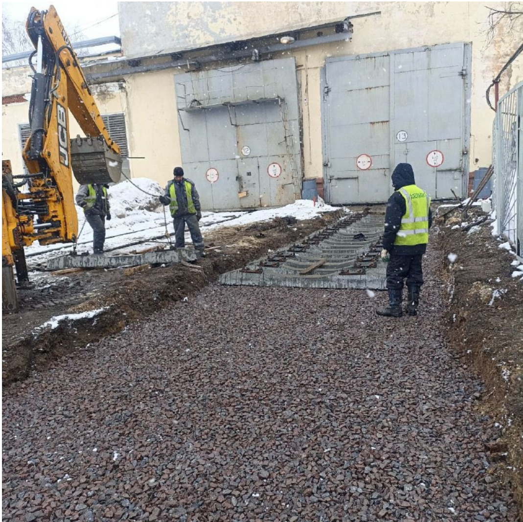
Устройство щебеночного балласта пути №7 после
