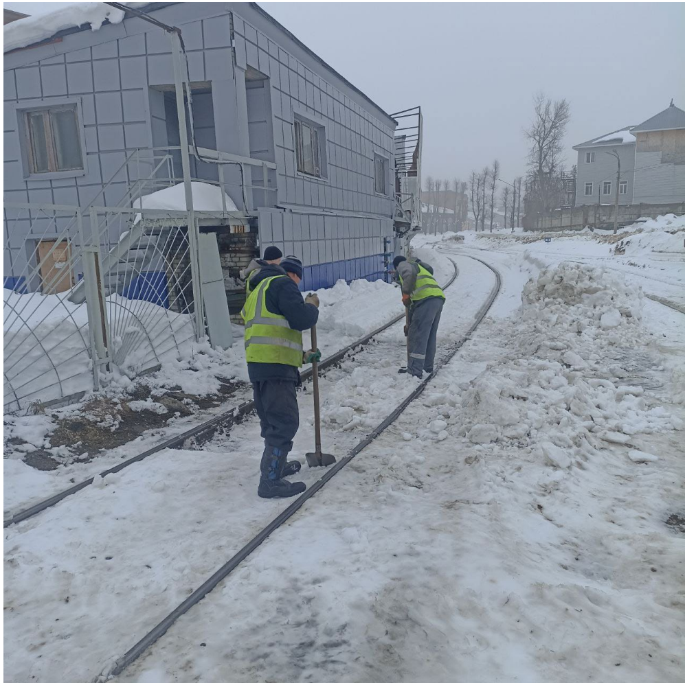
Демонтаж рельсошпальной решетки пути №7 до
