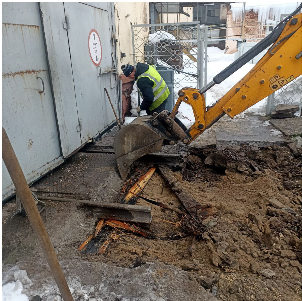
Демонтаж рельсошпальной решетки пути №7 после
