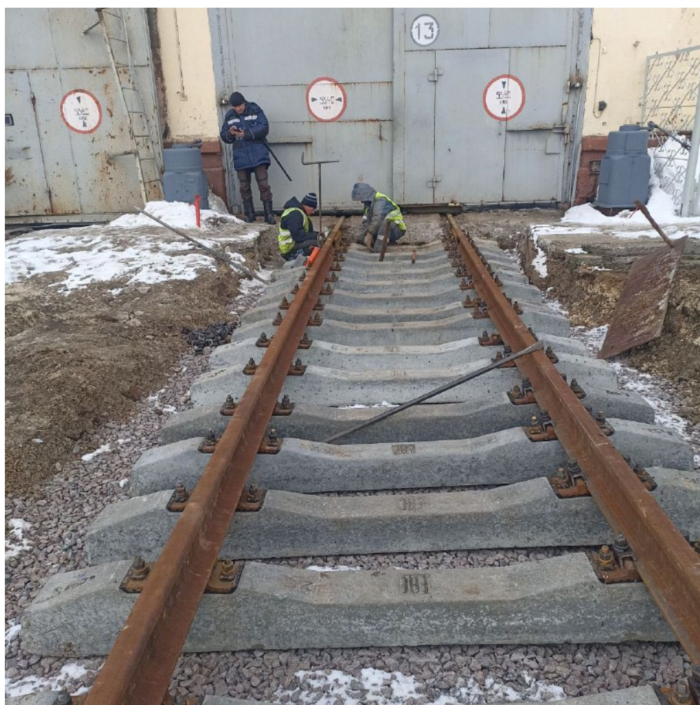
Укладка рельсошпальной решетки пути №7 после
