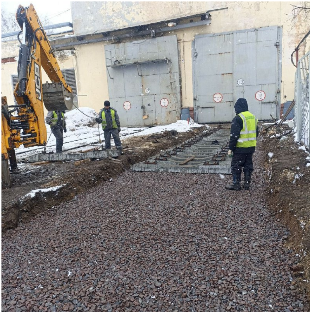
Укладка рельсошпальной решетки пути №7 до
