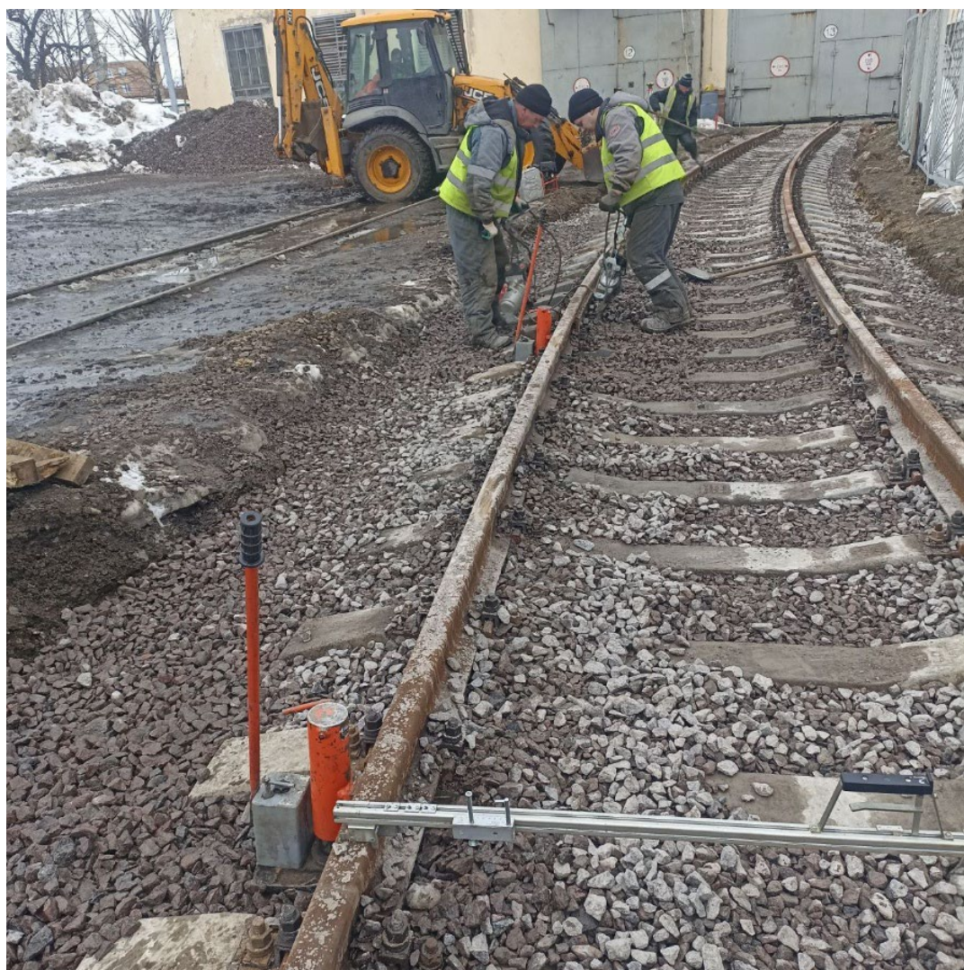
Балластировка, выправка и рихтовка пути №7 после
