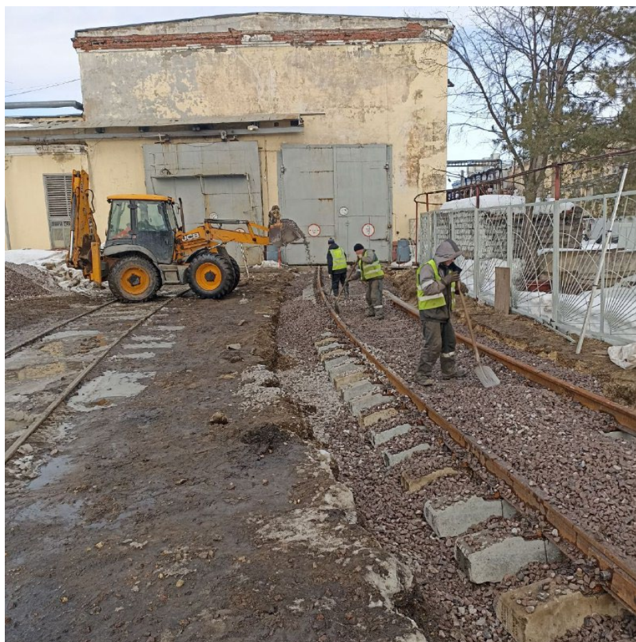
Балластировка, выправка и рихтовка пути №7 до
