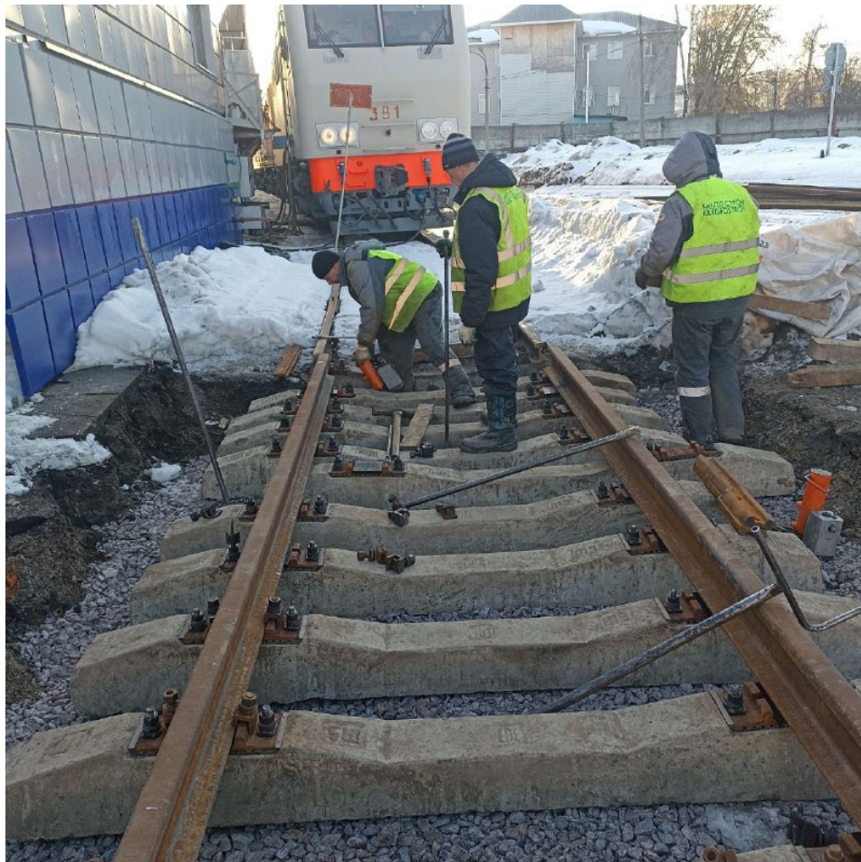
Укладка рельсошпальной решетки пути №7 после
