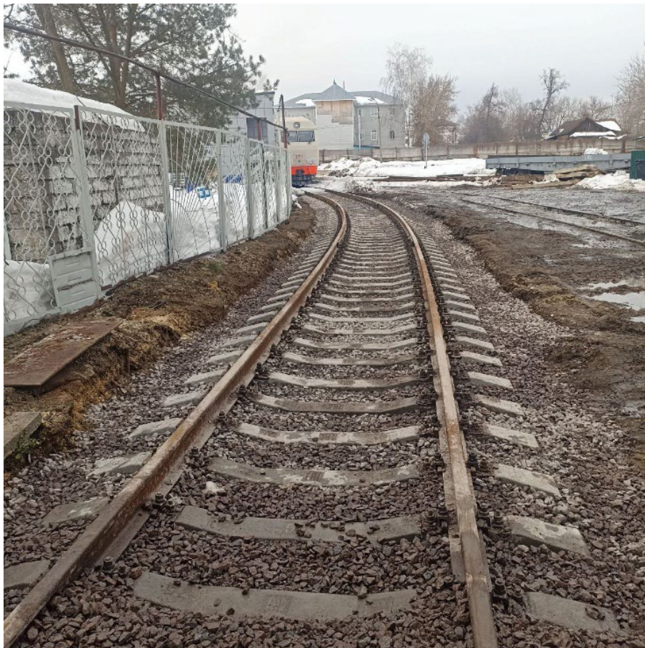
Балластировка, выправка и рихтовка пути №7 после
