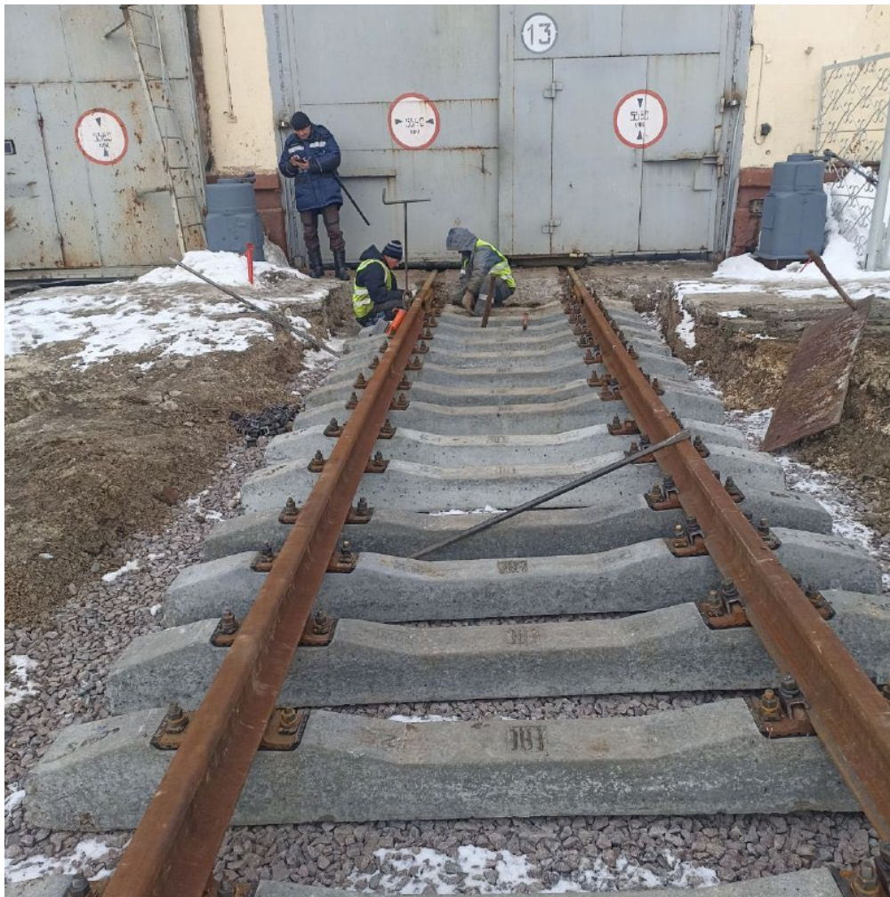
Балластировка, выправка и рихтовка пути №7 до
