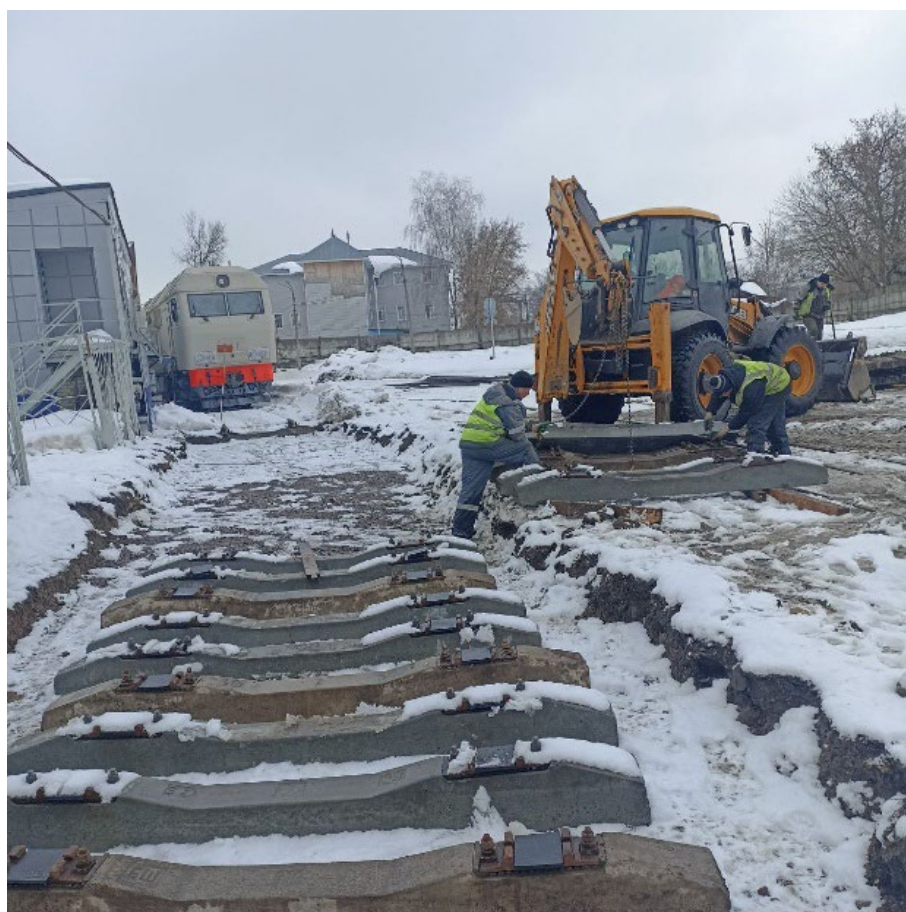
Укладка рельсошпальной решетки пути №7 до
