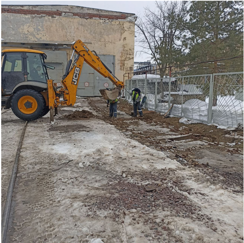
Демонтаж рельсошпальной решетки пути №7 после
