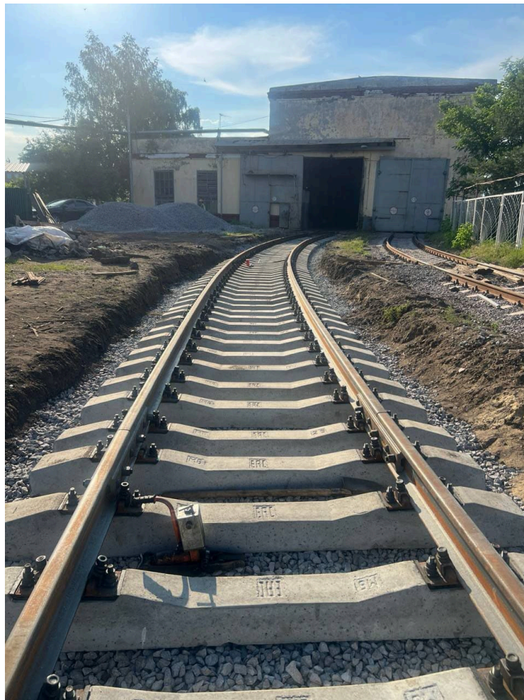
Укладка рельсошпальной решетки пути №14 после
