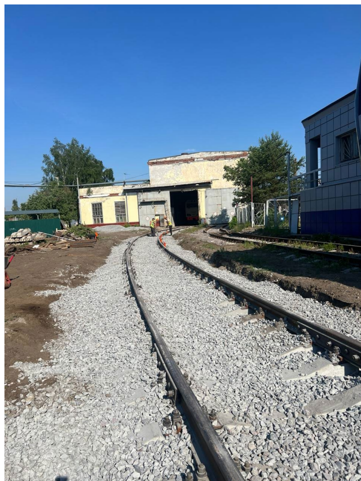
Балластировка, выправка и рихтовка пути №14 после
