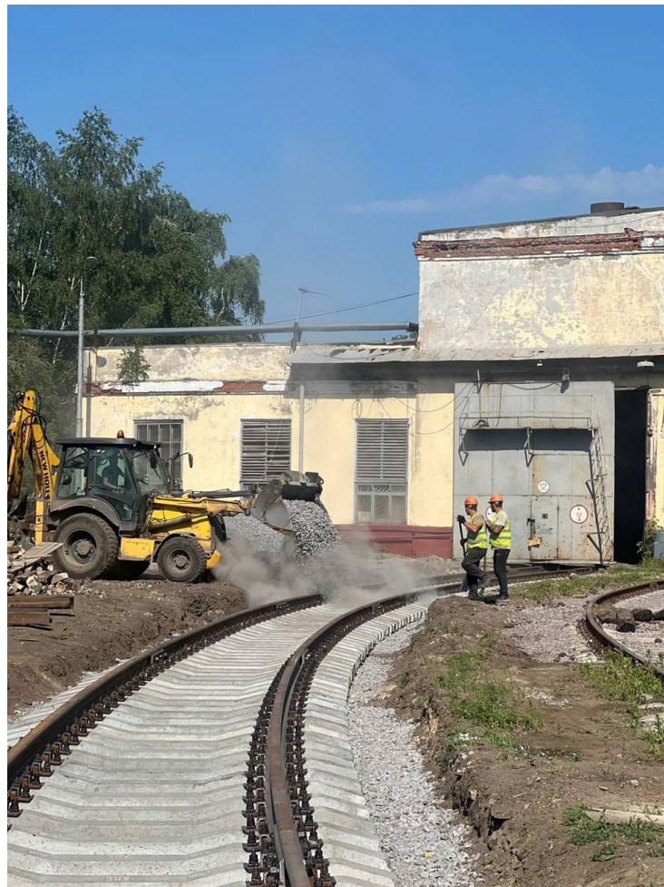
Балластировка, выправка и рихтовка пути №14 до
