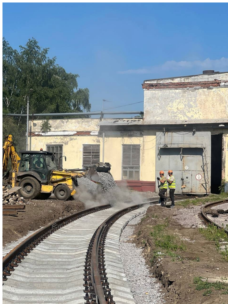
Укладка рельсошпальной решетки пути №14 после
