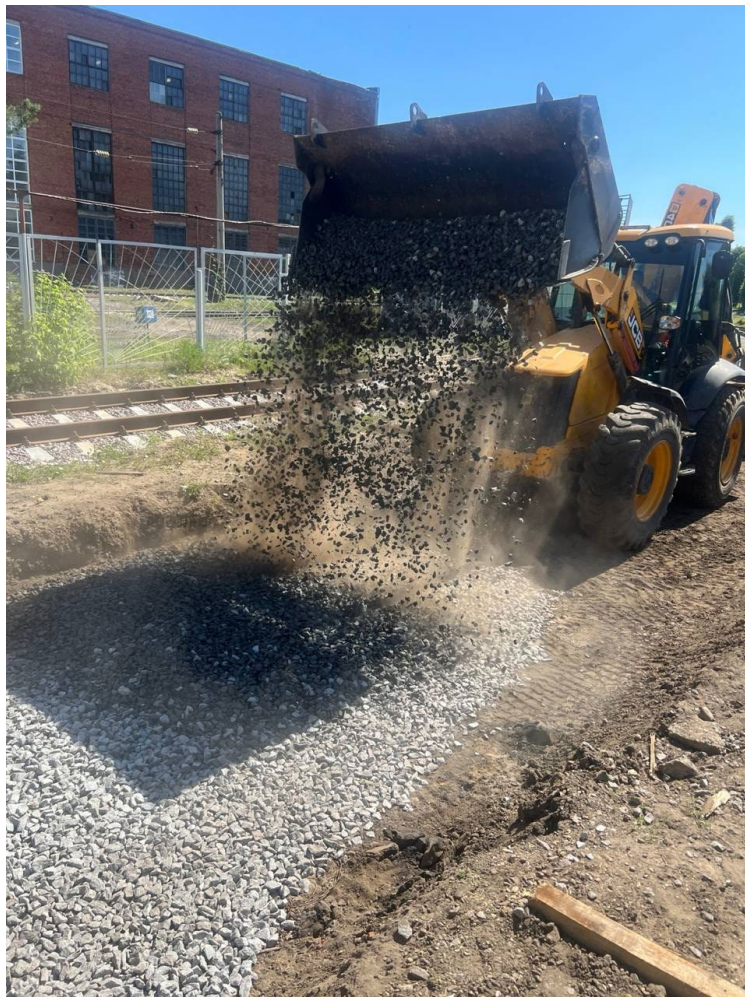
Устройство щебеночного балласта пути №14 после
