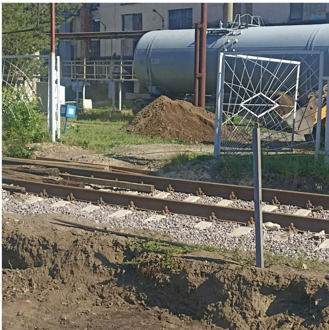
Устройство щебеночного балласта пути №14 до
