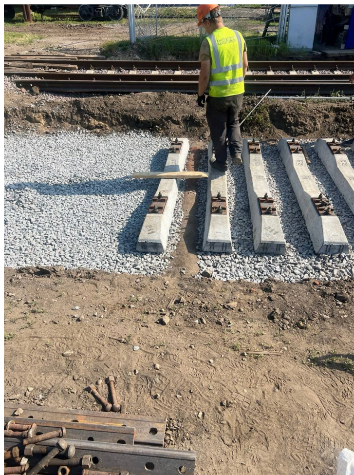
Устройство щебеночного балласта пути №14 после
