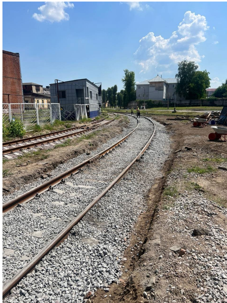
Балластировка, выправка и рихтовка пути №14 после
