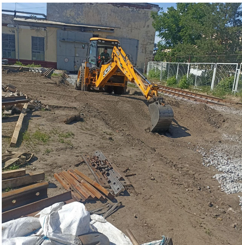
Демонтаж рельсошпальной решетки пути №14 после
