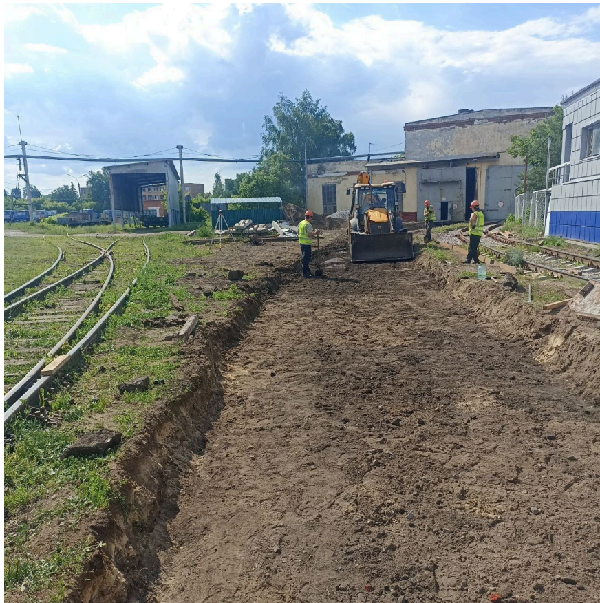
Устройство щебеночного балласта пути №14 до
