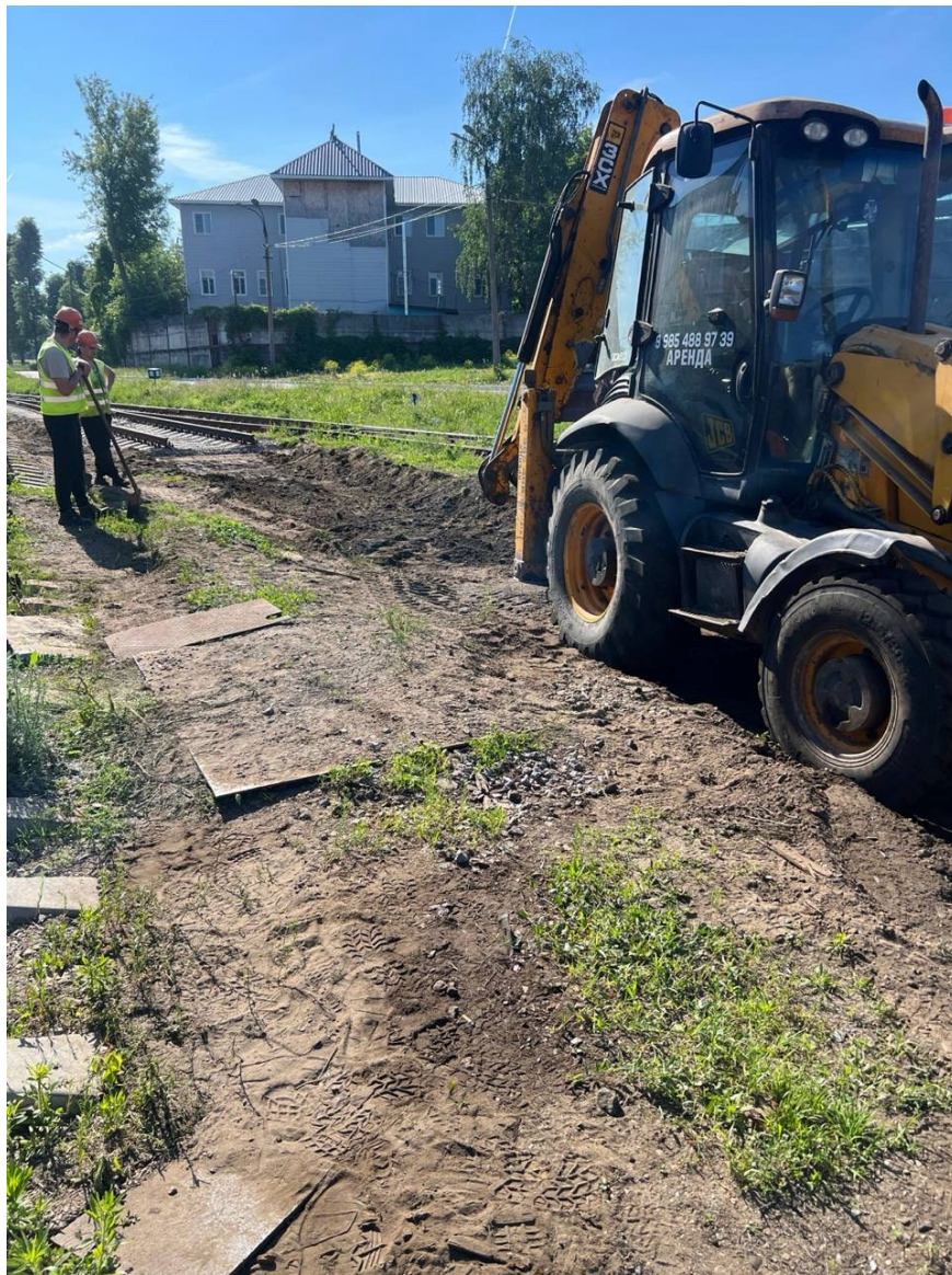
Демонтаж рельсошпальной решетки пути №14 после
