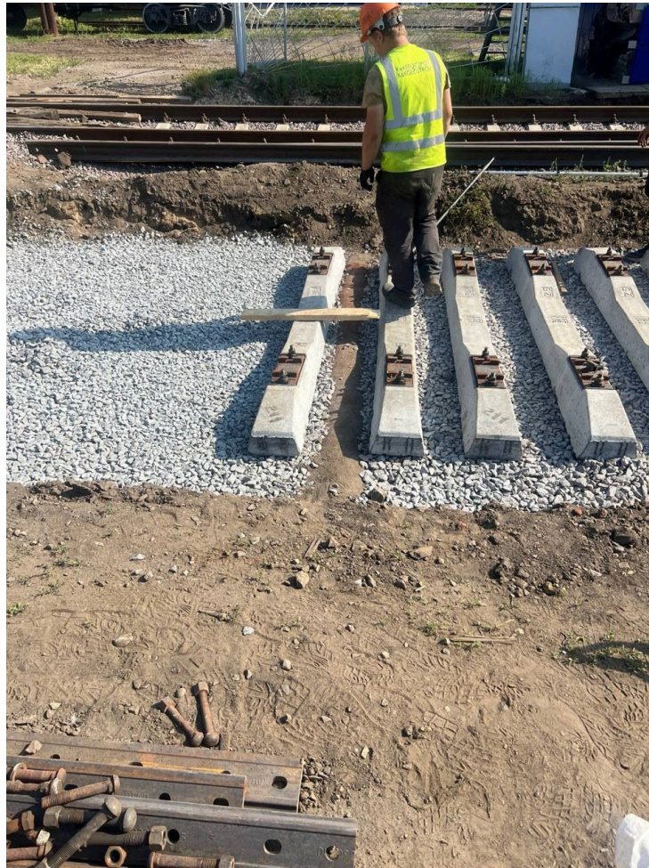
Укладка рельсошпальной решетки пути №14 до
