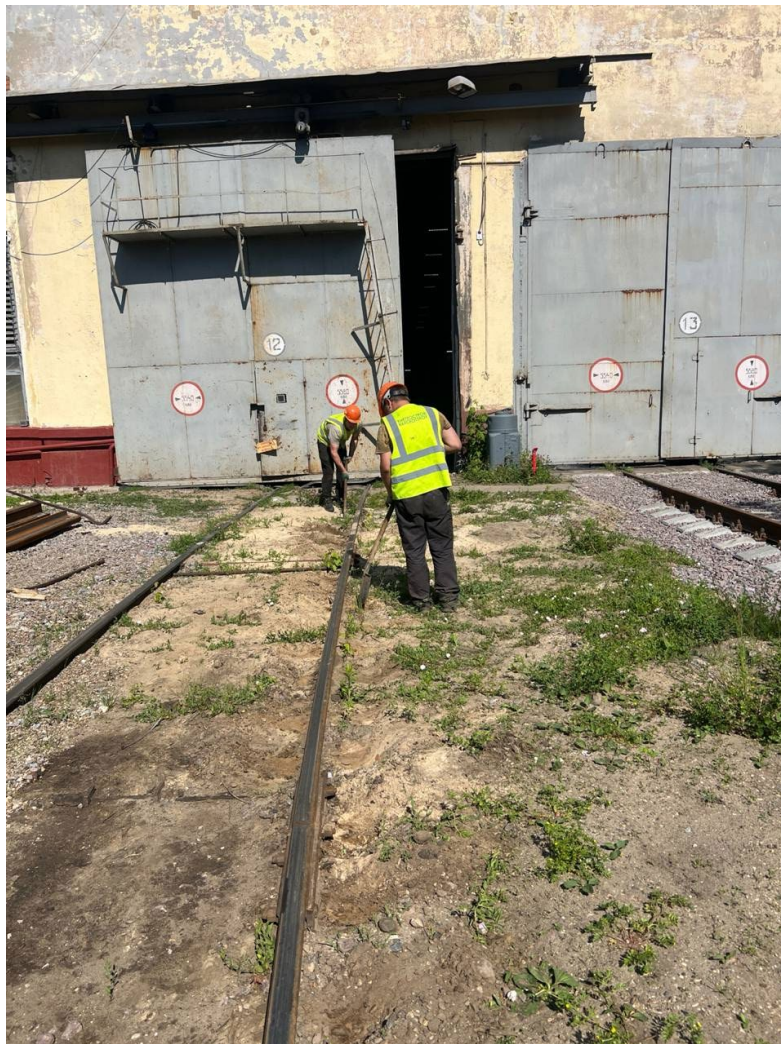
Демонтаж рельсошпальной решетки пути №14 до
