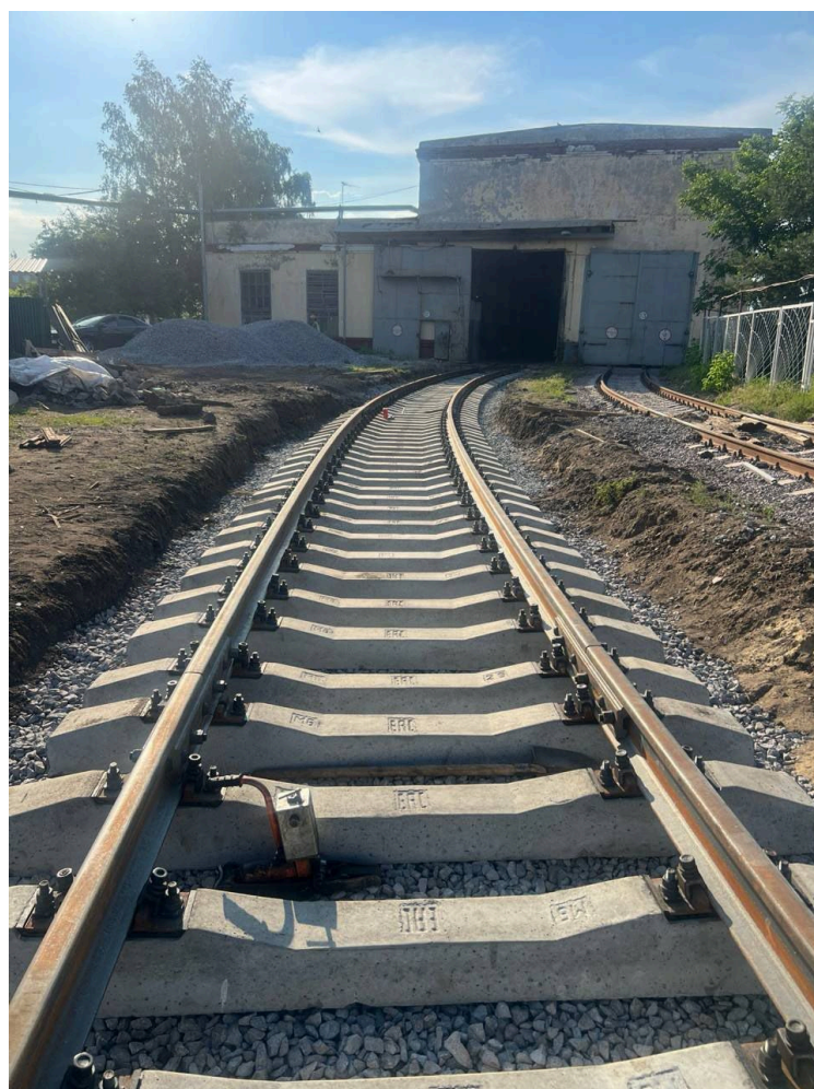
Балластировка, выправка и рихтовка пути №14 до
