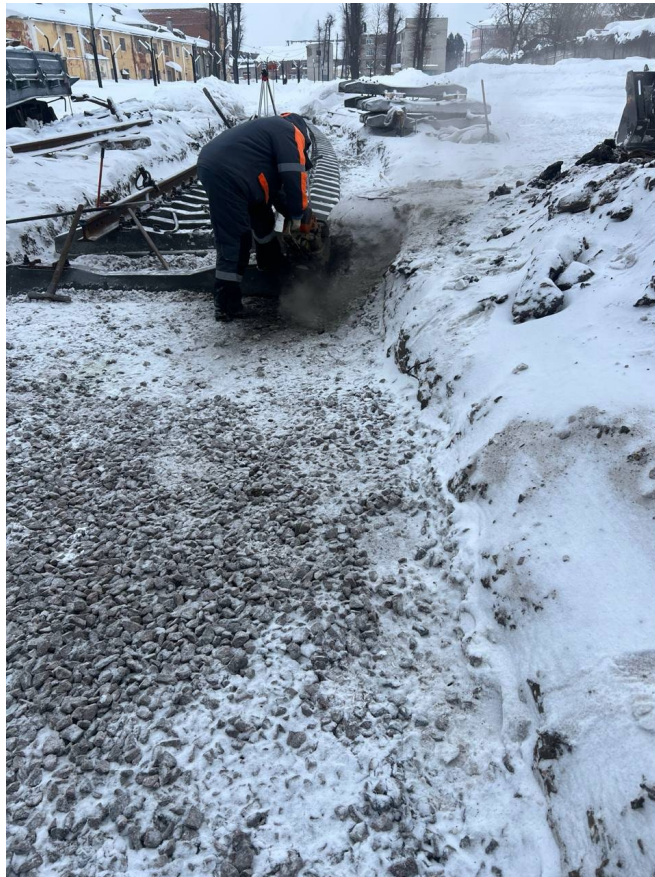
Укладка рельсошпальной решетки пути №7 до
