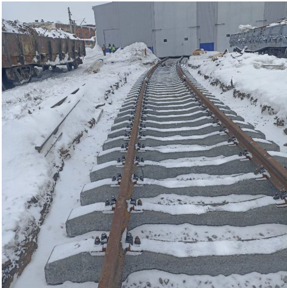
Укладка рельсошпальной решетки пути №7 после
