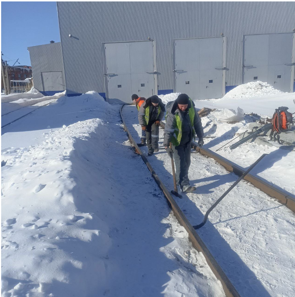
Демонтаж рельсошпальной решетки пути №7 до
