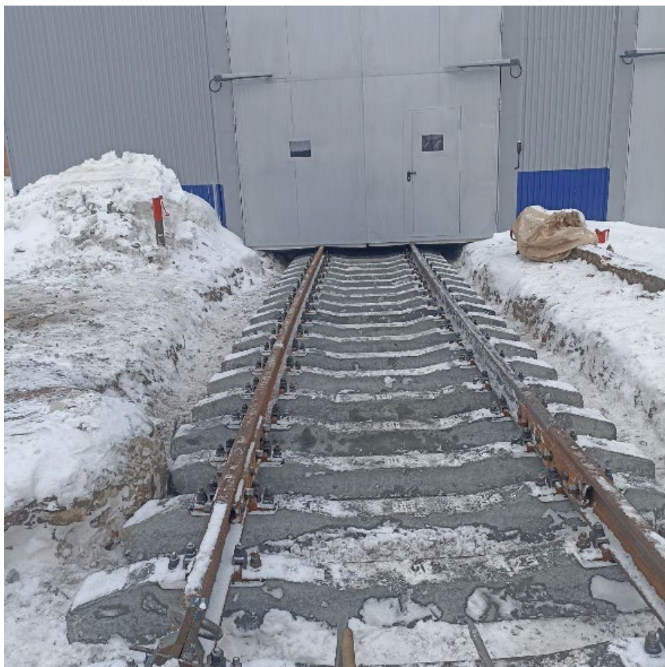
Укладка рельсошпальной решетки пути №7 после
