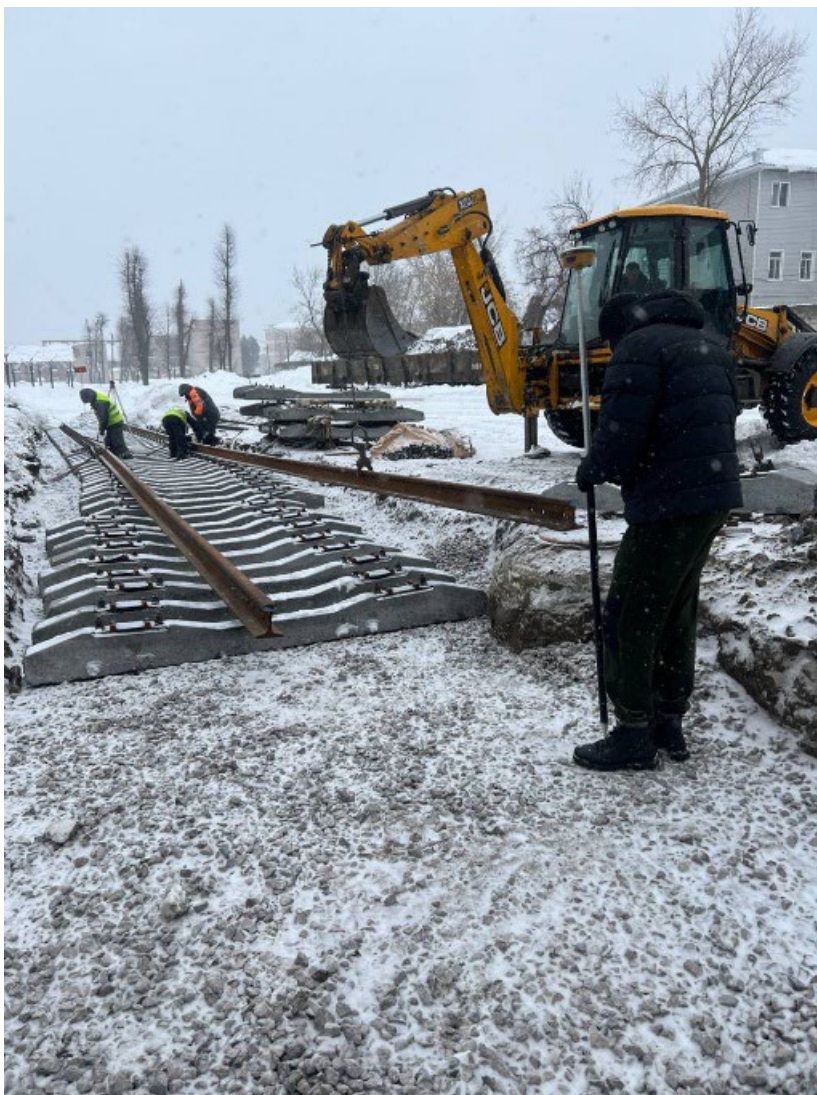
Укладка рельсошпальной решетки пути №7 до
