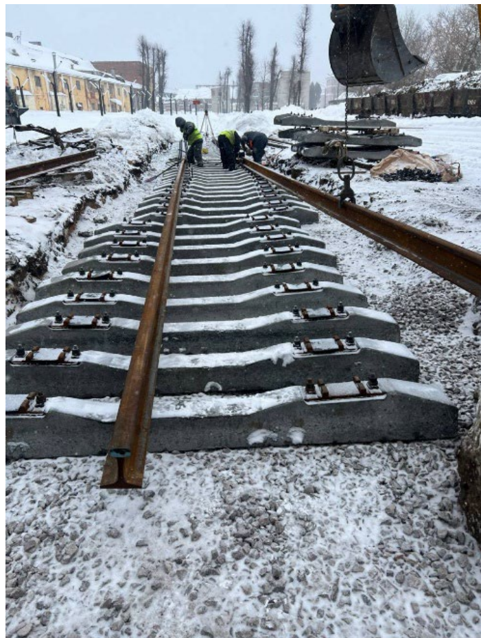
Устройство щебеночного балласта пути №7 после
