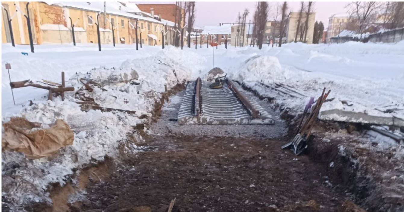
Устройство щебеночного балласта пути №7 до
