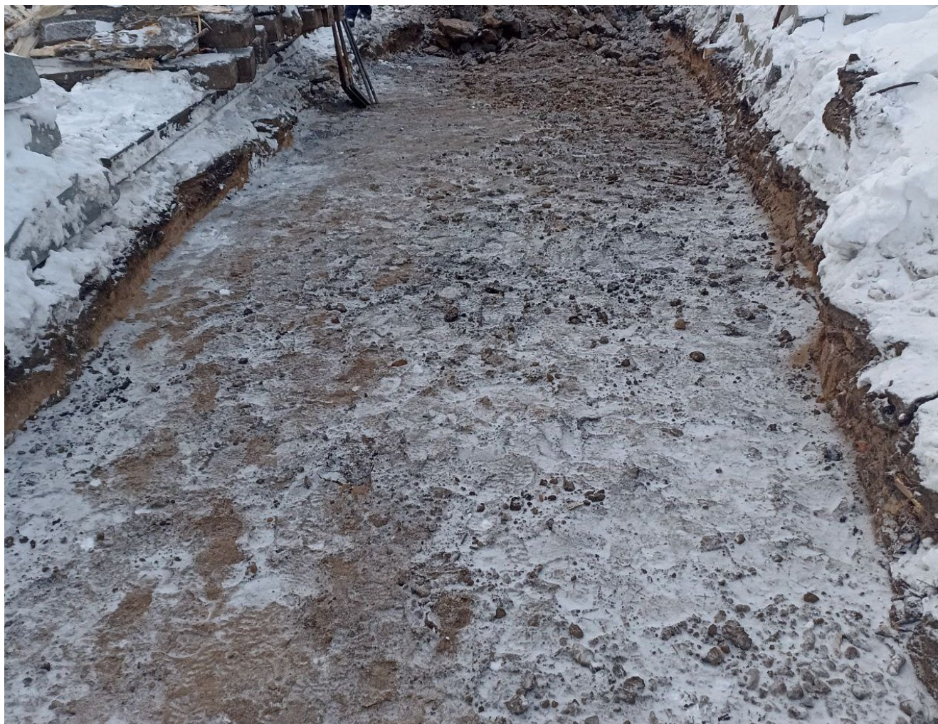
Устройство щебеночного балласта пути №7 до
