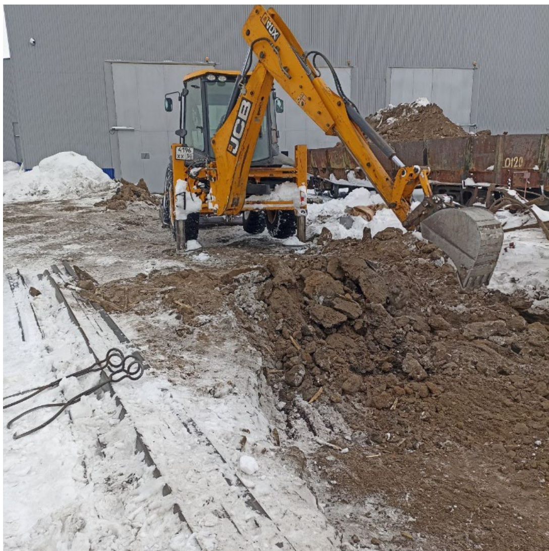
Демонтаж рельсошпальной решетки пути №7 после
