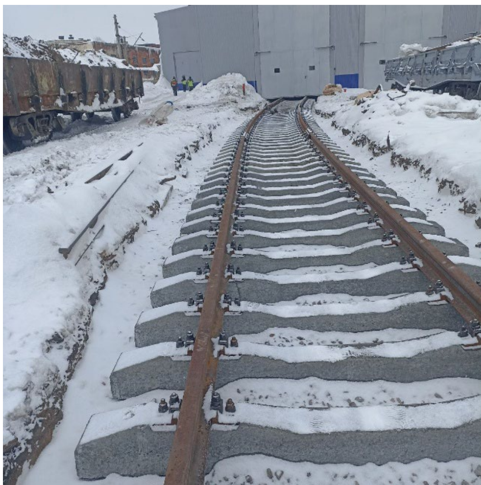
Баллаستировка, выправка и рихтовка пути №7 до
