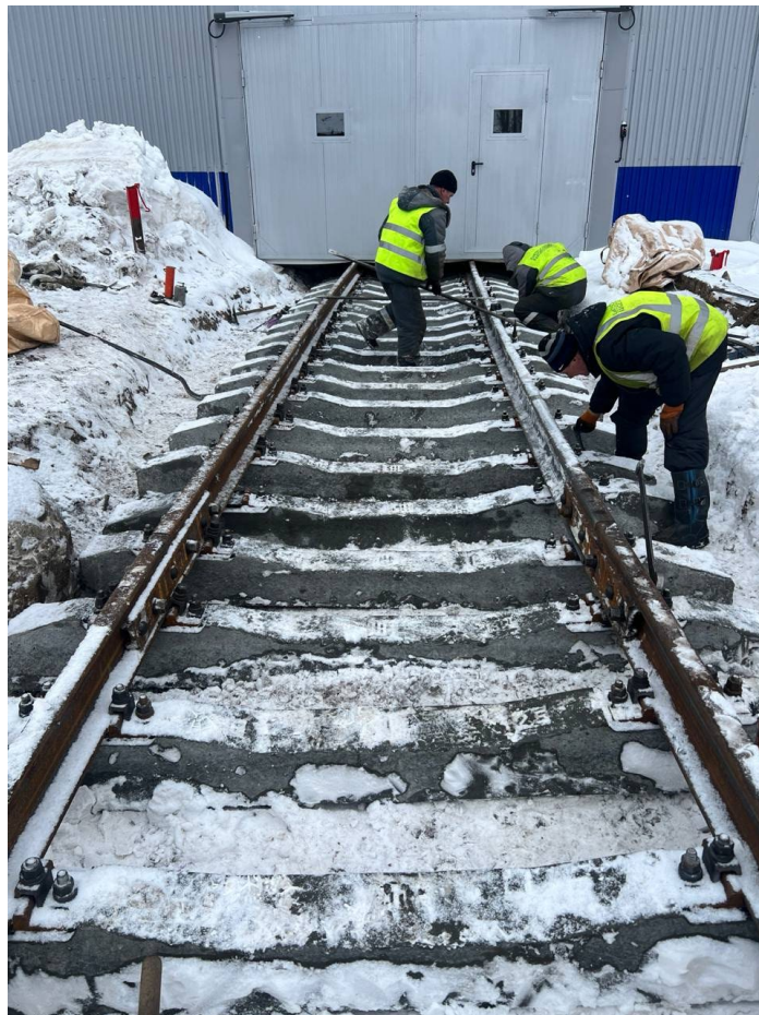
Баллаستировка, выправка и рихтовка пути №7 до
