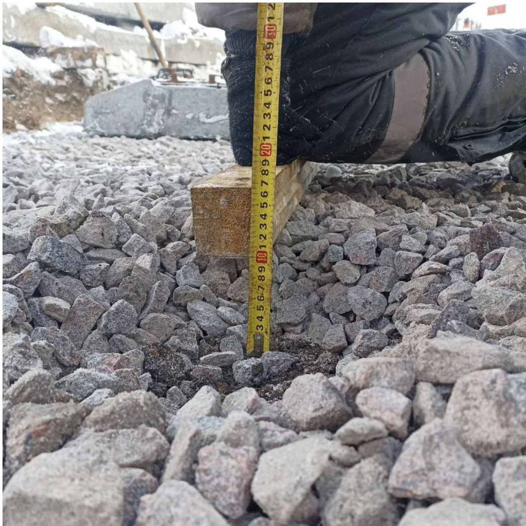
Устройство щебеночного балласта пути №7 после
