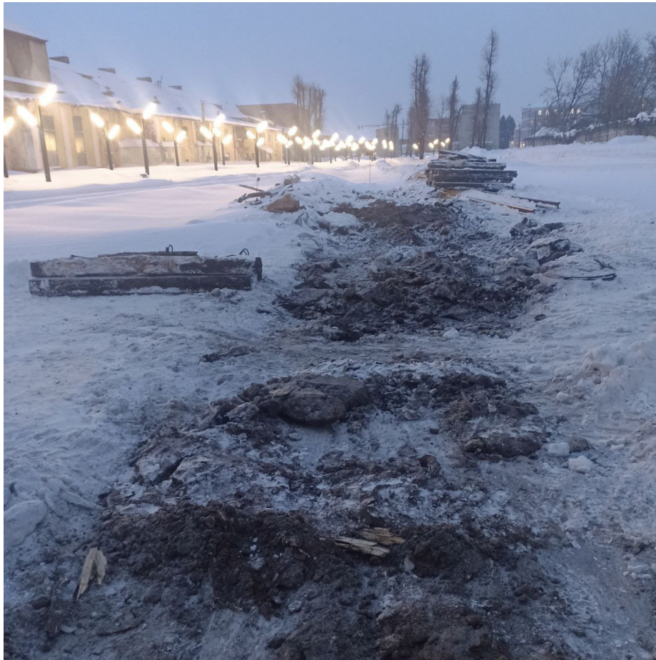
Демонтаж рельсошпальной решетки пути №7 после
