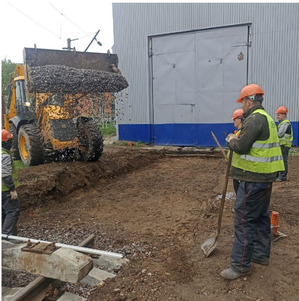
Устройство щебеночного балласта путей №9 и №10 до
