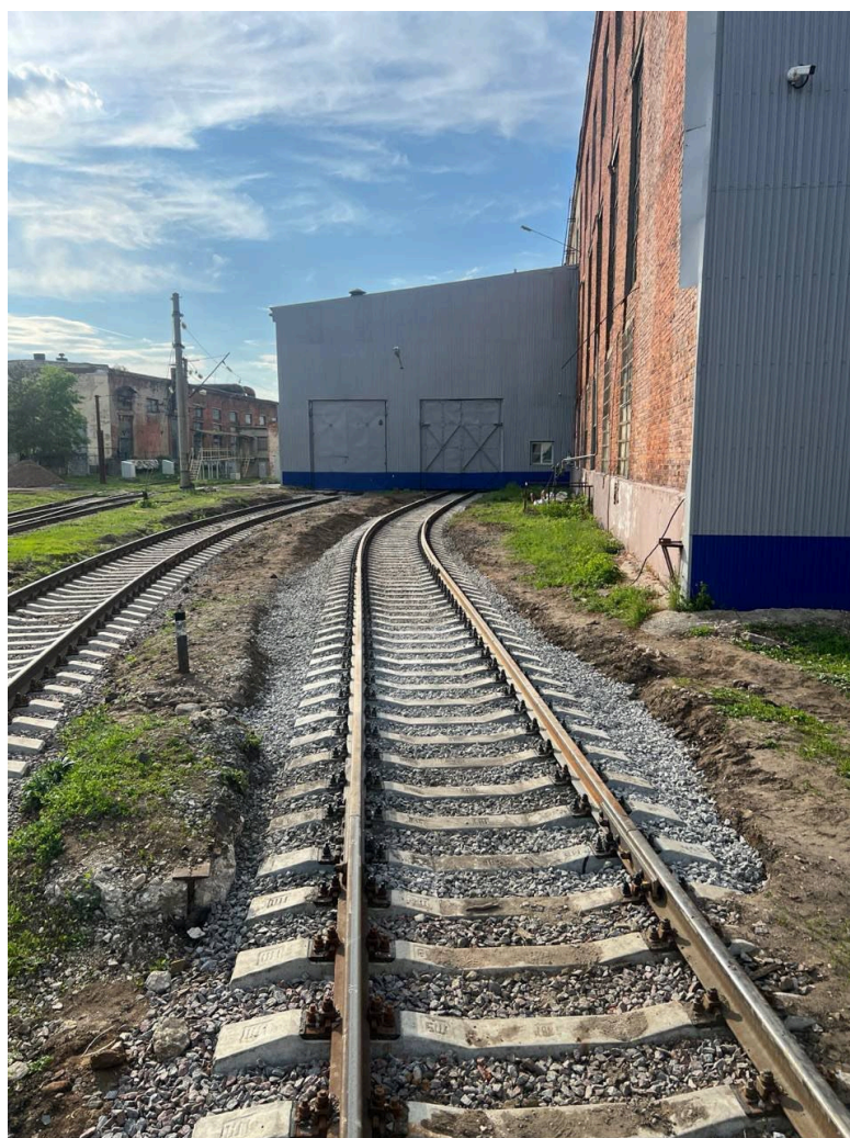
Балластировка, выправка и рихтовка путей №9 и №10 до
