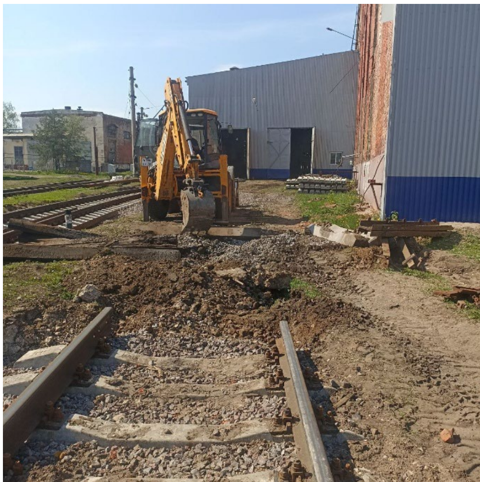
Выемка загрязненного балласта путей №9 и №10 до
