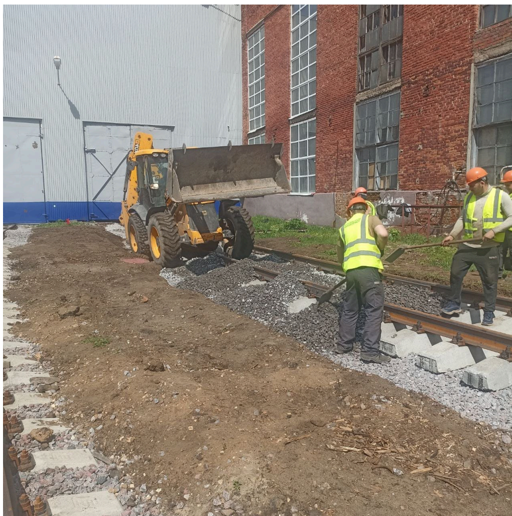
Укладка рельсошпальной решетки путей №9 и №10 после
