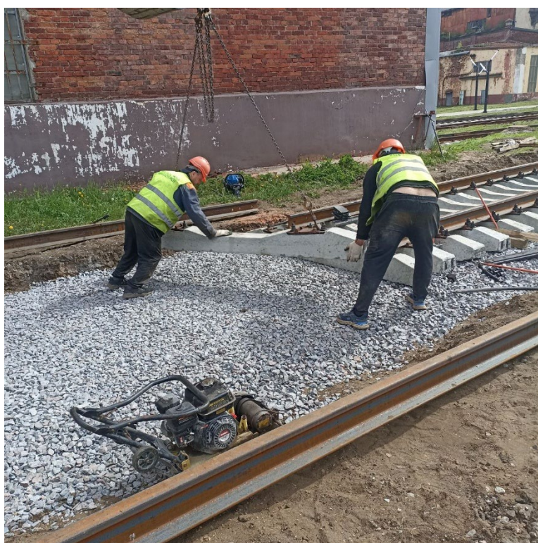
Устройство щебеночного балласта путей №9 и №10 после
