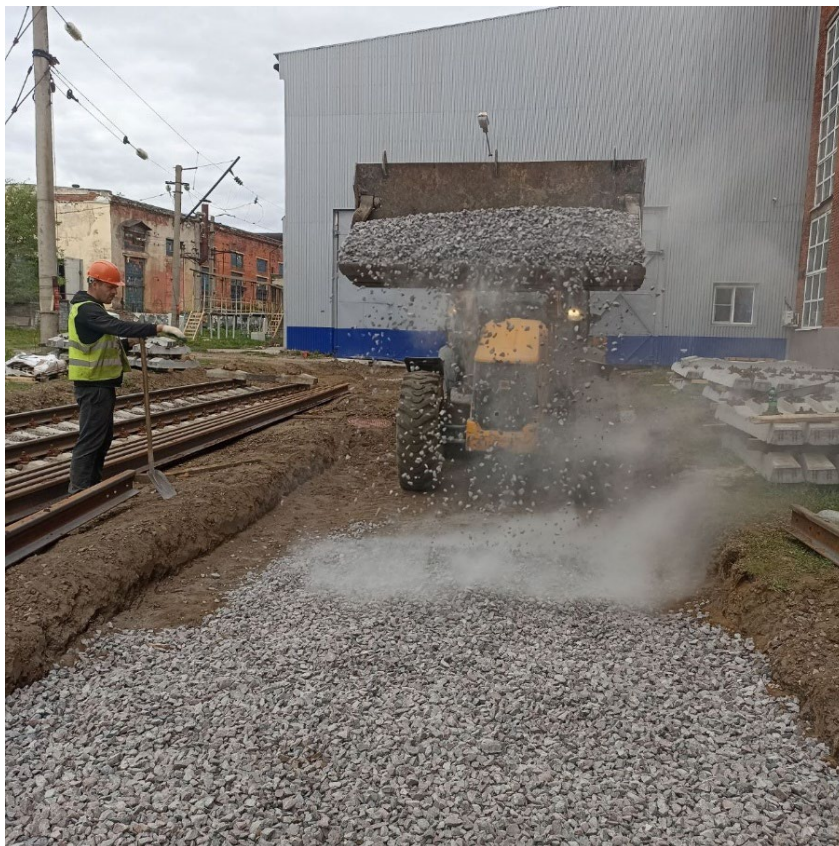
Устройство щебеночного балласта путей №9 и №10 до
