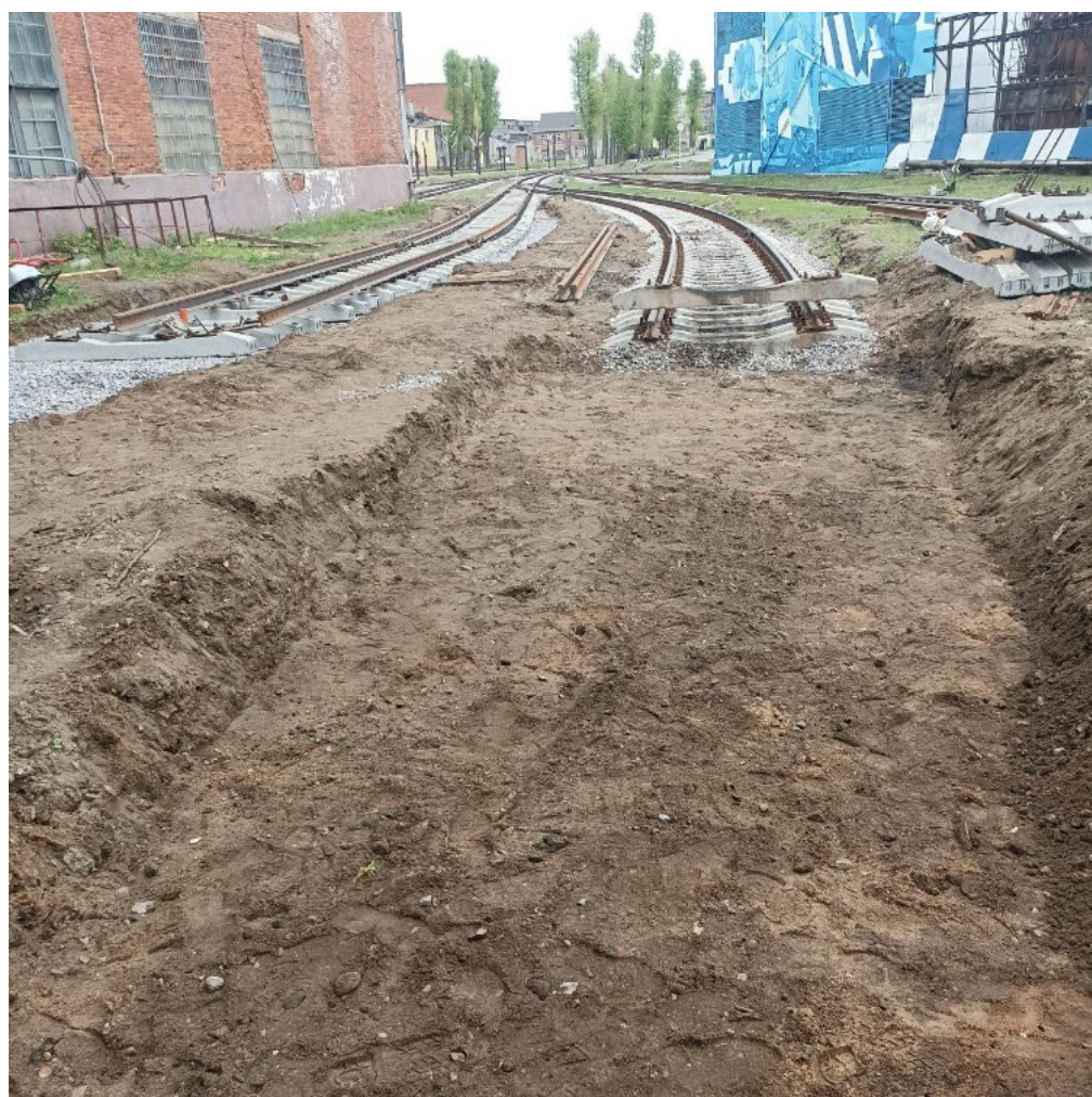
Выемка загрязненного балласта путей №9 и №10 после
