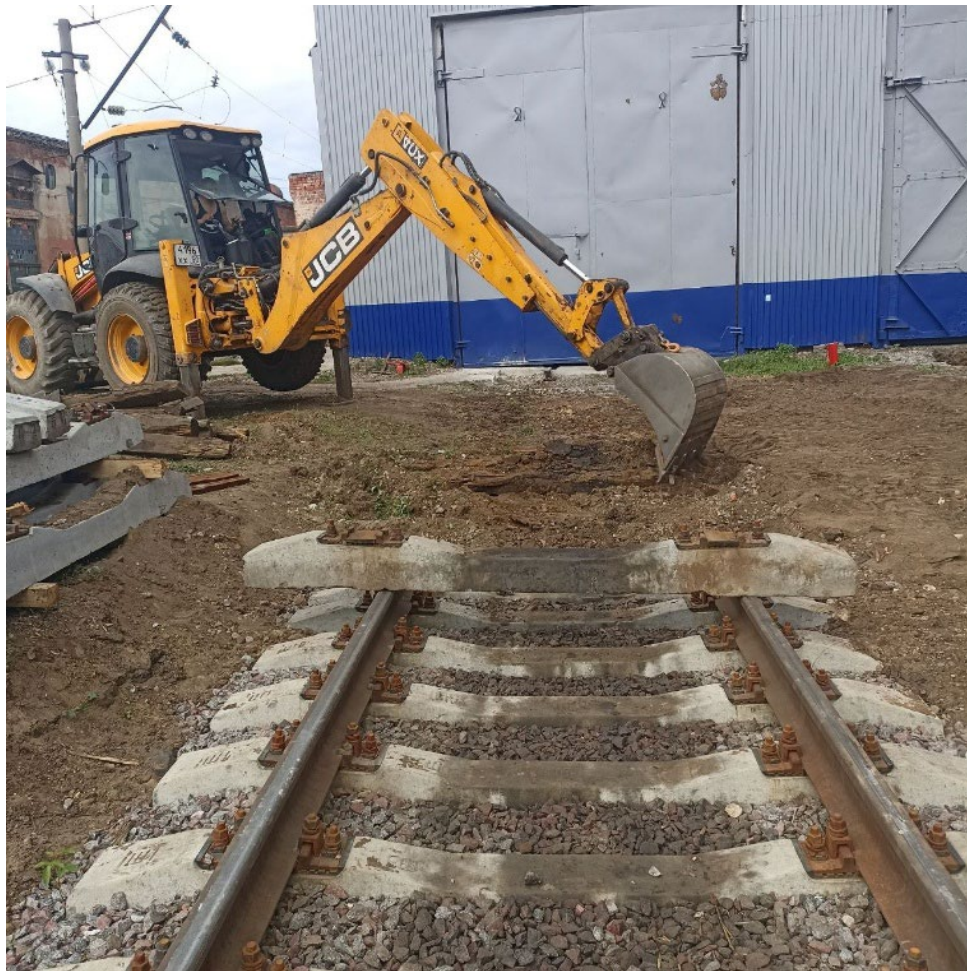
Выемка загрязненного балласта путей №9 и №10 до
