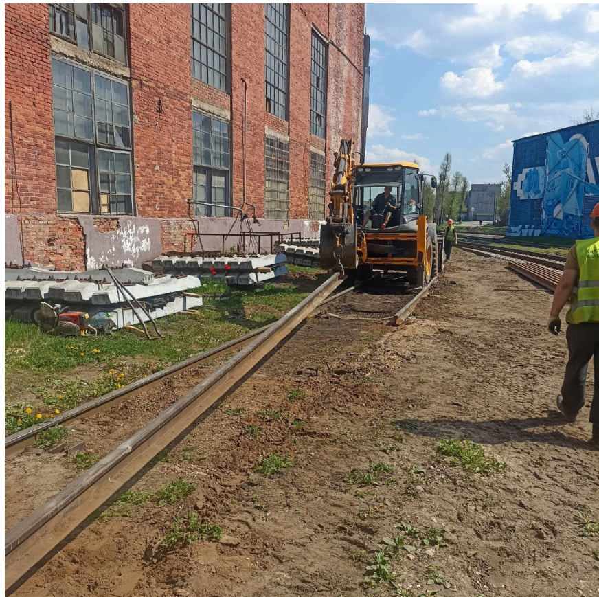
Демонтаж рельсошпальной решетки путей №9 и №10 до
