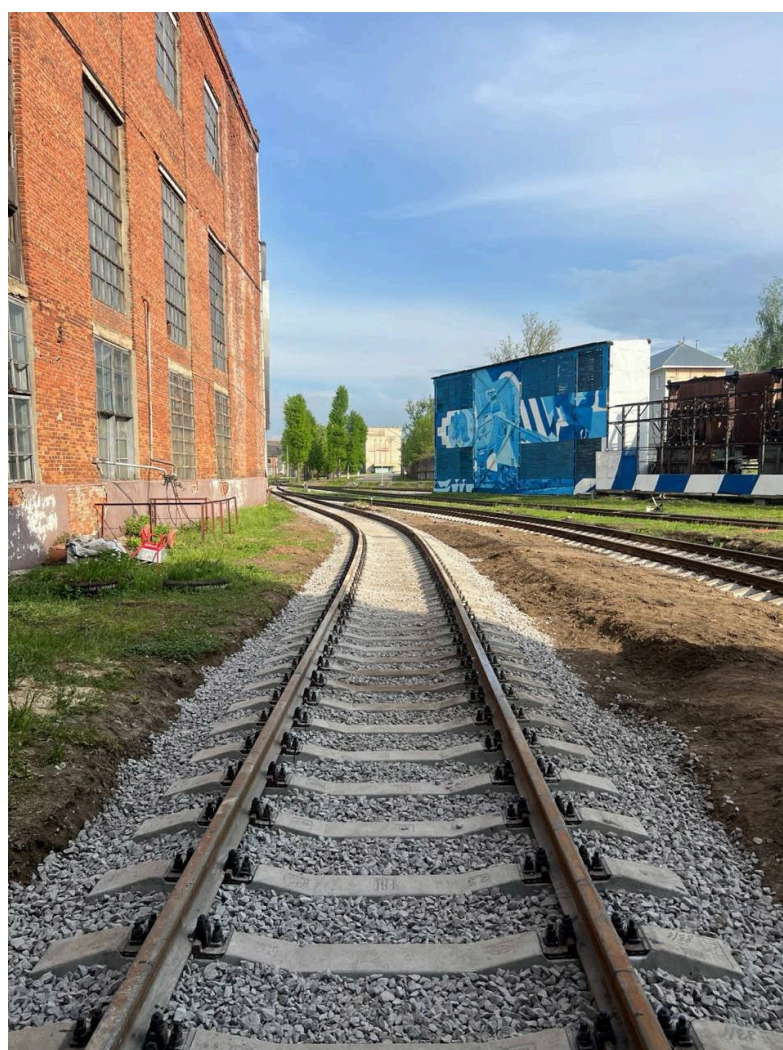
Балластировка, выправка и рихтовка путей №9 и №10 после
