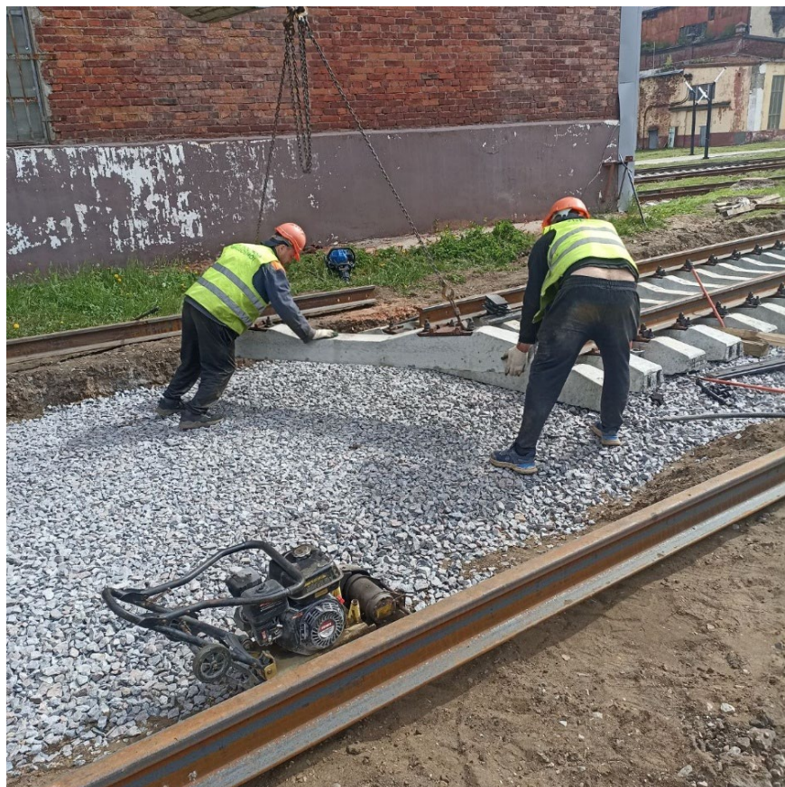
Укладка рельсошпальной решетки путей №9 и №10 до
