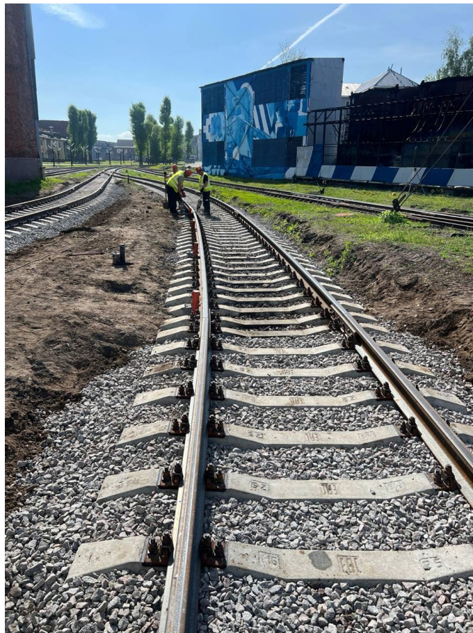
Балластировка, выправка и рихтовка путей №9 и №10 до
