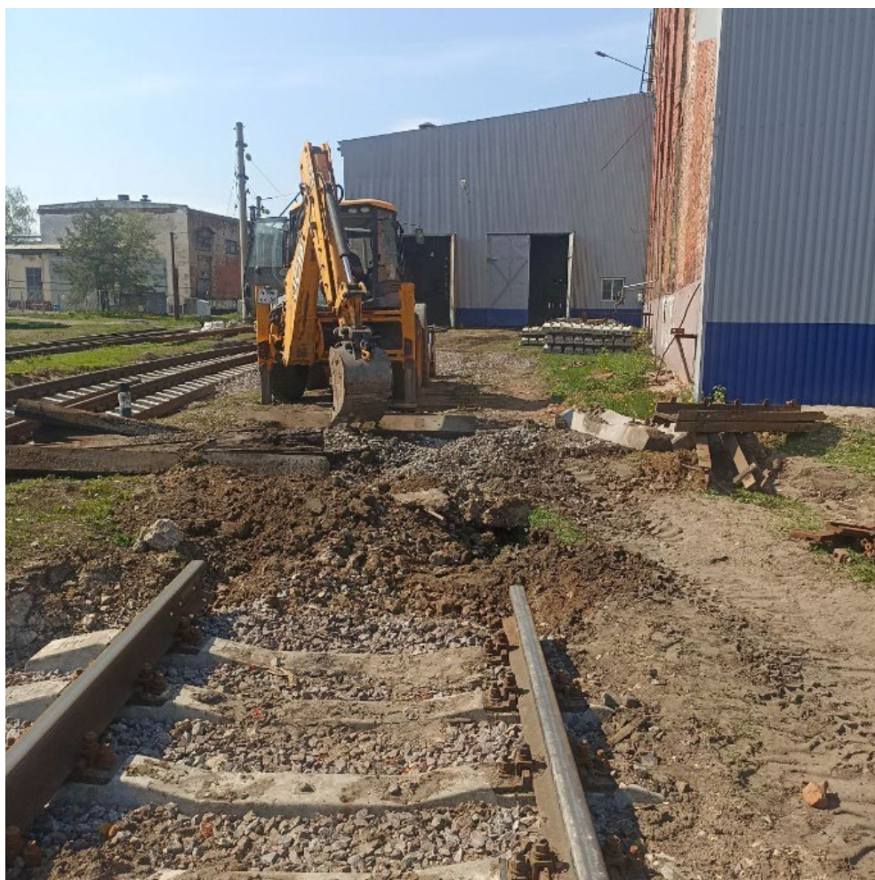
Демонтаж рельсошпальной решетки путей №9 и №10 после
