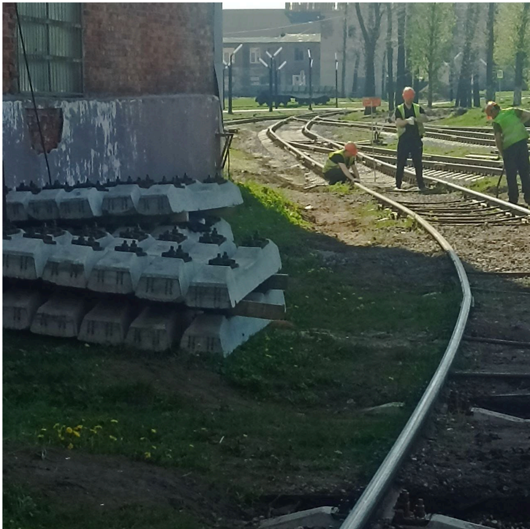
Демонтаж рельсошпальной решетки путей №9 и №10 до
