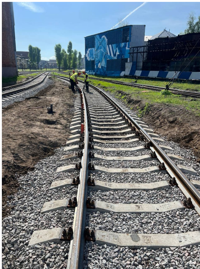
Укладка рельсошпальной решетки путей №9 и №10 после
