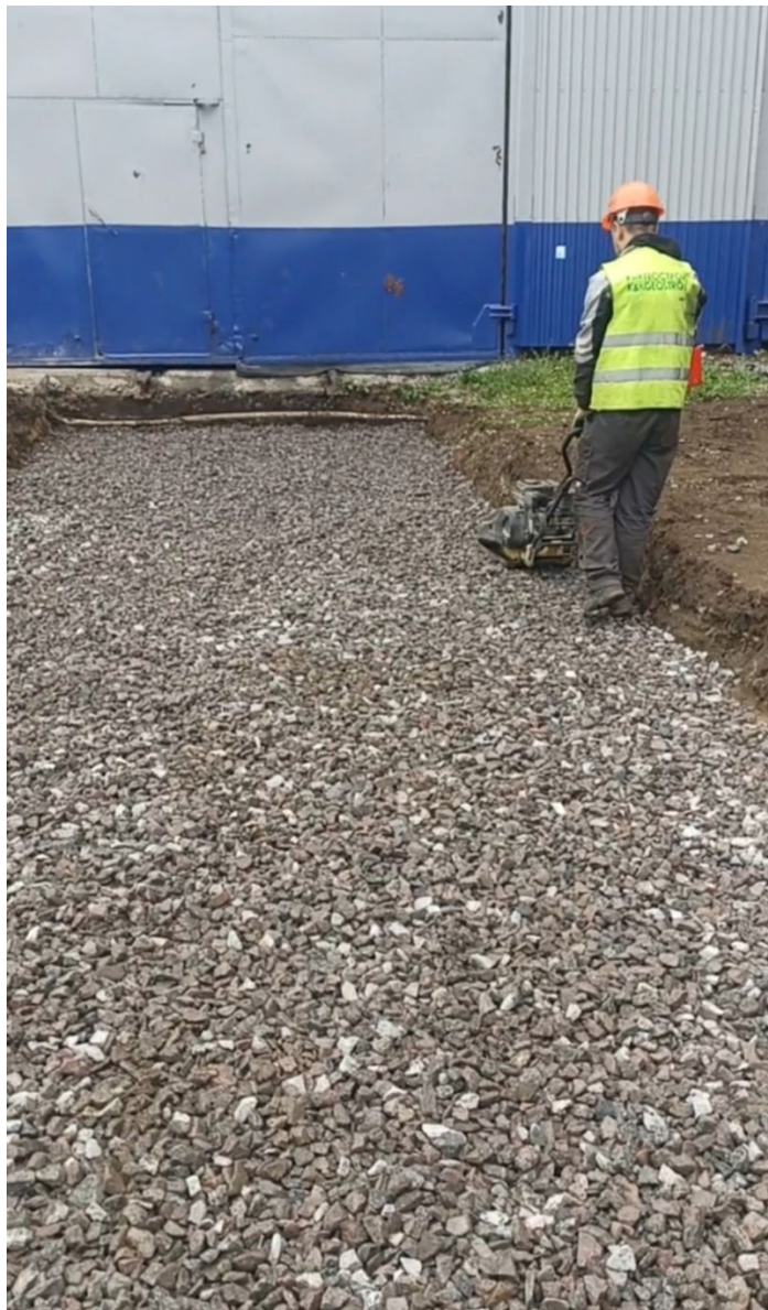
Устройство щебеночного балласта путей №9 и №10 после
