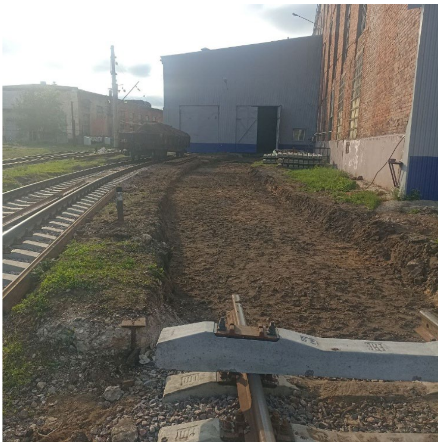
Выемка загрязненного балласта путей №9 и №10 после
