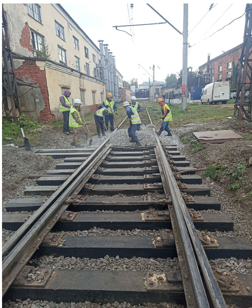
Балластировка стрелочного перевода №12 на жд. пути №11 до
