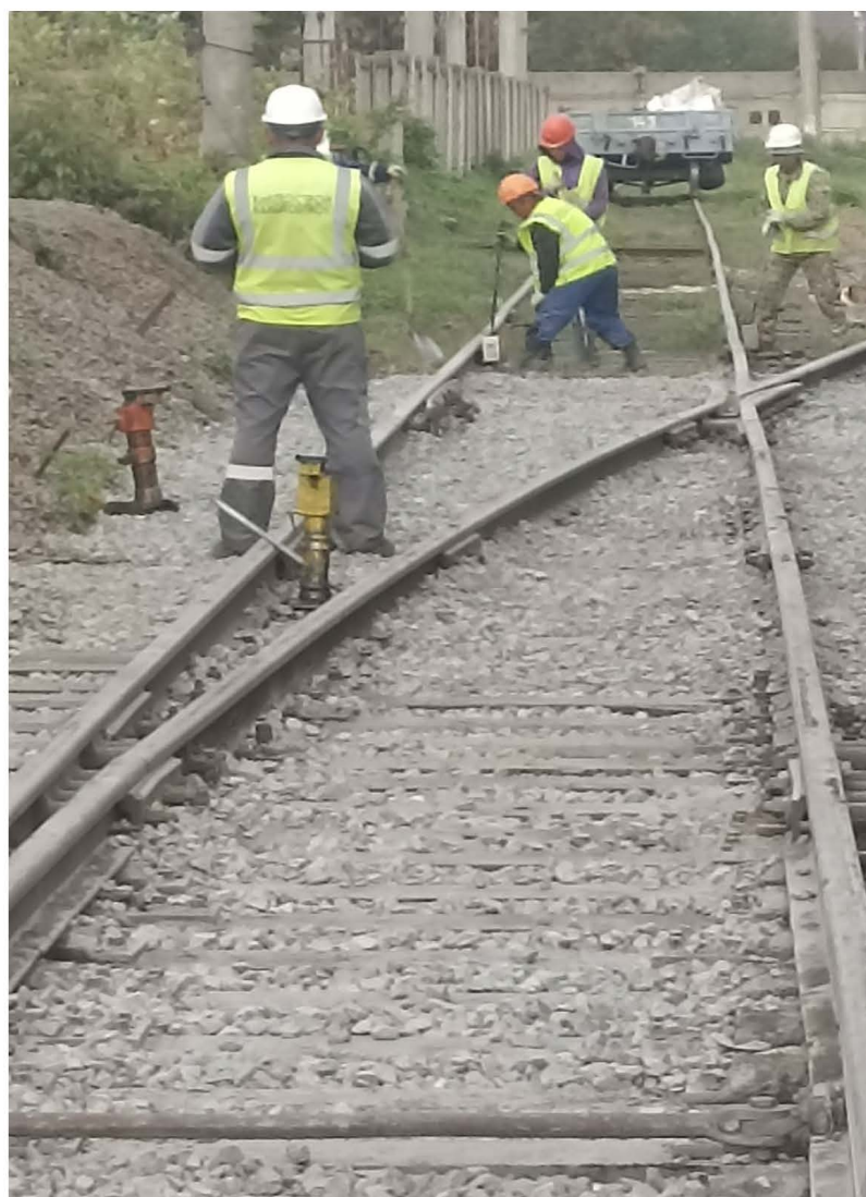
Балластировка стрелочного перевода №12 на жд. пути №11 после
