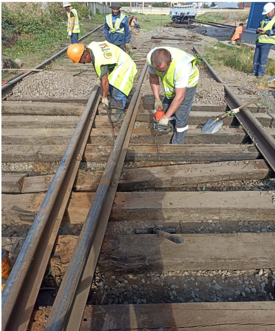
Ремонт стрелочного перевода №12 на жд. пути №11 до
