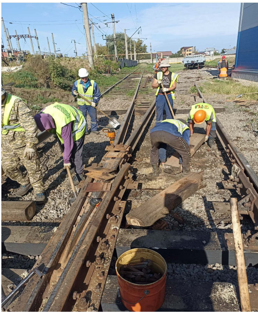
Внесение дополнительного щебня стрелочного перевода №12 на жд. пути №11 до
