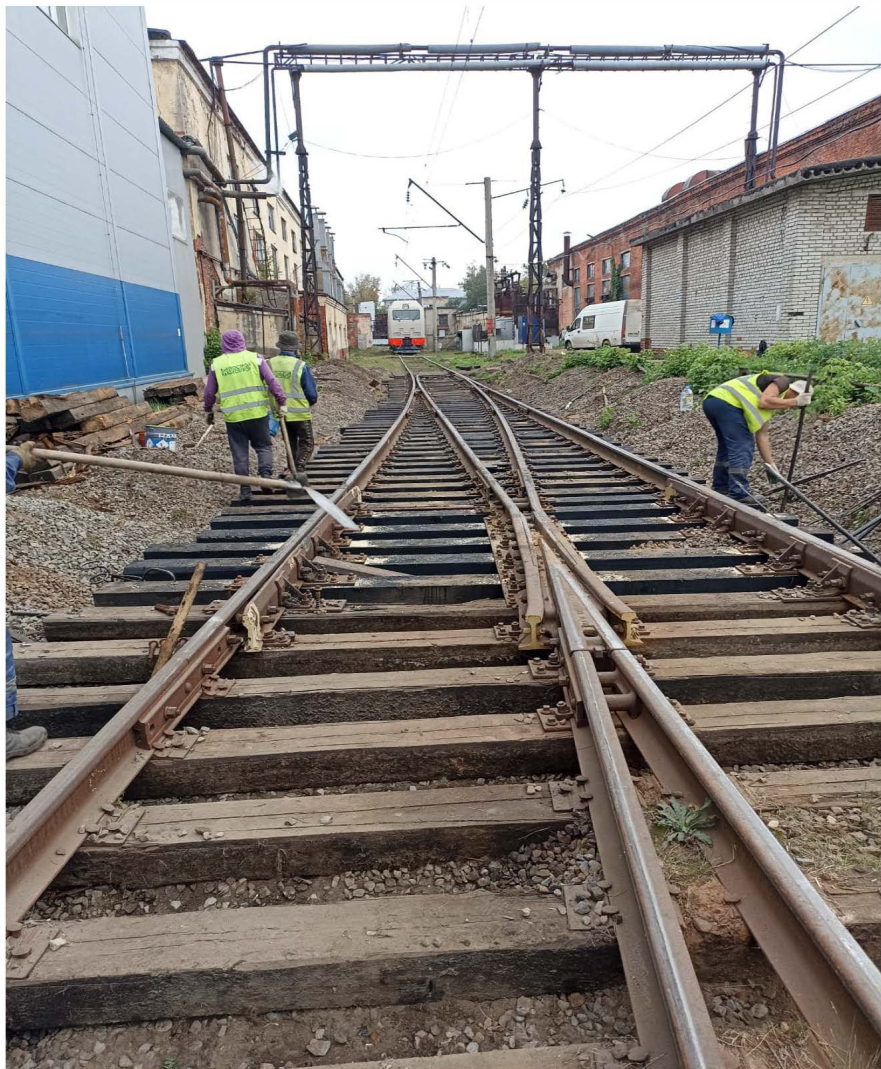
Ремонт стрелочного перевода №12 на жд. пути №11 после
