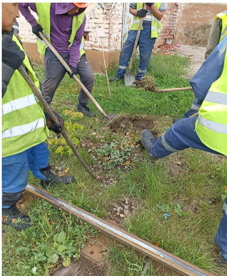
Очистка стрелочного перевода №12 на жд. пути №11 до
