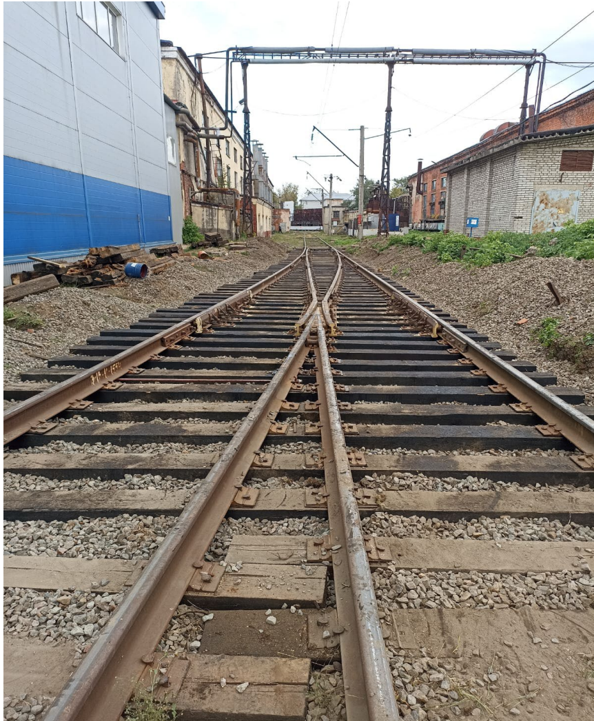
Балластировка стрелочного перевода №12 на жд. пути №11 до
