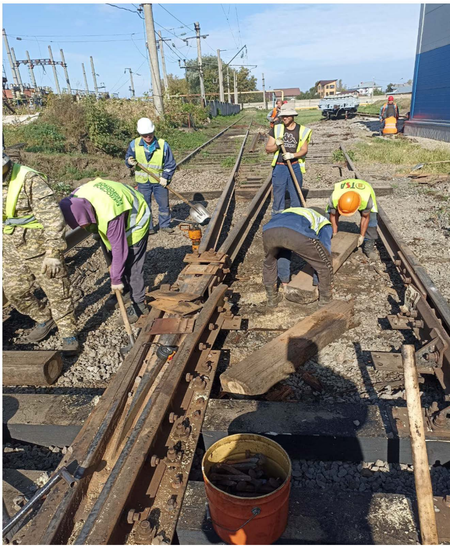
Ремонт стрелочного перевода №12 на жд. пути №11 до
