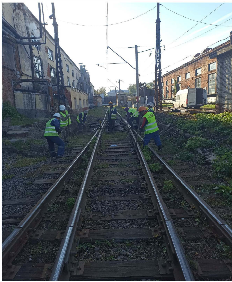
Очистка стрелочного перевода №12 на жд. пути №11 после
