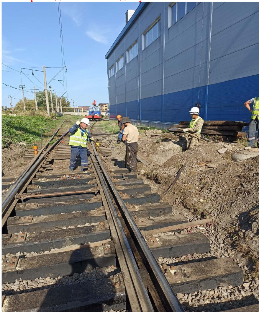
Внесение дополнительного щебня стрелочного перевода №12 на жд. пути №11 после
