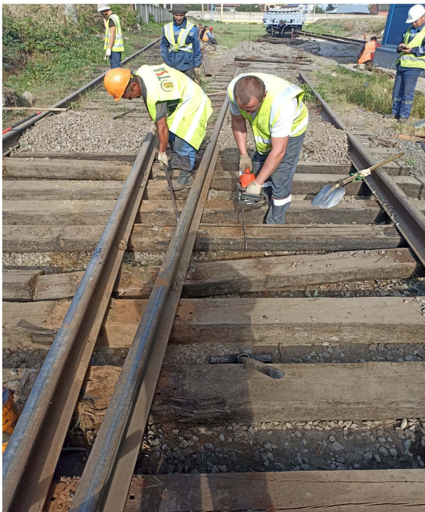
Внесение дополнительного щебня стрелочного перевода №12 на жд. пути №11 до
