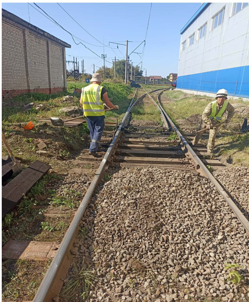
Очистка стрелочного перевода №12 на жд. пути №11 до
