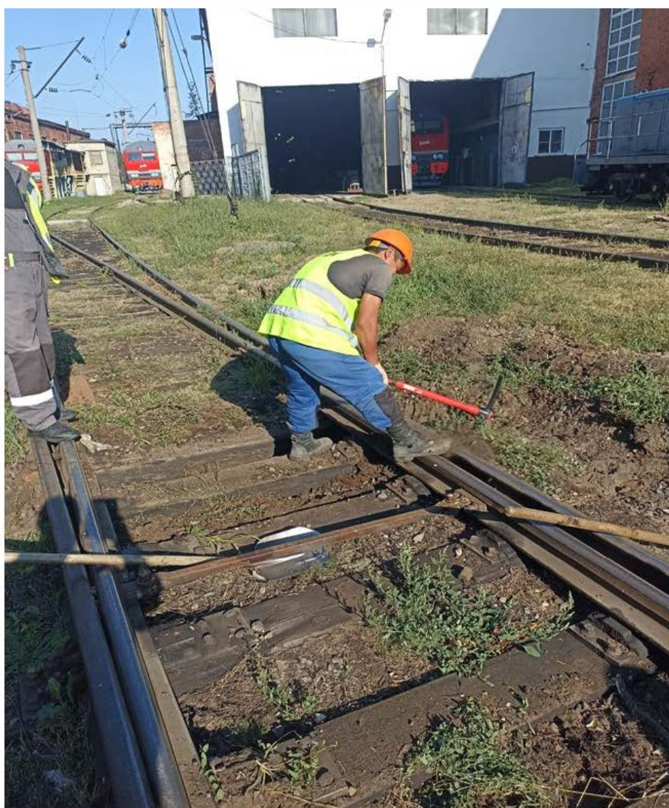
Ремонт стрелочного перевода №126 на жд. пути №11 до
