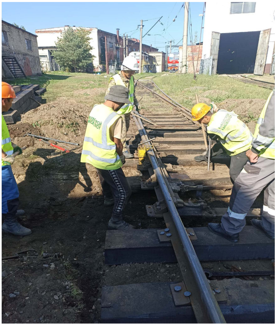
Внесение дополнительного щебня в основание стрелочного перевода №126 на жд. пути №11 до
