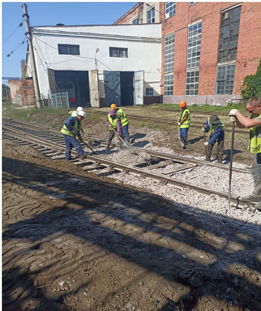
Внесение дополнительного щебня в основание стрелочного перевода №126 на жд. пути №11 после
