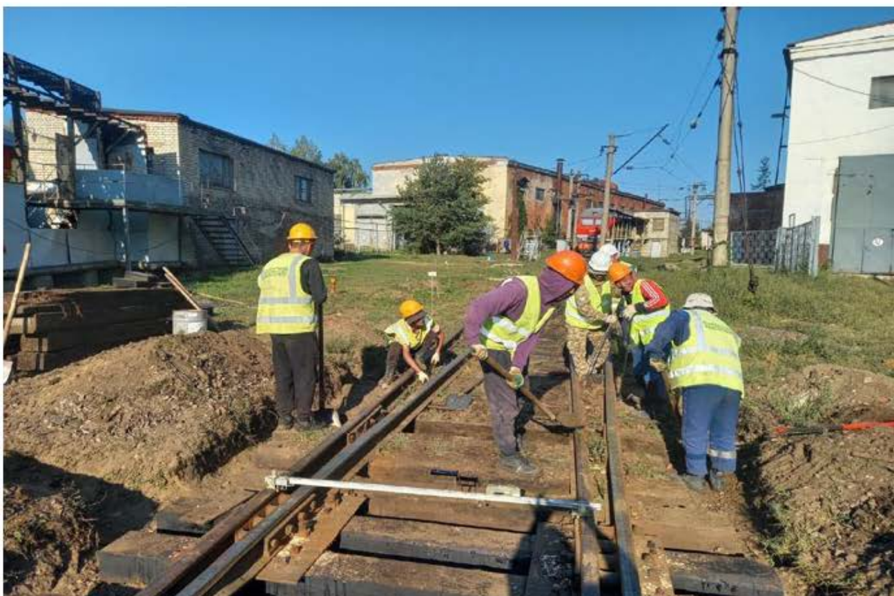
Ремонт стрелочного перевода №126 на жд. пути №11 до
