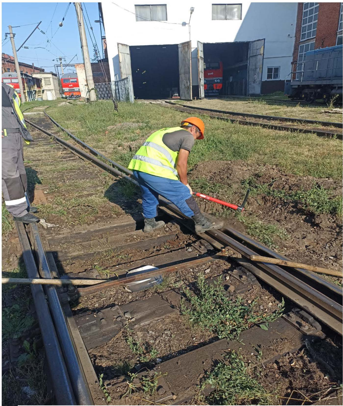
Очистка стрелочного перевода №126 на жд. пути №11 до
