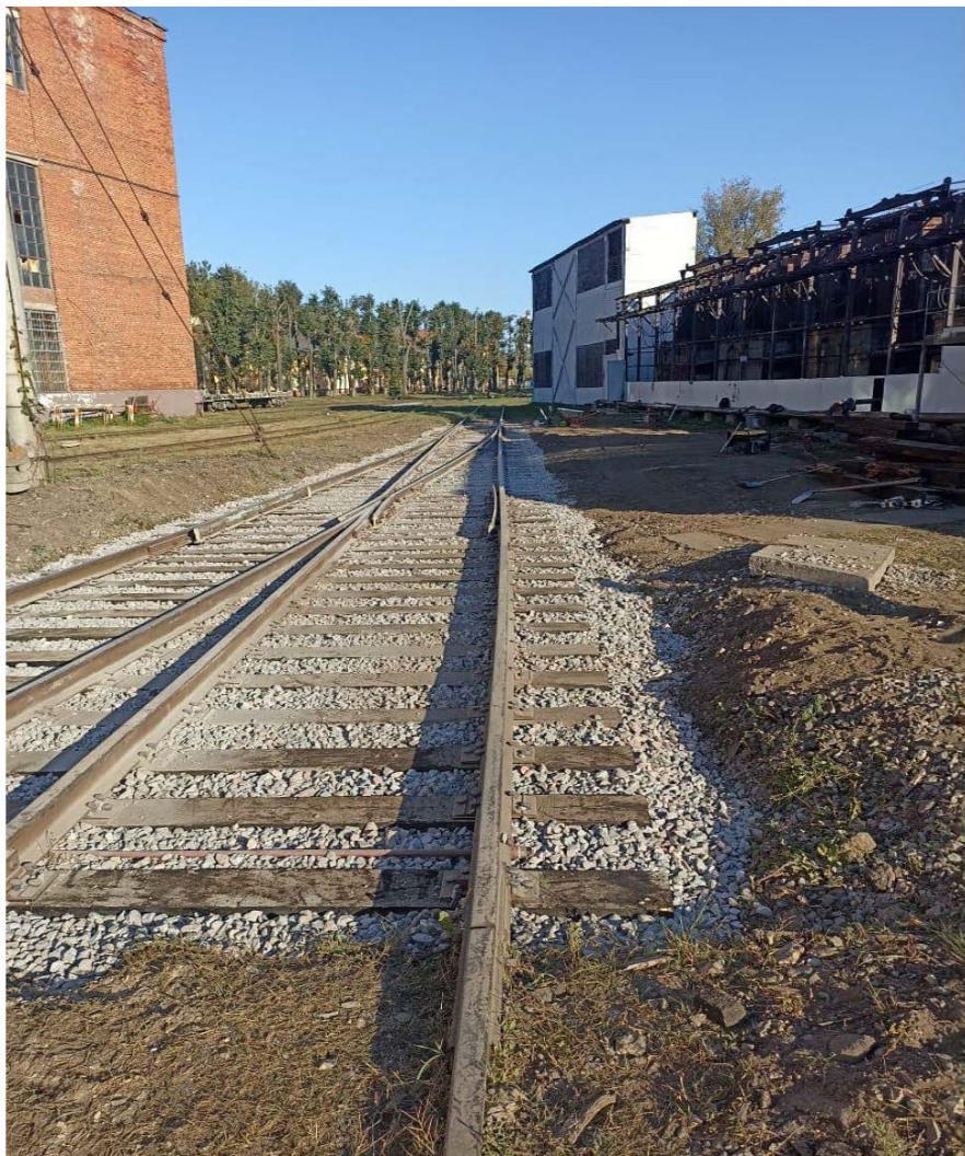
Балластировка стрелочного перевода №126 на жд. пути №11 после
