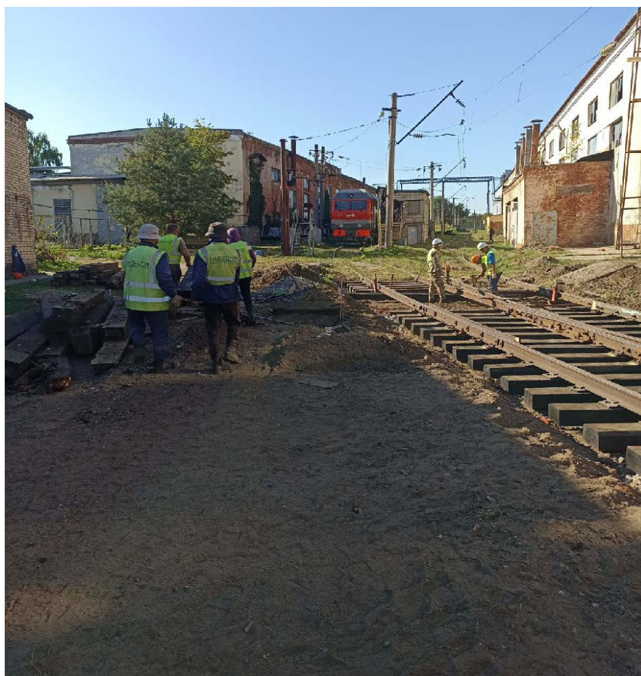
Внесение дополнительного щебня в основание стрелочного перевода №126 на жд. пути №11 после
