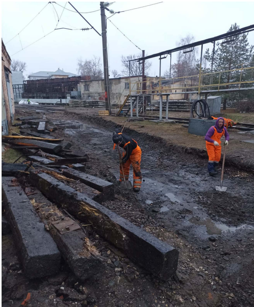
Внесение дополнительного щебня в основания железнодорожных путей №9, №10, №11 до
