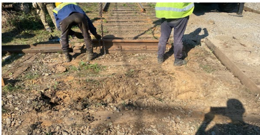
Демонтаж железнодорожных путей №9, №10, №11 до
