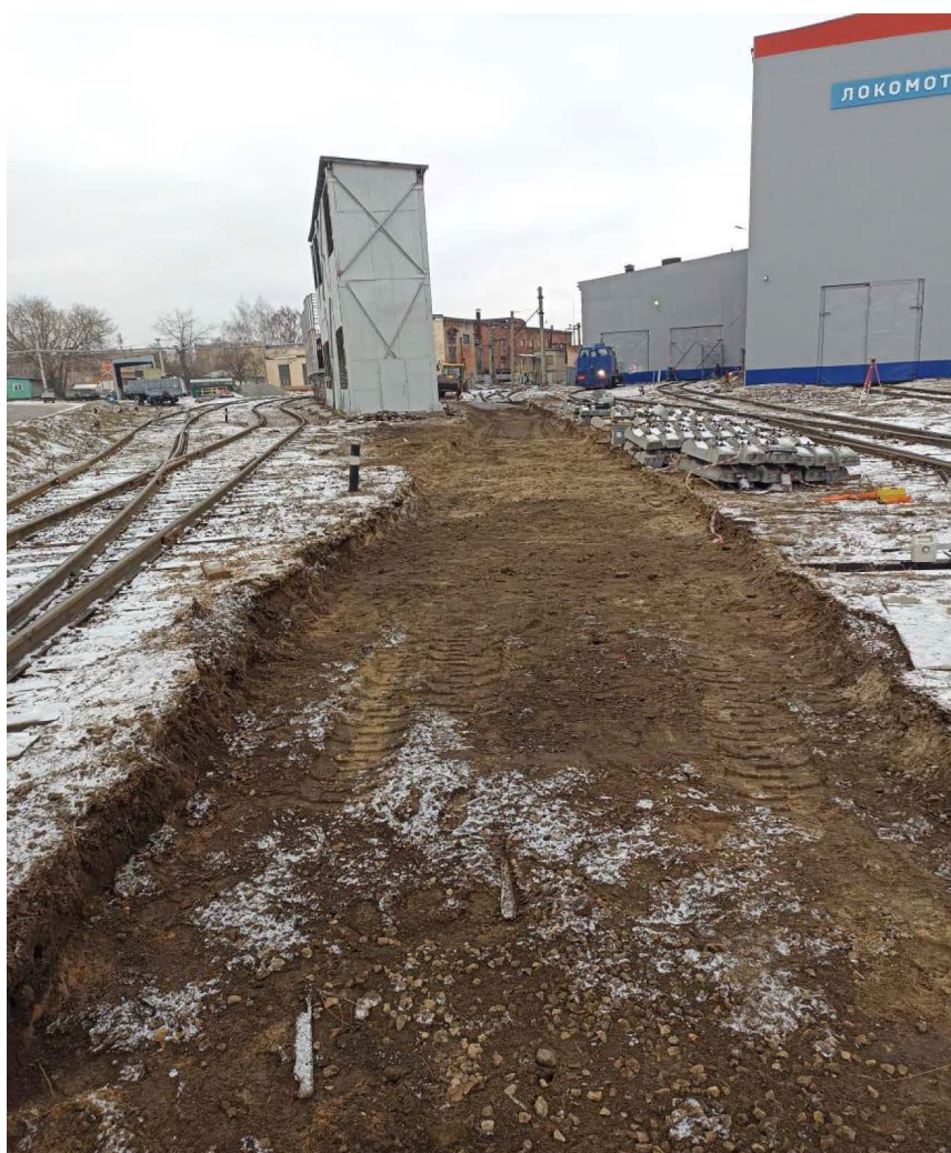
Внесение дополнительного щебня в основания железнодорожных путей №9, №10, №11 до
