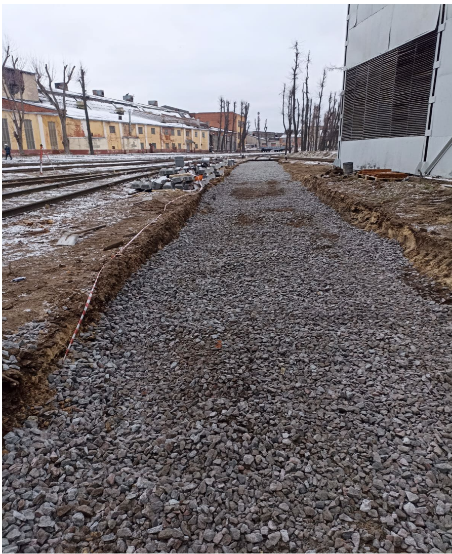
Внесение дополнительного щебня в основания железнодорожных путей №9, №10, №11 после
