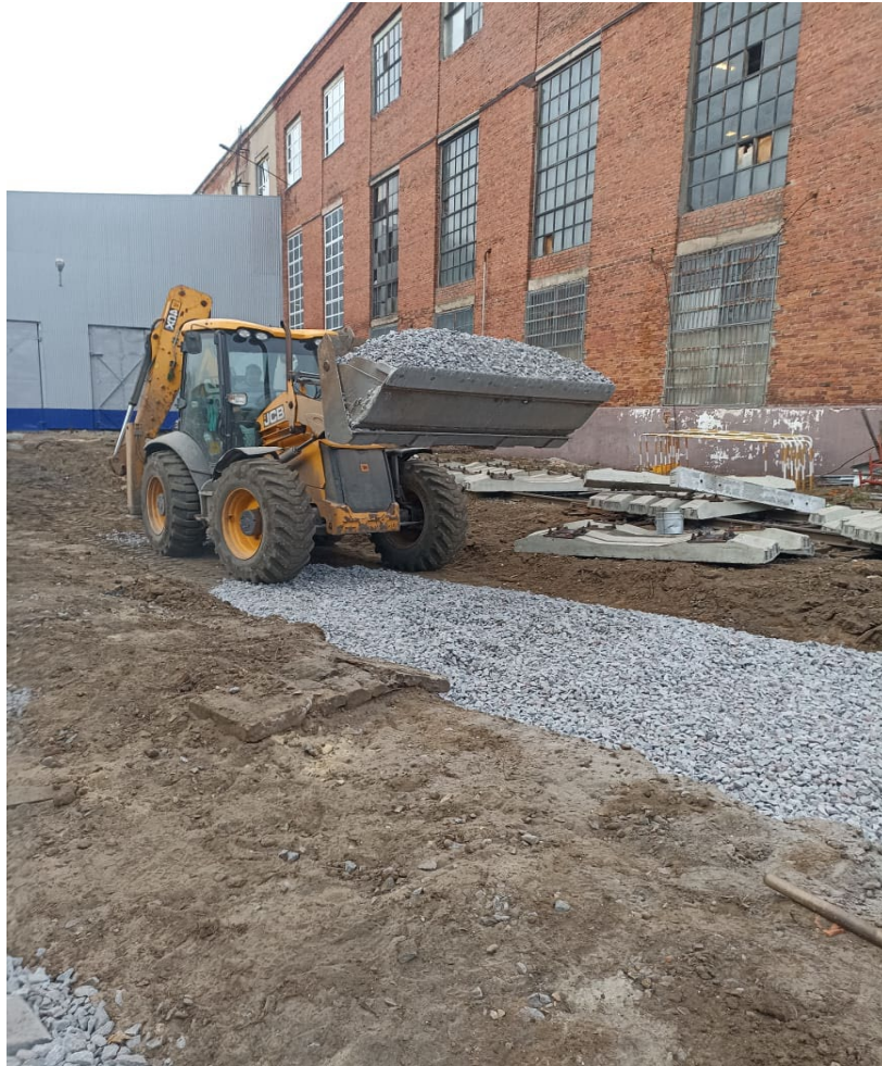
Внесение дополнительного щебня в основания железнодорожных путей №9, №10, №11 после
