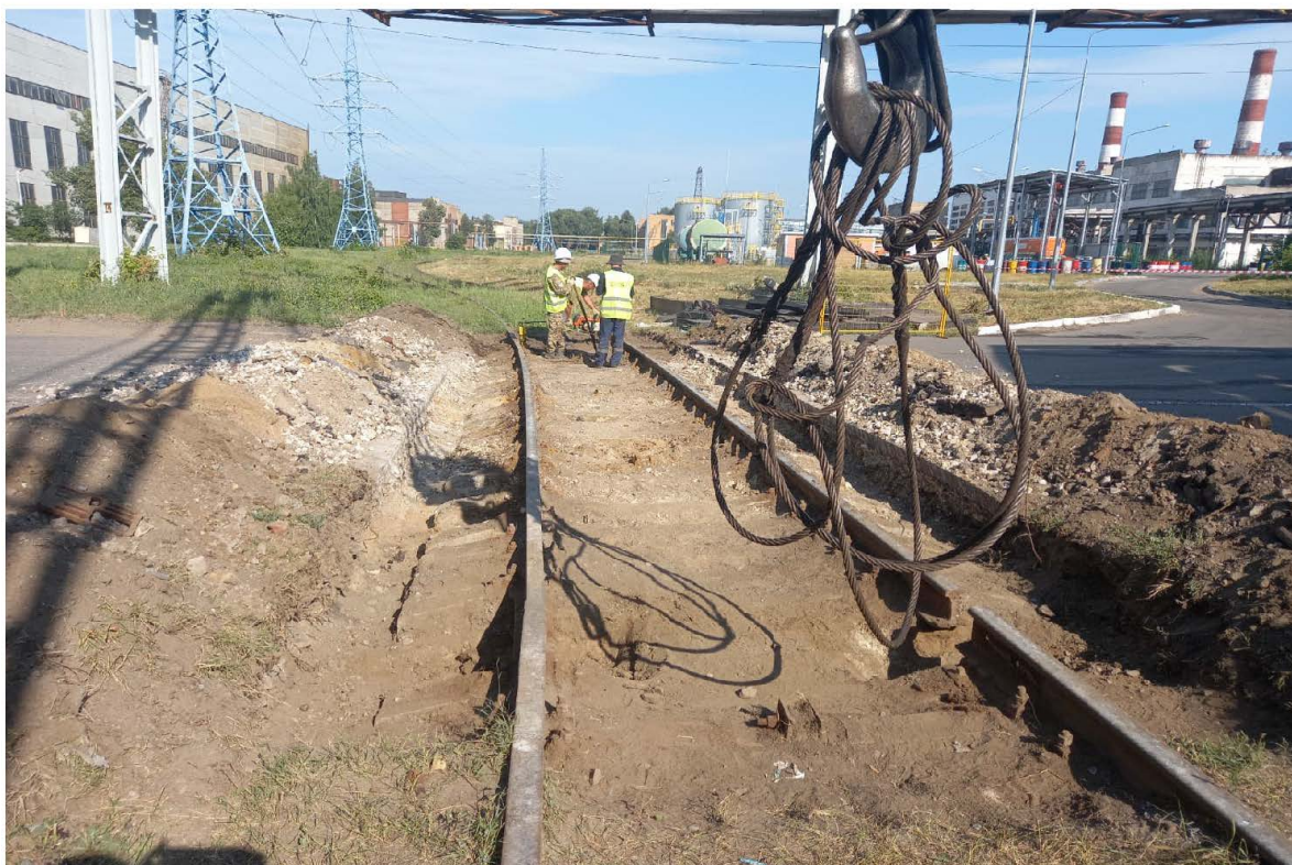
Балластировка, выправка и рихтовка жд. пути №7а переезд №30 до
