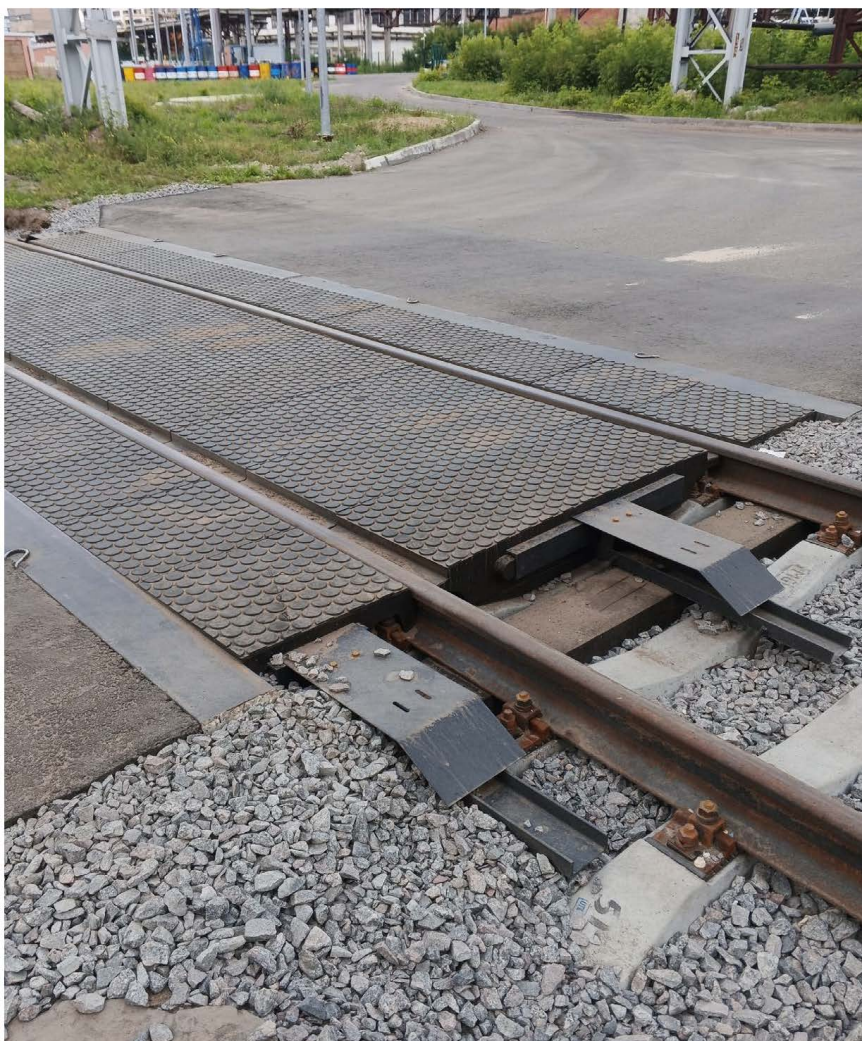
Переустройство резинокордового покрытия переезда №30 после
