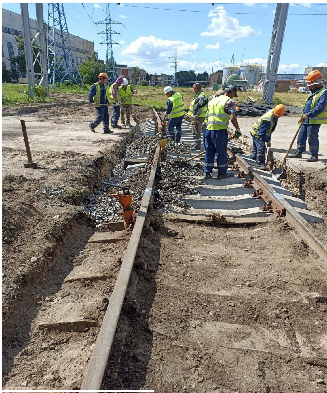
Балластировка, выправка и рихтовка жд. пути №7а переезд №30 до
