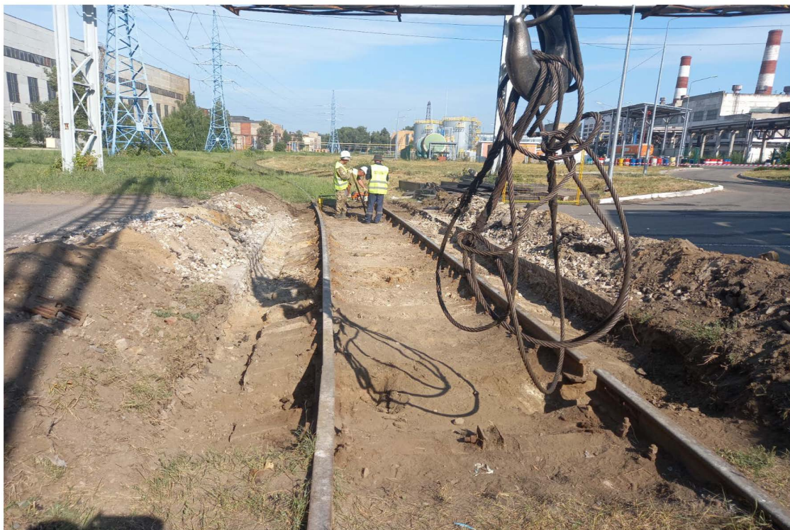
Демонтаж асфальтового покрытия переезда №30 после
