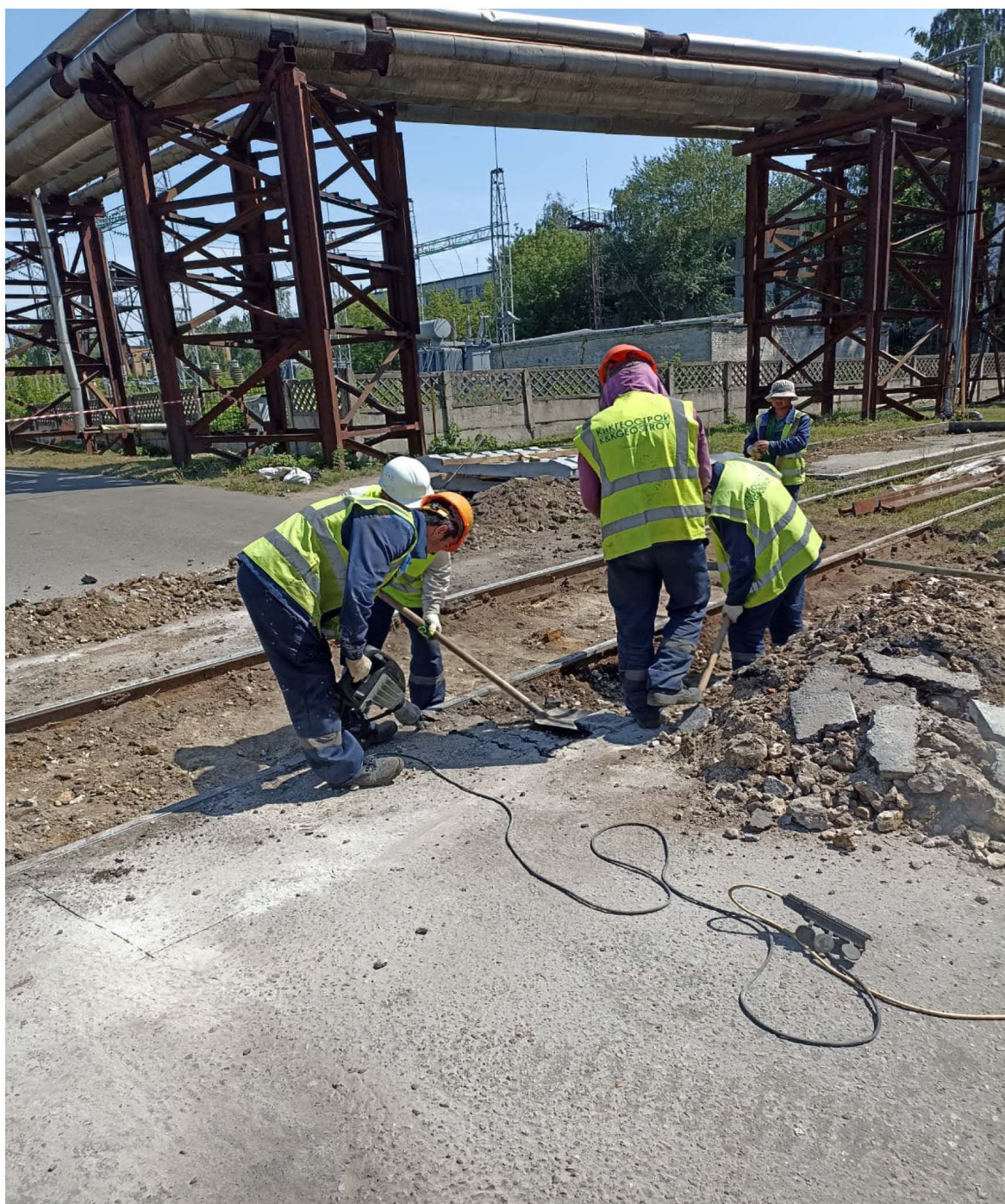
Монтаж новой рельсошпальной решетки жд. пути №7а переезд №30 до
