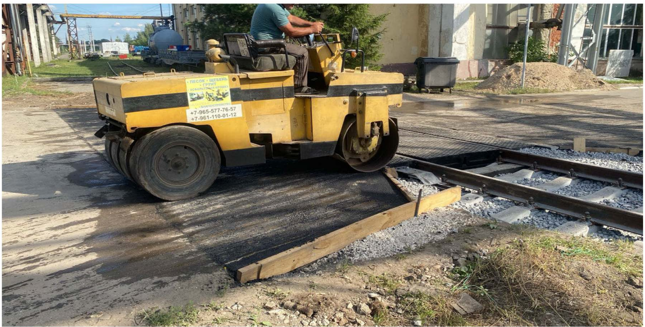
Устройство асфальтового покрытия переезда №30 после
