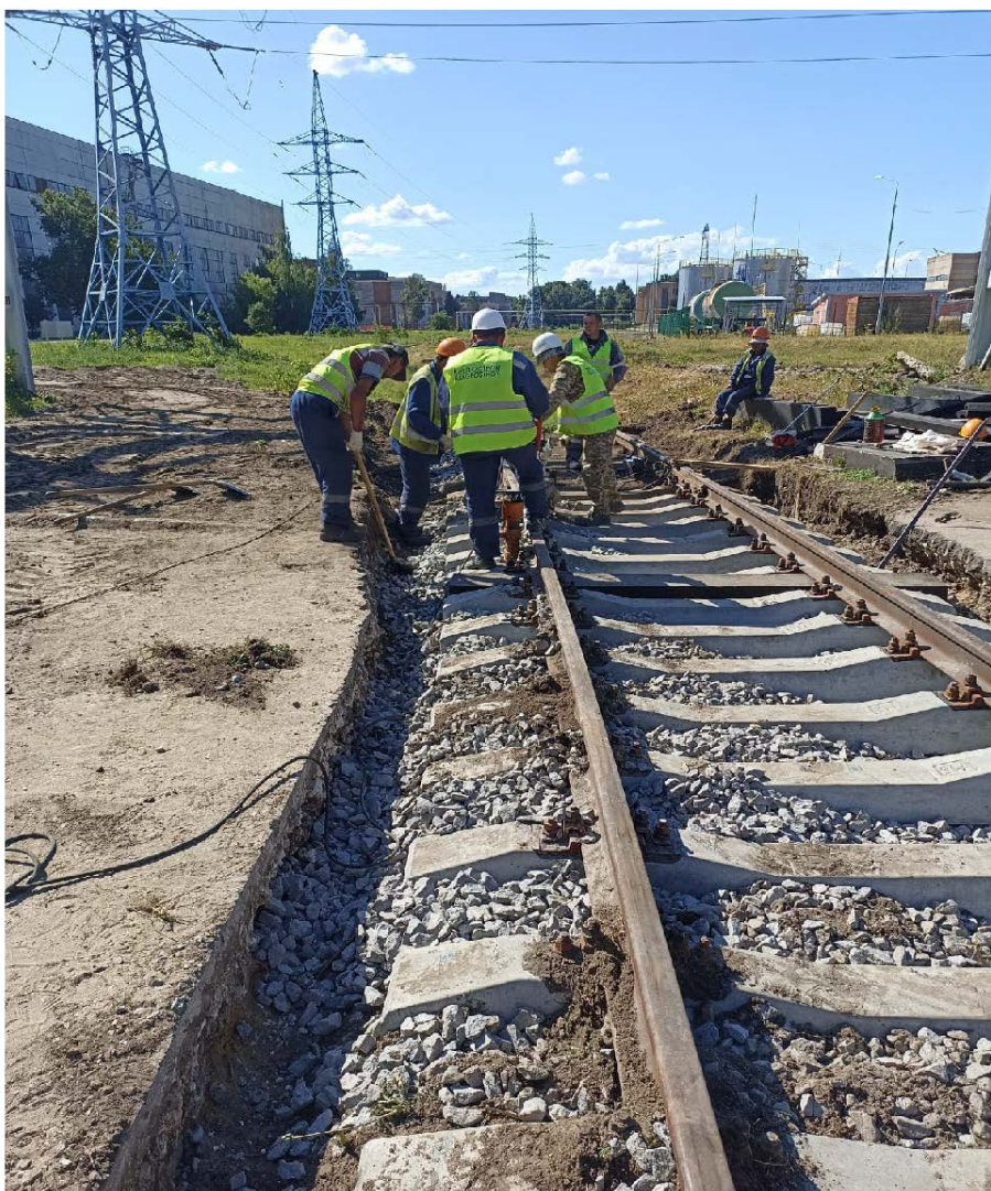
Монтаж новой рельсошпальной решетки жд. пути №7а переезд №30 после
