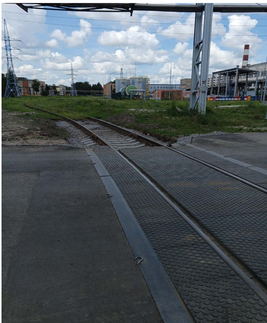
Переустройство резинокордового покрытия переезда №30 после
