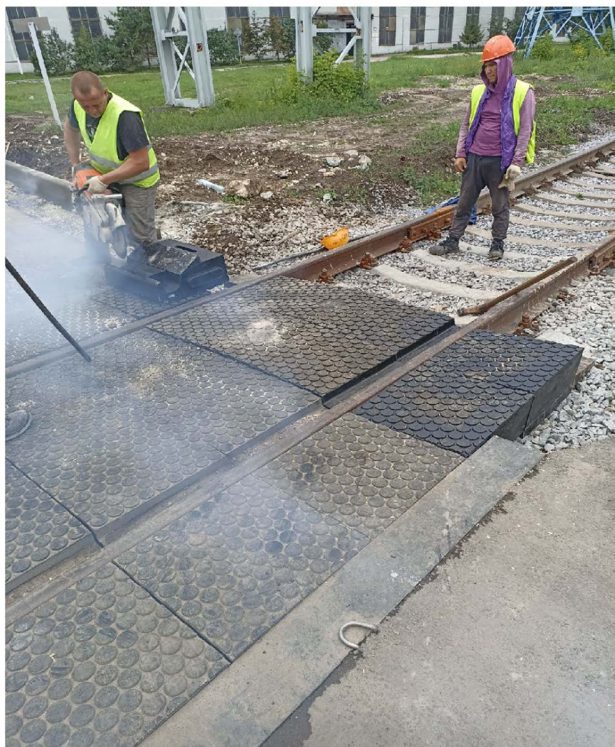
Переустройство резинокордового покрытия переезда №30 до
