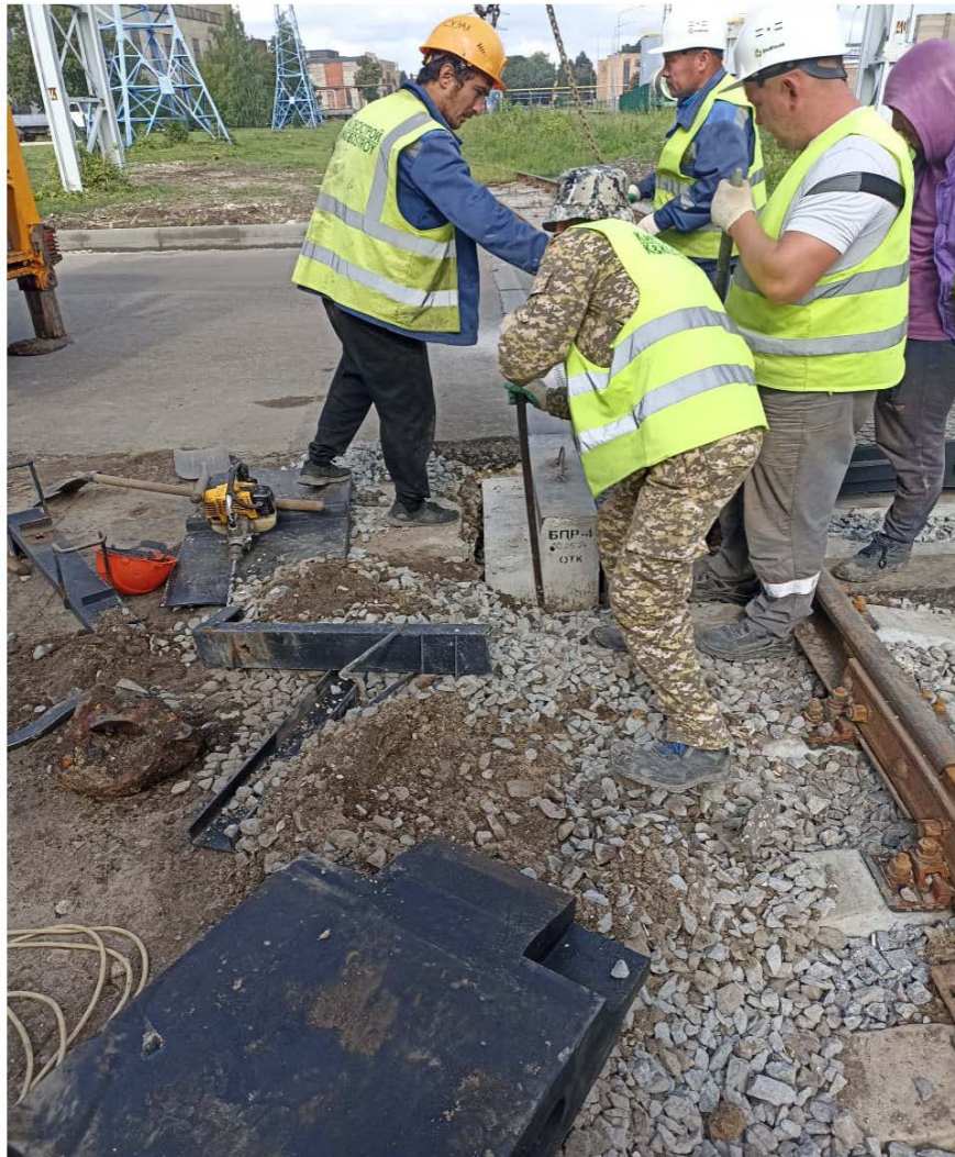
Переустройство резинокордового покрытия переезда №30 до
