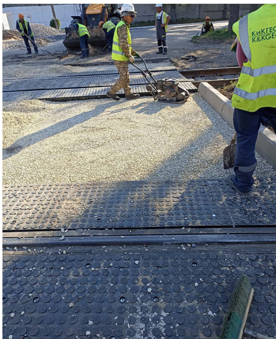
Устройство асфальтового покрытия переездов №8, б/н до
