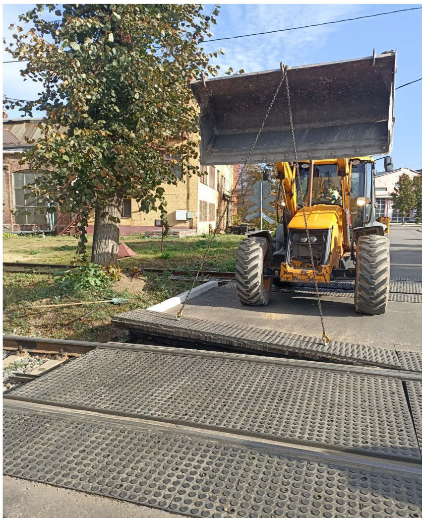
Демонтаж переезда N8 до
