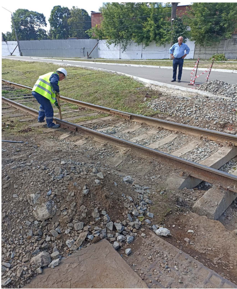
Очистка балласта и ремонт жд. путей №1 и №2 до
