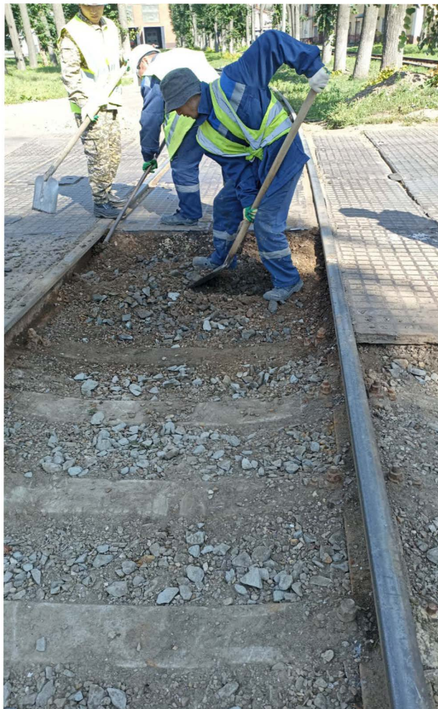
Очистка балласта и ремонт жд. путей №1 и №2 до
