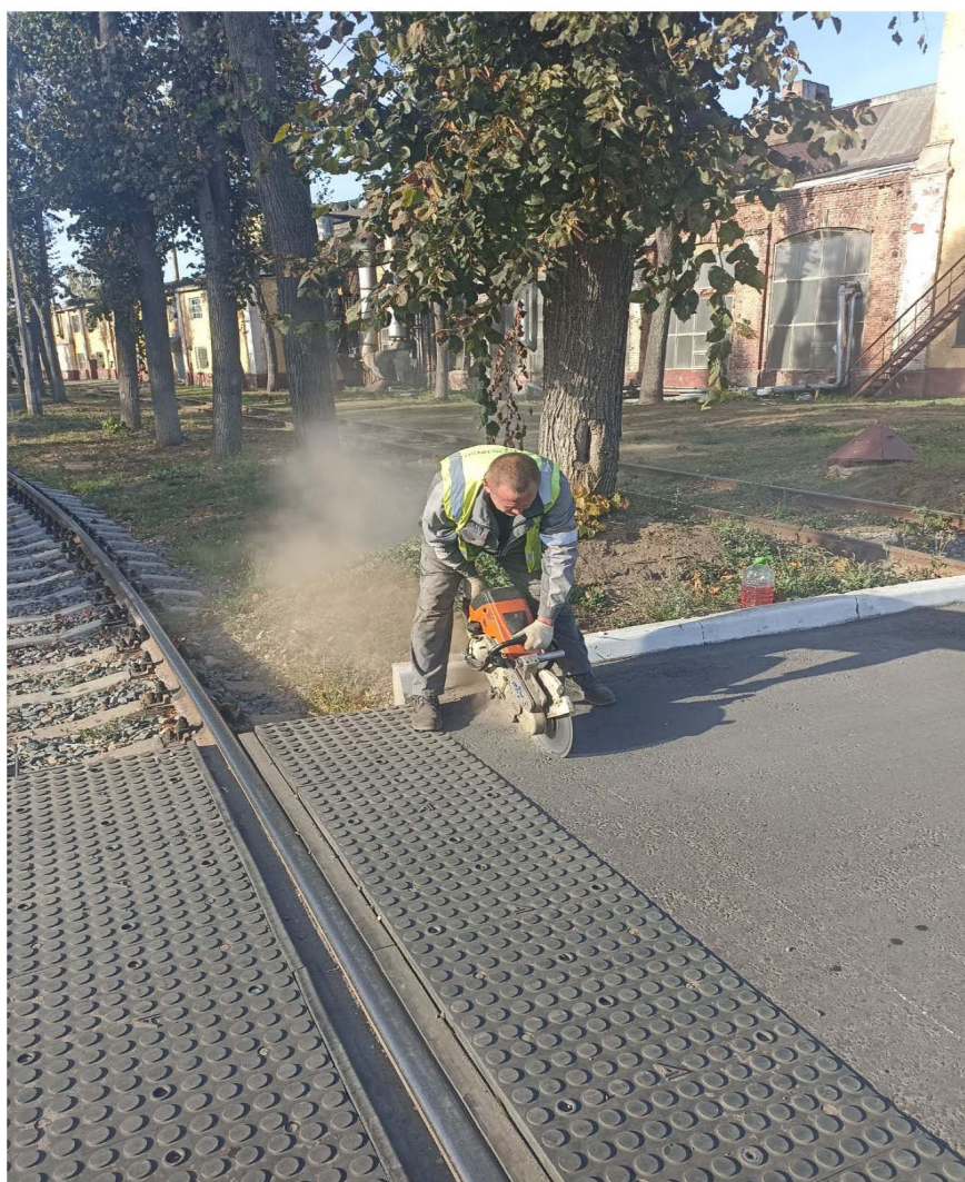
Демонтаж переезда N8 до
