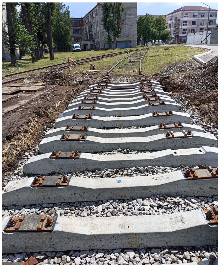
Балластировка, выправка и рихтовка жд. путей №1 и №2 после
