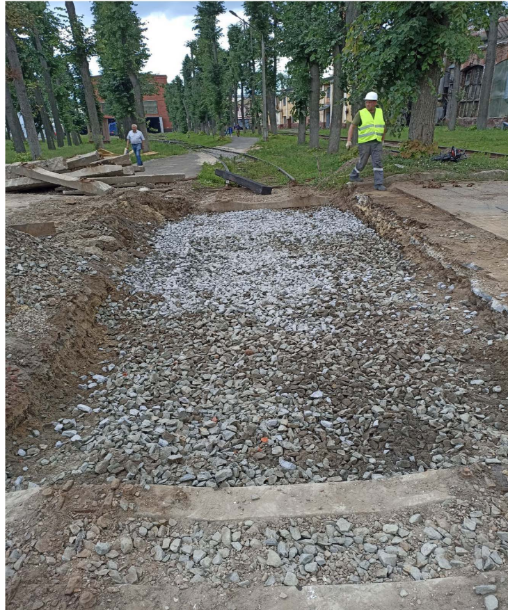
Очистка балласта и ремонт жд. путей №1 и №2 после
