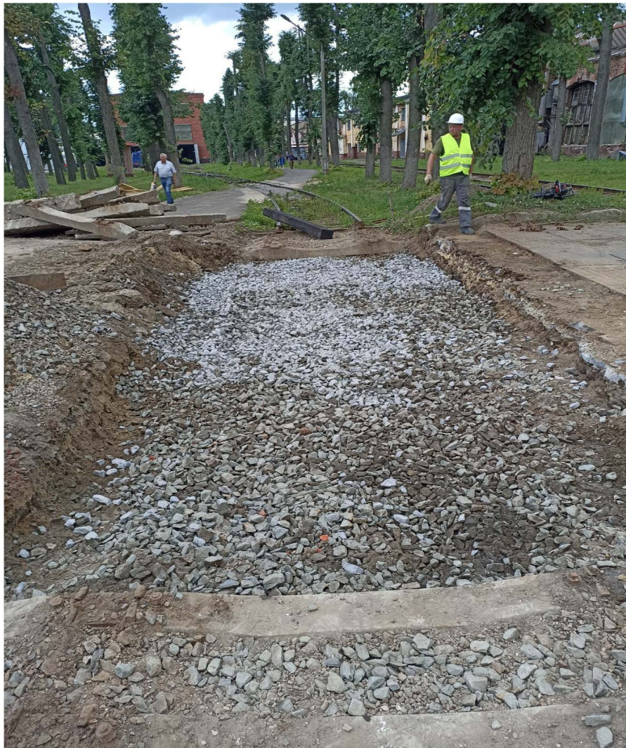
Балластировка, выправка и рихтовка жд. путей №1 и №2 до
