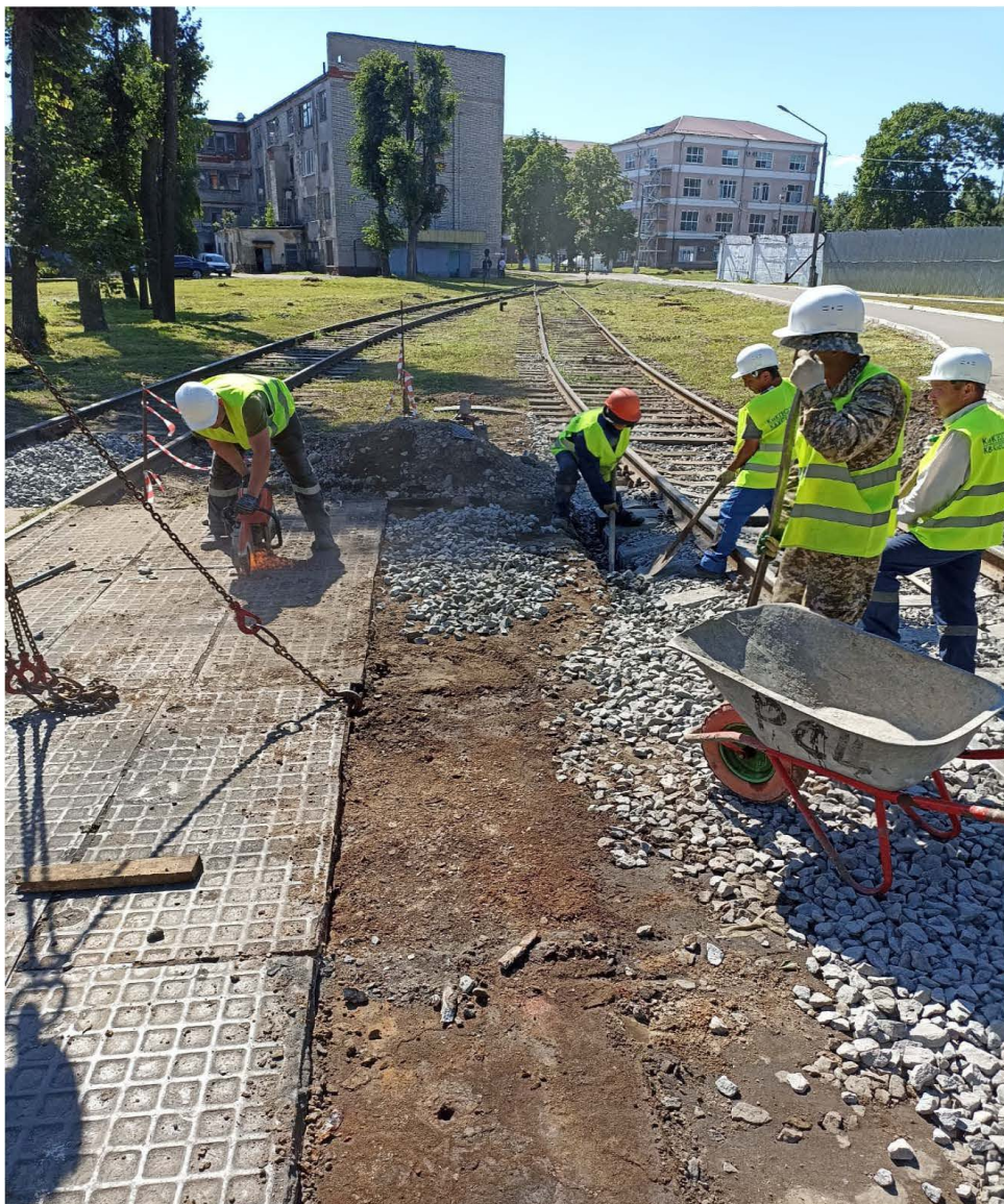
Демонтаж асфальтового покрытия переездов №8, б/н до
