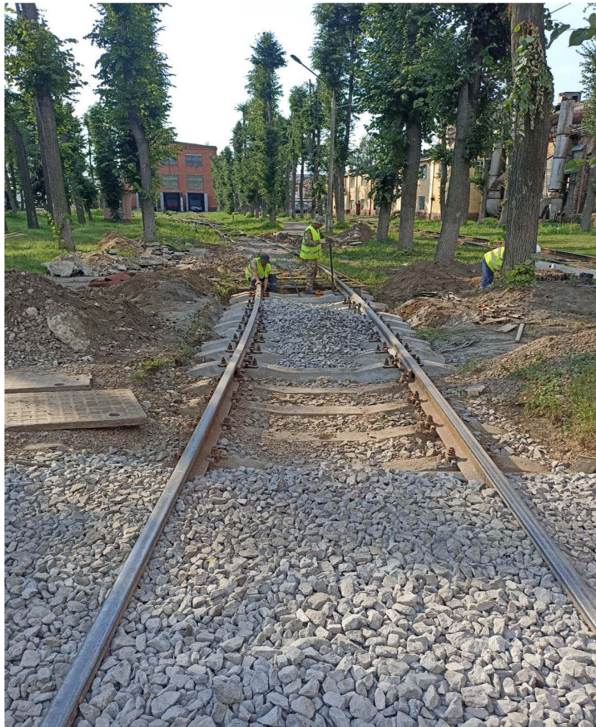
Балластировка, выправка и рихтовка жд. путей №1 и №2 после
