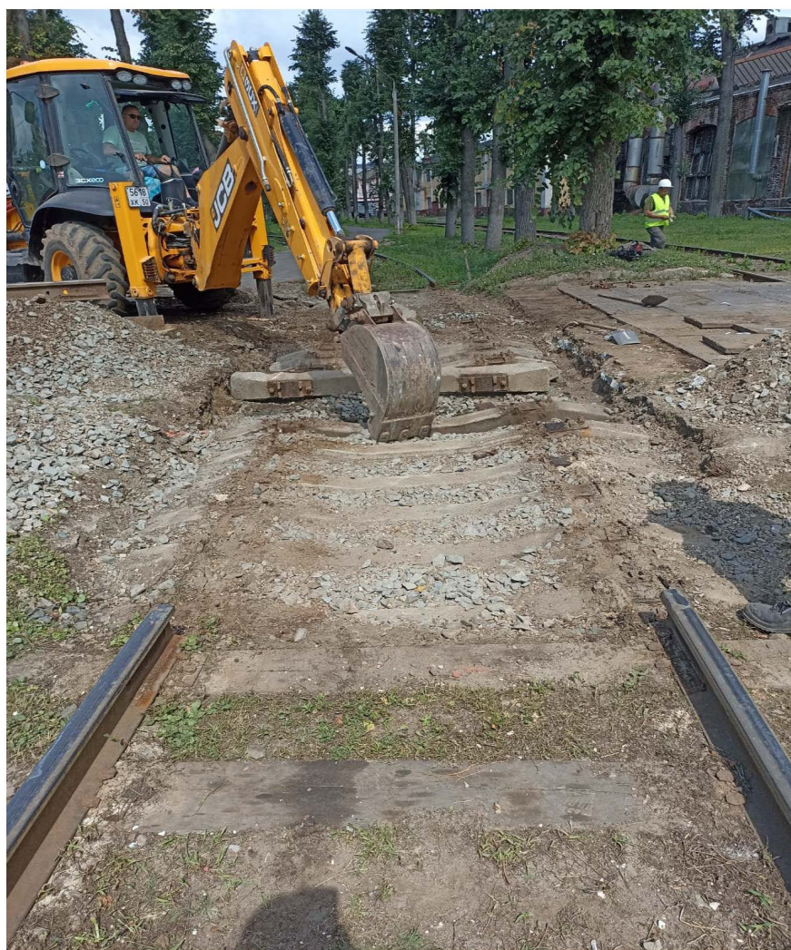
Балластировка, выправка и рихтовка жд. путей №1 и №2 до
