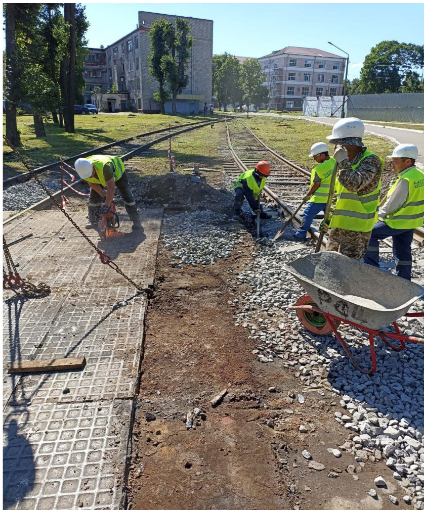
Демонтаж асфальтового покрытия переездов №8, б/н до
