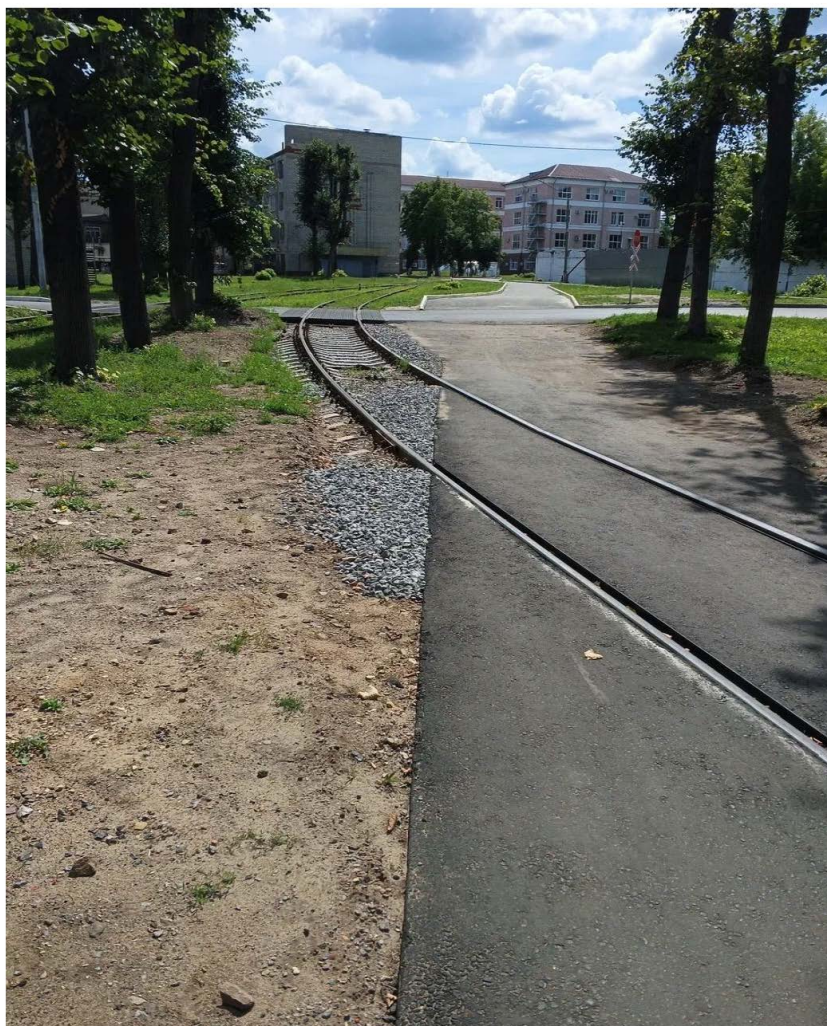
Устройство асфальтового покрытия переездов №8, б/н после
