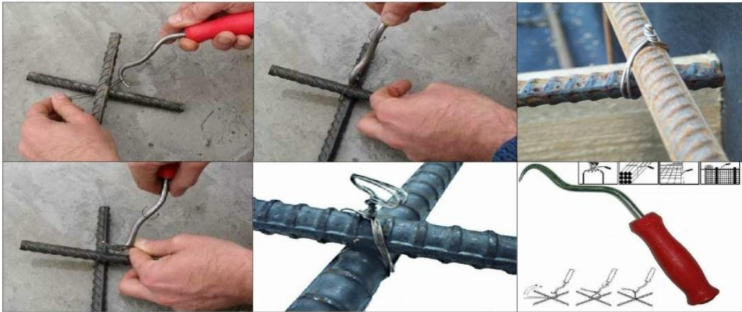
Схема соединения арматурных стержней вязальной проволокой.
