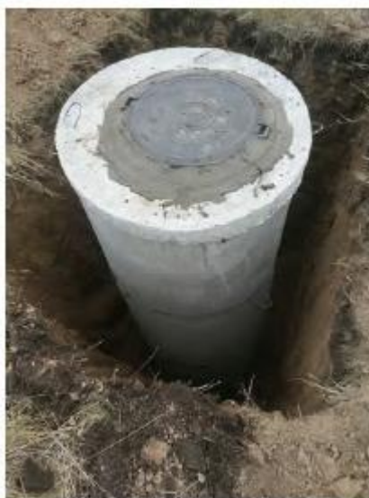
Рис.3. Заделка мест стыков и зазоров
