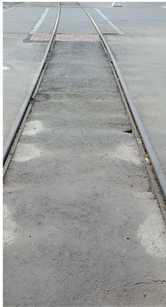
5.Путь №37(въезд в КИО): размыв балласта под асфальтовым покрытием
