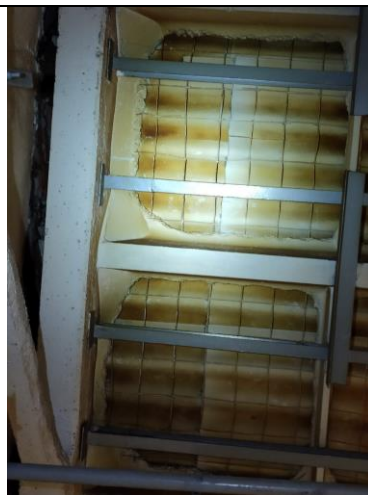
Фото 8. Стальной каркас для усиления плит покрытия в осях А-Г/16-24.
