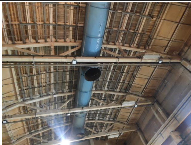
Фото 7. Стальной каркас для усиления плит покрытия в осях А-Г/16-24.
