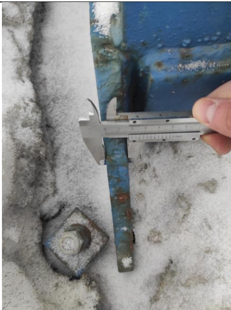
Фото 5. Измерение толщины траверсы (колонна К-1).
