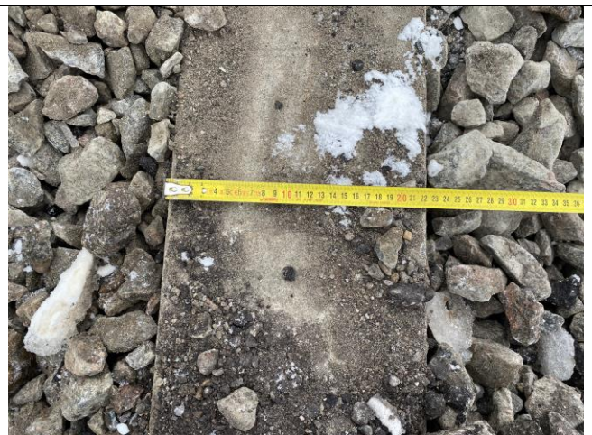
Фото 12. Измерение ширины шпалы (шурф 1)
