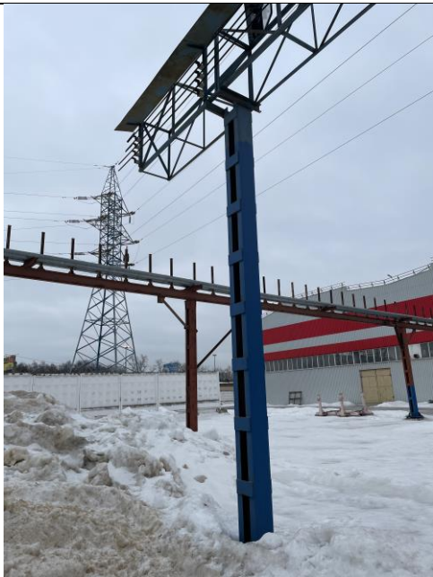
Фото 2. Колонна К-1 в осях Е/2.
