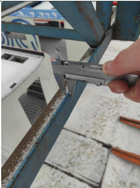
Фото 9. Измерение толщины уголка нижнего пояса фермы.
