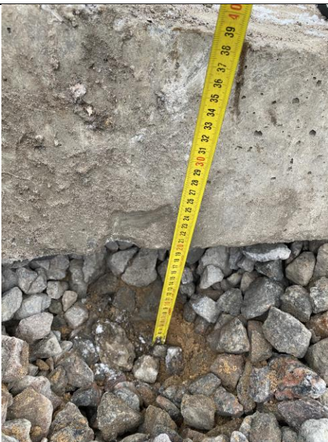
Фото 13. Измерение высоты шпалы и щебе-
