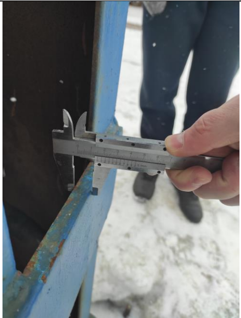
Фото 4. Измерение толщины пластины (колонна К-1).
