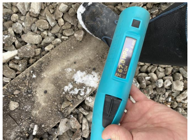
Фото 14. Измерение прочности бетона шпалы
