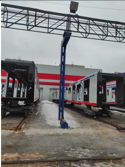
Фото 1. Колонны и пролетные строения трансбордера в осях Г-Ж/1-7.
