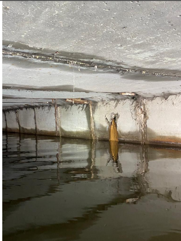
Фото 20. Разрушение защитного слоя бетона стенки звена коллектора, пластинчатая коррозия.
