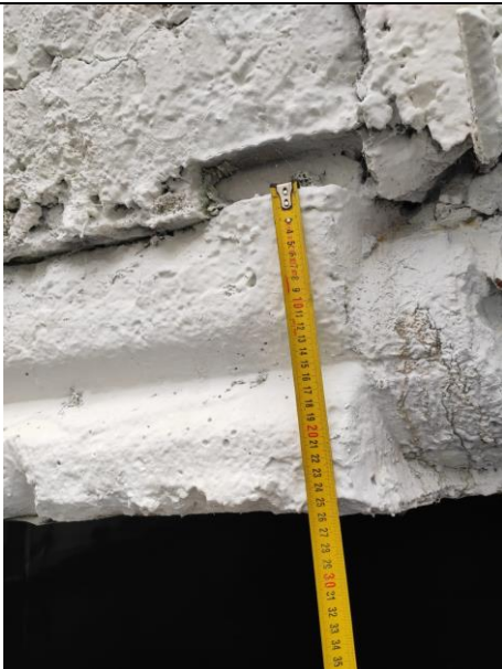
Фото 5. Измерение толщины плиты перекрытия звена коллектора
