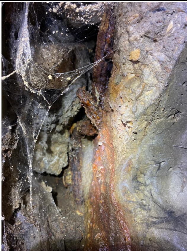
Фото 21. Разрушение защитного слоя бетона стенки звена коллектора. Пластинчатая коррозия арматуры стенки звена коллектора.
