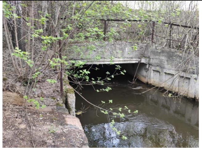
Фото 2. Общий вид оголовочного звена коллектора, расположенного вблизи Ярославского шоссе. Подпорная монолитная ж/б стена.
