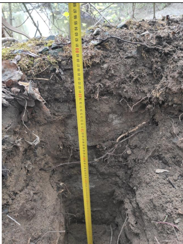
Фото 9. Измерение расстояния от верха подпорной стены до верха плиты перекрытия звена коллектора в шурфе.
