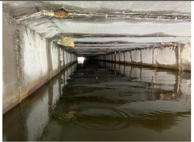
Фото 4. Общий вид внутреннего пространства коллектора.
