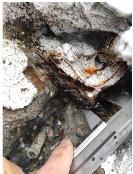
Фото 14. Измерение диаметра поперечной рабочей арматуры верхней сетки плиты перекрытия звена коллектора.
