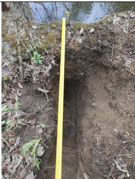
Фото 7. Шурф над звеном коллектора
