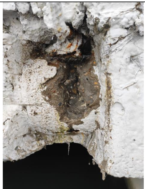
Фото 12. Вскрытие защитного слоя бетона плиты перекрытия для измерения диаметра рабочей арматуры верхней сетки.
