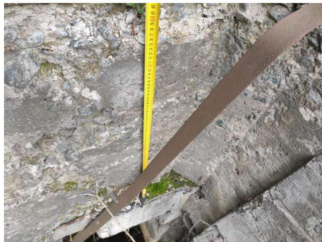
Фото 8. Измерение расстояния от верха подпорной стены до верха плиты перекрытия звена коллектора.
