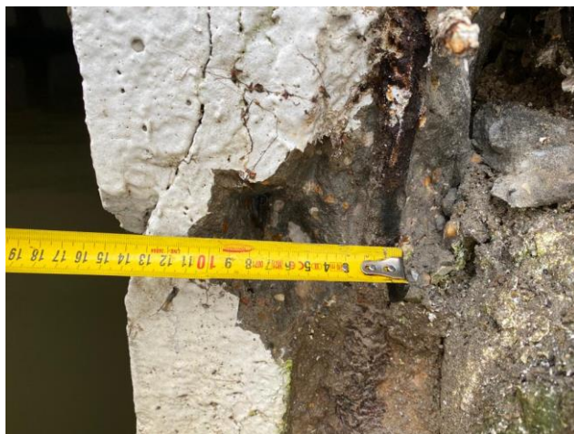
Фото 11. Измерение шага продольной рабочей арматуры нижней сетки плиты перекрытия звена коллектора.
