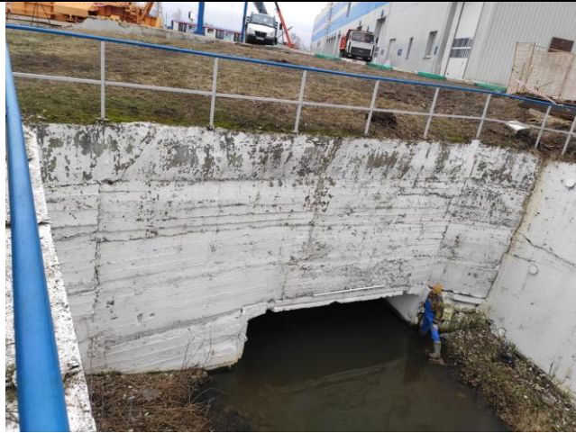
Фото 1. Общий вид оголовочного звена коллектора, расположенного вблизи моста. Подпорная монолитная ж/б стена.
