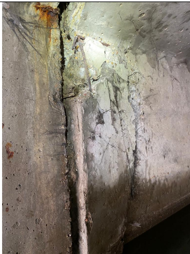
Фото 20. Разрушение защитного слоя бетона стенки звена коллектора, пластинчатая коррозия.
