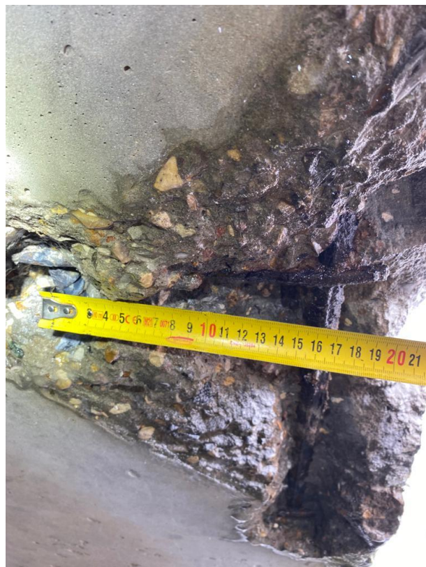
Фото 10. Измерение шага поперечной рабочей арматуры нижней сетки плиты перекрытия звена коллектора.
