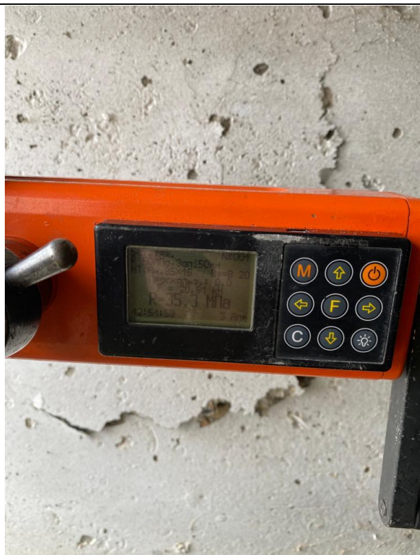
Фото 17. Определение прочности стенки звена коллектора бетона методом отрыва со скалыванием.
