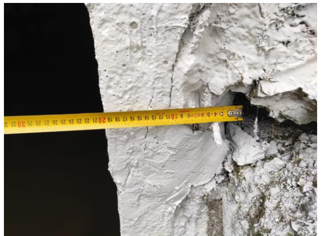
Фото 6. Измерение толщины стенки звена коллектора
