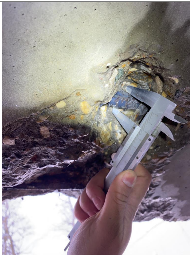
Фото 15. Измерение диаметра поперечной рабочей арматуры нижней сетки плиты перекрытия звена коллектора.
