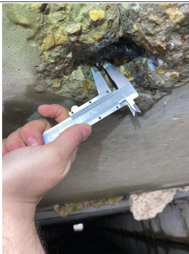
Фото 16. Измерение диаметра продольной рабочей арматуры верхней сетки плиты перекрытия звена коллектора.
