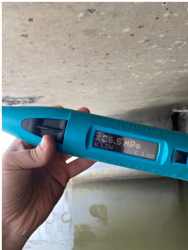
Фото 19. Определение прочности бетона плиты перекрытия звена коллектора методом ударного импульса.
