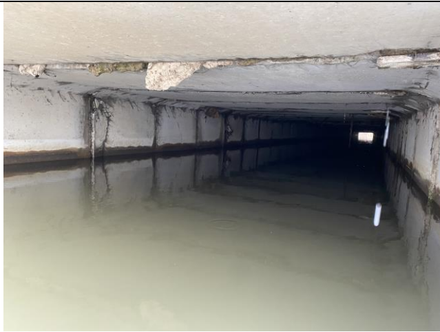
Фото 3. Общий вид внутреннего пространства коллектора.
