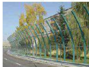
Рис. 3. Строительно-технические мероприятия по защите от шума
