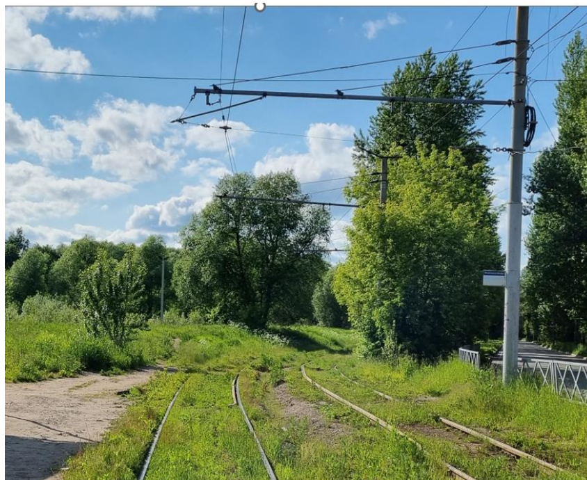
Рис. 2.2 – Трамвайная контактная сеть.
