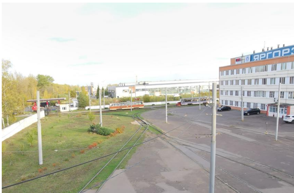
Рисунок 7. Главный бытовой корпус
