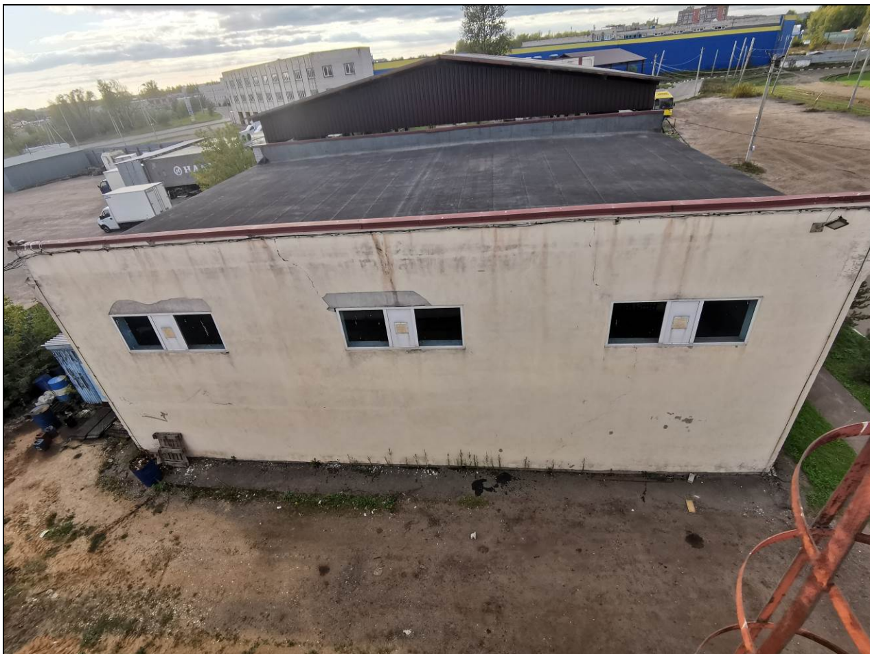
Фото 1. Общий вид литера Л со стороны фасада по оси 1
