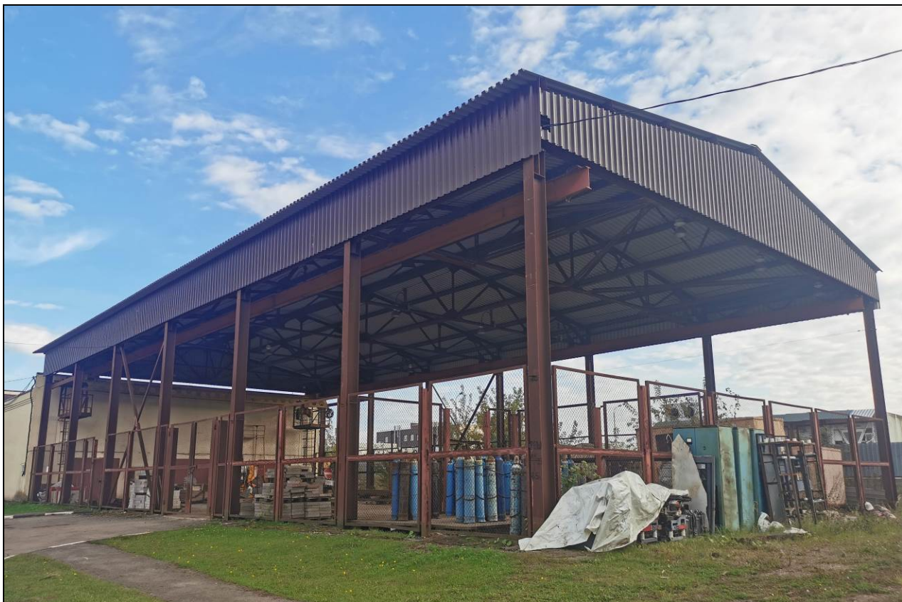
Фото 6. Общий вид литера Л1 со стороны фасадов по осям А, 9
