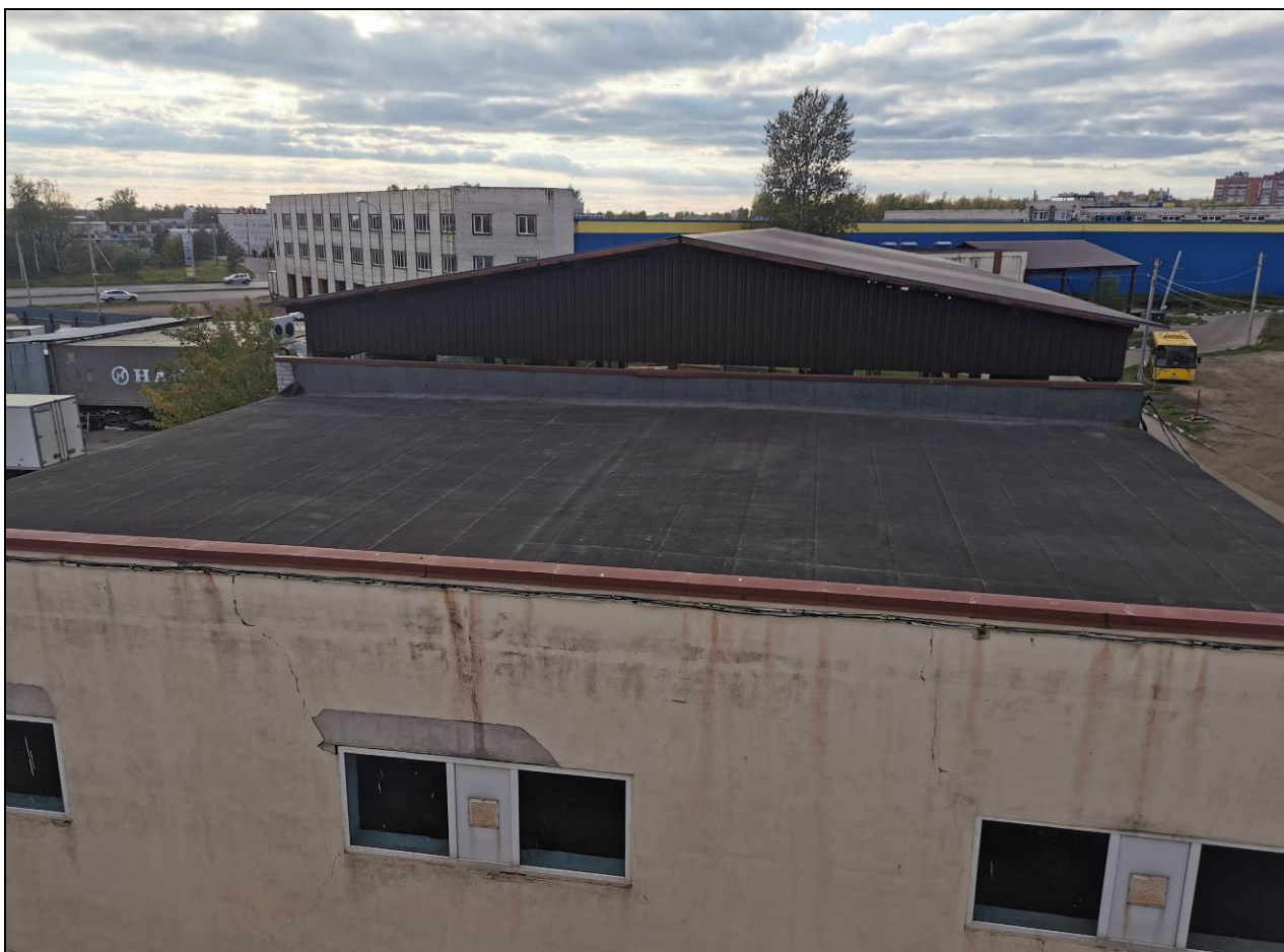
Фото 4. Литер Л. Общий вид кровли
