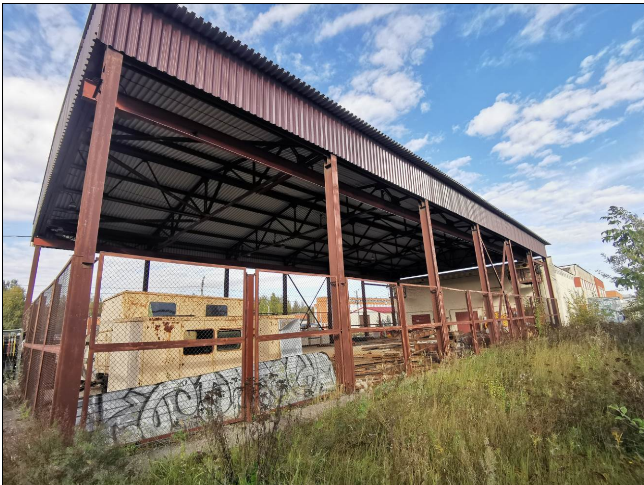
Фото 5. Общий вид литера Л1 со стороны фасада по оси Б
