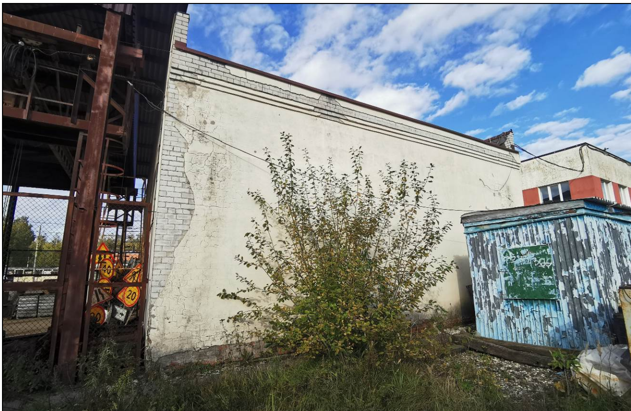
Фото 2. Общий вид литера Л со стороны фасада по оси Б
