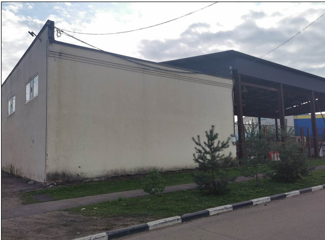
Фото 3. Общий вид литера Л со стороны фасада по оси А
