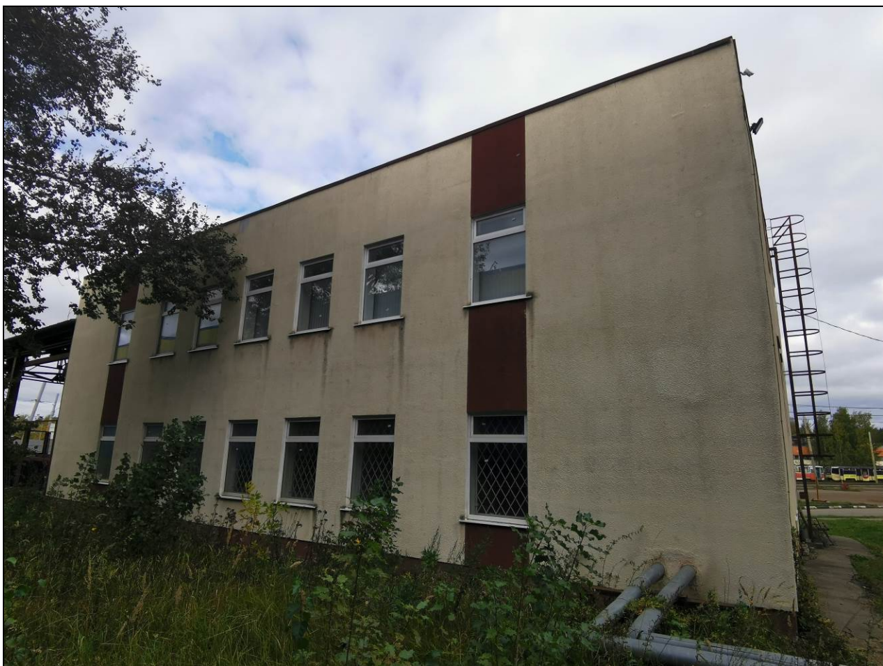
Фото 2. Общий вид литера М со стороны фасада по оси Б
