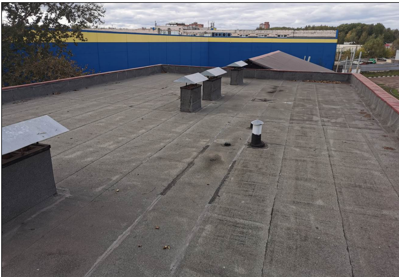
Фото 7. Литер М. Общий вид кровли
