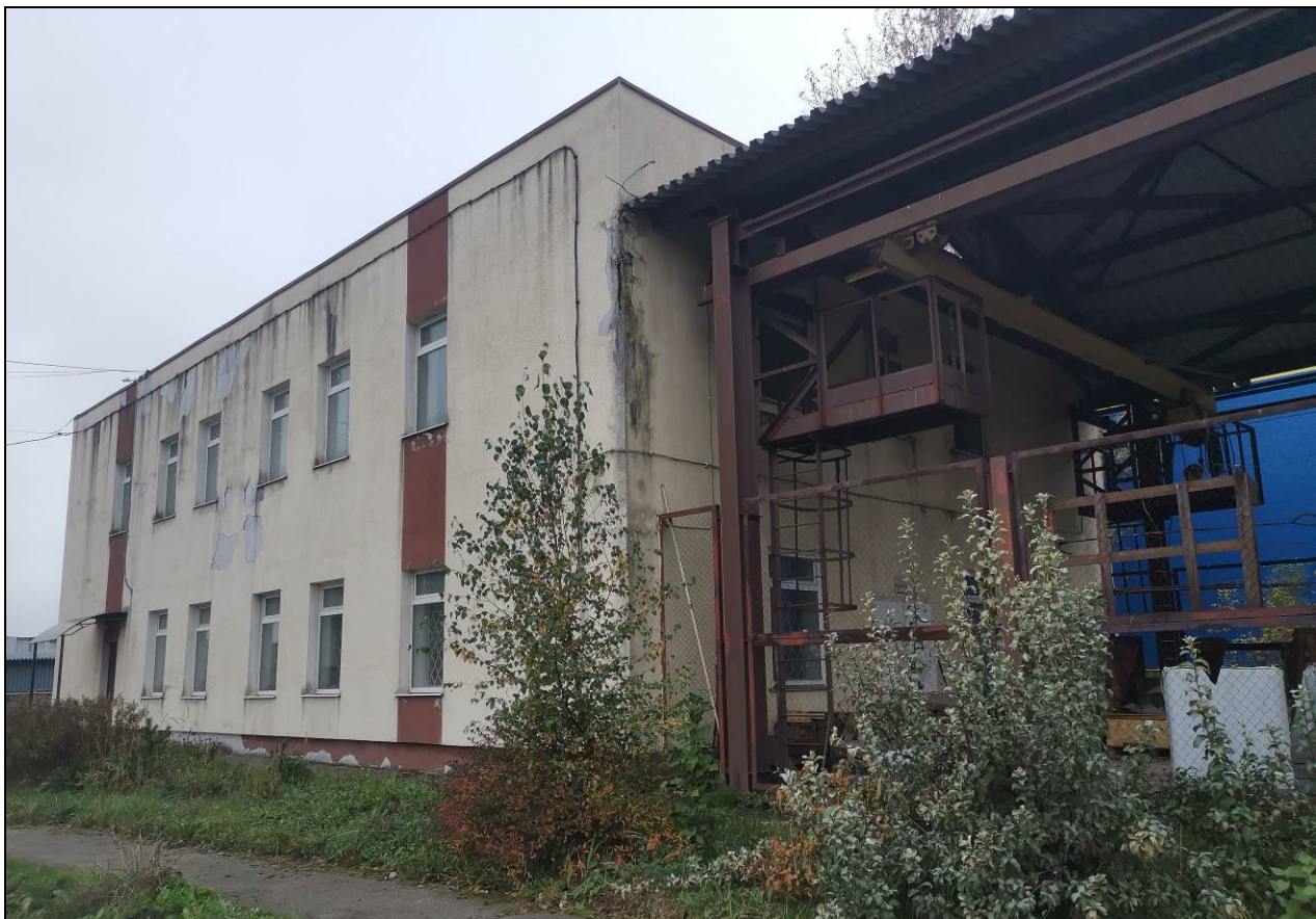
Фото 3. Общий вид литера М со стороны фасадов по осям А, 2
