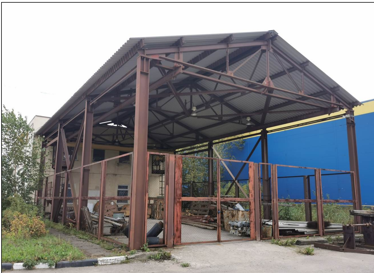
Фото 6. Общий вид литера М1 со стороны фасадов по осям А, 6
