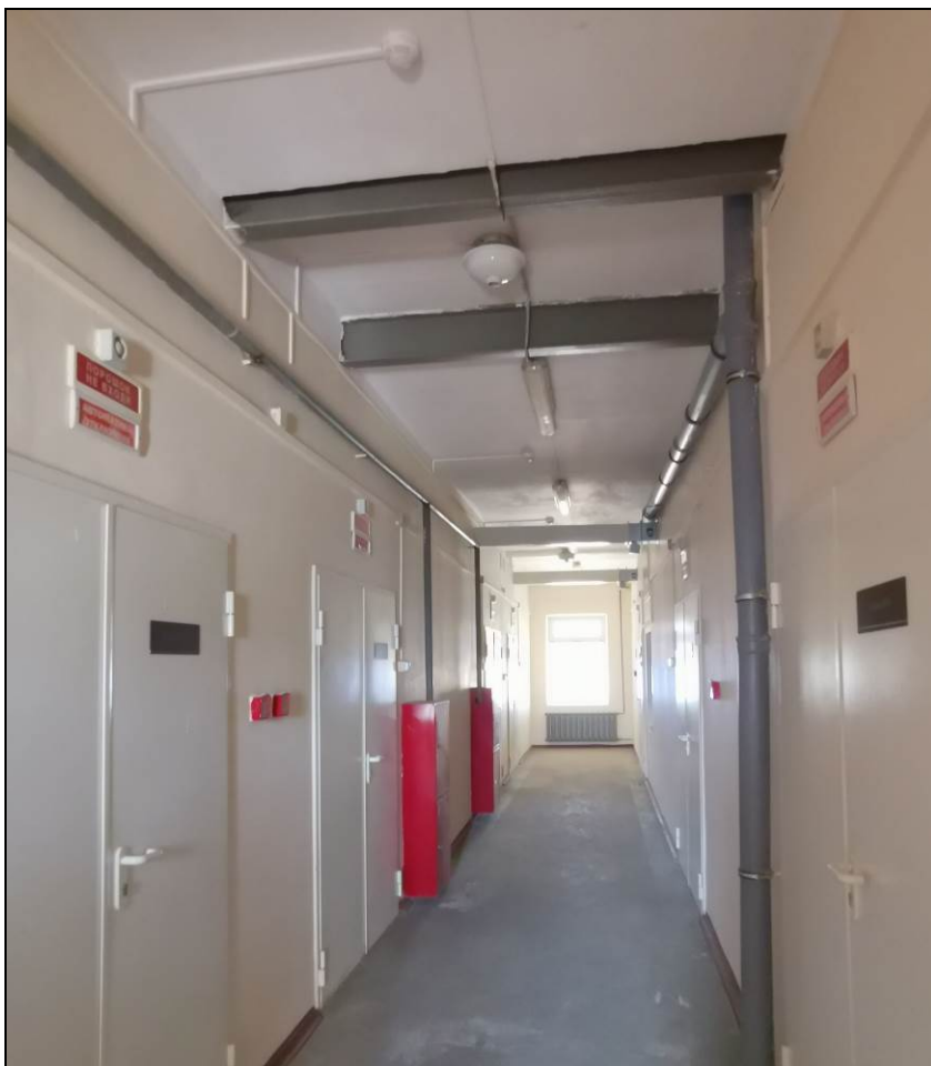
Фото 4. Вид помещений литера М
