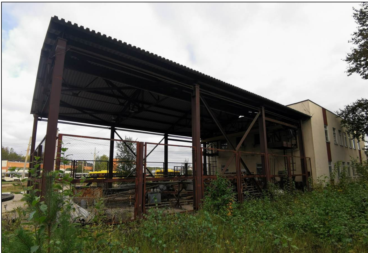
Фото 5. Общий вид литера М1 со стороны фасада по оси Б
