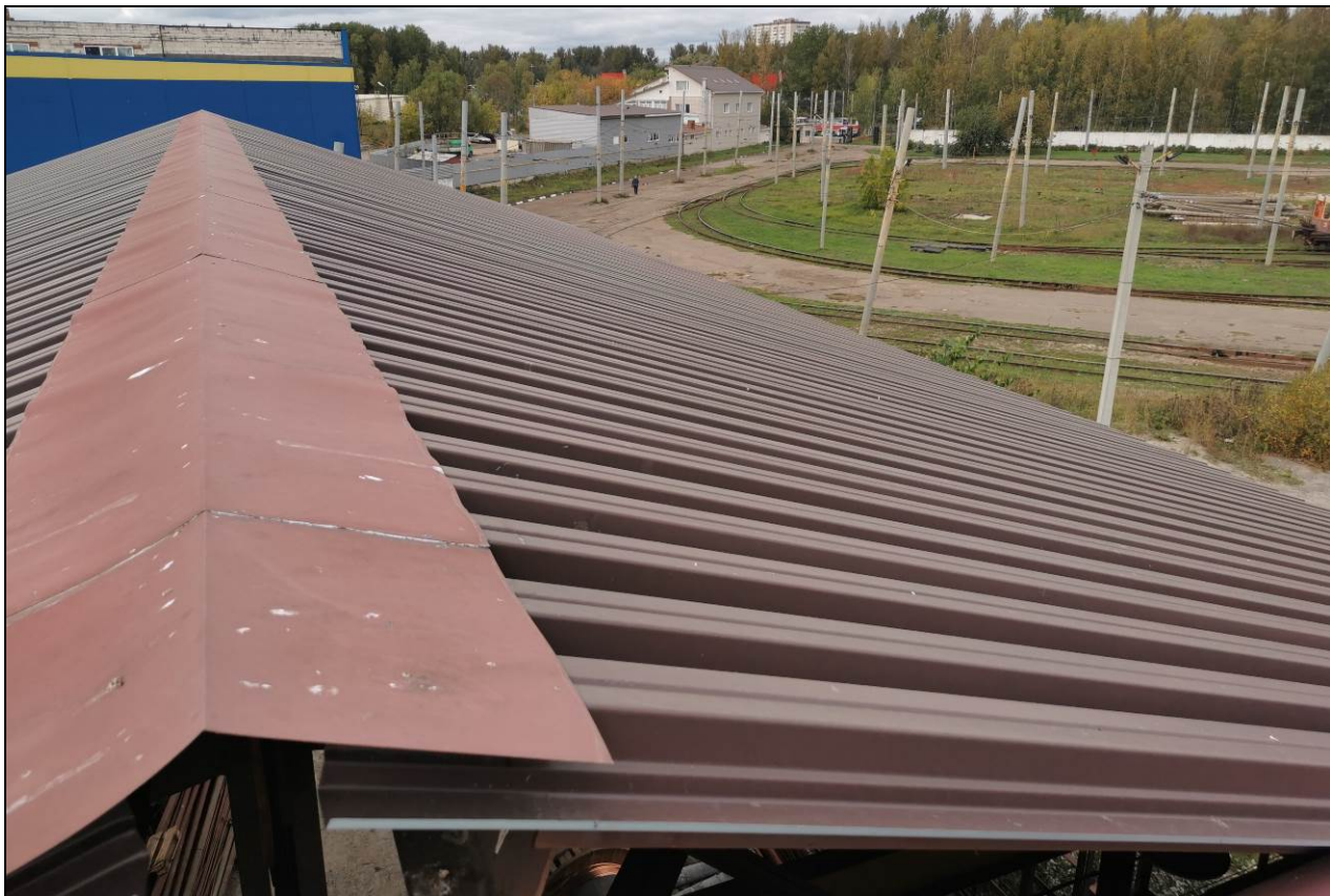
Фото 21. Литер М1. Общий вид кровли
