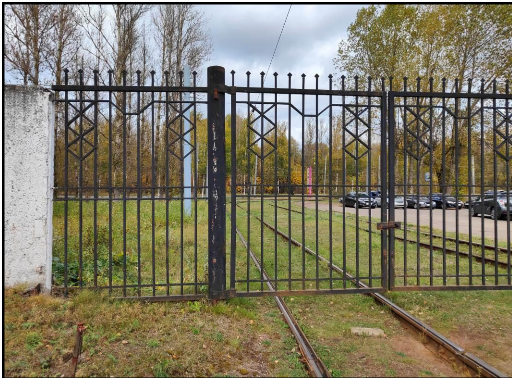
Фото 1. Общий вид металлического ограждения
