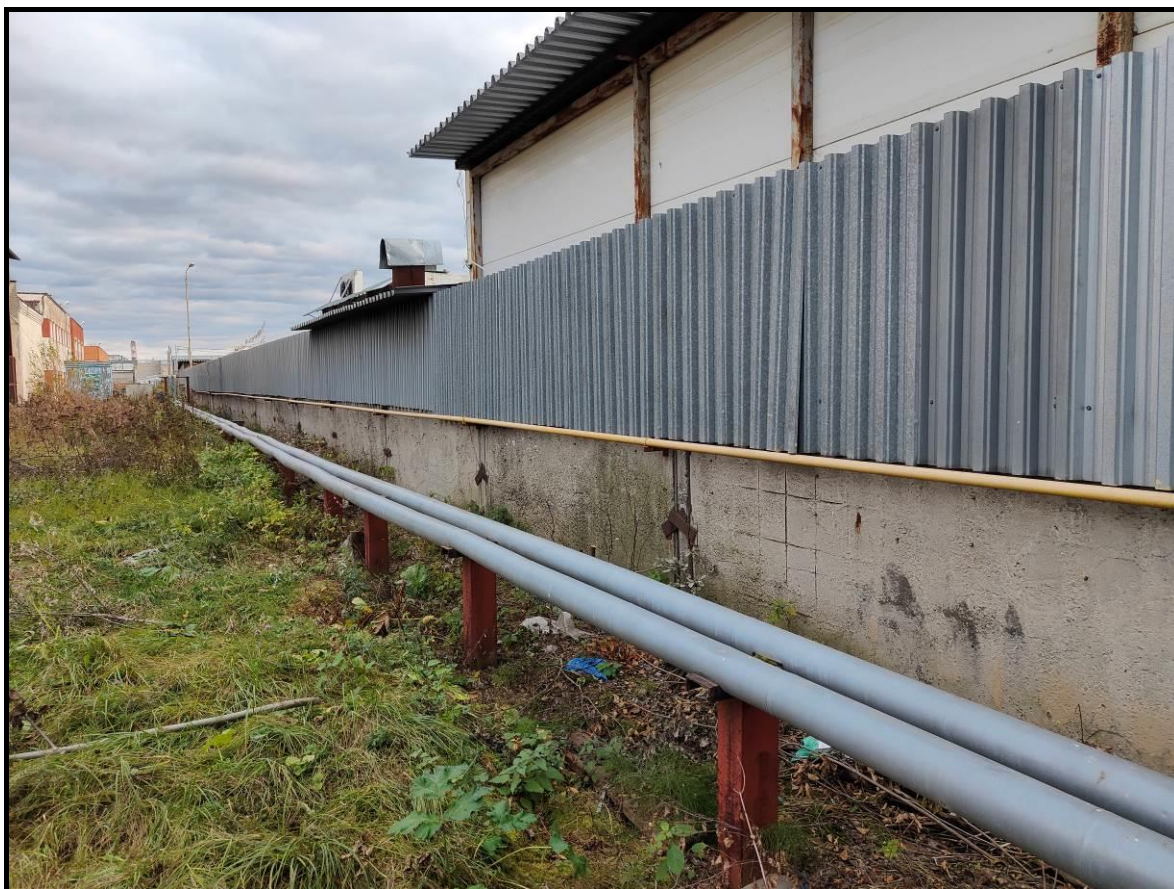
Фото 6. Общий вид железобетонного ограждения с профлистом
