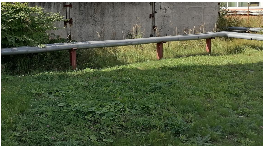
Фото 9. Общий вид опор тепловых сетей
