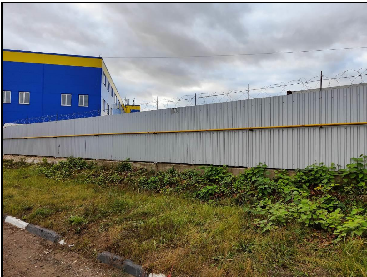
Фото 3. Общий вид металлического ограждения
