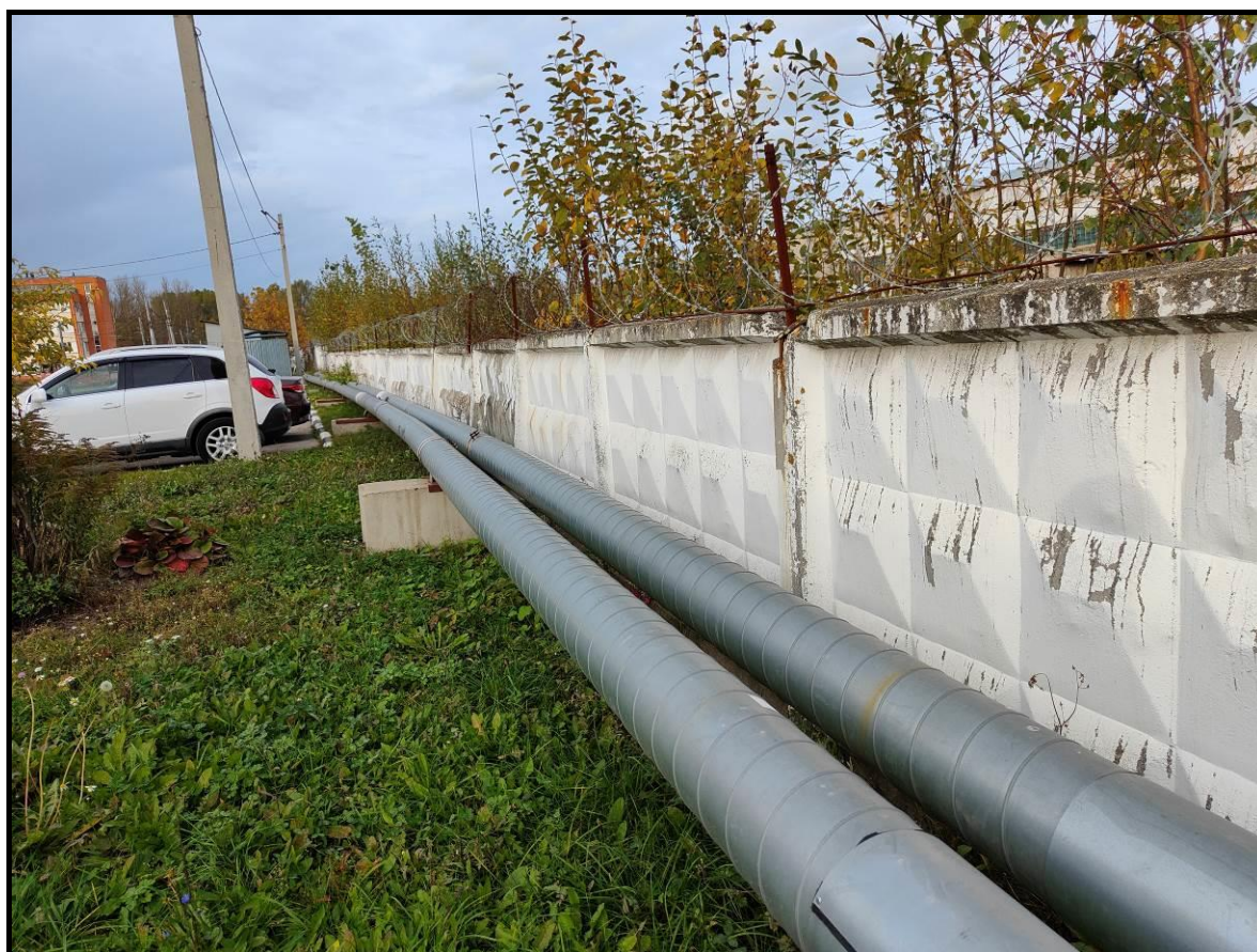
Фото 8. Общий вид железобетонного ограждения с колючей проволокой
