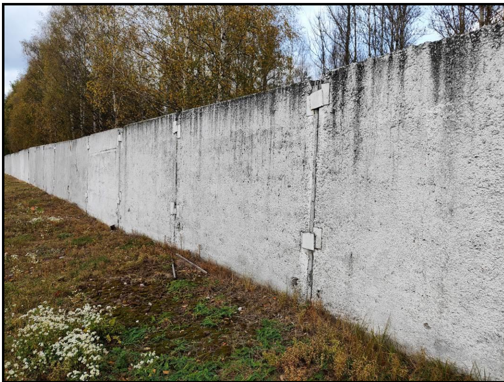
Фото 2. Общий вид железобетонного ограждения
