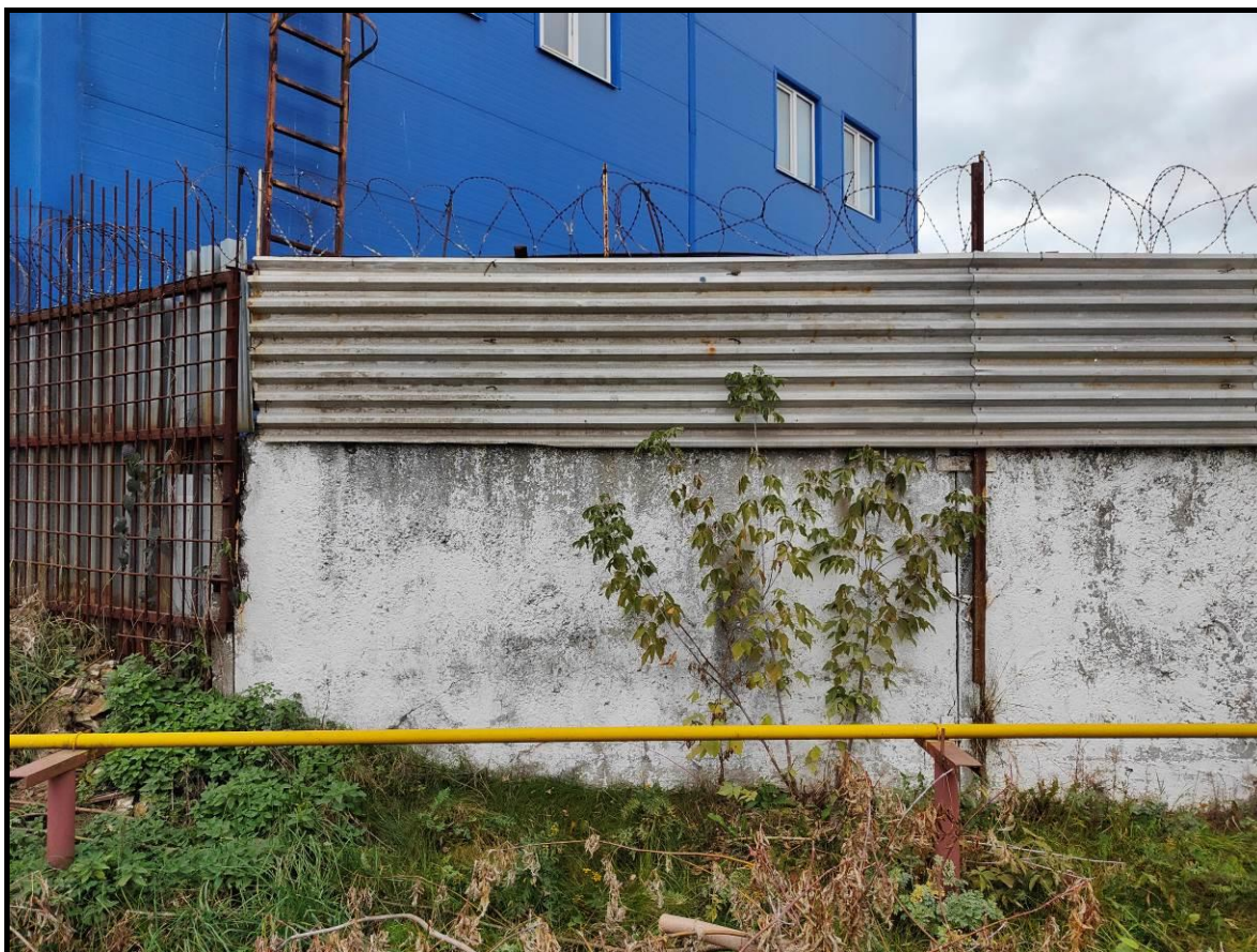
Фото 4. Общий вид железобетонного ограждения с профлистом
