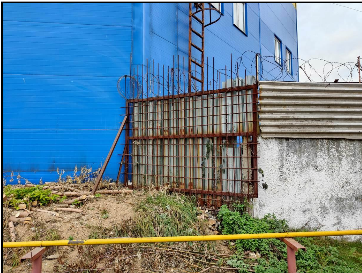
Фото 5. Общий вид металлического ограждения
