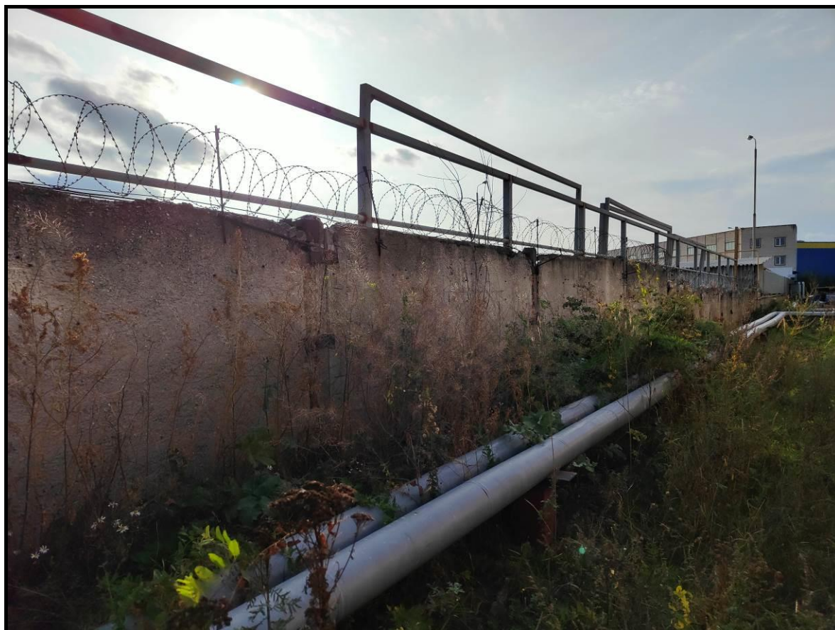
Фото 7. Общий вид железобетонного ограждения с колючей проволокой
