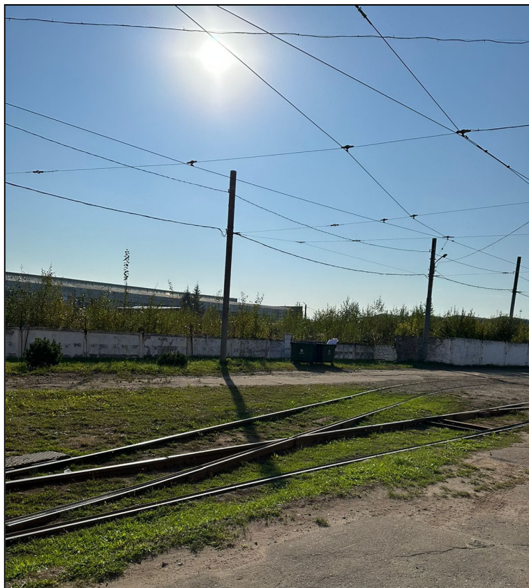
Фото 3. Общий вид трамвайного пути и контактной сети на территории депо
