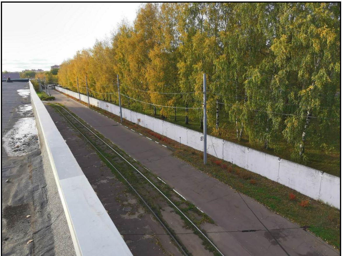
Фото 10. Общий вид трамвайного пути и контактной сети на территории депо
