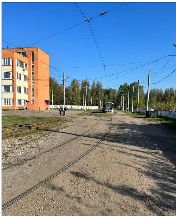
Фото 4. Общий вид трамвайного пути и контактной сети на территории депо
