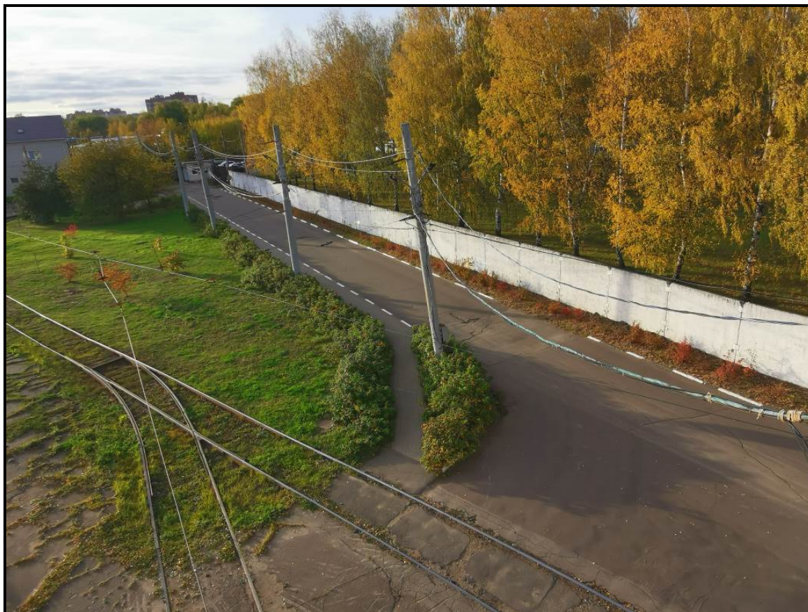
Фото 11. Общий вид трамвайного пути и контактной сети на территории депо
