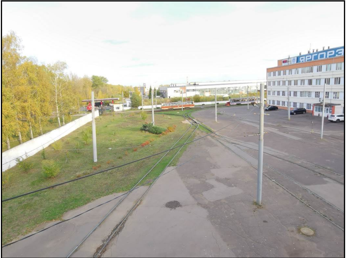
Фото 9. Общий вид трамвайного пути и контактной сети на территории депо
