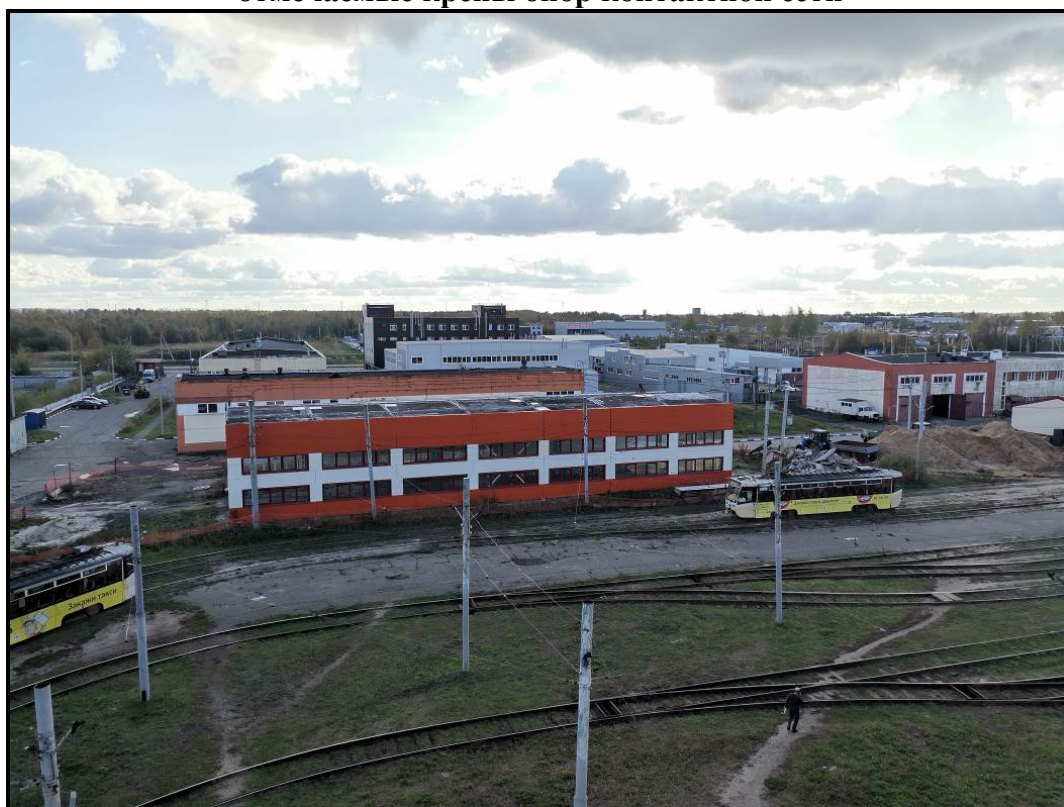
Фото 6. Общий вид трамвайного пути и контактной сети на территории депо
