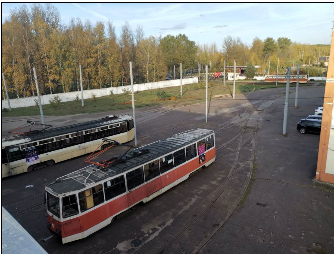
Фото 8. Общий вид трамвайного пути и контактной сети на территории депо
