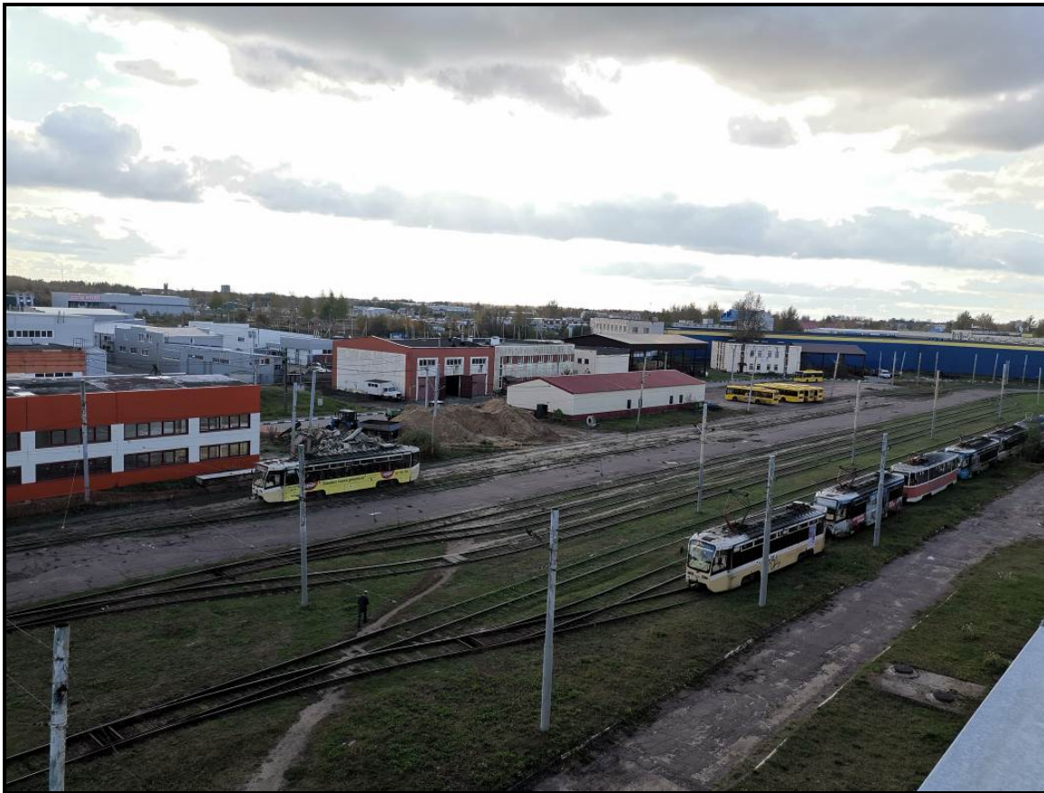
Фото 7. Общий вид трамвайного пути и контактной сети на территории депо
