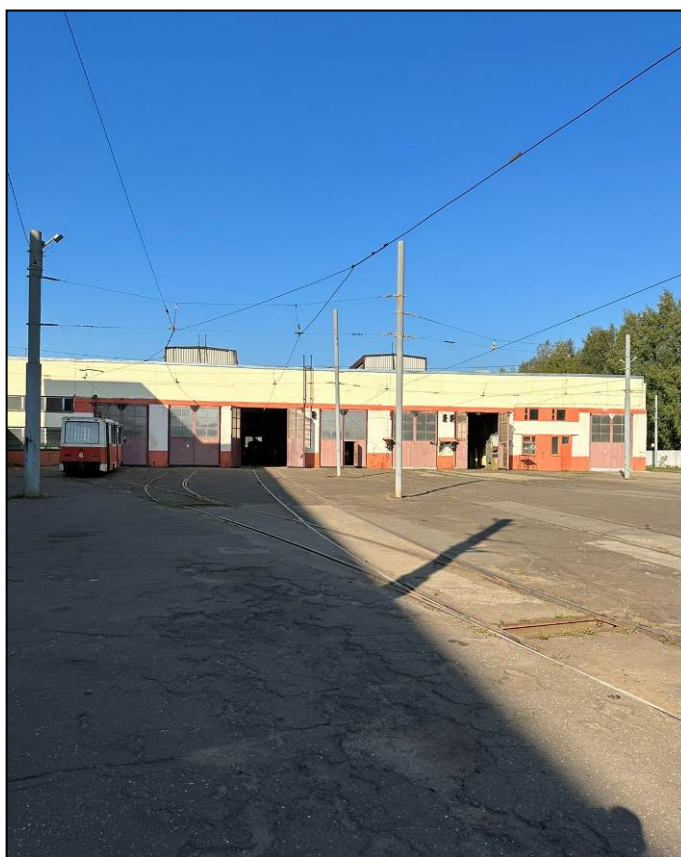
Фото 2. Общий вид трамвайного пути и контактной сети на территории депо
