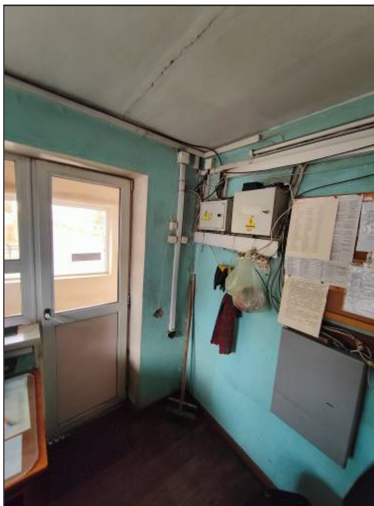
Фото 1.4. Общий вид внутреннего помещения здания
