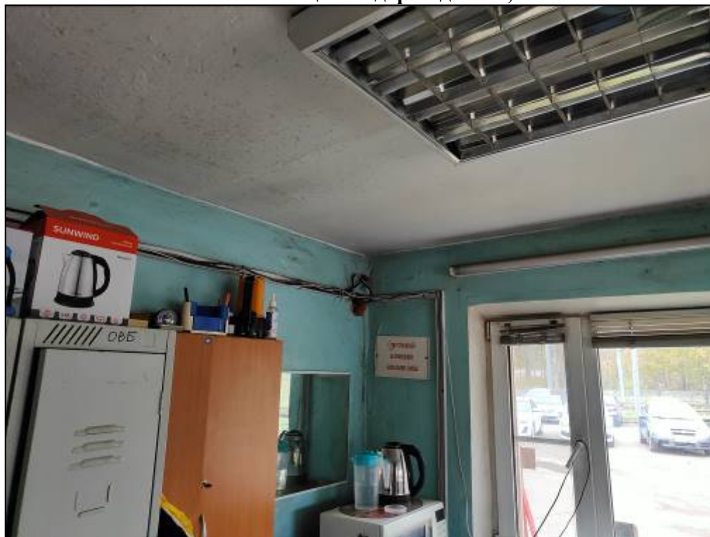
Фото 1.3. Общий вид внутреннего помещения здания
