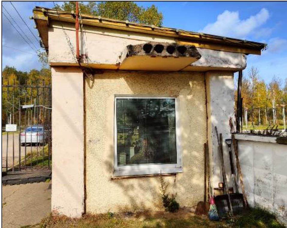
Фото 2.1. Общий вид фасада 1-2
