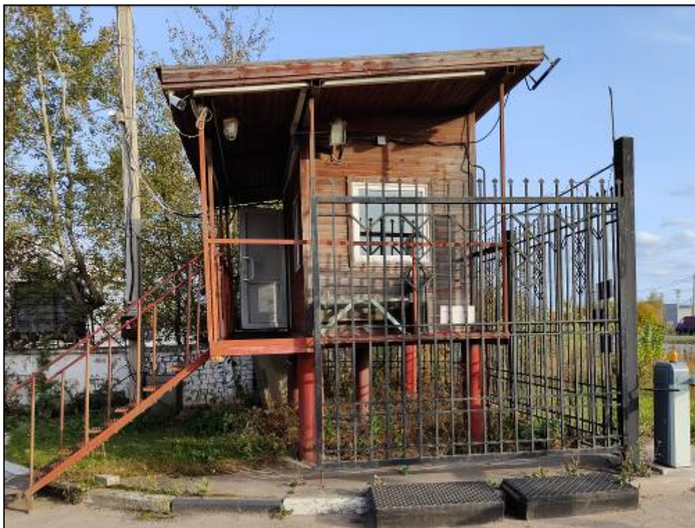
Фото 3.1 Общий вид фасада А-Б
