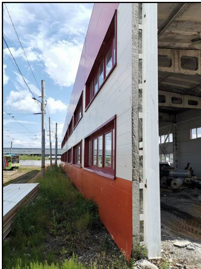
Фото 6.2.1. Общий вид панелей фасадов
