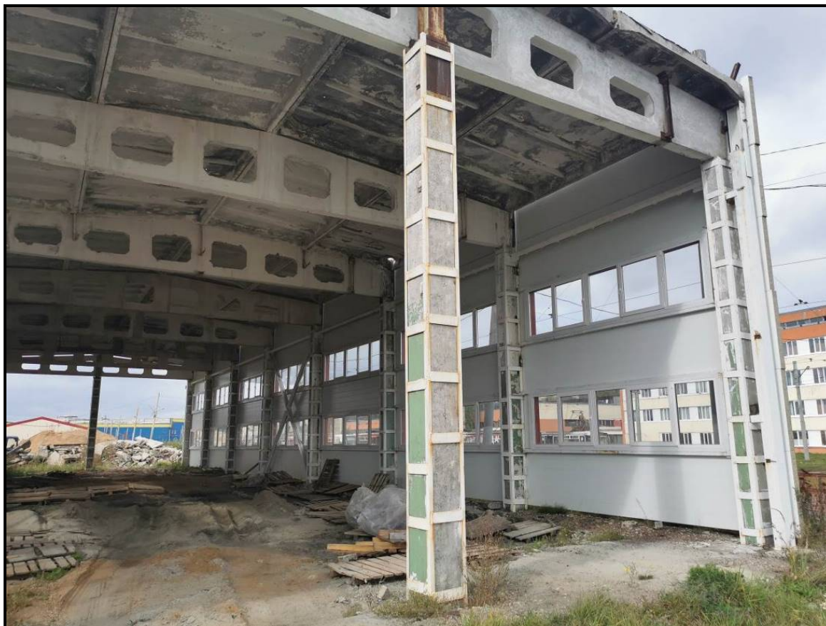
Фото 6.3.2. Общий вид фахверковой колонны
