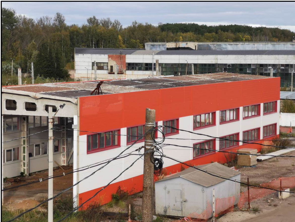
Фото 3. Общий вид здания. Фасад 1-8
