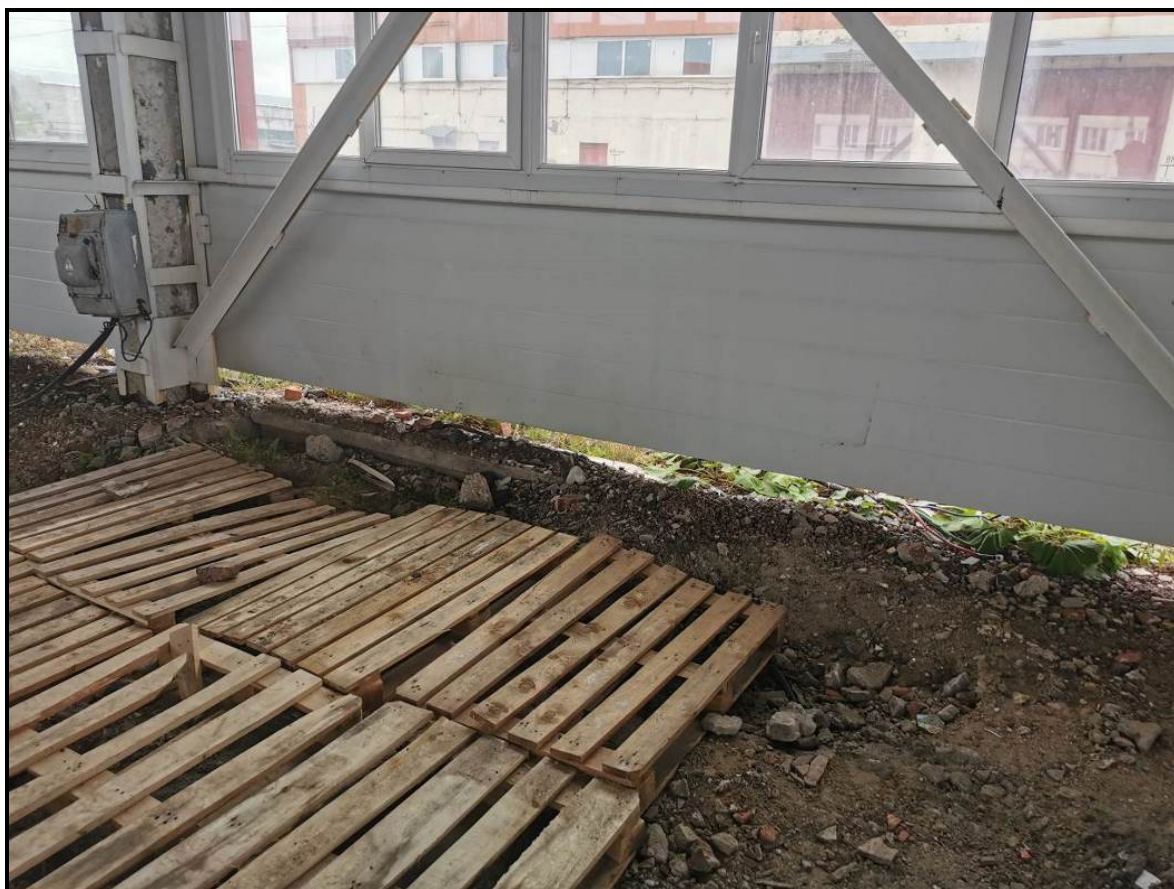
Фото 6.2.4. Общий вид панелей фасадов
