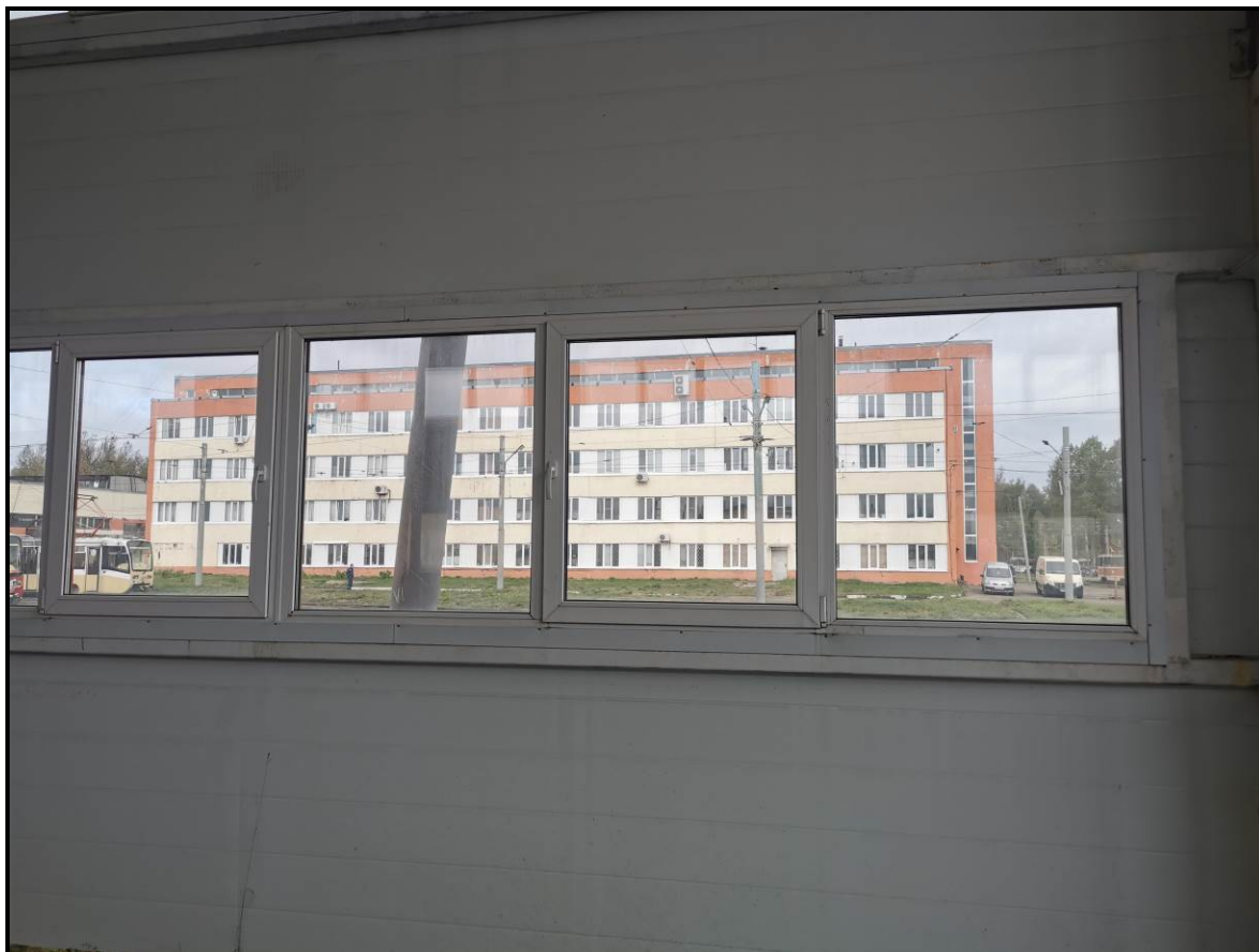
Фото 6.2.3. Общий вид панелей фасадов
