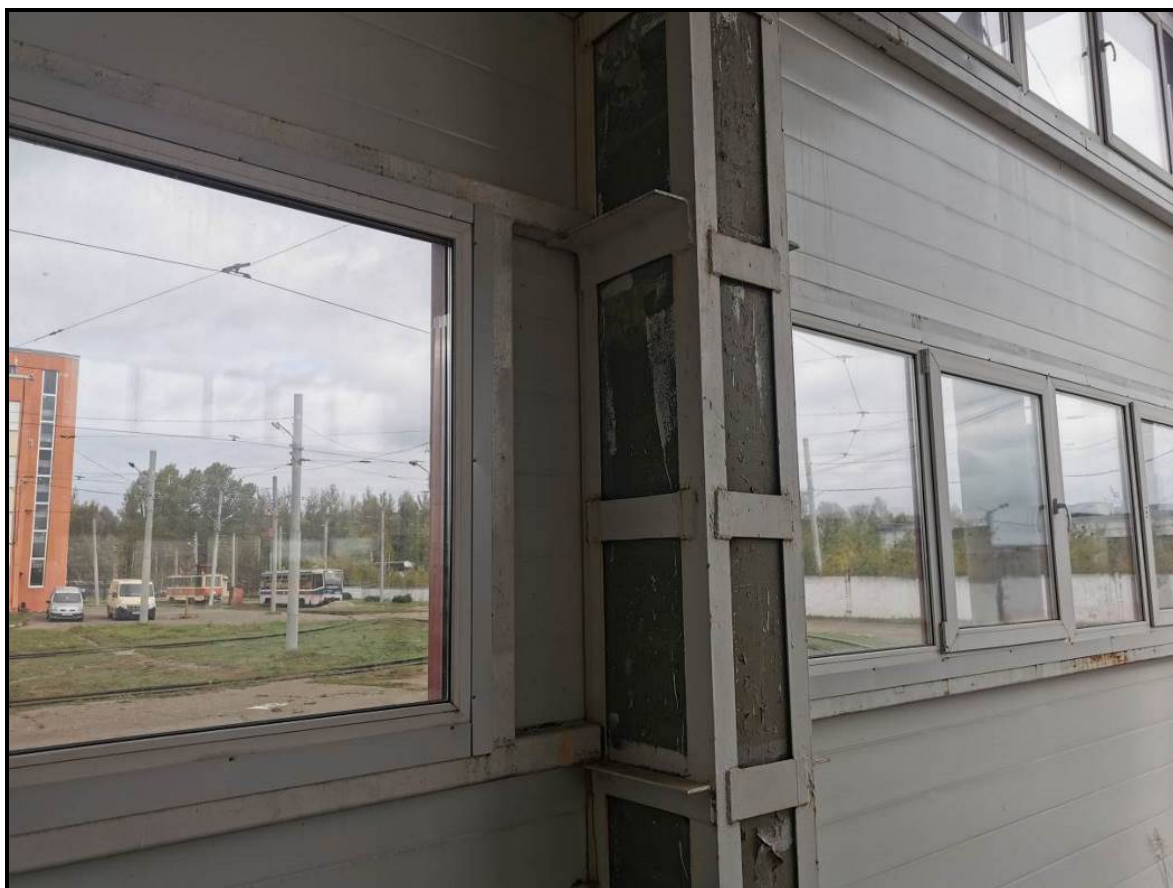
Фото 6.3.1. Общий вид колонны
