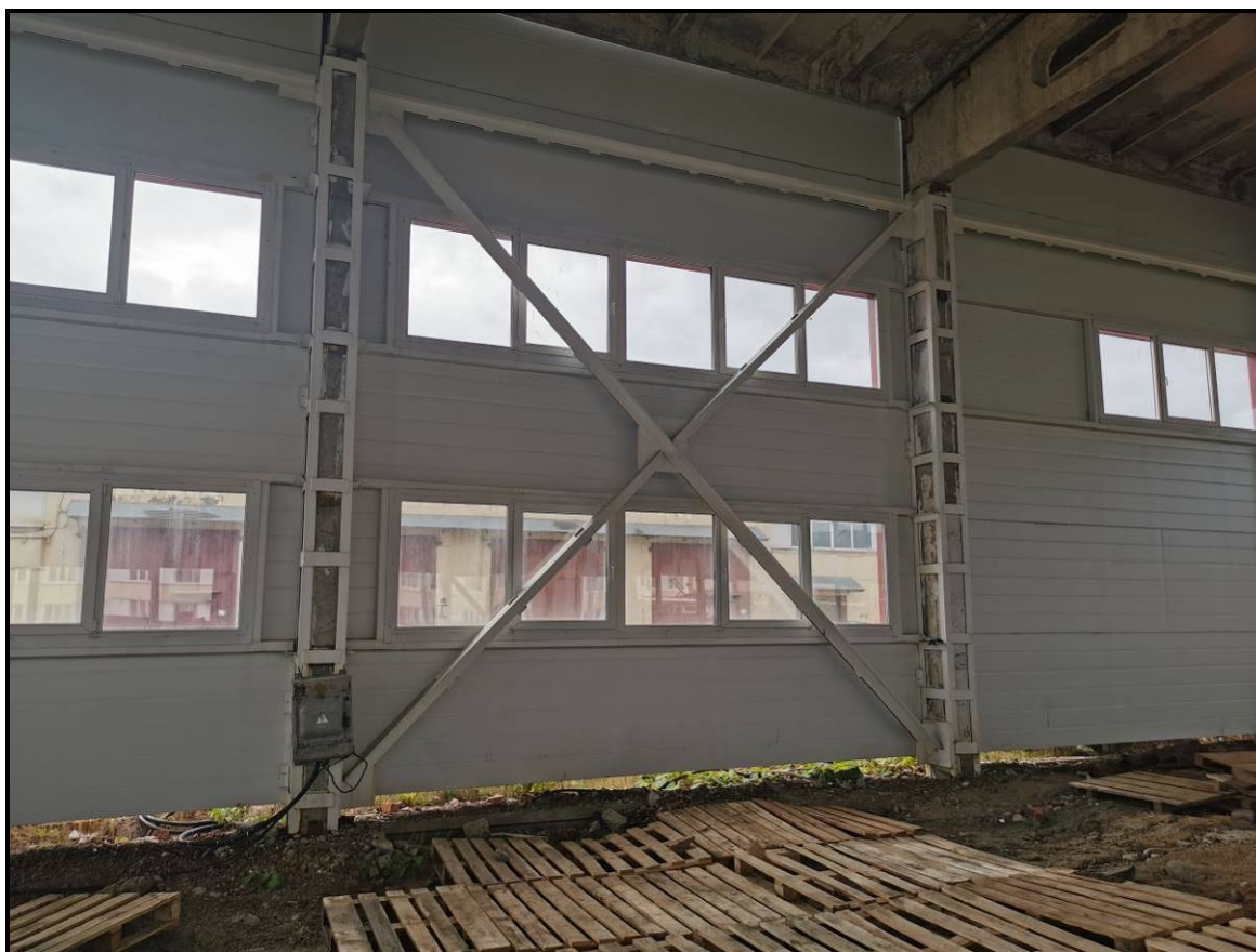
Фото 6.3.3. Общий вид вертикальной связи
