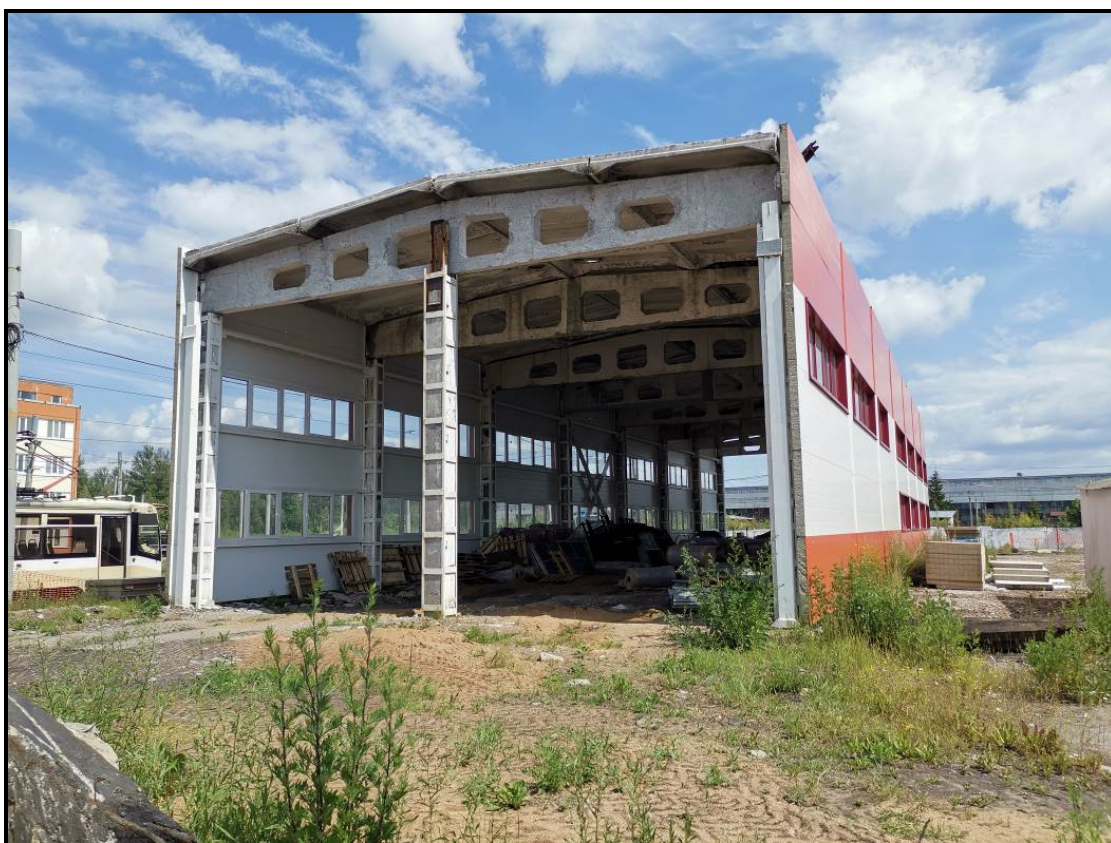
Фото 2. Общий вид здания. Фасад В-А
