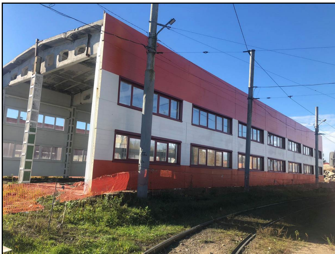
Фото 4. Общий вид здания. Фасад 8-1
