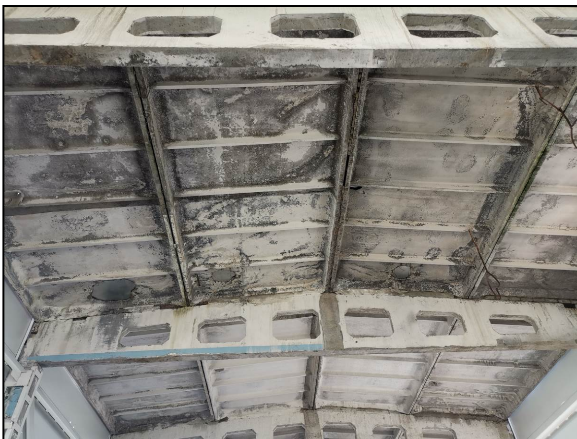
Фото 6.4.3. Общий вид плит покрытия
