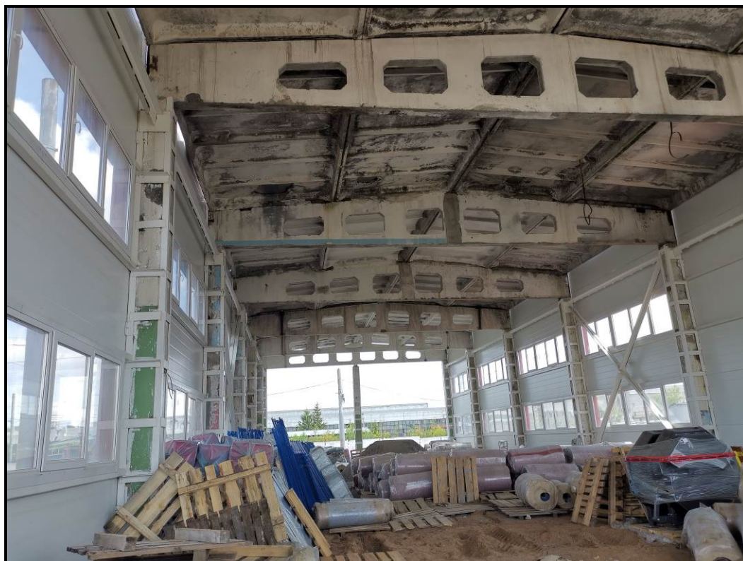
Фото 6.4.1. Общий вид балок покрытия
