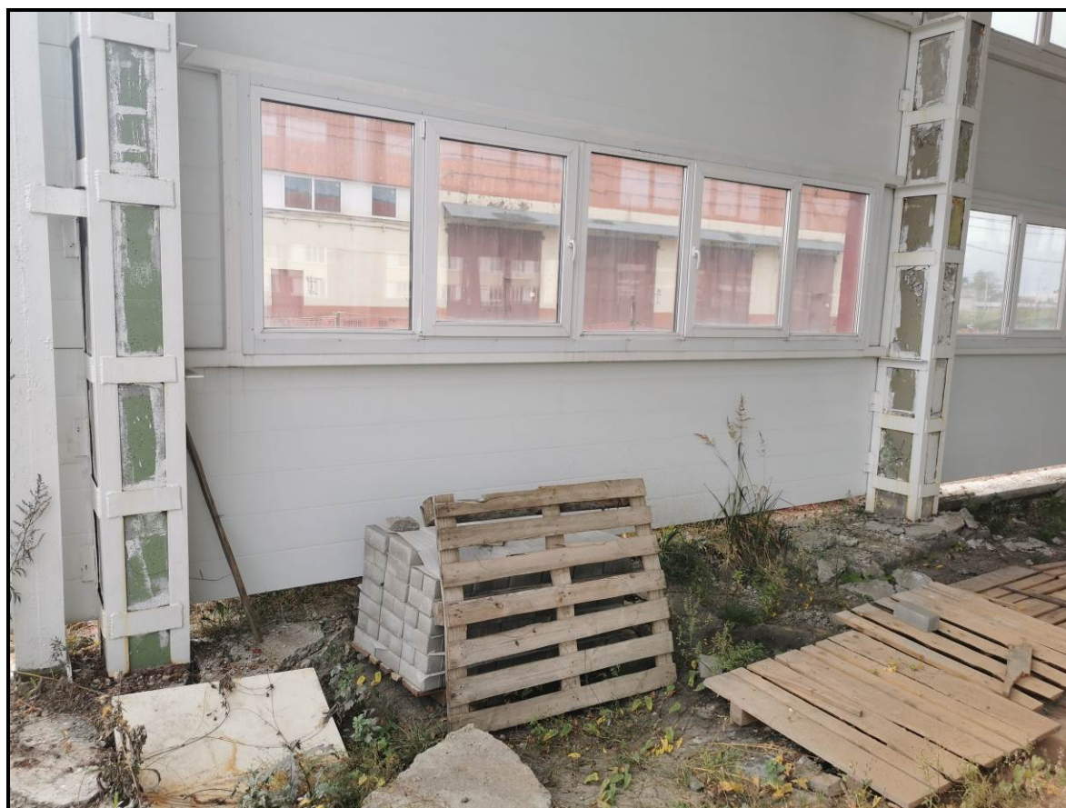
Фото 6.2.2. Общий вид панелей фасадов
