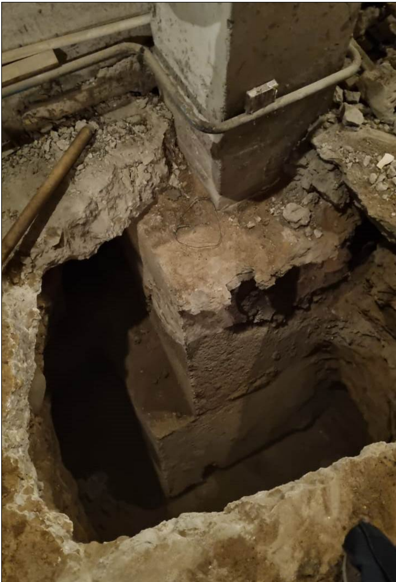
Фото 28. Вид шурфа под колонну каркаса в осях Б/9 (шурф №2)
