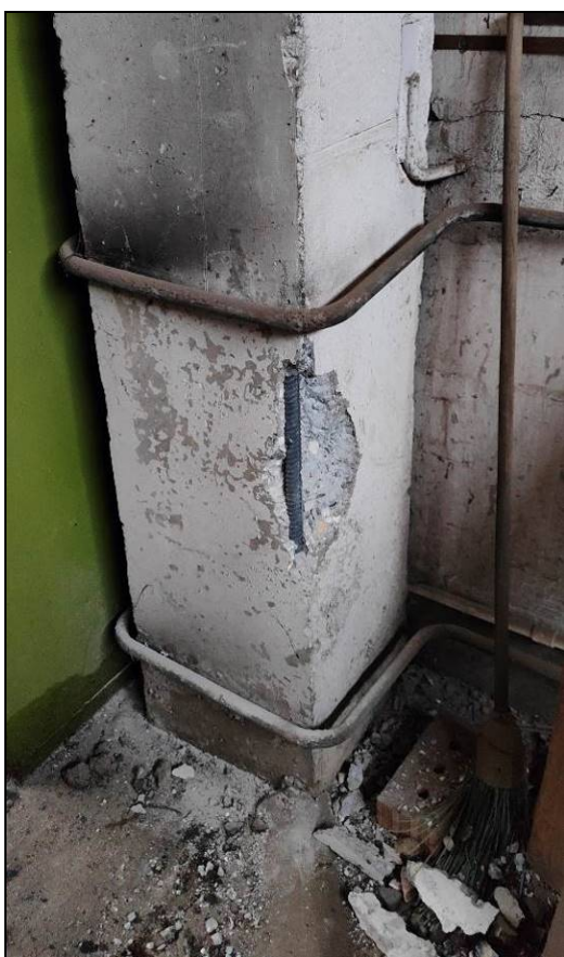
Фото 25, 26. Вскрытие колонн каркаса для определения фактического армирования
