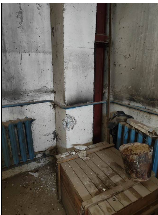
Фото 25, 26. Вскрытие колонн каркаса для определения фактического армирования
