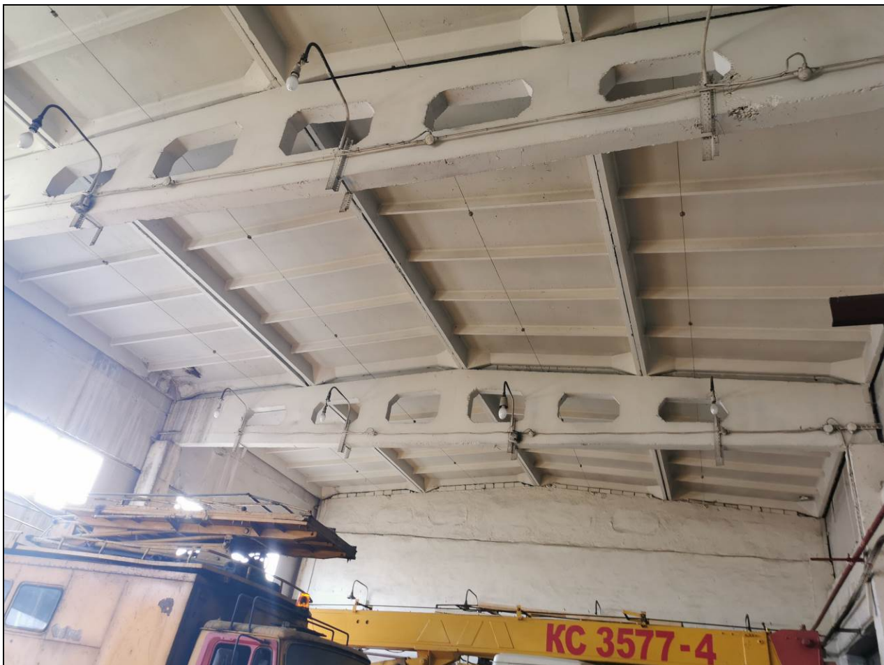
Фото 1. Общий вид элементов покрытия (плит и балок)
