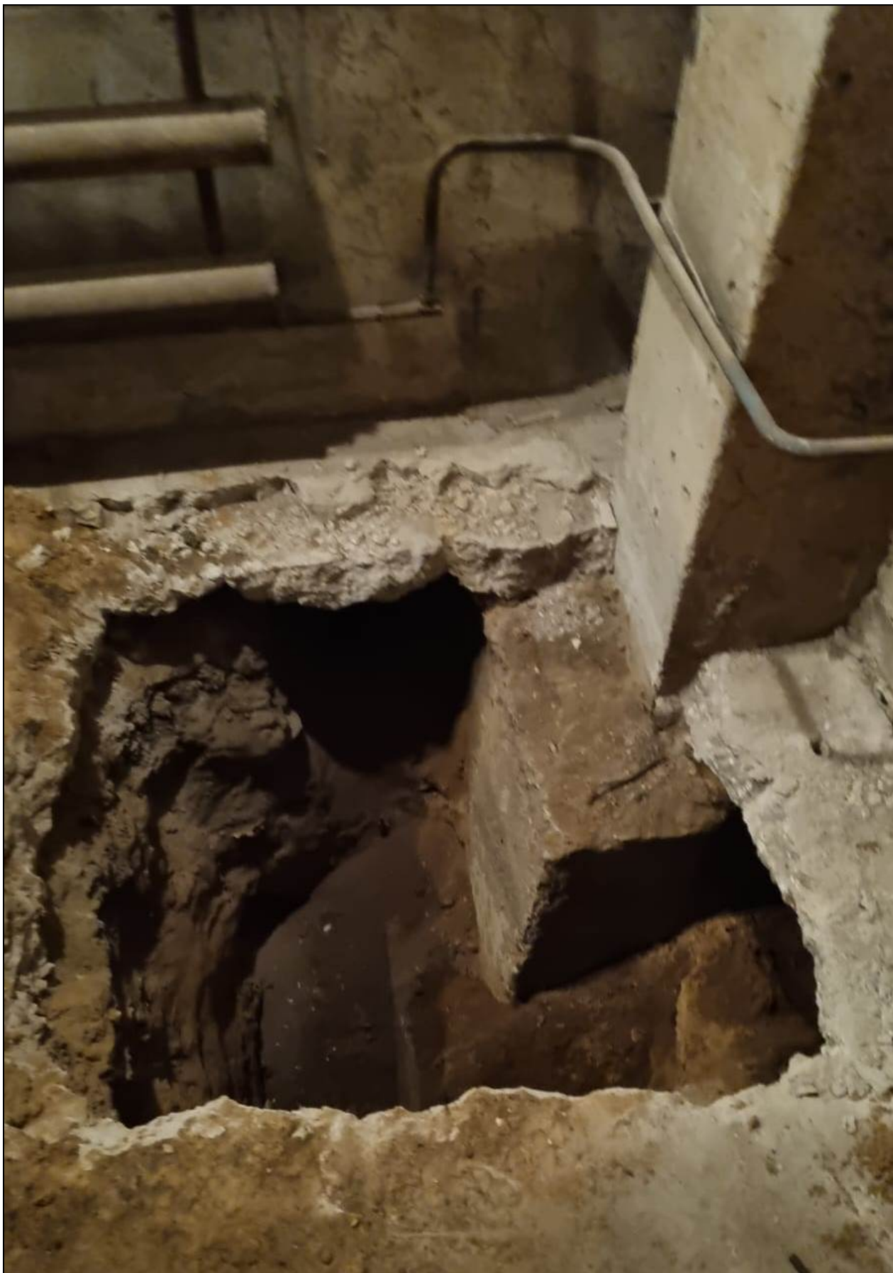
Фото 27. Вид шурфа под колонну каркаса в осях А/9 (шурф №1)
