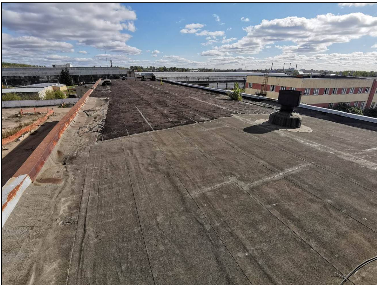
Фото 13. Общий вид кровли
