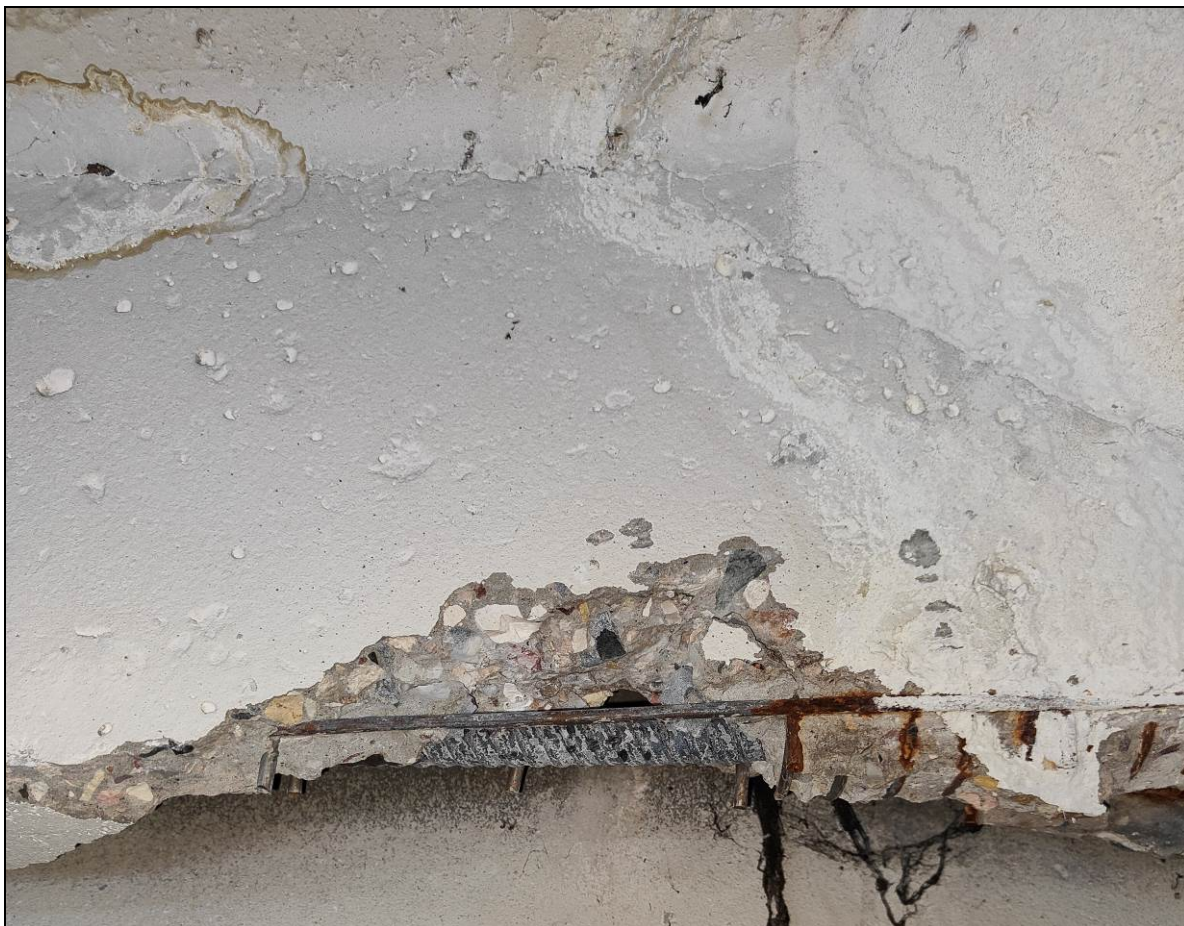
Фото 24. Вскрытие плиты покрытия
