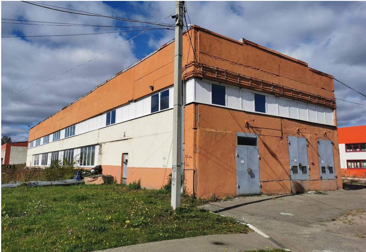
Фото 2. Общий вид здания со стороны фасадов по осям 1, В
