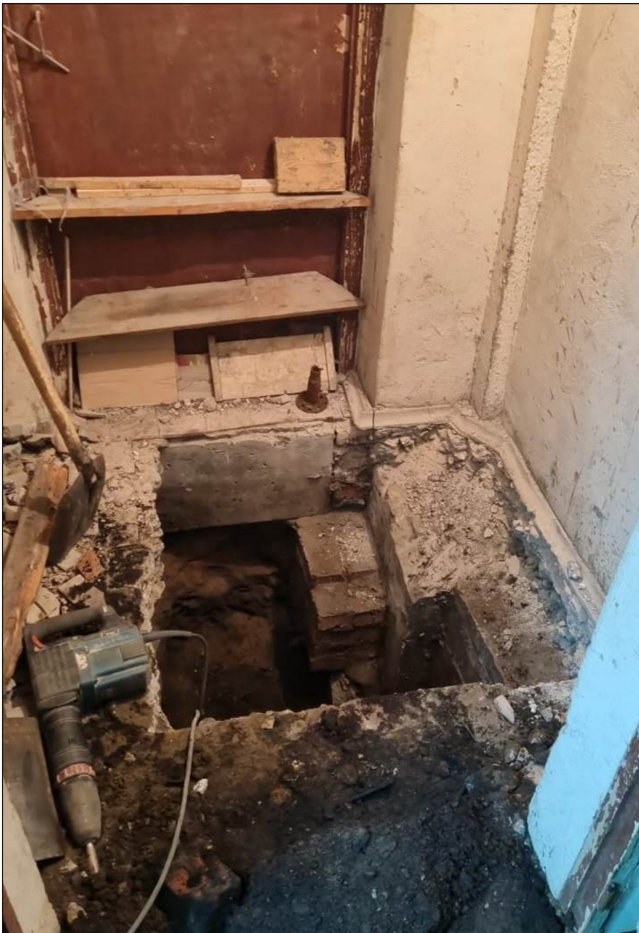
Фото 29. Вид шурфа под колонну каркаса в осях А/З и стену по оси 3 (шурф №3)
