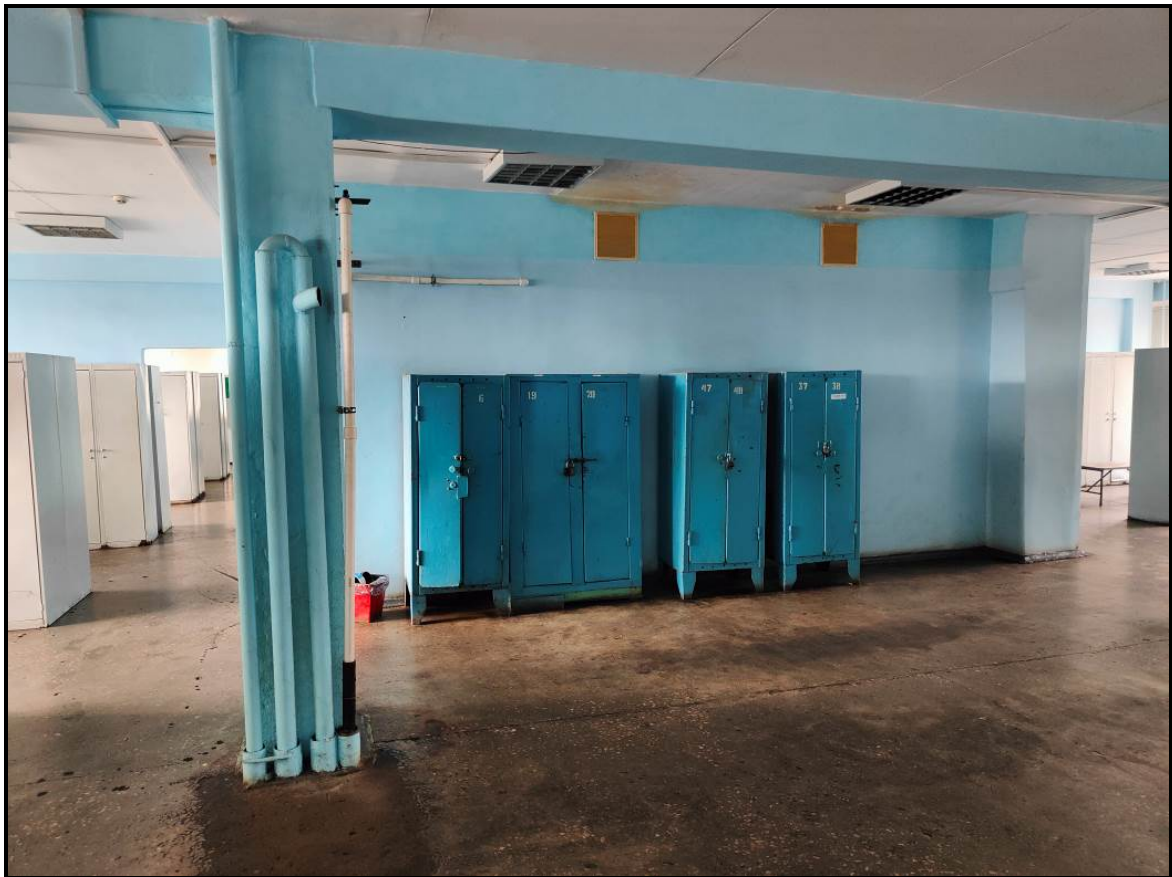
Фото 6.3.1. Общий вид колонн и ригелей
