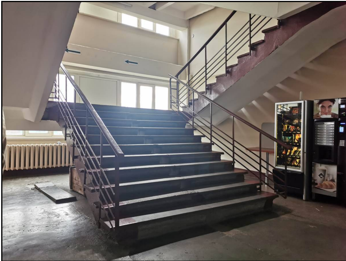
Фото 6.10.1. Общий вид лестниц
