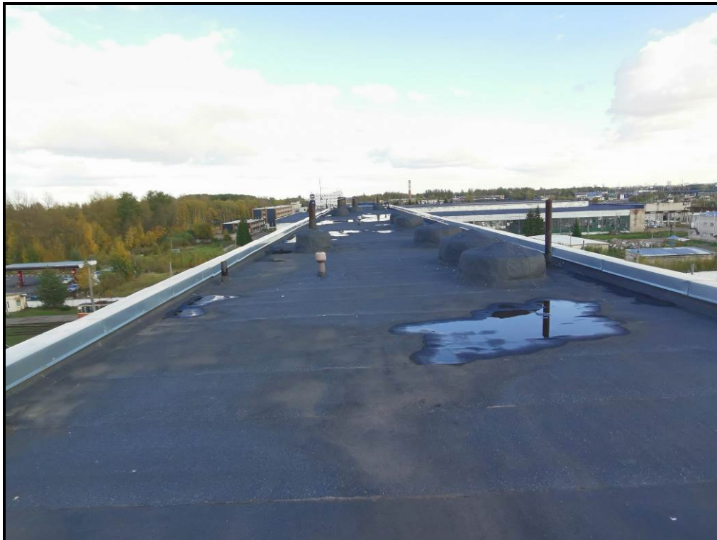
Фото 6.5.4. Общий вид кровли
