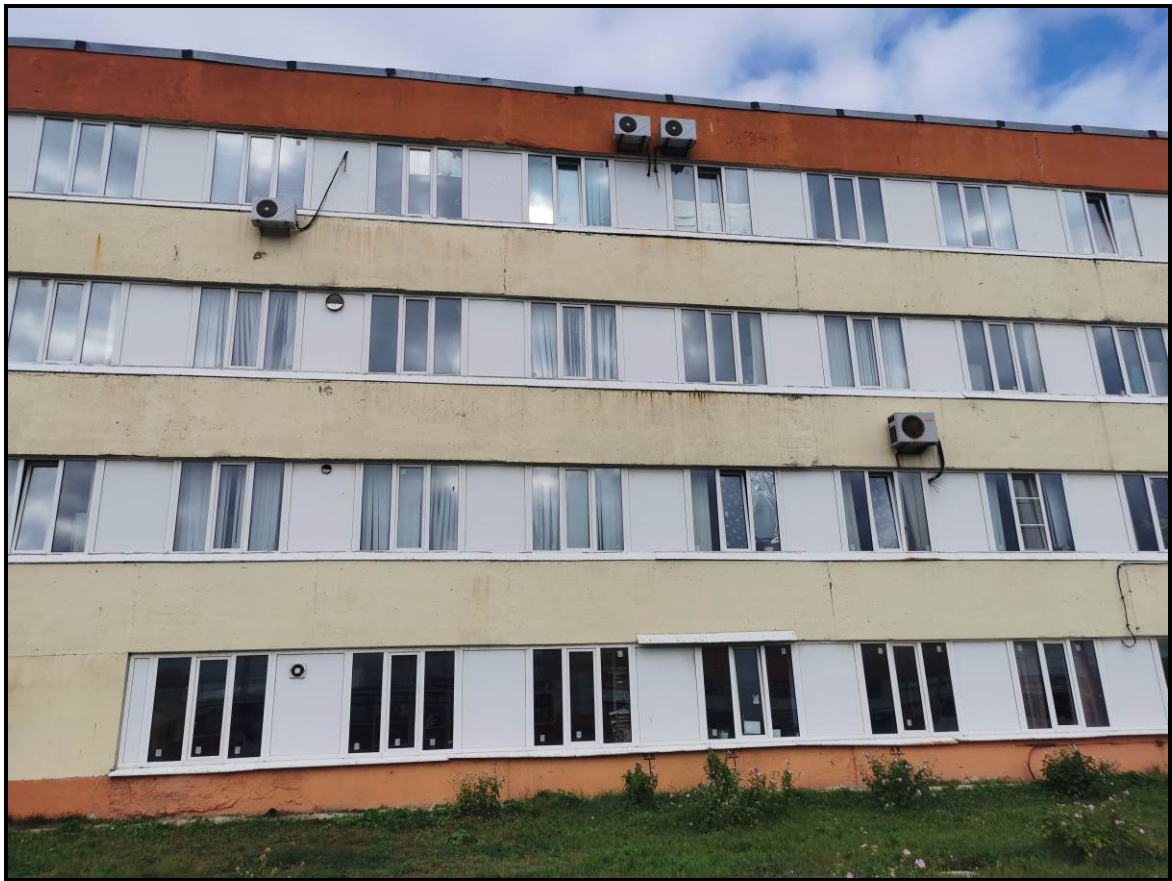
Фото 6.7.1. Общий вид оконных заполнений
