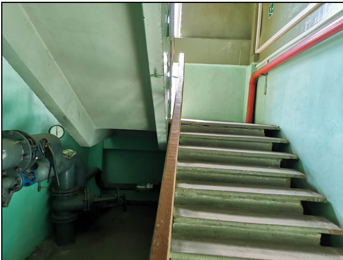
Фото 6.10.2. Общий вид лестниц
