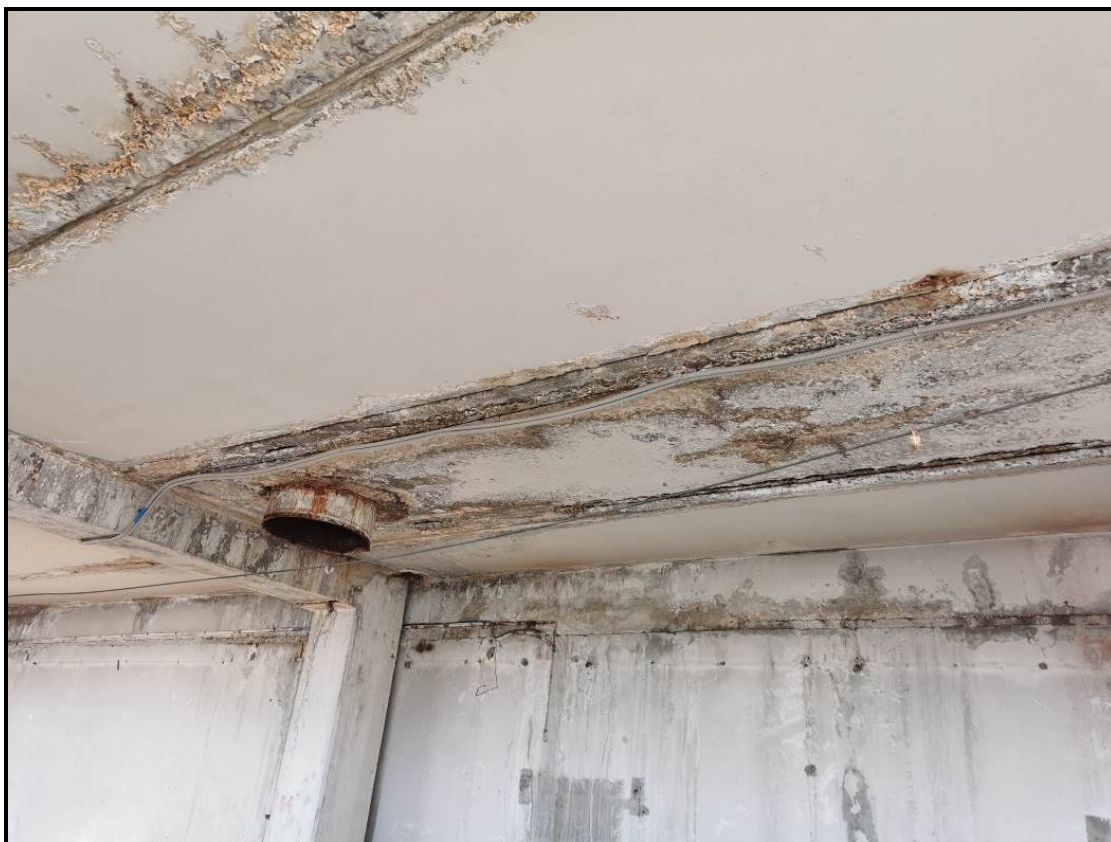
Фото 6.5.1. Общий вид ригелей и плит покрытия
