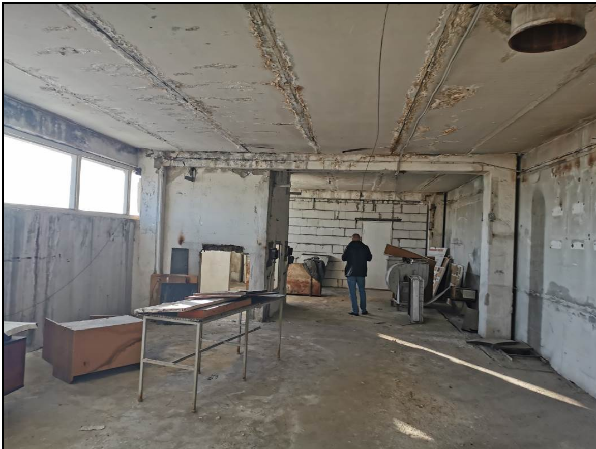
Фото 6.5.2. Общий вид ригелей и плит покрытия
