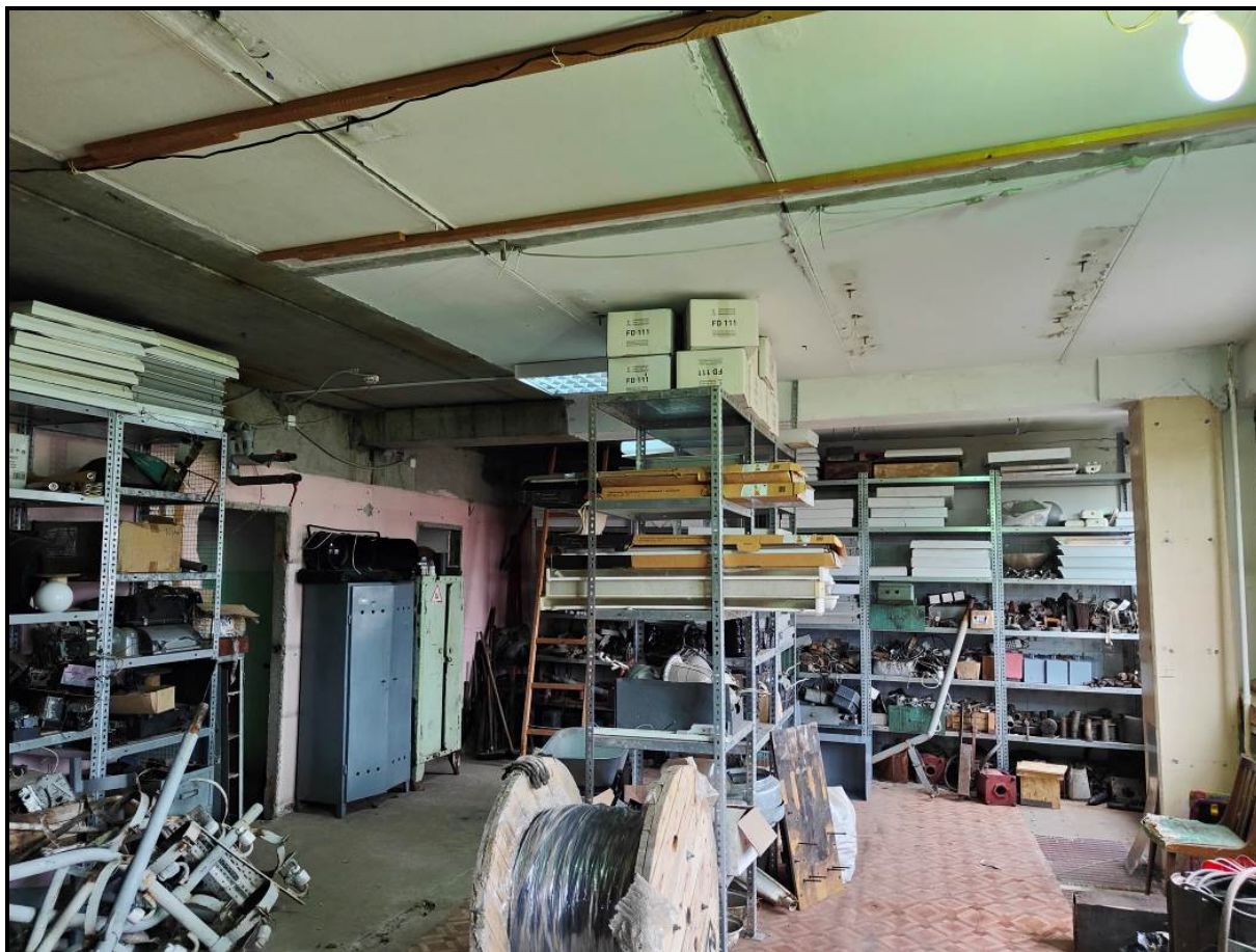
Фото 6.4.2. Общий вид плит перекрытий
