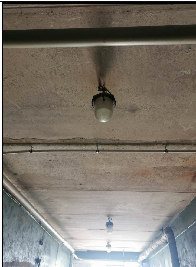
Фото 6.4.1. Общий вид плит перекрытий
