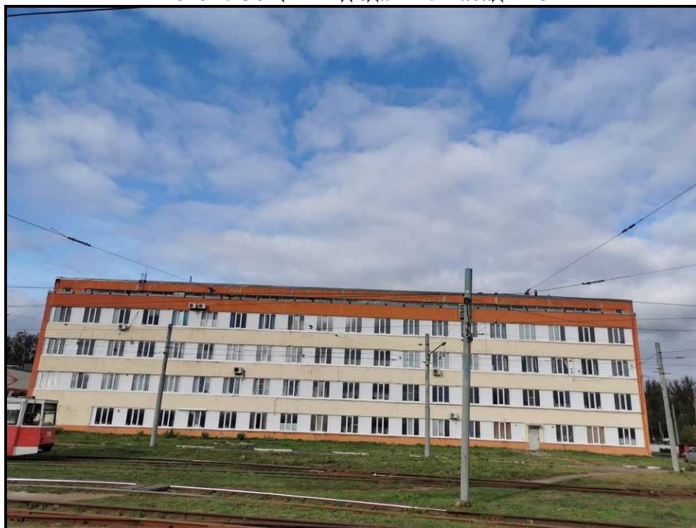
Фото 2. Общий вид здания. Фасад 13-1
