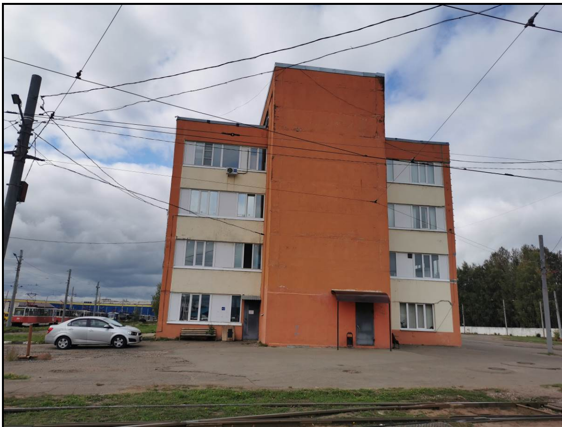
Фото 4. Общий вид здания. Фасад Г-А
