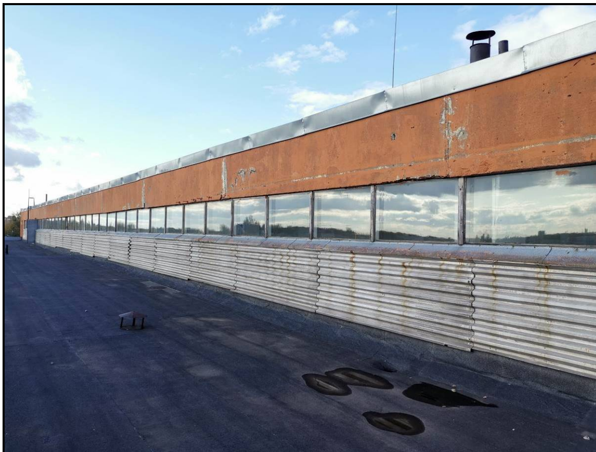
Фото 6.7.3. Общий оконных заполнений пятого этажа
