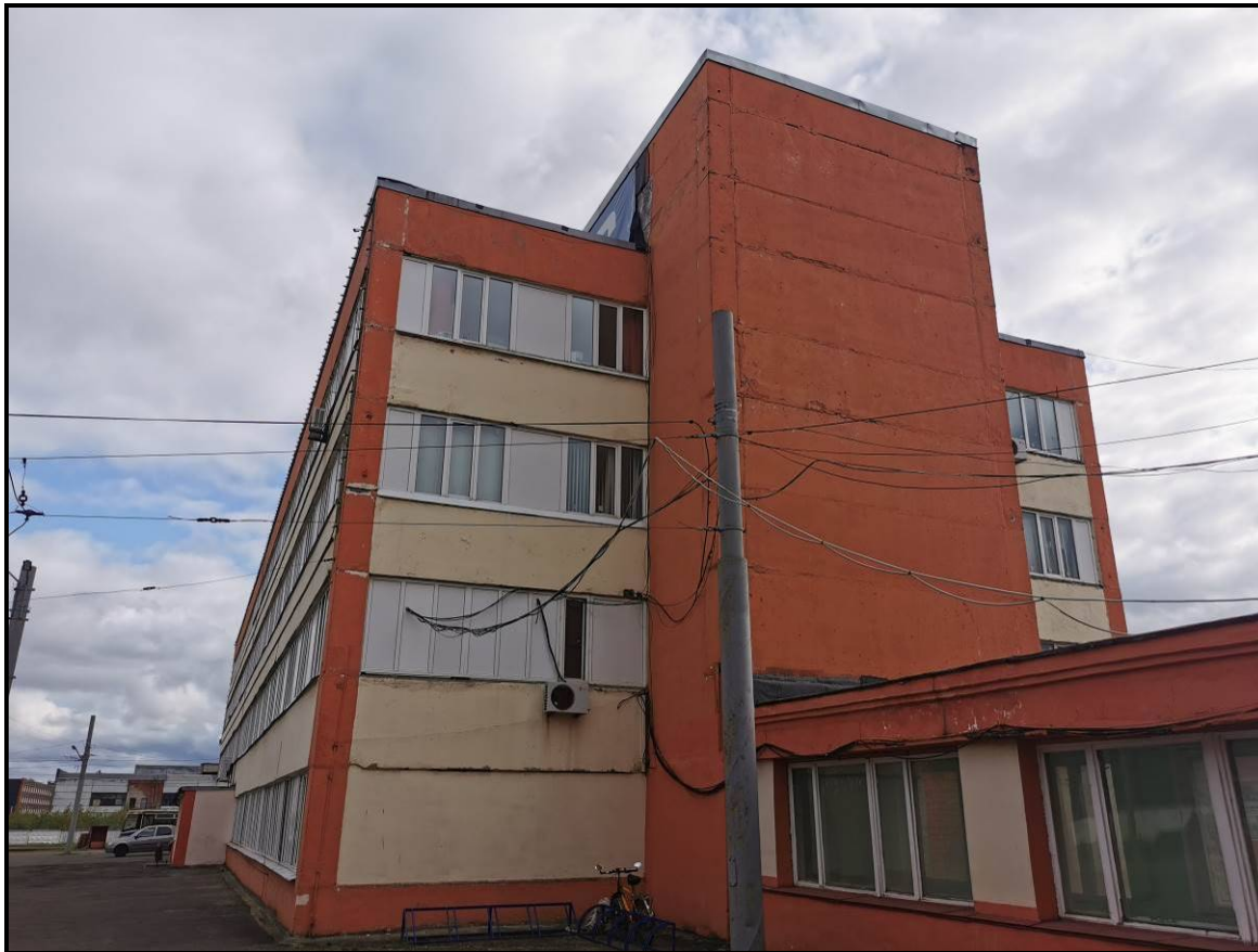
Фото 3. Общий вид здания. Фасад А-Г
