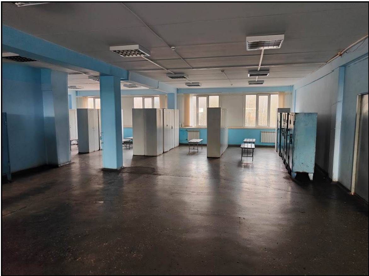
Фото 6.3.2. Общий вид колонн и ригелей
