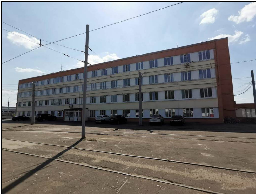
Фото 1. Общий вид здания. Фасад 1-13
