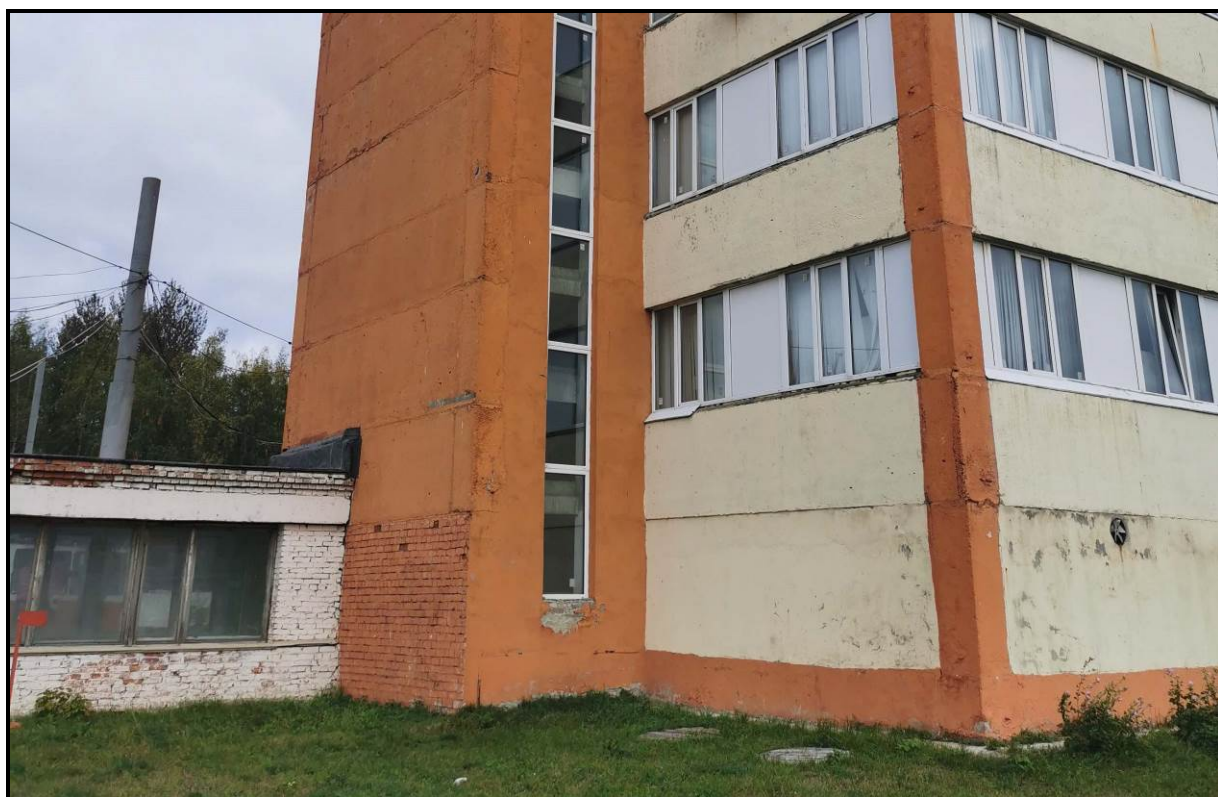
Фото 6.2.2. Общий вид кирпичных участков стен
