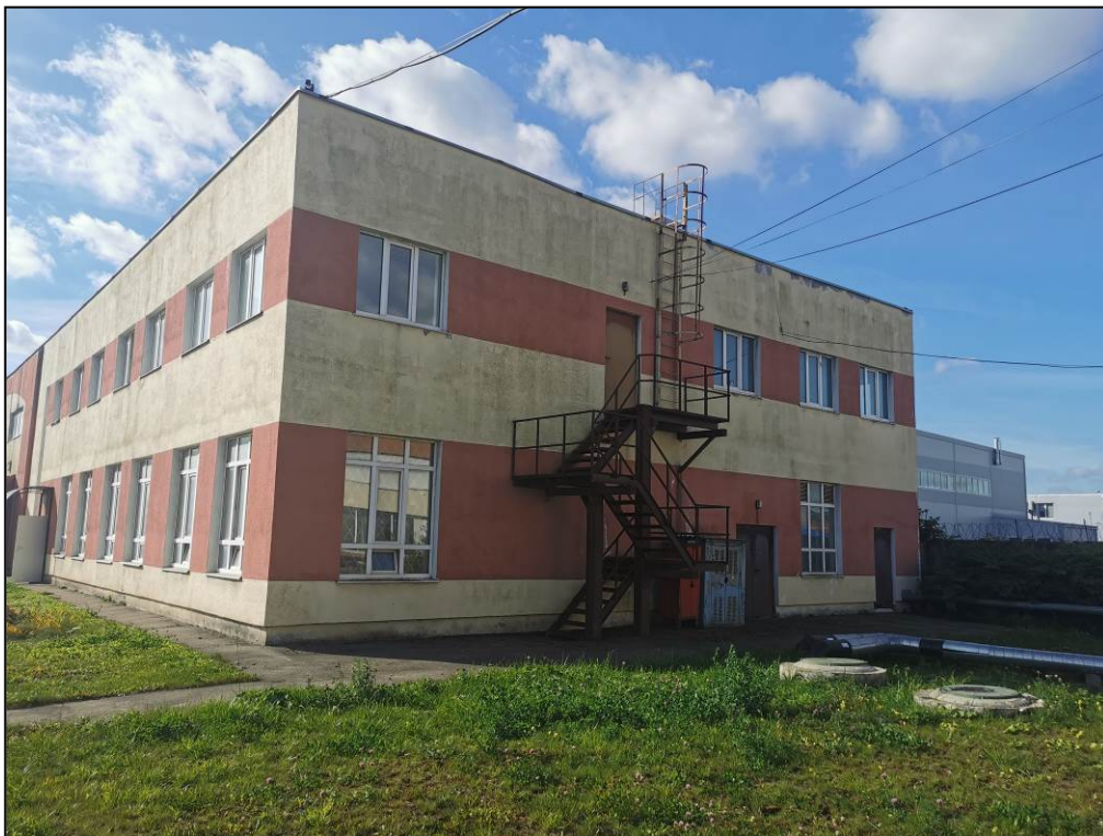
Фото 2. Общий вид здания. Фасад А-Г
