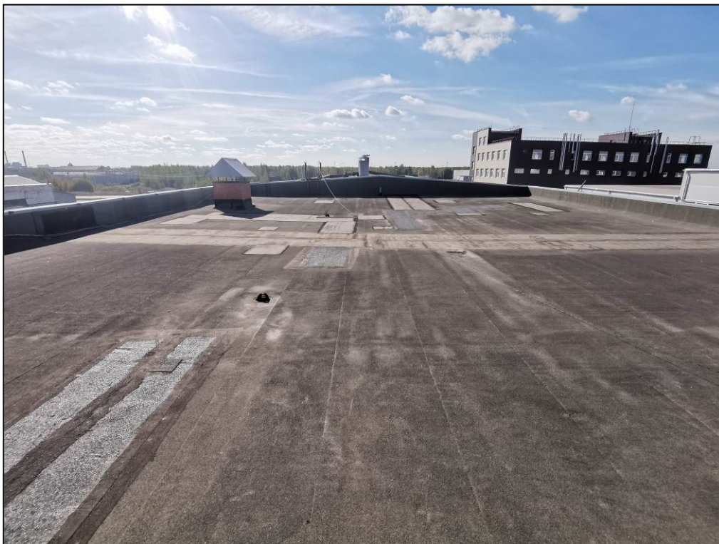
Фото 7. Общий вид кровли здания в осях А-Гх13-17
