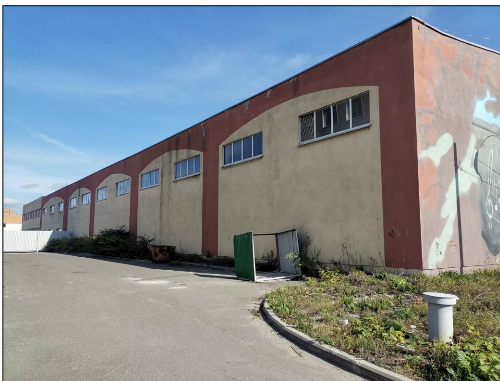
Фото 3. Общий вид здания. Фасад 17-1
