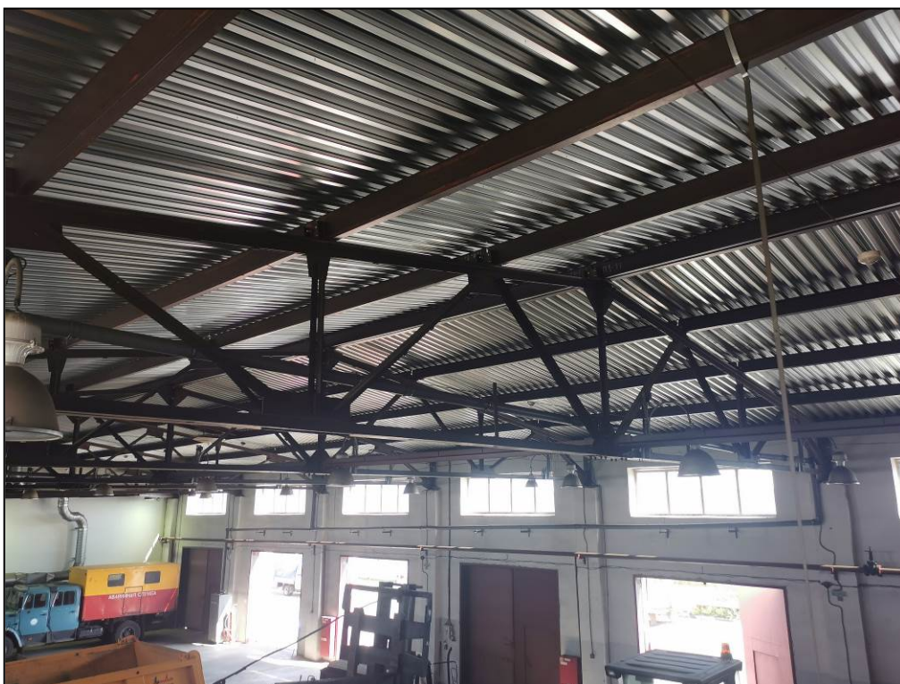
Фото 4. Общий вид ферм покрытия в осях А-Гх1-9
