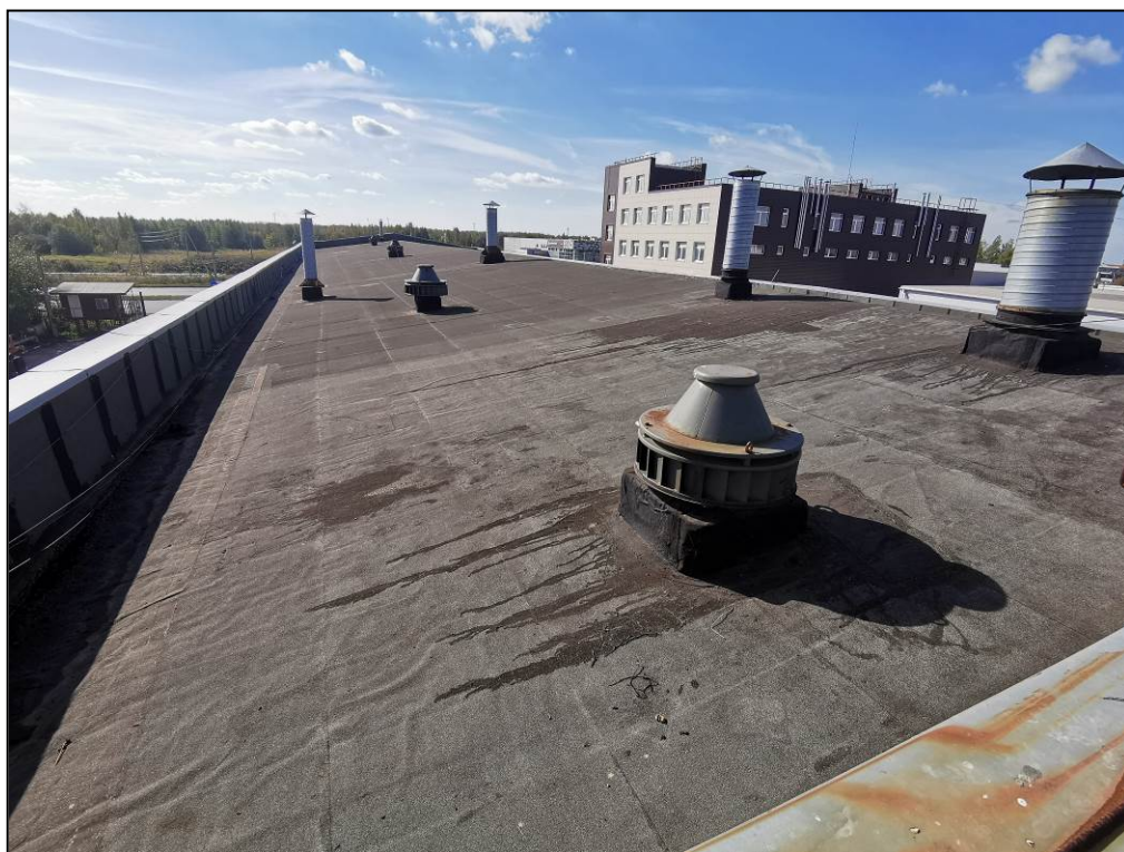
Фото 6. Общий вид кровли здания в осях А-Гх1-13
