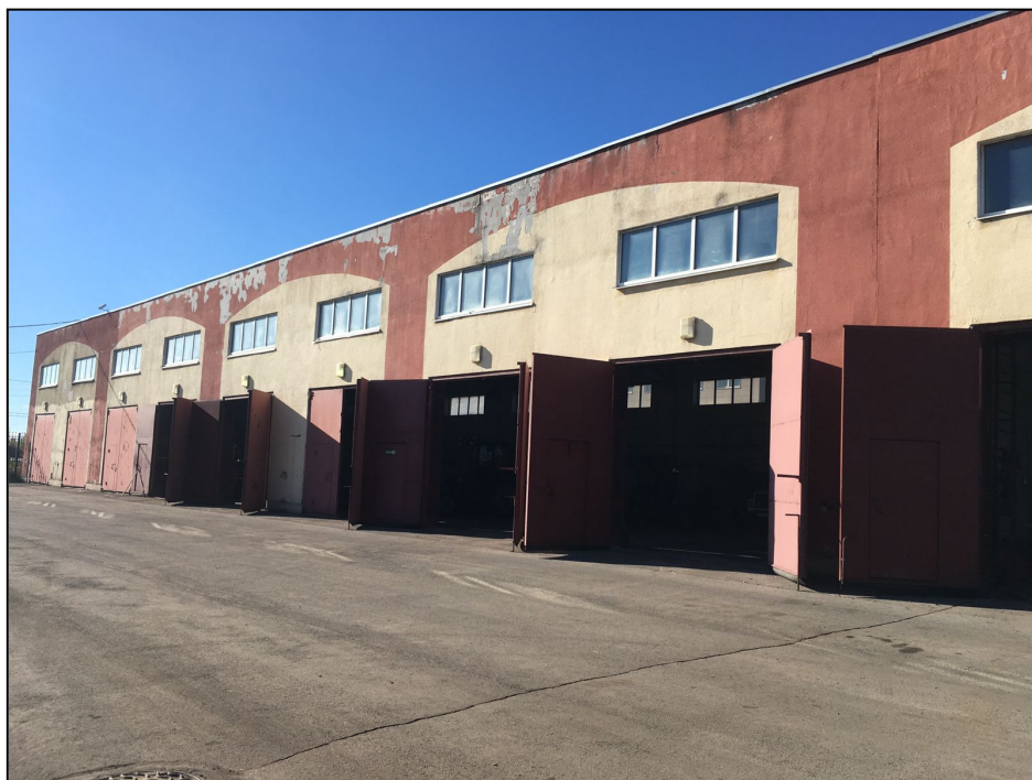
Фото 1. Общий вид здания. Фасад 1-17
