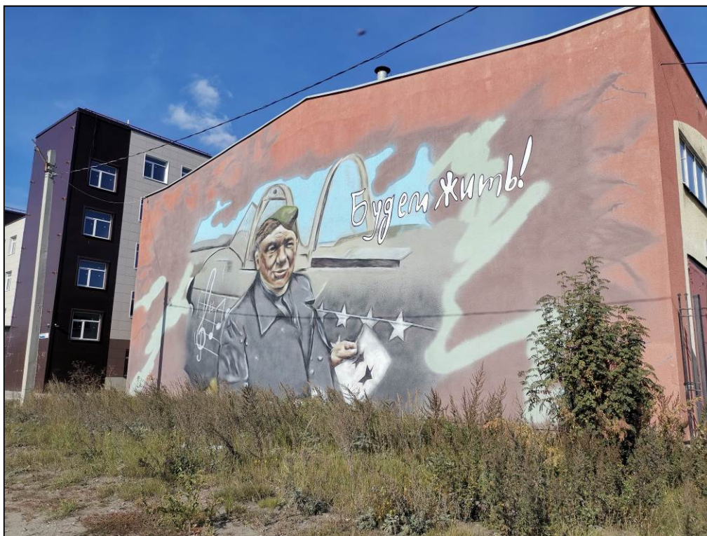
Фото 4. Общий вид здания. Фасад Г-А
