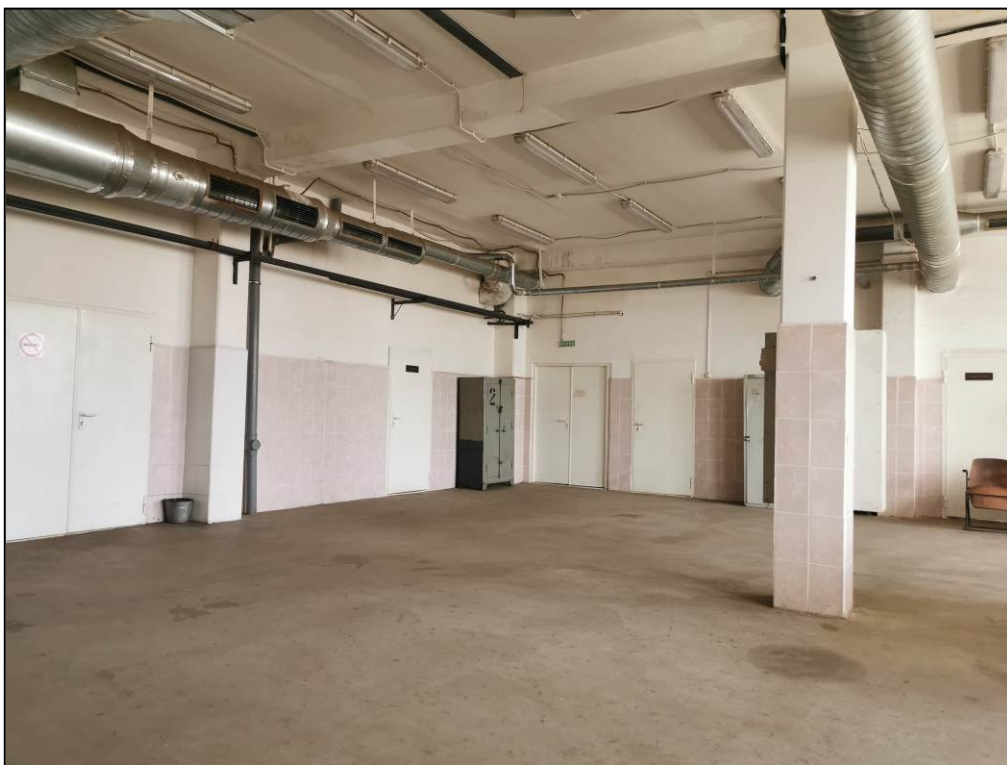
Фото 5. Общий вид элементов каркаса в осях А-Гх13-17
