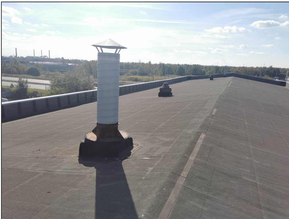
Фото 7. Общий вид кровли здания в осях А-Гх1-13
