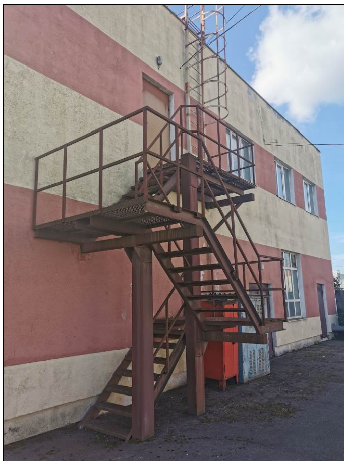
Фото 19. Общий вид наружной эвакуационной лестницы по оси 17
