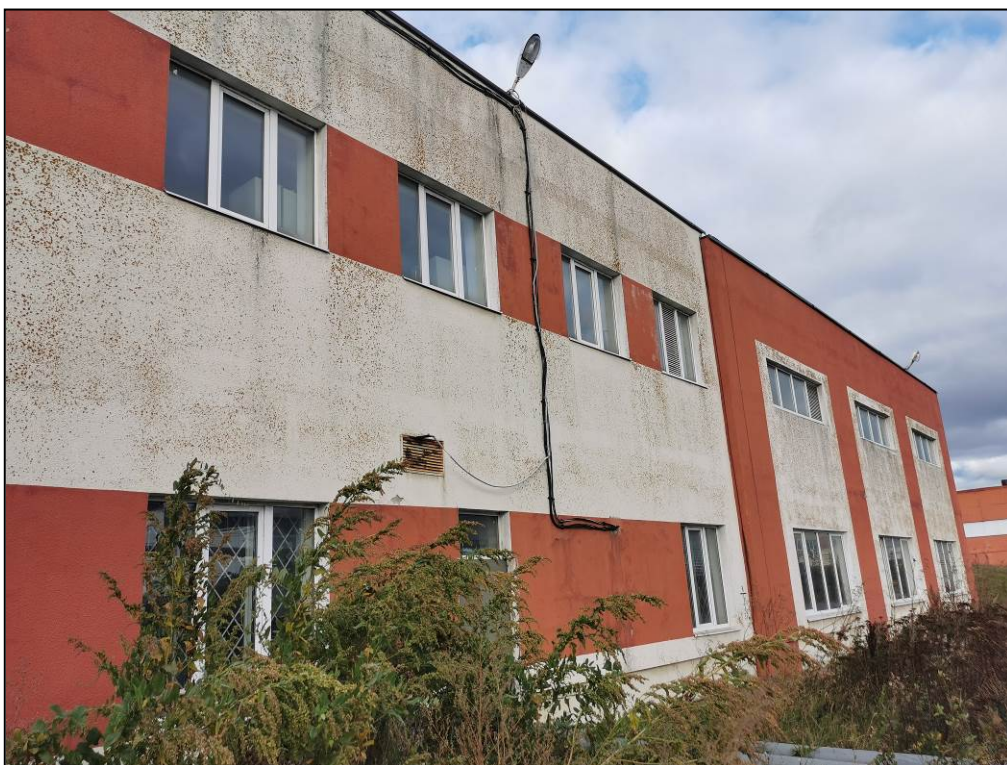
Фото 3. Общий вид здания. Фасад 9-1
