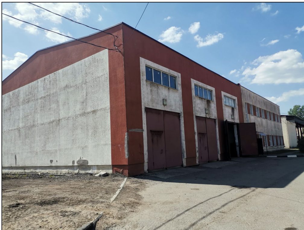
Фото 1. Общий вид здания. Фасад 1-9
