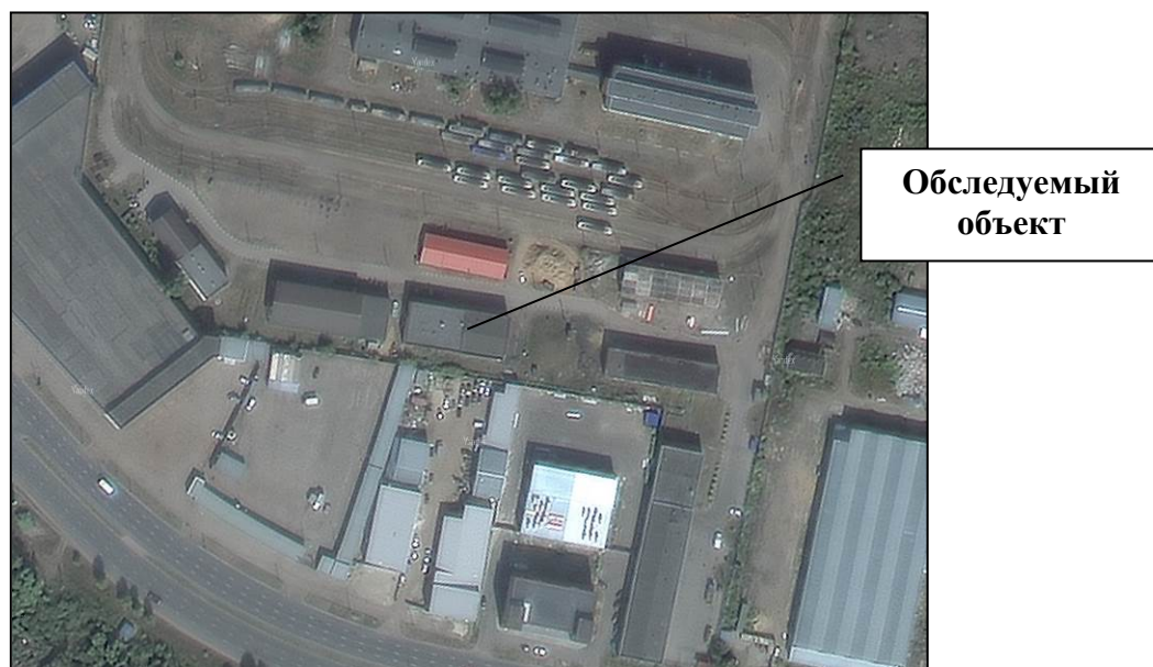
Рис. 1. Местоположение обследуемого объекта
