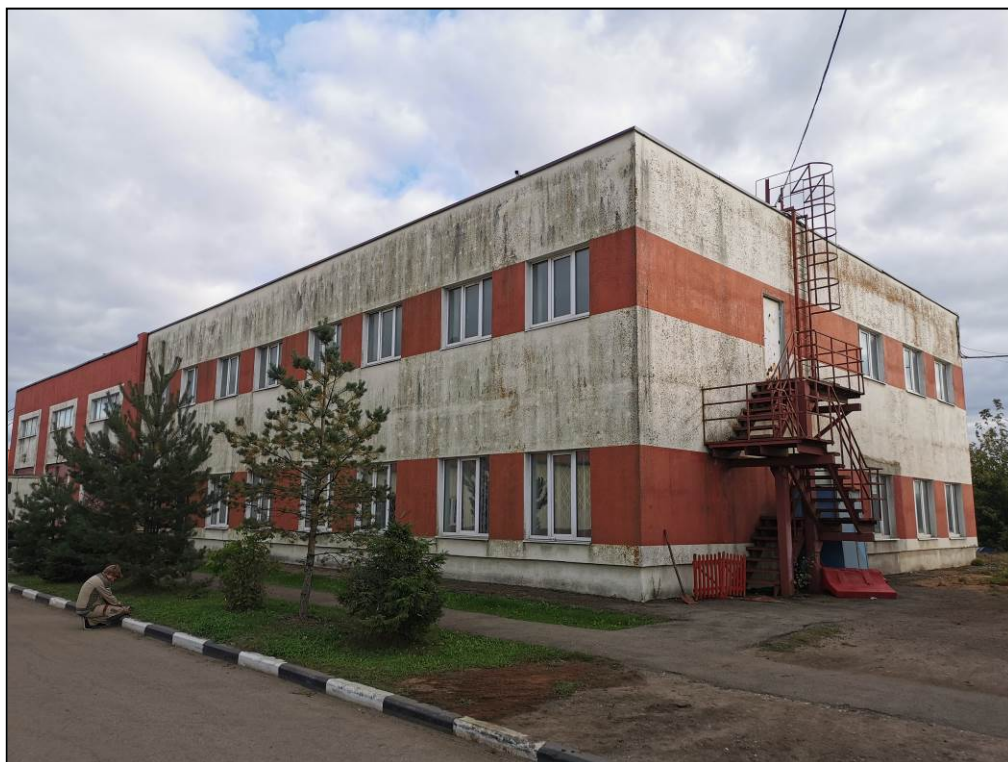
Фото 1. Общий вид здания. Фасады 1-9, А-Г
