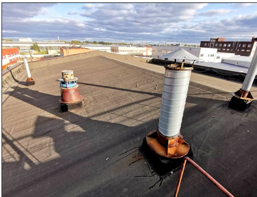
Фото 8. Общий вид кровли здания в осях А-Гх1-4
