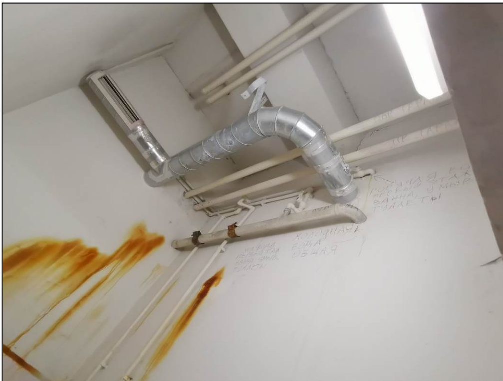
Фото 11. Участок установки ремонтных хомутов на трубопроводе холодного водоснабжения
