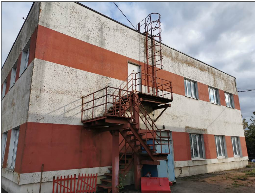
Фото 2. Общий вид здания. Фасад А-Г
