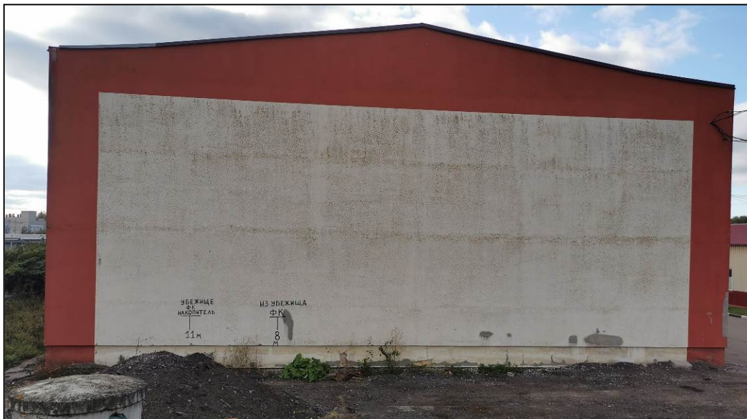
Фото 4. Общий вид здания. Фасад Г-А
