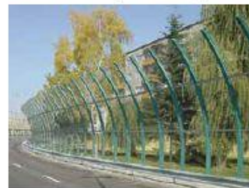
Рис. 3. Строительно-технические мероприятия по защите от шума
