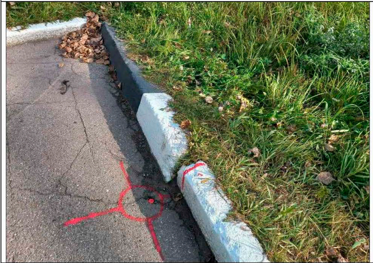
Фото пункта закрепления
