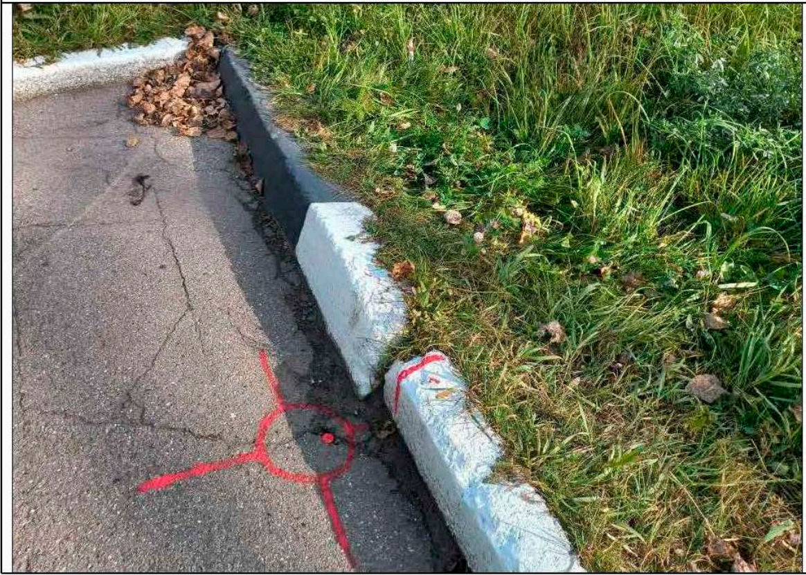
Фото пункта закрепления
