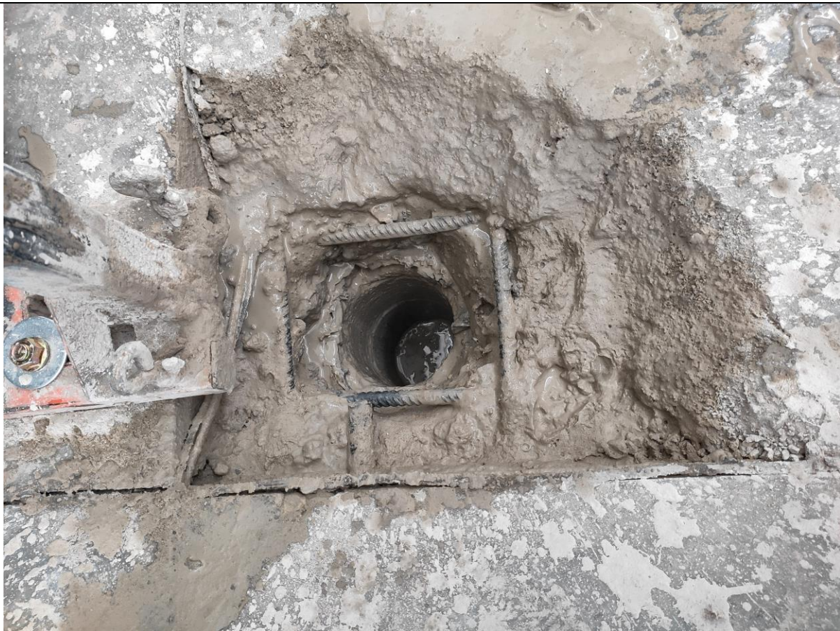
Фото 26. Вскрытие полов в осях Б-В/4-5.
