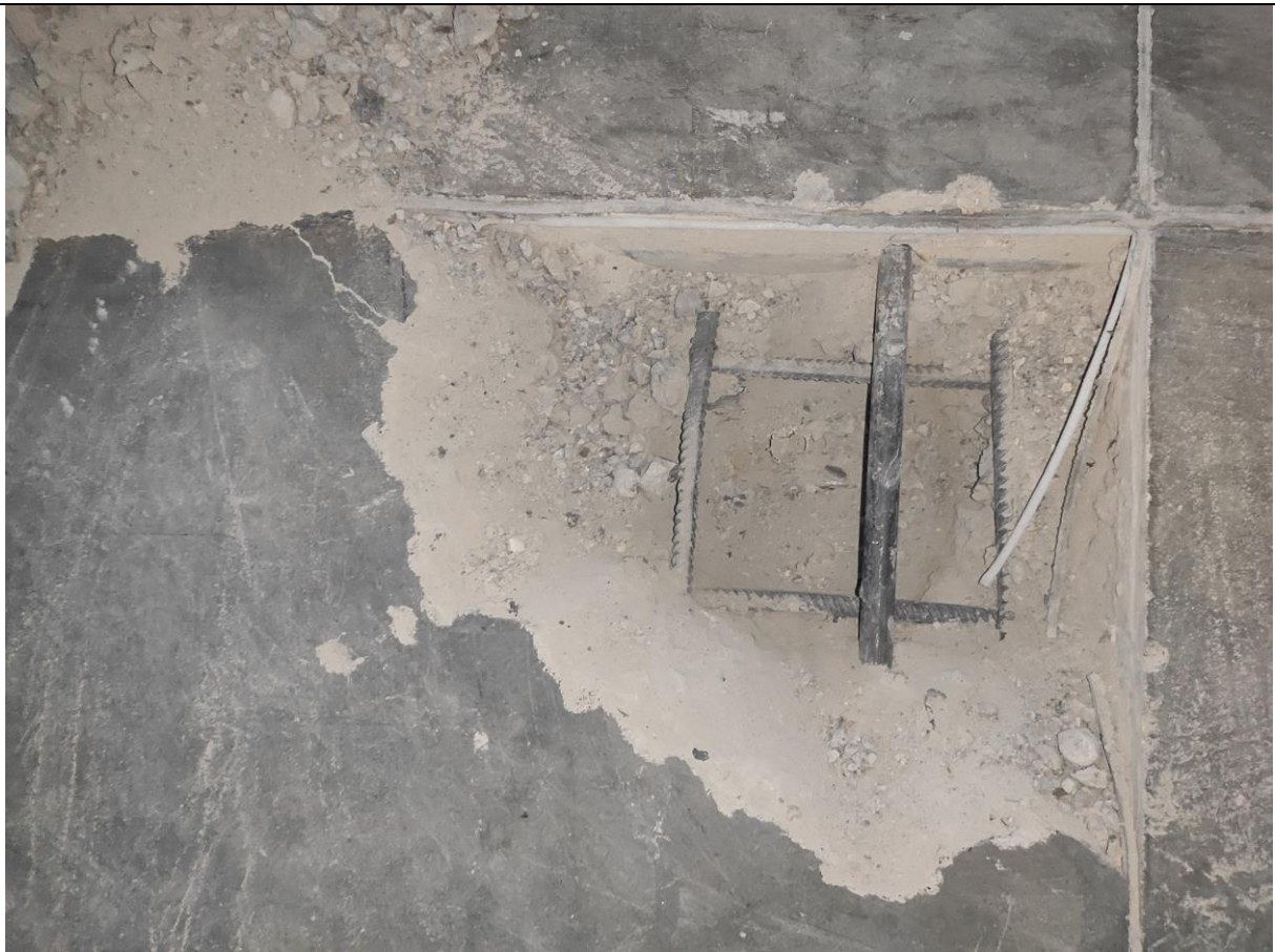
Фото 25. Вскрытие полов в осях Б-В/4-5.
