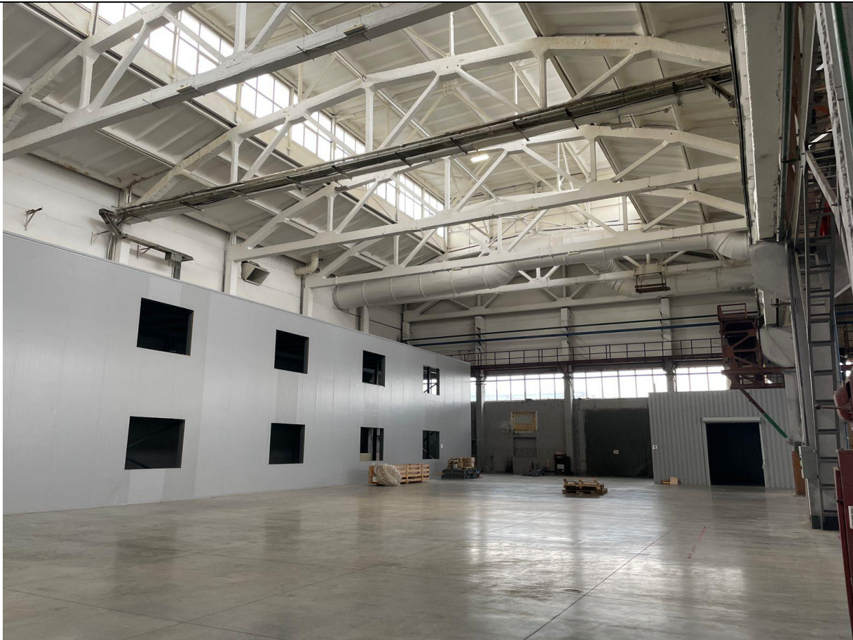
Фото 8. Общий вид помещения цеха в осях Б-В/28-33.
