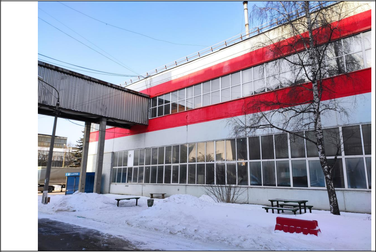
Фото 2. Фрагмент фасада в осях 1-33.
