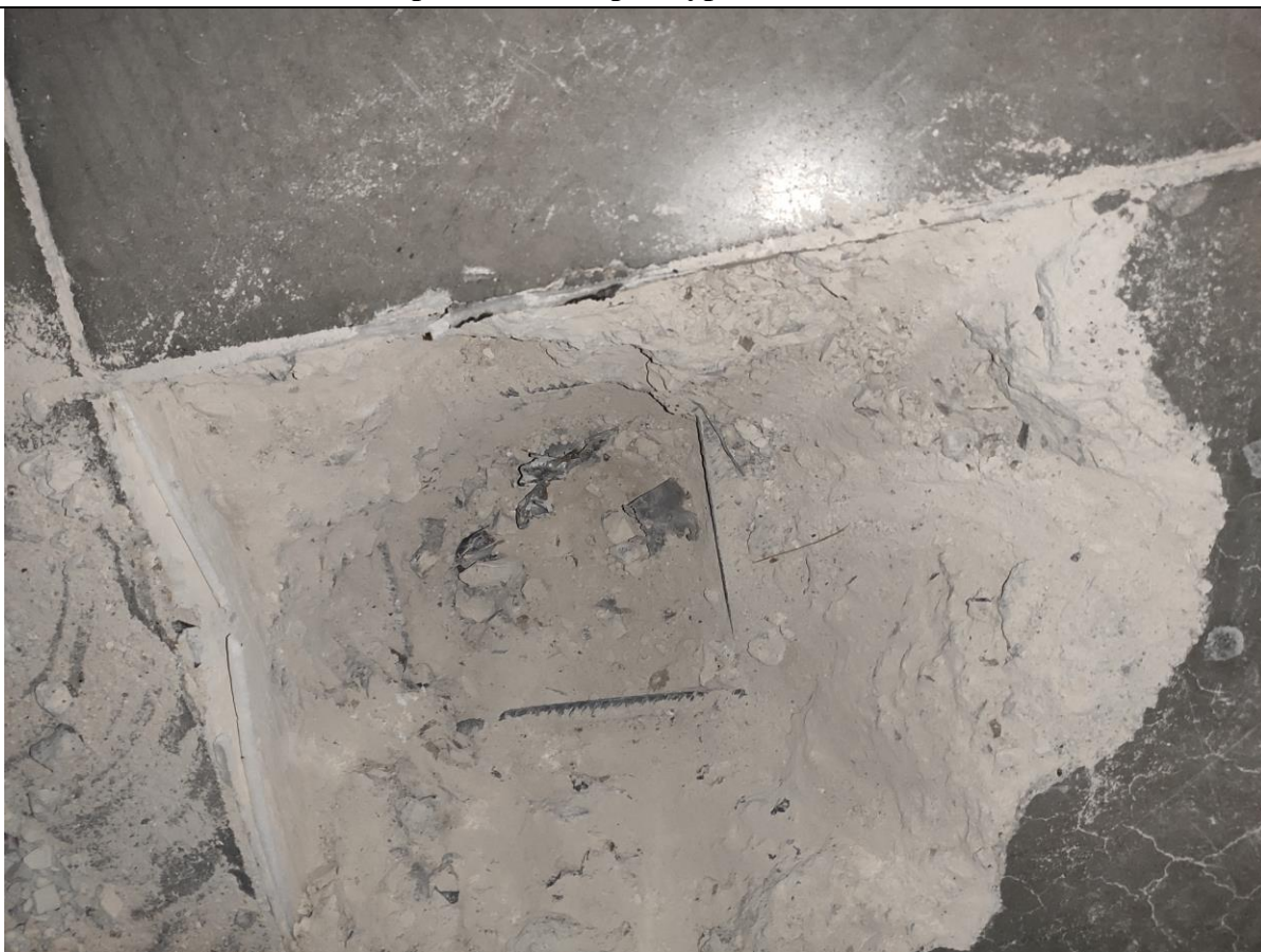
Фото 29. Вскрытие полов в осях А-Б/18-19.
