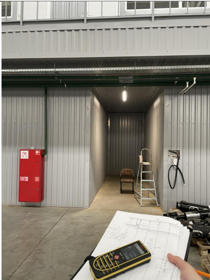
Фото 24. Подключение пожарного крана к системе водоснабжения
