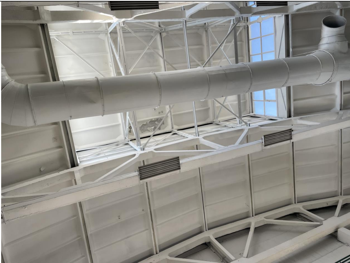
Фото 38. Разрушение отделочного слоя плит покрытия.
