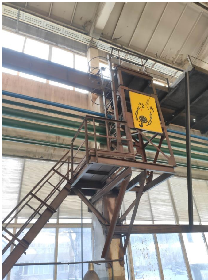
Фото 14. Ремонтная площадка в осях А/6-7. Подкрановая балка ПБ-1
