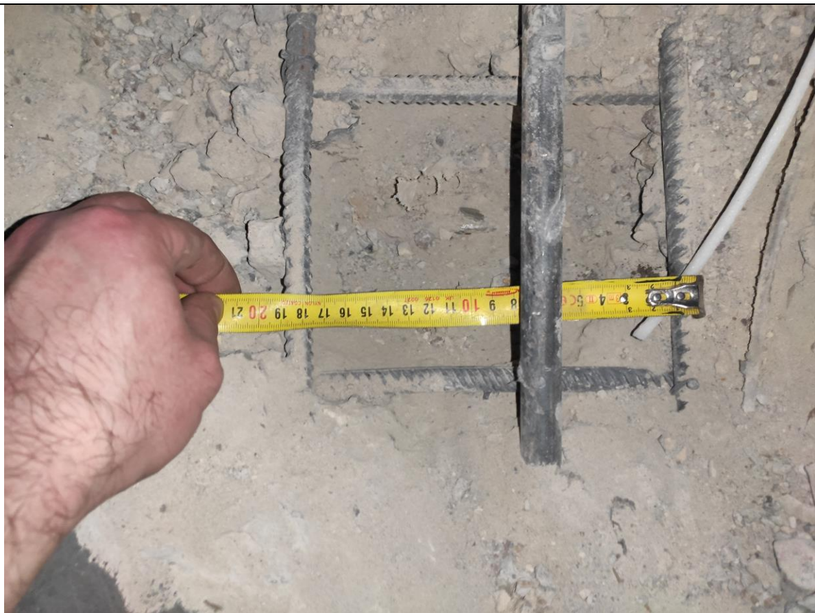
Фото 28. Измерение шага арматуры полов в осях Б-В/4-5.
