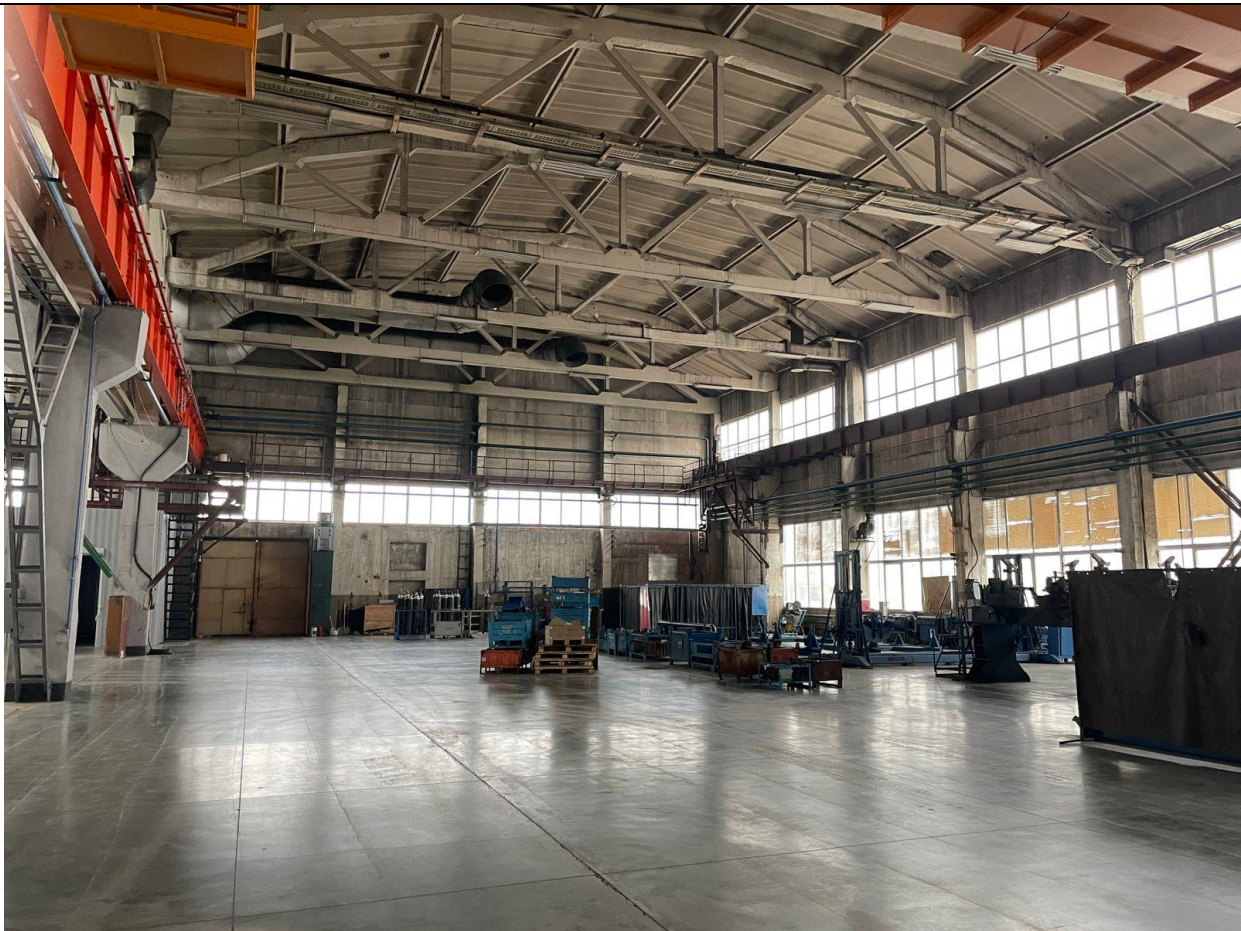
Фото 7. Общий вид помещения цеха в осях А-Б/26-33.
