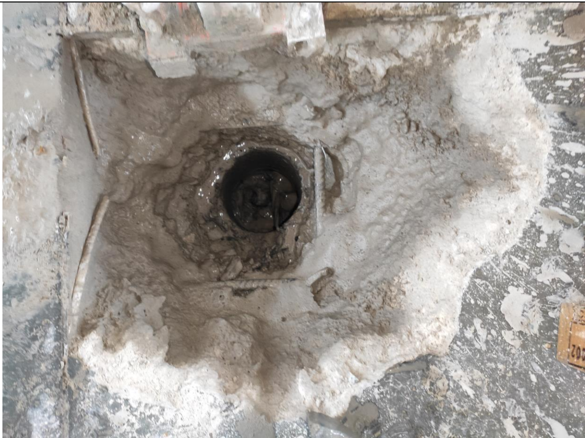
Фото 30. Вскрытие полов в осях А-Б/18-19.
