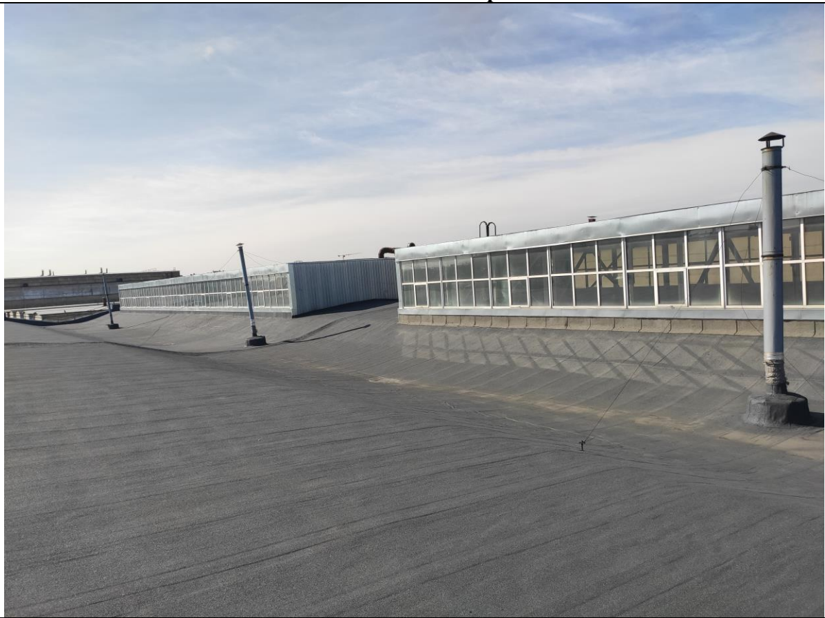
Фото 6. Общий вид кровли.
