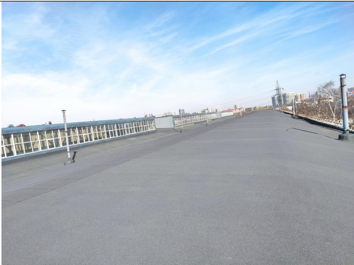
Фото 5. Общий вид кровли.
