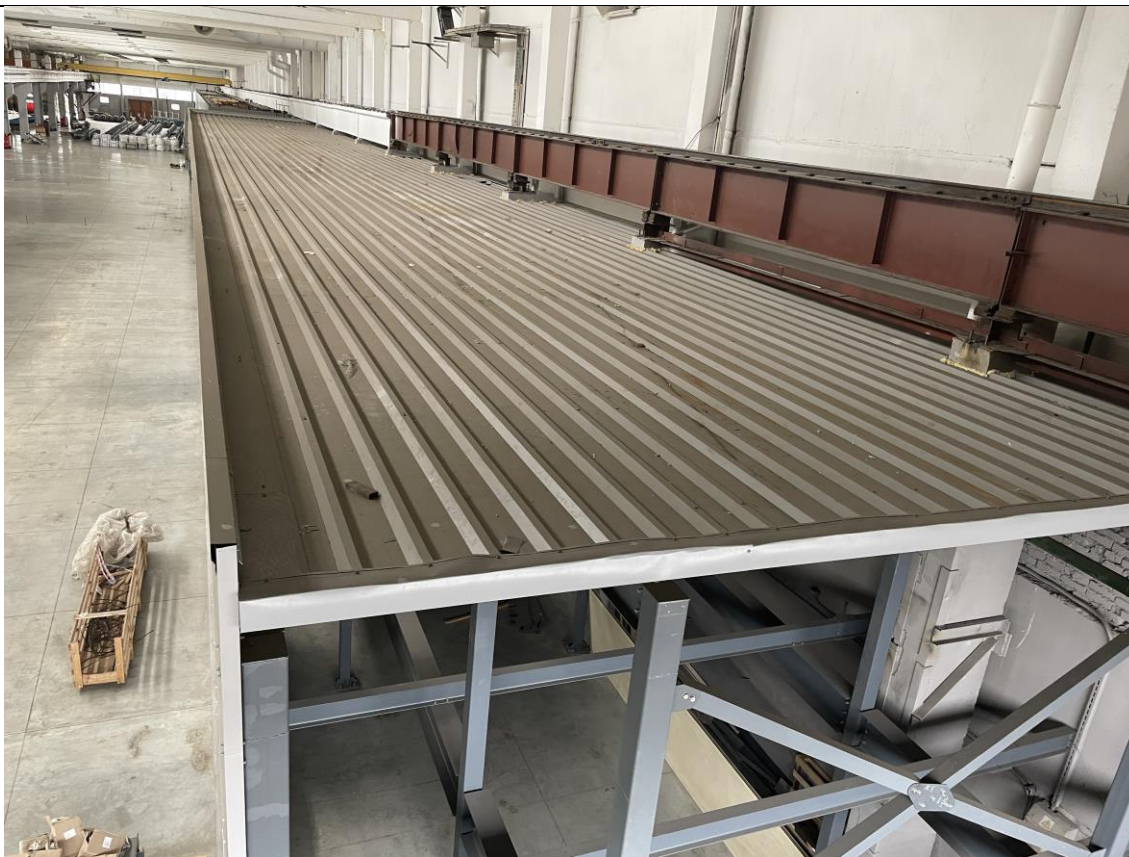
Фото 12. Конструкция покрытия недостроенной части АБК в осях Б-В/24-33. Подкрановые балки ПБ-4 и ПБ-5
