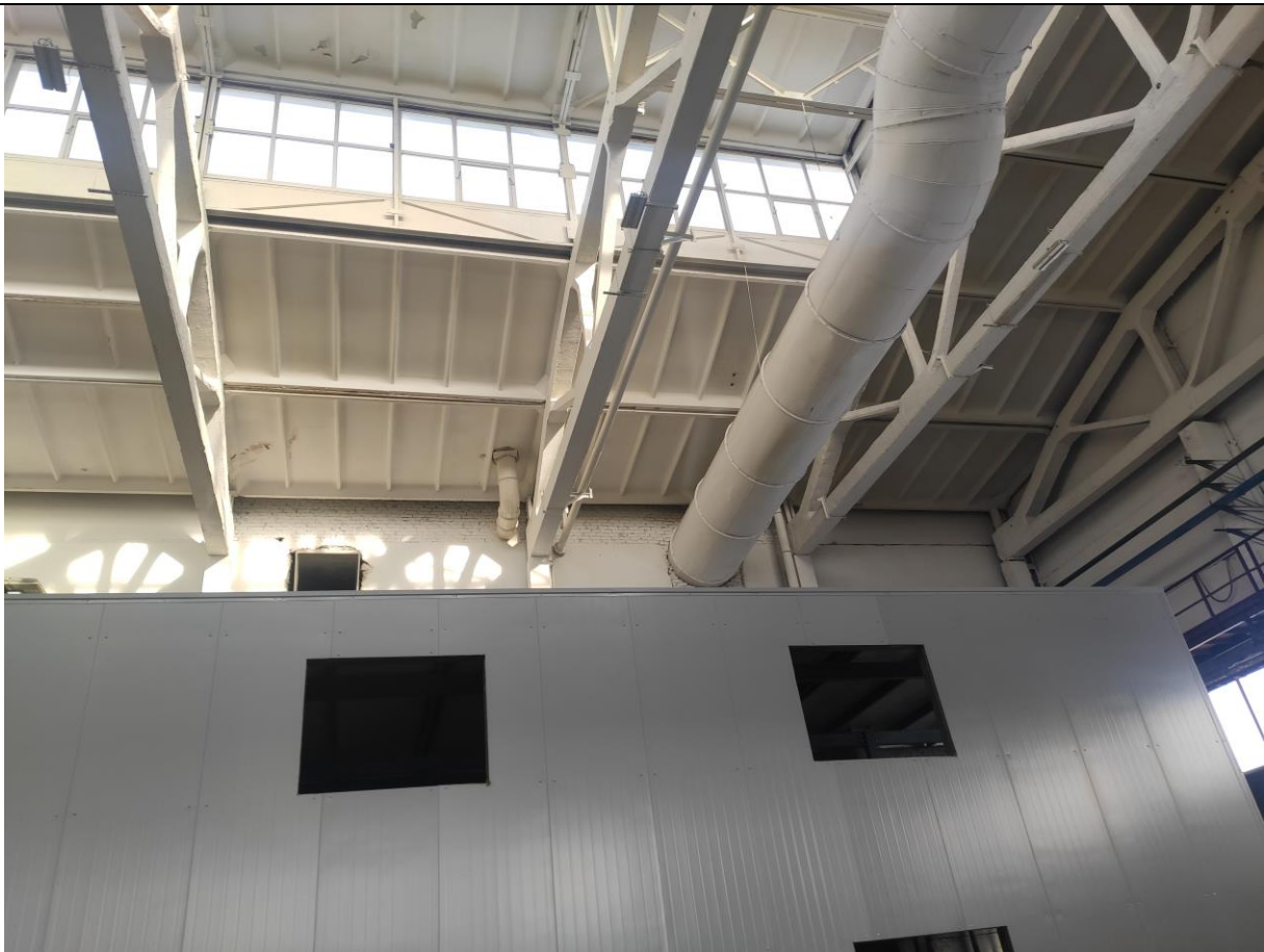
Фото 22. Вентиляционный проем из помещения венткамеры в стене по оси В.
