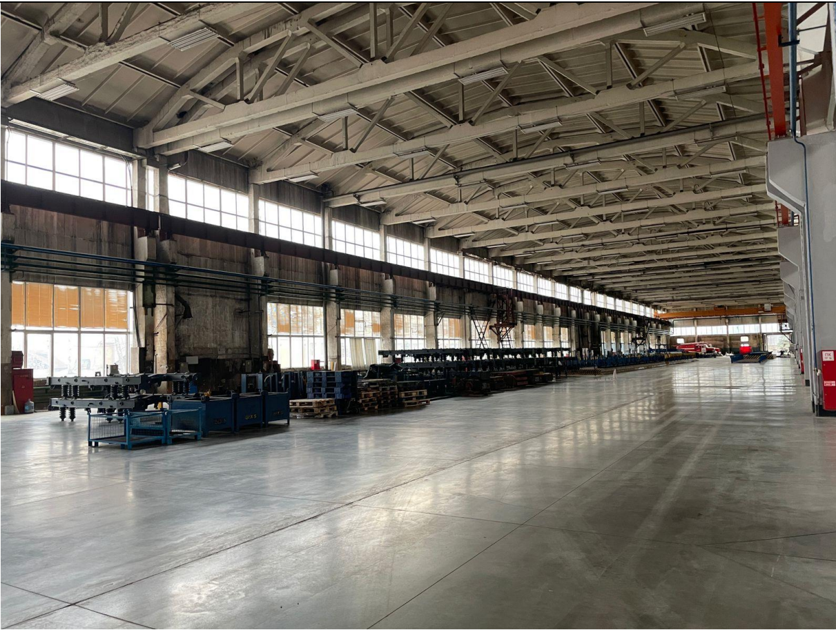
Фото 10. Общий вид помещения цеха в осях А-Б/26-1.
