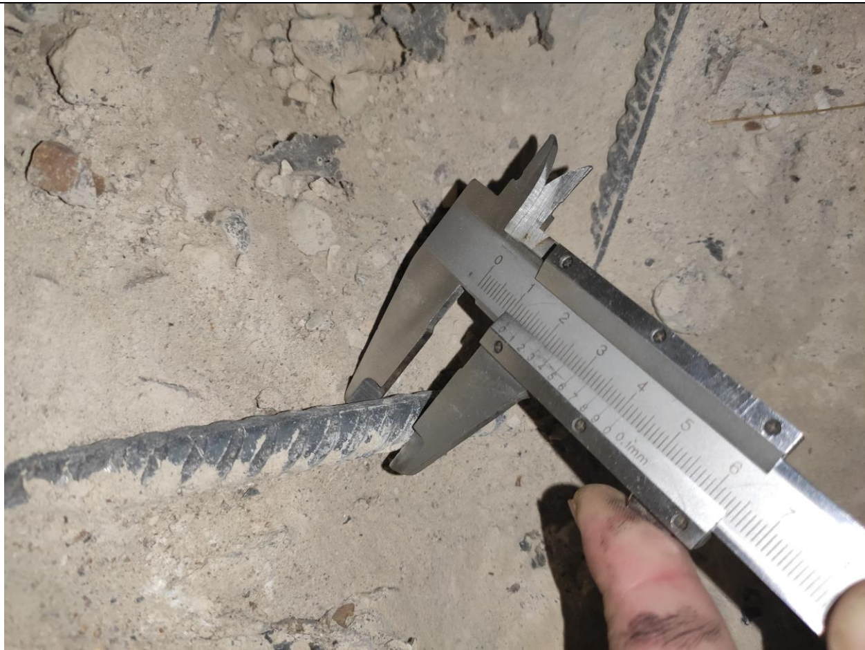
Фото 31. Измерение диаметра арматуры полов в осях А-Б/18-19.
