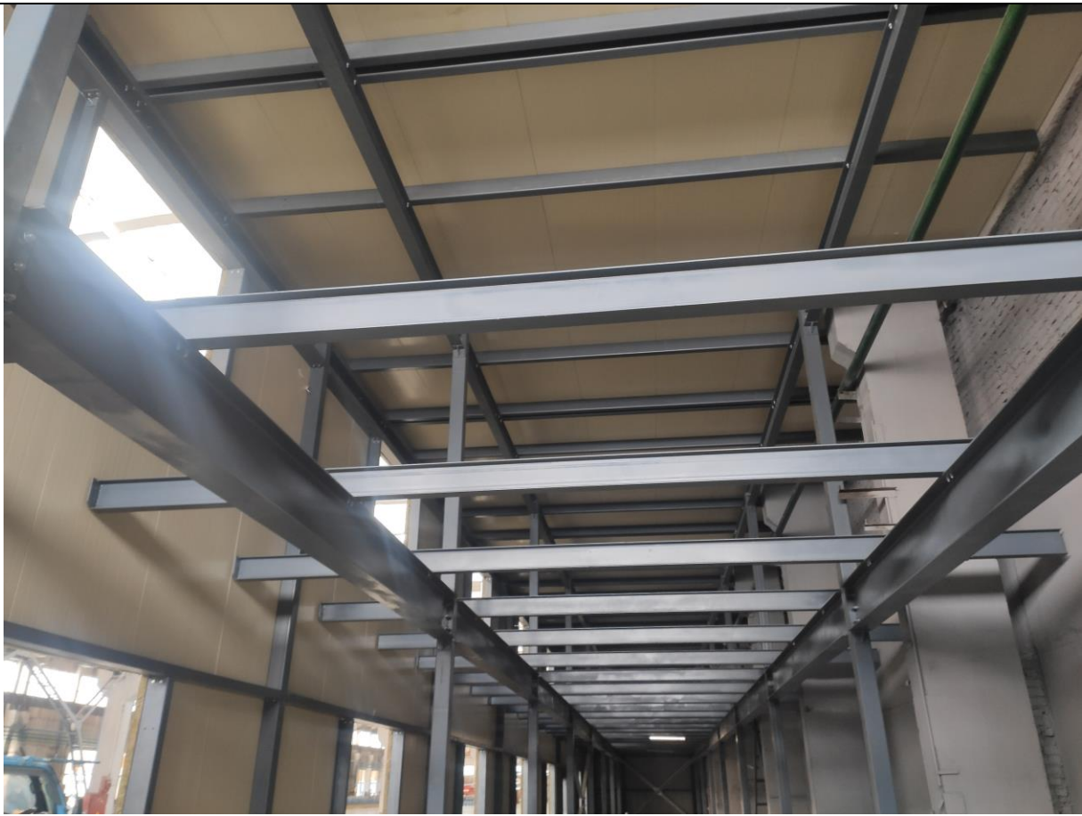
Фото 11. Металлический каркас недостроенной части АБК в осях Б-В/24-33.
