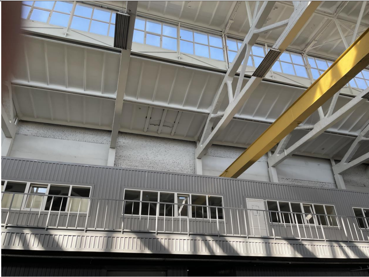
Фото 39. Участок с усилением поврежденной плиты покрытия.
