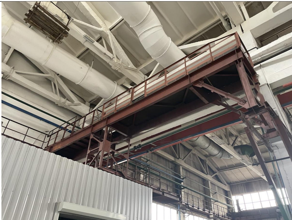
Фото 15. Ремонтные площадки в осях А-В/32-33
