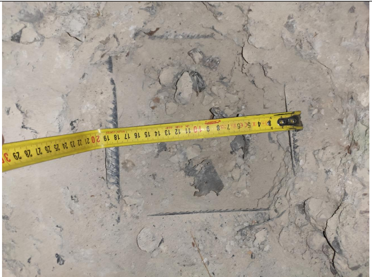
Фото 32. Измерение шага арматуры полов в осях А-Б/18-19.
