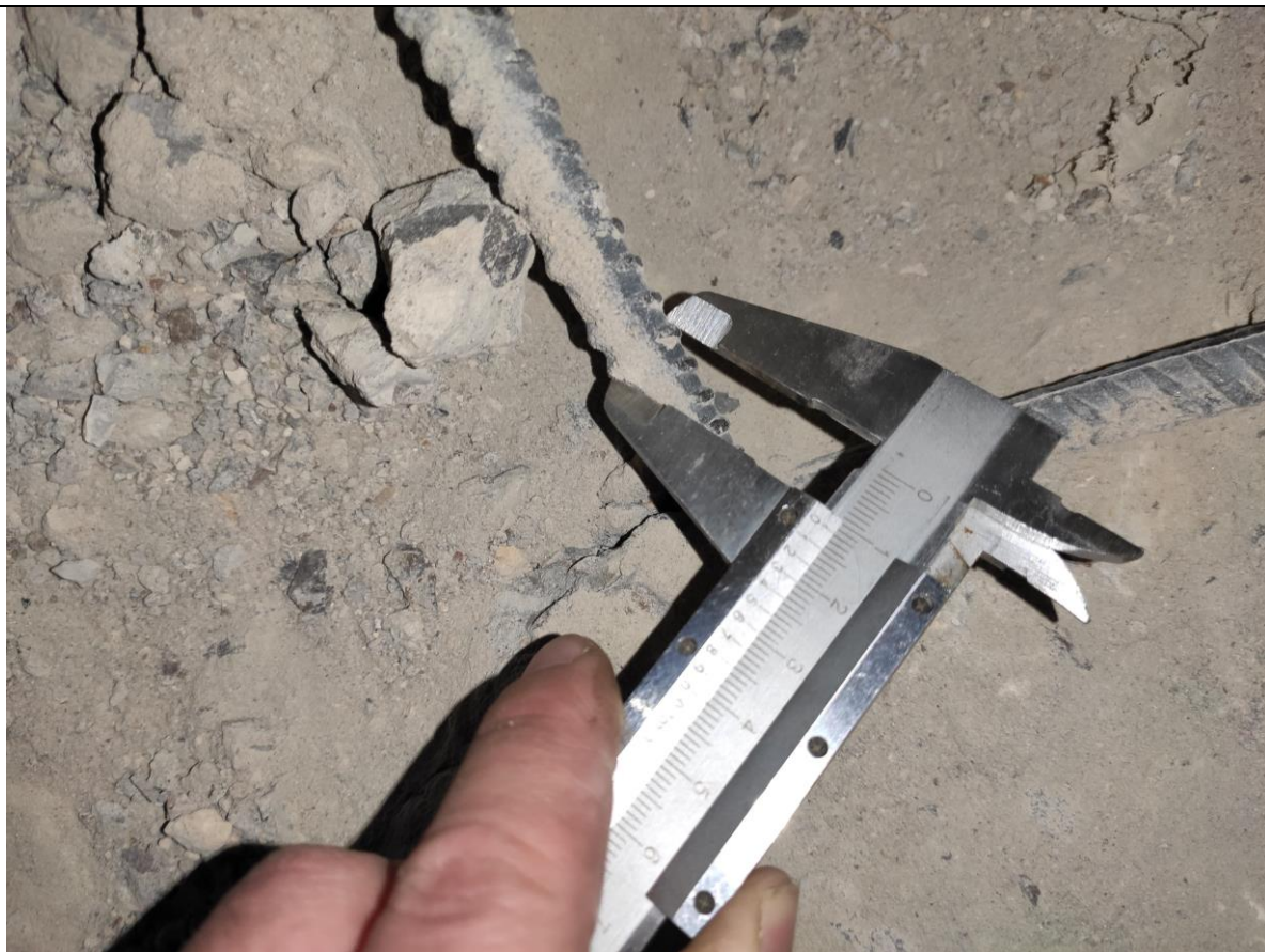
Фото 27. Измерение диаметра арматуры полов в осях Б-В/4-5.
