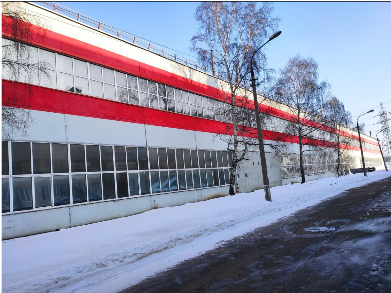
Фото 3. Фрагмент фасада в осях 1-33.
